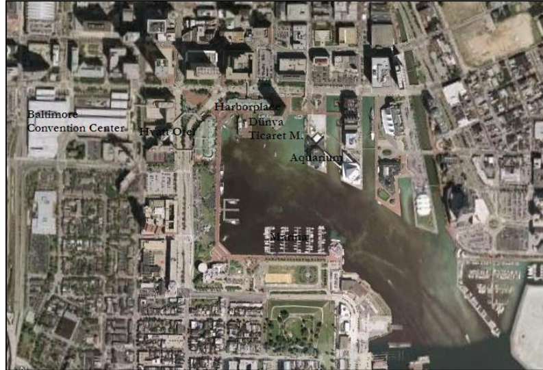
Şekil 3.2: Inner Harbor Projesi Havadan Görünüşü (www.earth.google.com)
