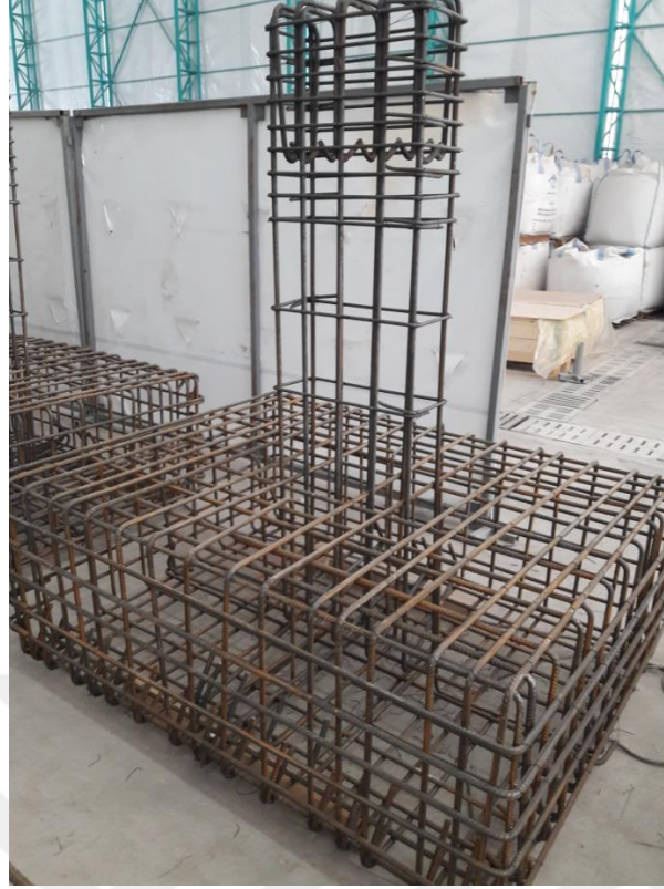
Şekil 2.7 : Kolon-temel donatı detaylandırması.
