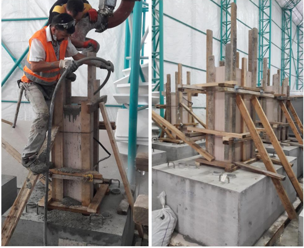
Şekil 2.1 : Beton dökümü ve dikey kalıplama.
