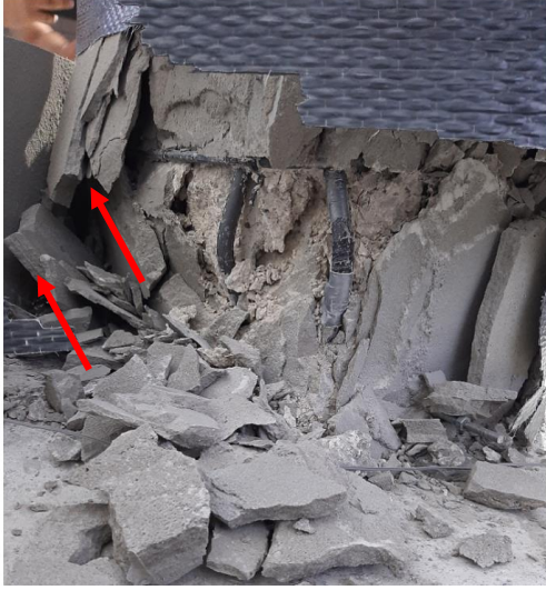
Şekil 3.32 : Tamir harcının kademeli uygulaması sonucu oluşan tabakalaşma.
