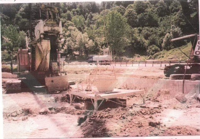
Fotoğraf. 5.3 Taşaltı Heyelan Bölgesinde delme kazıkta (BS20) beton uygulaması
