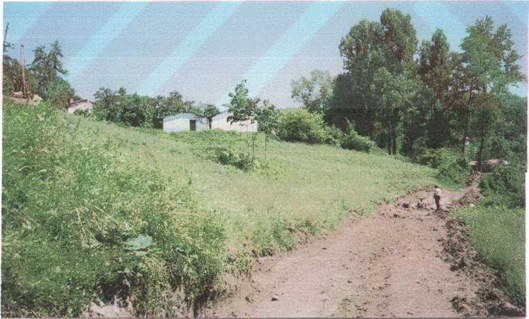
Fotoğraf 4.6 Taşaltı heyelan bölgesinde kayma dairesinin derinliğini ve birimleri belirlemek amacı ile yapılan araştırma sondajı
