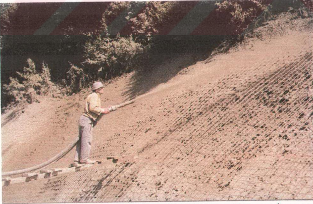
Fotoğraf 5.1 Taşaltı Heyalan bölgesinde değiştirilen yol güzergahının yeni kazı şevlerindeki püskürtme beton uygulaması
