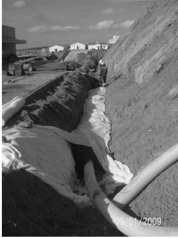
Şekil 4.3 : Yağmur suyunun toprakta filtre edilmesi
