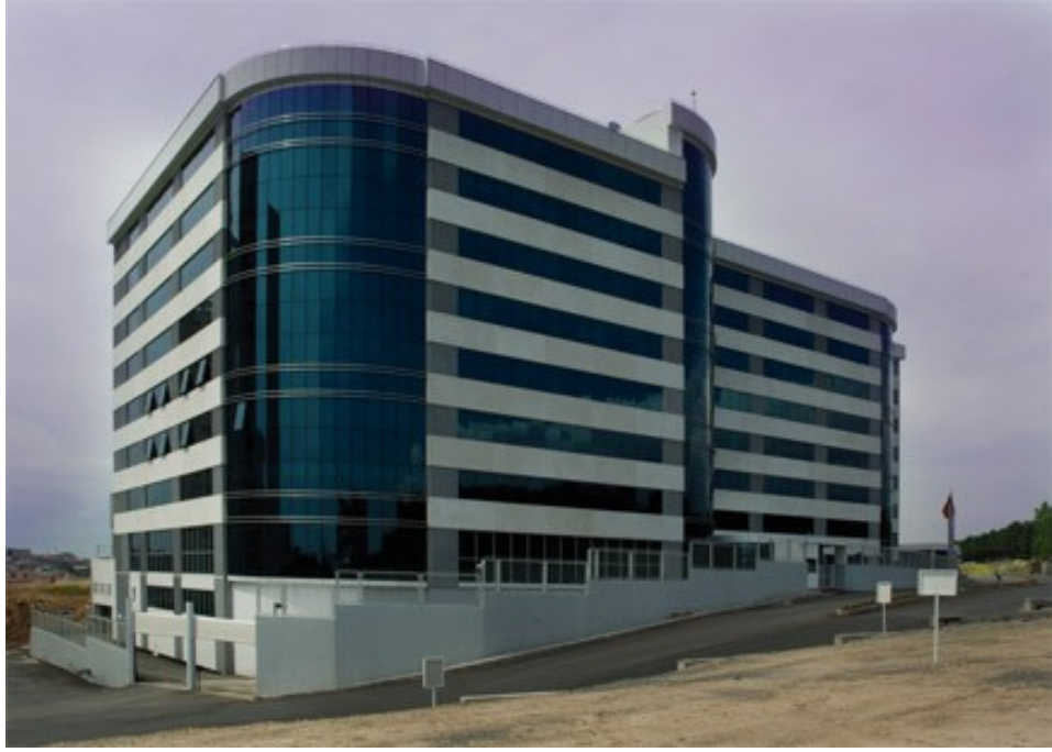
Şekil 2.10 : Unilever Genel Müdürlük Binası
