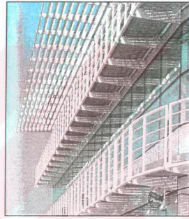
Şekil 4.15 Cephede ışık rafları [17]
