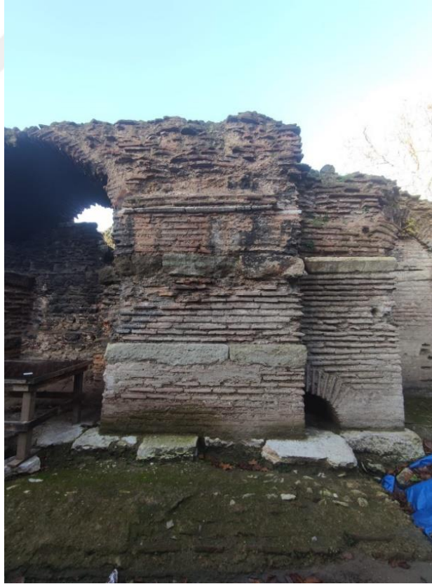
Şekil 3.6 : Polyeuktos Kilisesi tonoz başlangıç seviyesinden korniş detayı (Çelebi, 2023).
