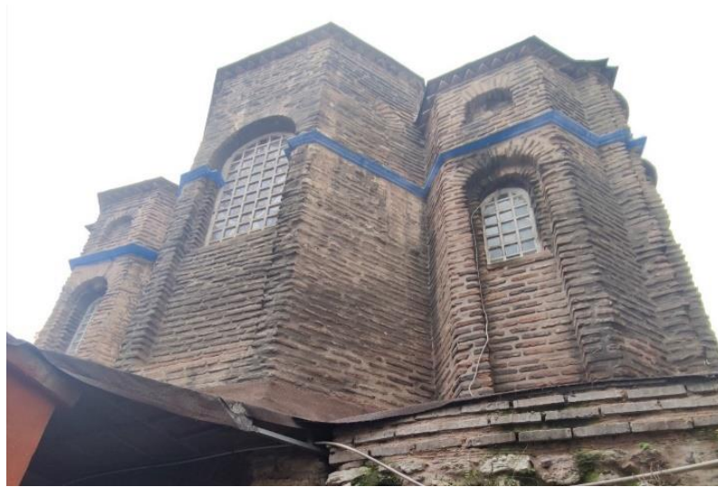
Şekil 4.7 : Bodrum Camii dış cephede kemer seviyesinden korniş detayı (Çelebi, 2023).
