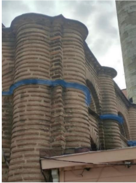
Şekil 4.3 : Bodrum Camii dış cepheden korniş detayı (Çelebi, 2023).
