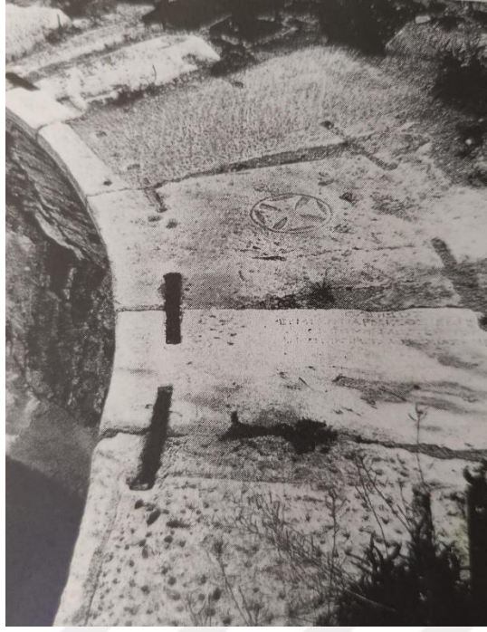
Şekil 6.2 : Enez'deki Fatih Camisi'nde metal kenetleri gösteren kubbe kornişi detayı (Ousterhout, 2016, s.227)
