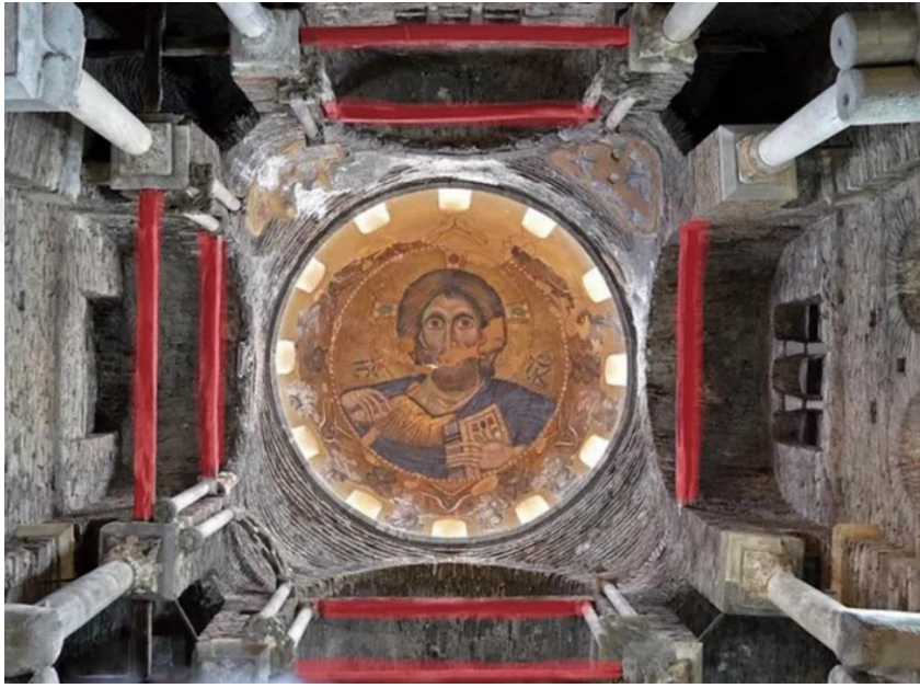
Şekil 3.1 : Sütun başlıklarının üst seviyesinden geçen ahşap kirişler, Panagia Parigoritissa Kilisesi (URL-2’den türetilmiştir. Son erişim Eylül 2024).
