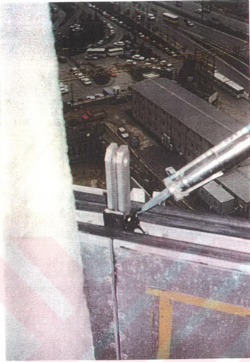
Şekil 4.3. Türkiye İş Bankası şantiyesinde uygulanan panel sistem giydirme cephede macun uygulaması, 4. Levent, İstanbul.
