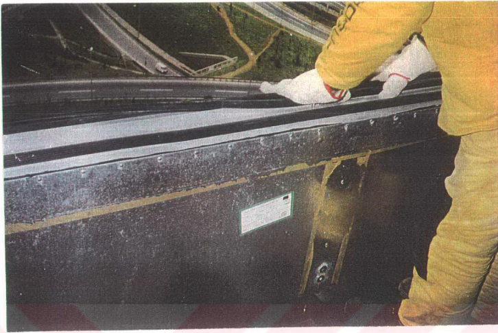
Şekil 4.6. Türkiye İş Bankası Genel Müdürlük Binası giydirme cephesinde E.P.D.M. fitil uygulaması, 4. Levent, İstanbul.
