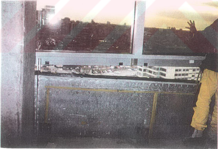
Şekil 4.7. E.P..D..M. fitillerin üst üste gelen panellerin arasında kullanımı
