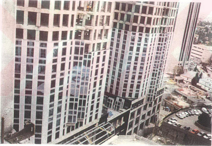
Şekil 2.7. Panel sistemle yapılmakta olan Türkiye İş Bankası Genel Müdürlük Binası, 4. Levent, İstanbul.
