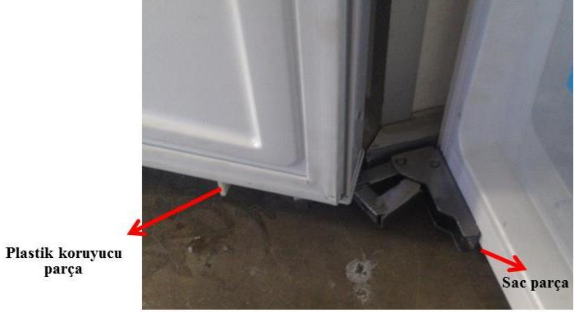
Şekil 6.30 : Alt menteşenin montajında kullanılan ek parçalar.
