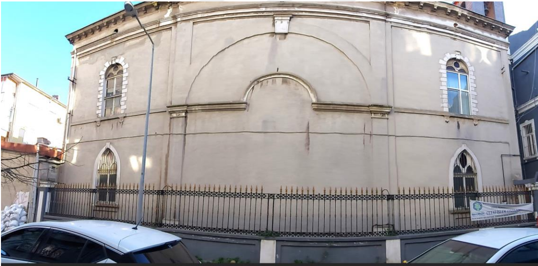
Şekil E.176 : Kilisenin kuzey cephe duvarında zemin katta yer alan P03 kodlu ahşap doğramalı pencereler.
