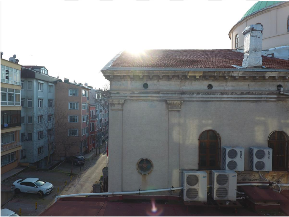
Şekil E.116 : Kilisenin doğu cephesi (Küçük Yalı Sokak tarafı).
