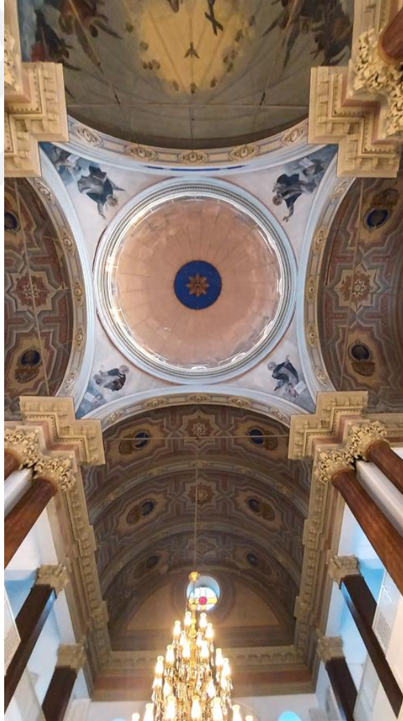
Şekil E.130 : Haç kollarının kesişimindeki kubbe, presbiterium mekânı üzerindeki yarım kubbe ile yan sunakların üzerindeki beşik tonozlu tavan.
