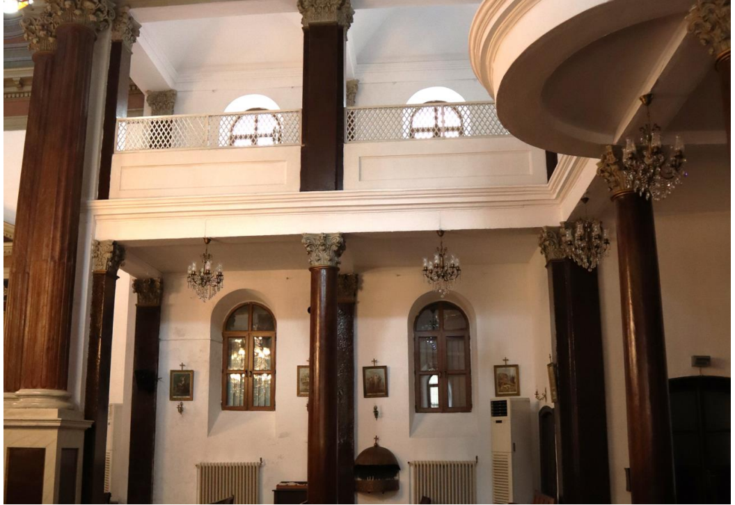
Şekil E.194 : Kilisenin doğu beden duvarında, zemin katta yer alan ve müştemilat yapısı nedeniyle dışardan kapanmış durumdaki pencereler.
