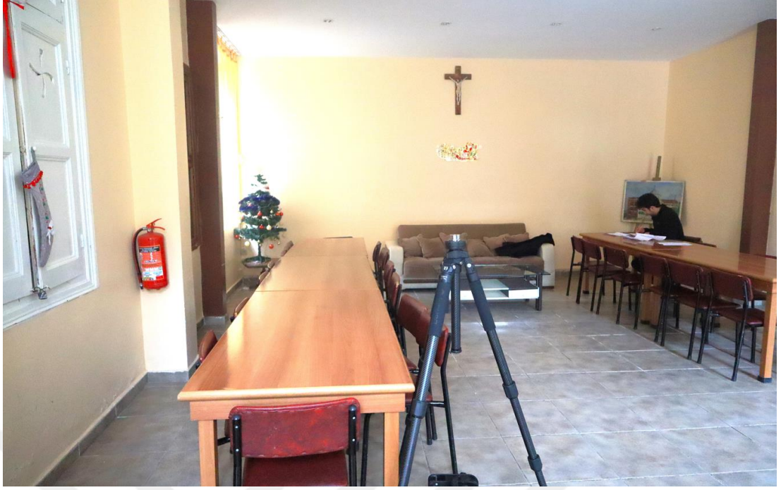
Şekil E.65 : A Z03 oda mekânının doğu ve batı duvarında karşılıklı olarak yer alan çelik kolonlar.
