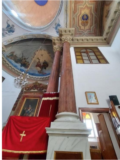
Şekil E.26 : Naosun kuzey duvarında, presbiteriumun doğusunda yer alan ahşap kapı ve pencere.
