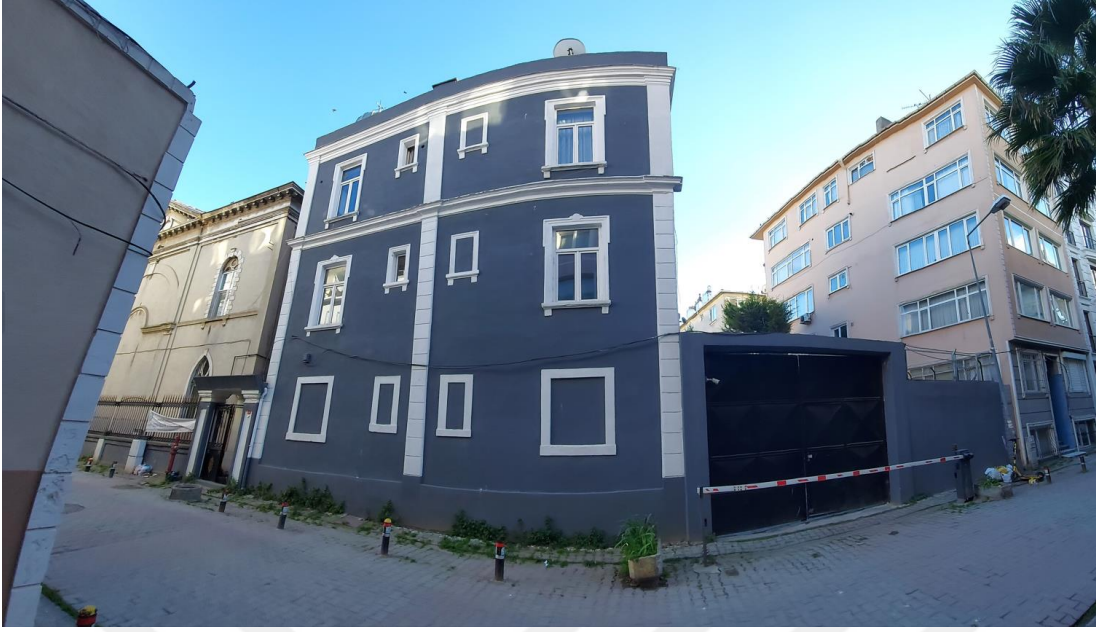
Şekil E.111 : Kagir apartman (lojman) yapısının kuzey cephesi.
