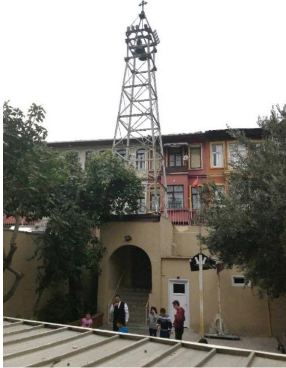
Şekil A.6 : Galeri katından bahçe giriş kapısına bakış (Prıfıtı, 2017, s.13).
