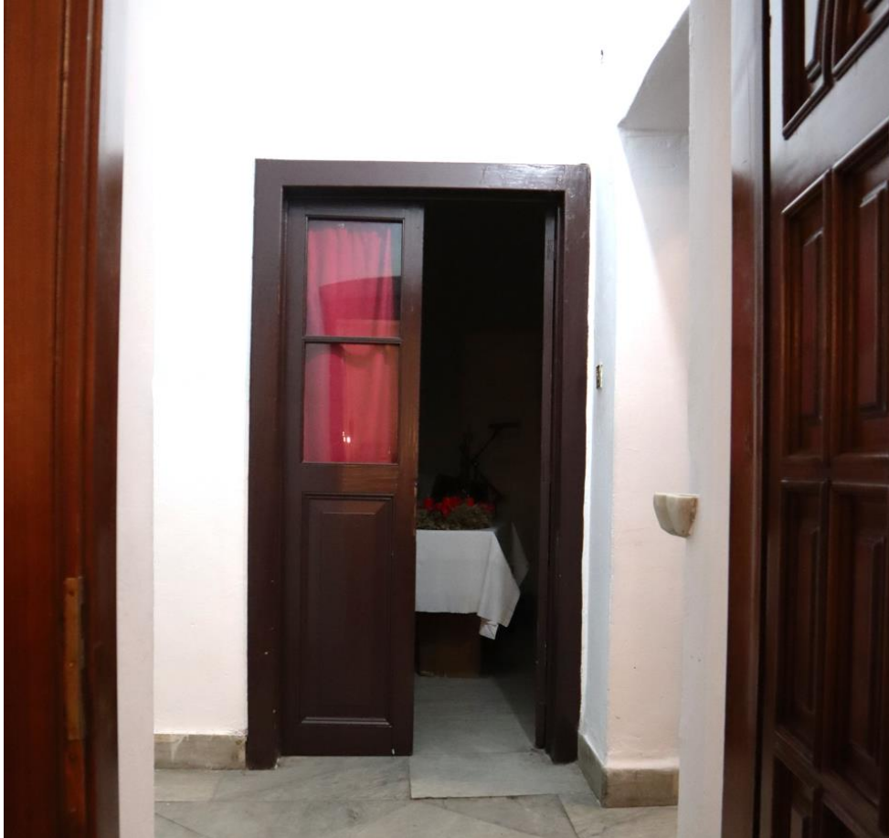
Şekil E.168 : K 05 kodlu çift kanatlı ahşap doğramalı kapı.
