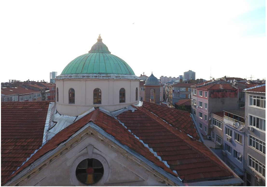
Şekil E.117 : Kilisenin doğu cephesindeki çatı örtüsü.
