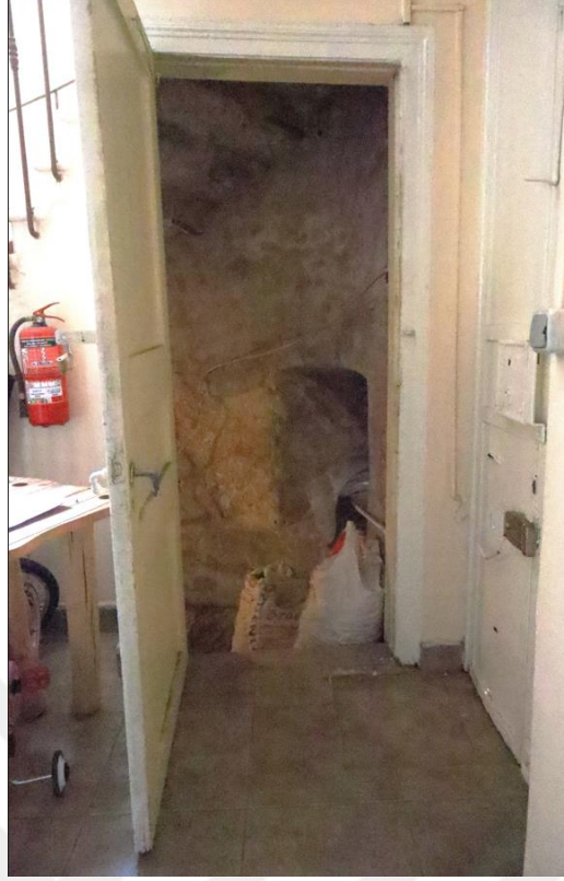
Şekil E.67 : Apartman yapısında bodrum kata inen merdiven önündeki kapı.
