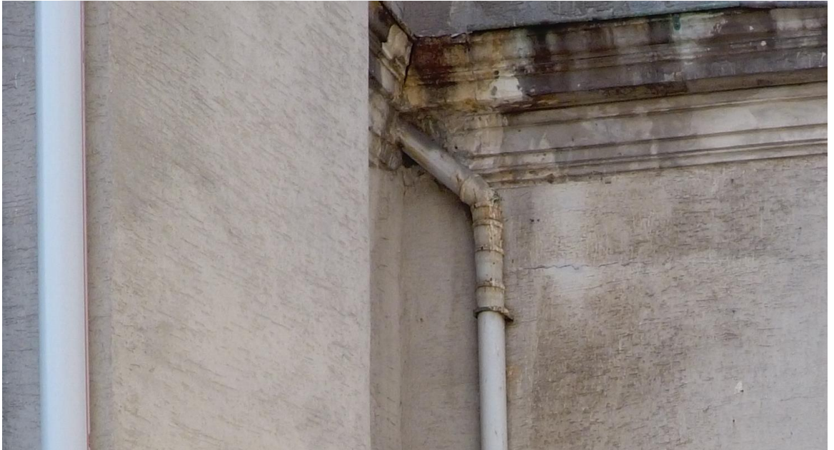
Şekil E.198 : Batı cephesinde yer alan taş silmedeki ve cephedeki yüzey kirliliği.
