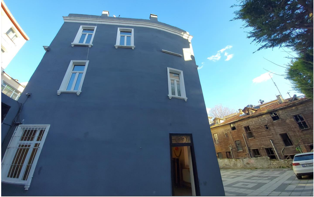
Şekil E.122 : Batı cephesine dahil olan kagir apartman (lojman) yapısı.
