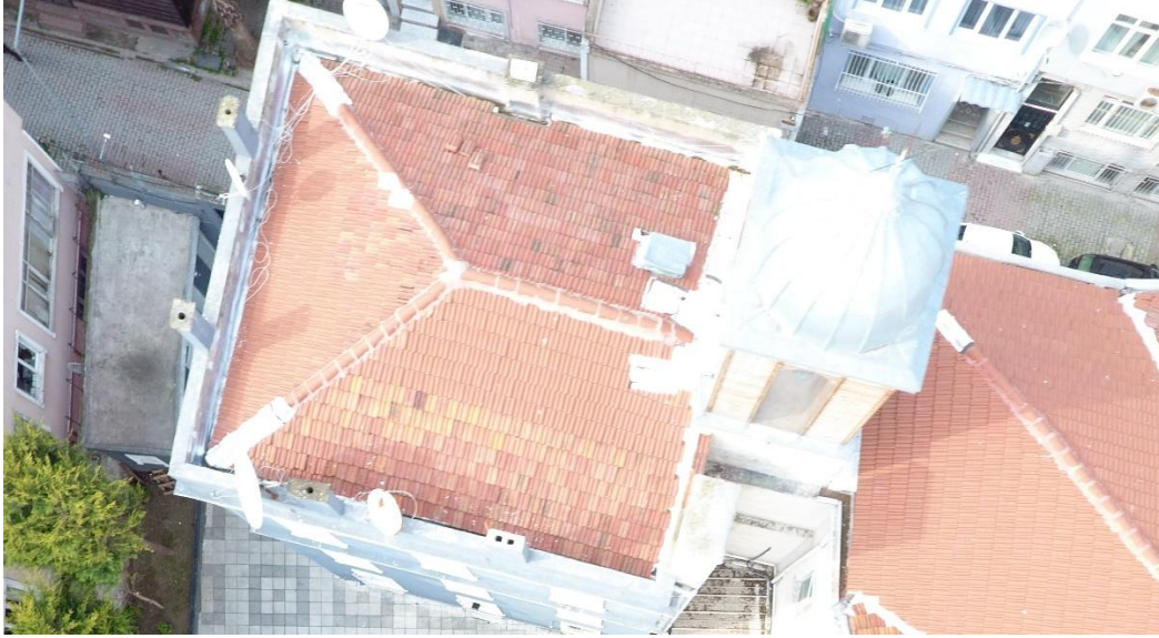
Şekil E.40 : Apartman yapısının çatısında yer alan metal çatı kapağı.
