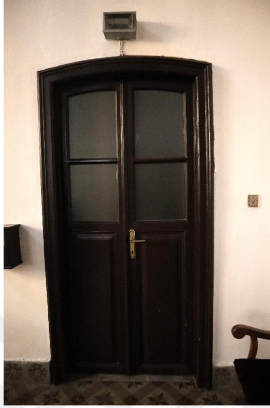
Şekil E.3 : Narteks mekanının doğu yönündeki duvarında yer alan kapı.
