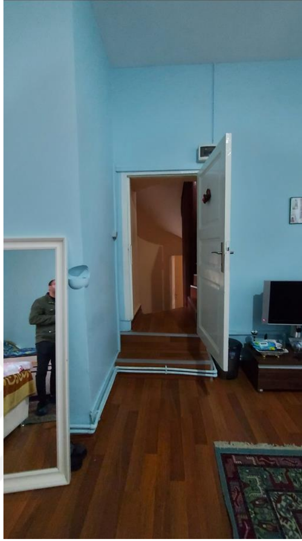
Şekil E.41 : K 104 oda mekanına açılan K02kodlu kapı.
