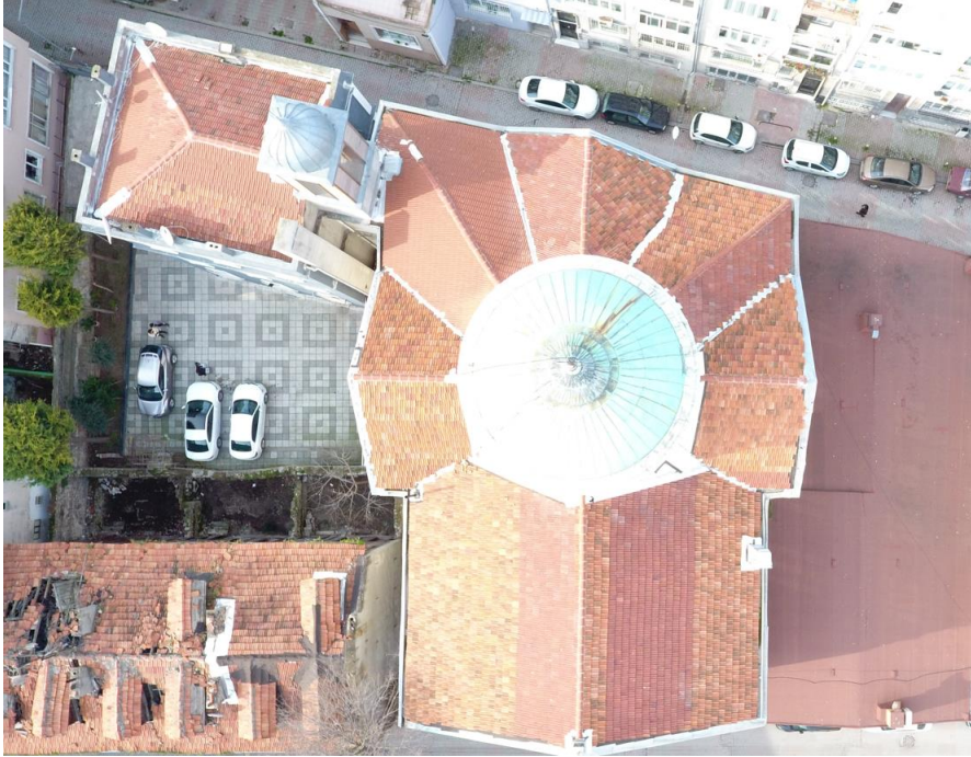
Şekil E.164 : Marsilya kiremit ile kaplı olan kilise, kagir apartman ve ahşap lojman çatıları ile kumlu membran örtü ile kaplı olan müştemilat yapısı çatısı.
