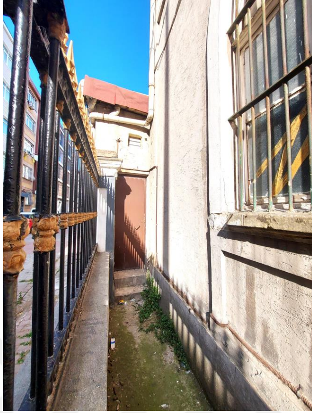
Şekil E.109 : Kilise ile Rüya Sokak arasında yer alan bahçe ve bahçe duvarı.
