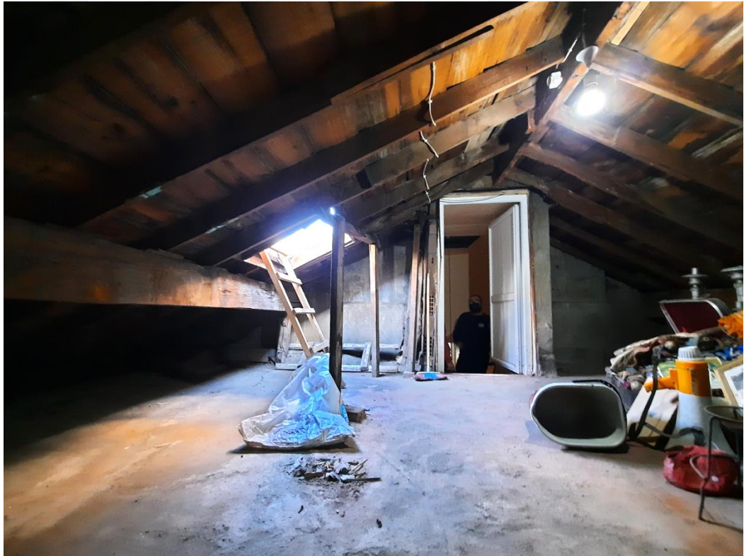
Şekil E.158 : Kagir apartman yapısının çatı arasındaki ahşap çatı strüktürü.
