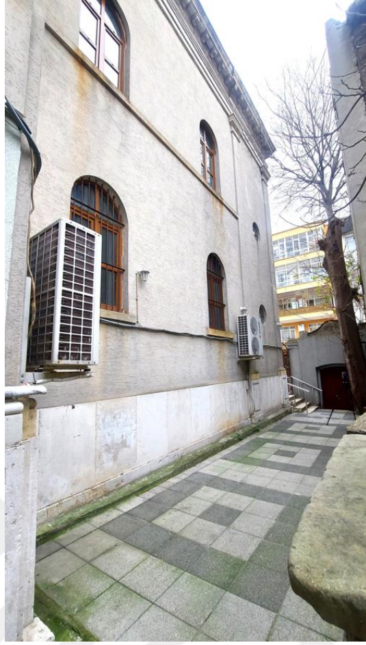
Şekil E.121 : Kilise doğu cephesi.
