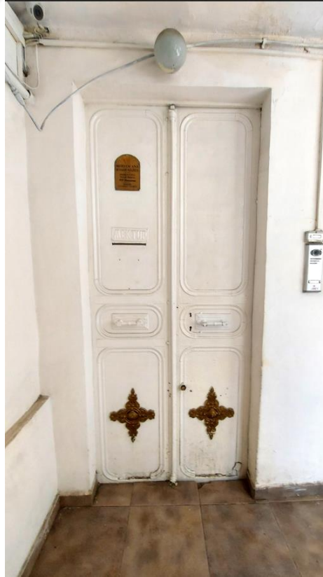
Şekil E.54 : Apartman (kagir lojman) yapısının çift kanatlı demir doğramalı giriş kapısı.
