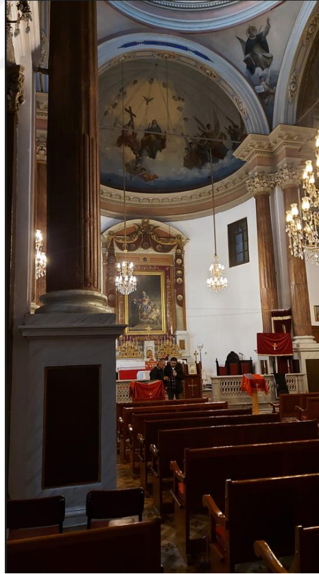
Şekil E.148 : Kubbeyi taşıyan ST3 sütunu kenet şeklindeki bağlantı elamanı ile batı beden duvarına sabitlenmiştir.
