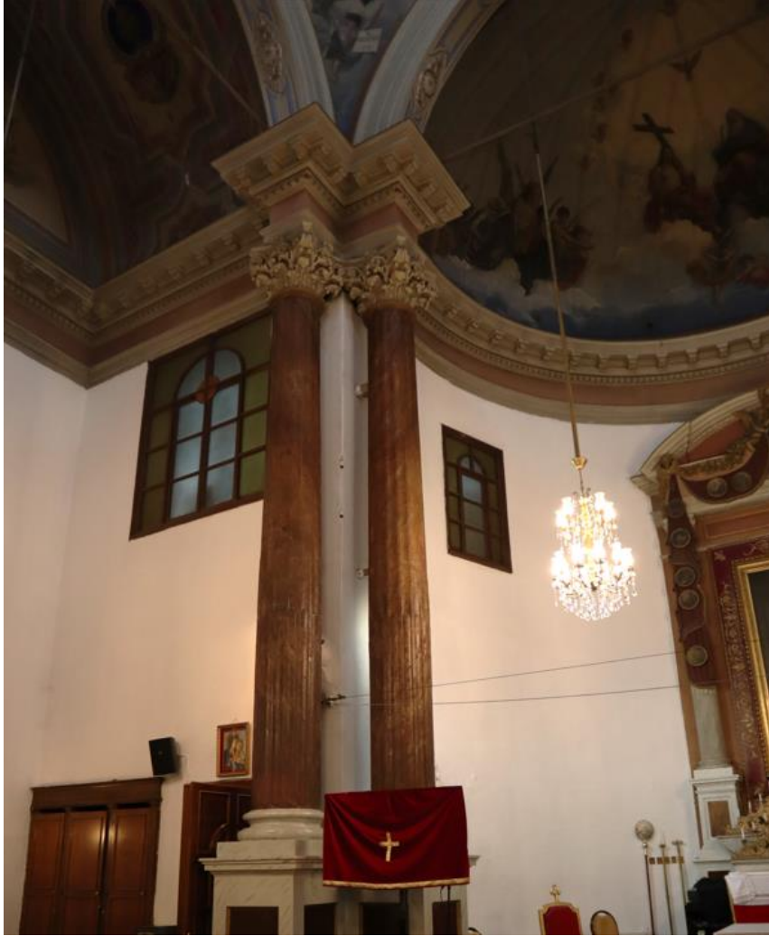
Şekil E.180 : Galeri katında yer alan P 09 kodlu ahşap doğramalı pencereler.
