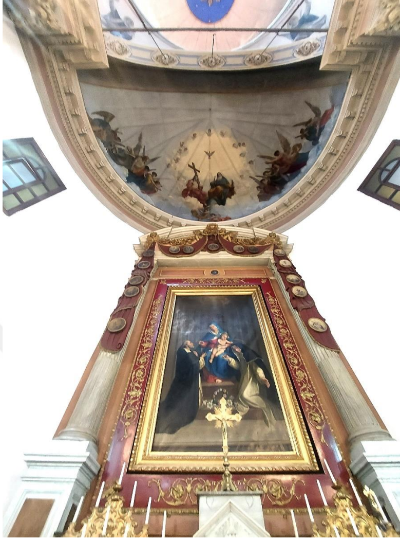
Şekil E.23 : Presbiterium mekanında yer alan yarım daire formundaki kubbe, beşik kemer ve demir gergi elemanı.
