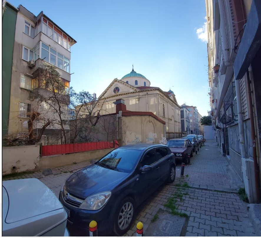
Şekil E.113 : Rüya Sokaktan kiliseye bakış.
