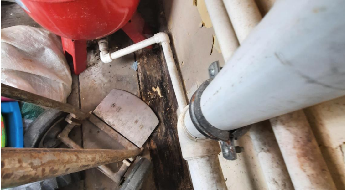
Şekil E.202 : A Z02 oda mekanının ahşap zemin kaplamasındaki çürüme ve renk değişimi.
