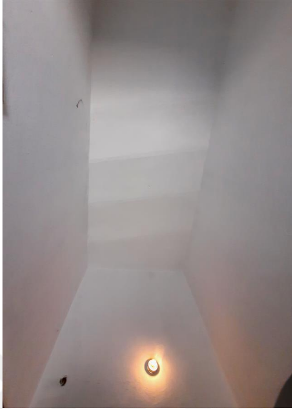
Şekil E.29 : K Z05 hol mekân tavanındaki volta döşemeye ait putrel izleri.
