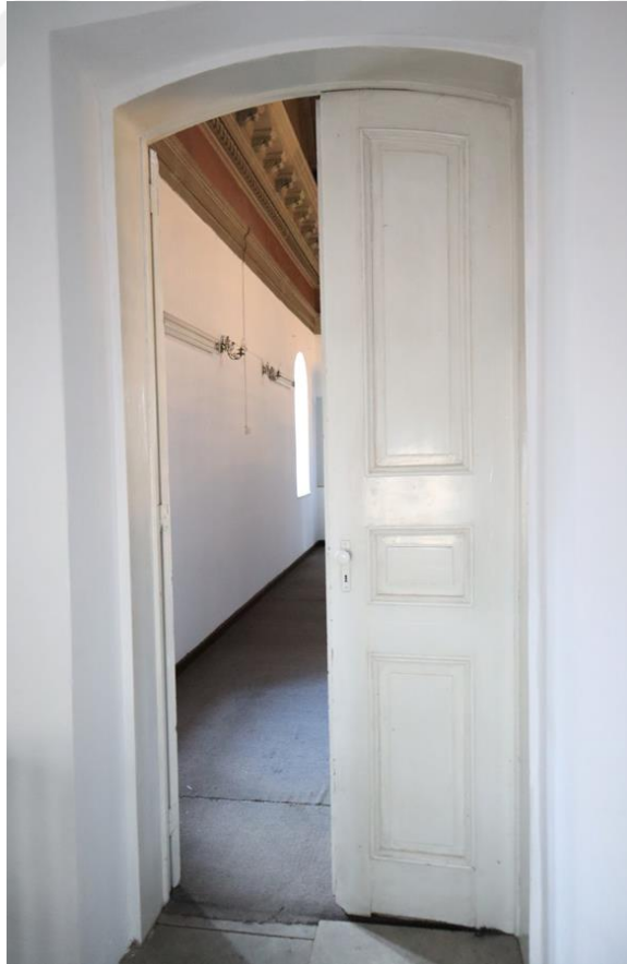
Şekil E.170 : K 21 kodlu çift kanatlı ahşap doğramalı kapı.
