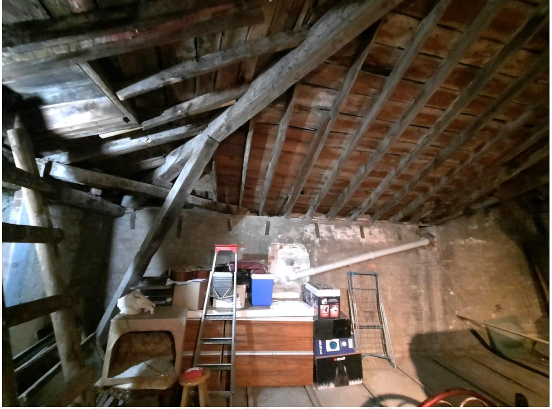
Şekil E.157 : K 104 oda mekanının üzerine denk gelen çatı arasındaki ahşap çatı strüktürü.
