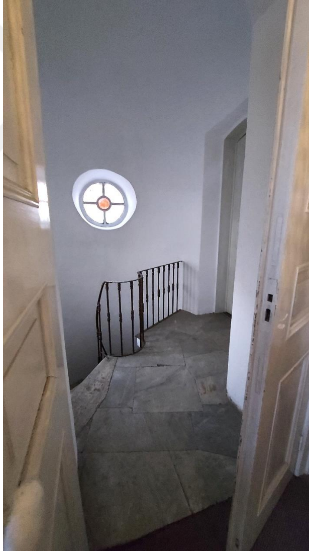
Şekil E.8 : Galeri katına çıkan merdiven holü.
