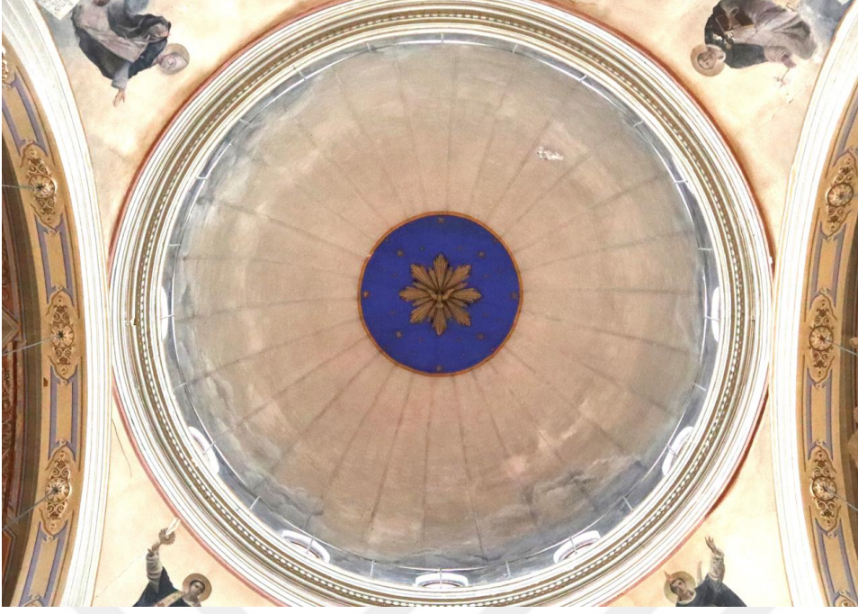
Şekil E.155 : Kubbe strüktürünü oluşturan 26 adet demir putrelin sıva altından görünüşü.
