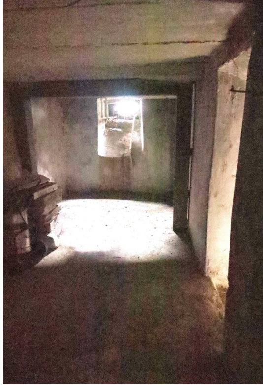
Şekil E.52 : Apartman yapısının bodrum katındaki kömürlük mekanı.
