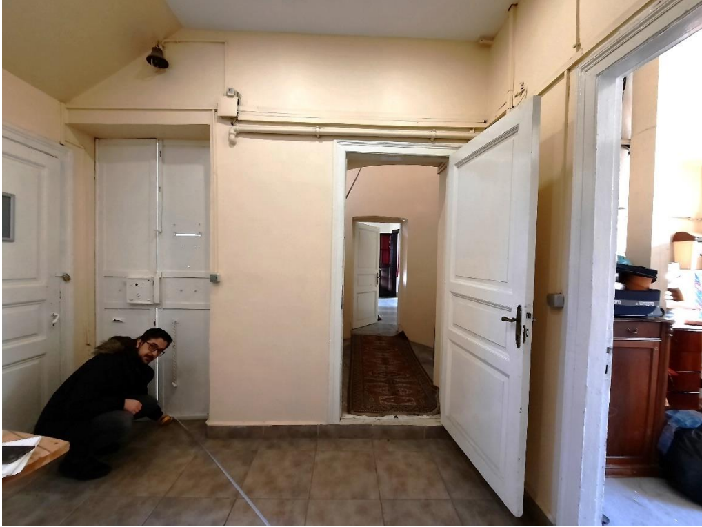
Şekil E.56 : Kilisenin K Z08 hol mekânından apartman yapısının giriş holüne açılan K 02 kodlu tek kanatlı ahşap doğramalı kapı.
