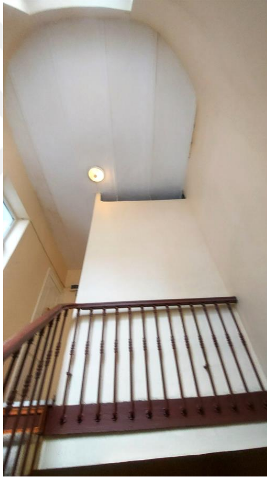
Şekil E.196 : A 101 hol mekanında yer alan muhdes duvar.
