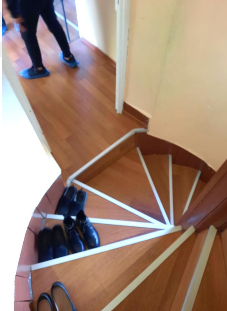
Şekil E.38 : Kilisedeki K M03 merdiven holünden, apartman yapısının ikinci katında yer alan A 201 hol mekanına bakış.
