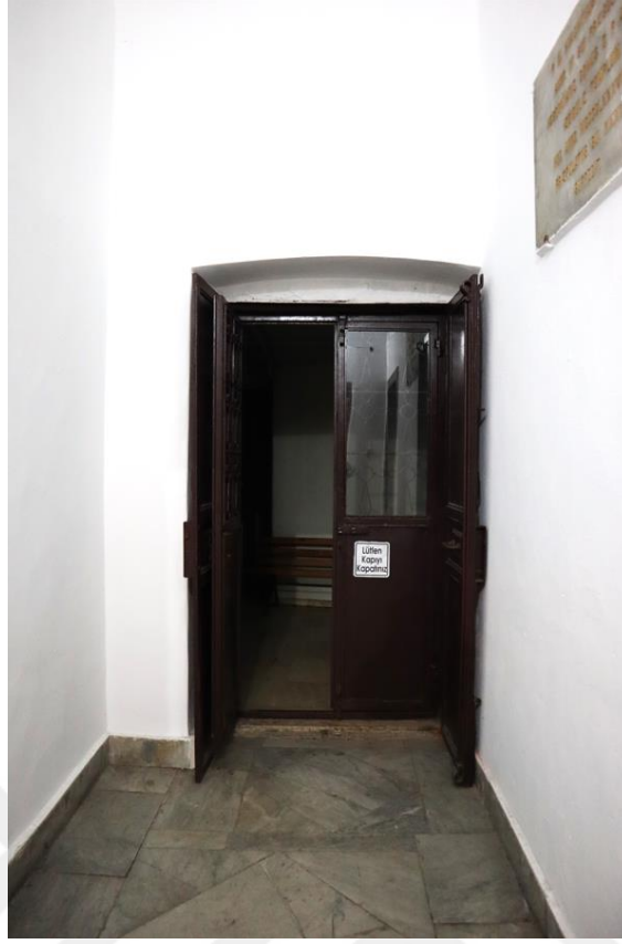
Şekil E.165 : K 06 kodlu ard arda konumlandırılmış olan iki adet çift kanatlı demir doğramalı kapılar.
