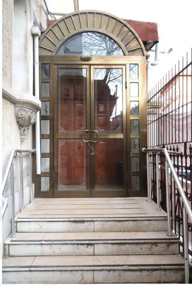
Şekil E.89 : Müştemilat yapısının girişindeki rüzgarlık.
