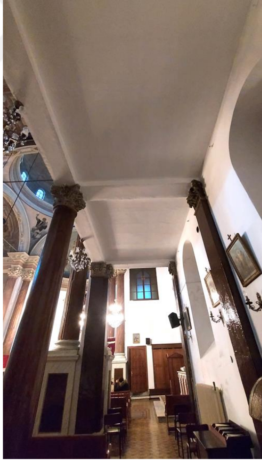
Şekil E.124 : Galeri kat döşemesindeki kirişler.
