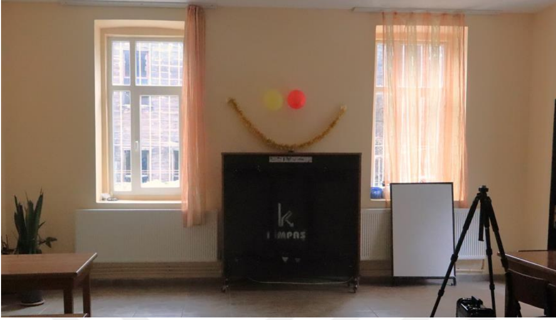
Şekil E.63 : A Z03 oda mekânının güney duvarında yer alan pvc doğramalı iki adet pencere.
