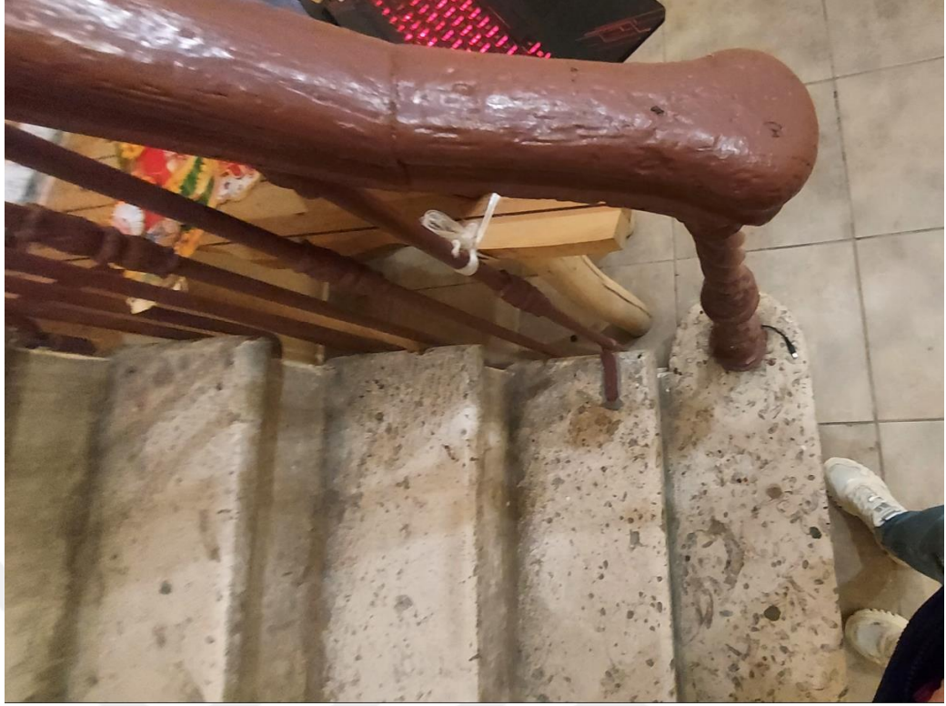
Şekil E.161 : A Z04 merdiven holüne ait demir küpeşte ve korkuluk.
