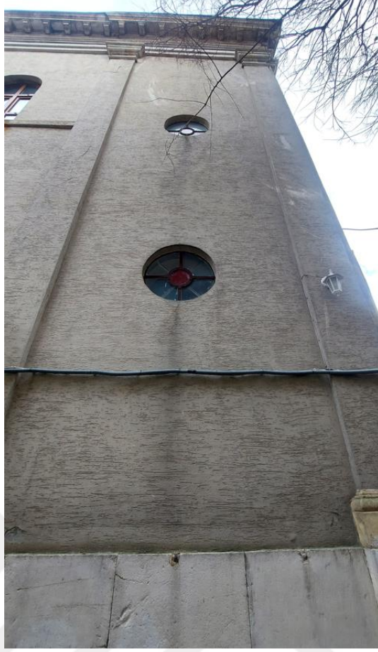
Şekil E.177 : P 05 kodlu dairesel demir doğramalı pencereler.
