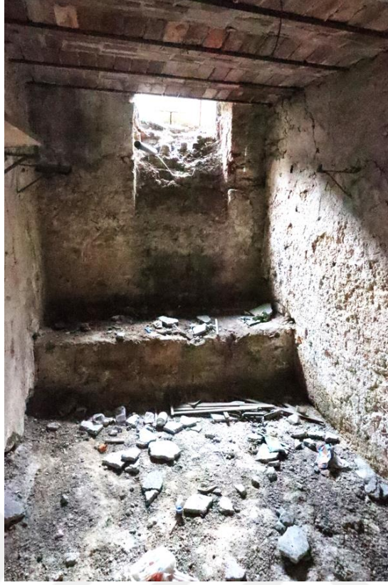
Şekil E.53 : Apartman yapısının bodrum katındaki depo mekanı.
