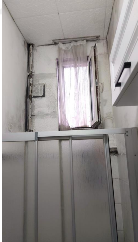
Şekil E.84 : A 204 ıslak hacim mekanındaki pvc doğramalı pencere.
