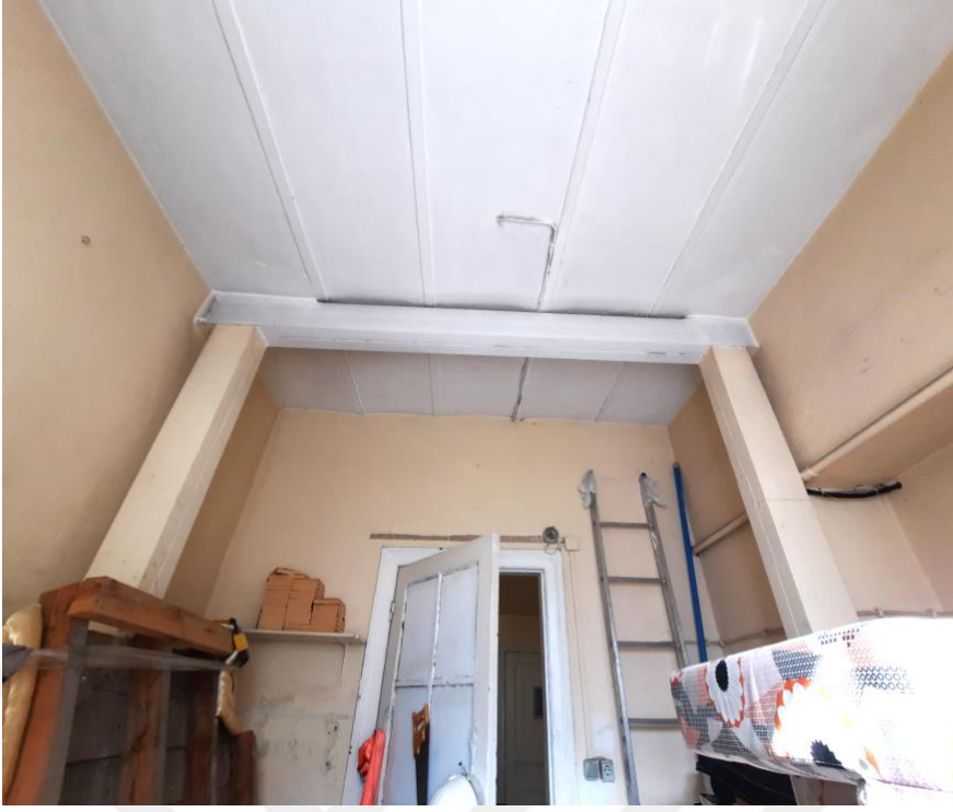
Şekil E.59 : Apartman yapısının zemin katında yer alan ve A Z02 kodlu oda mekanı.
