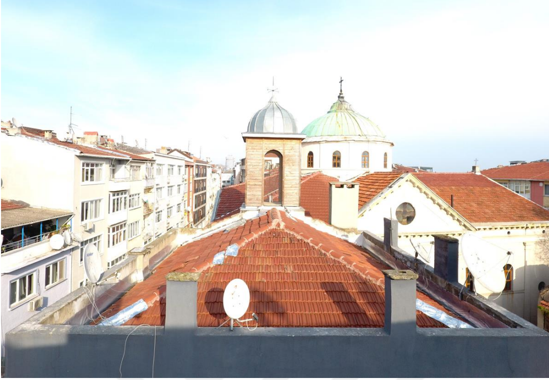
Şekil E.119 : Kilisenin batı cephesinde arkadan görünüşe giren kubbe ve çan kulesi.
