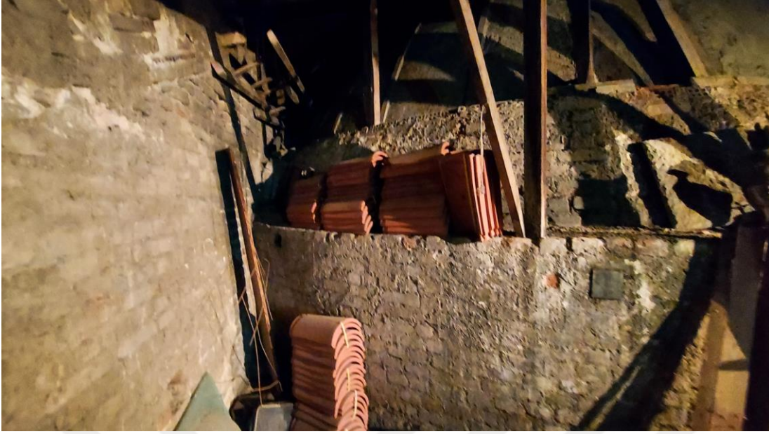
Şekil E.135 : K 104 oda mekanı üzerine denk gelen çatı arası mekanındaki tuğla duvar örgüsü ve sıvalı durumdaki yarım kubbe.
