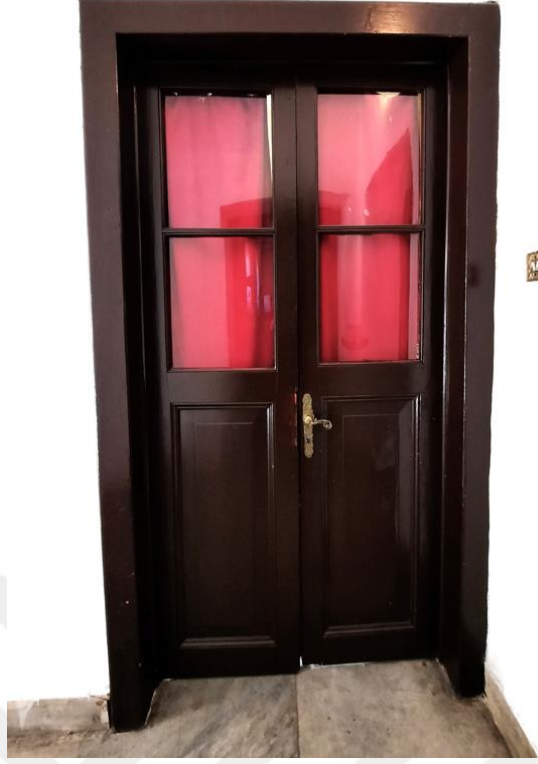
Şekil E.27 : K Z05 hol mekânından şapele geçişi sağlayan K 05 kodlu çift kanatlı ahşap kapı.
