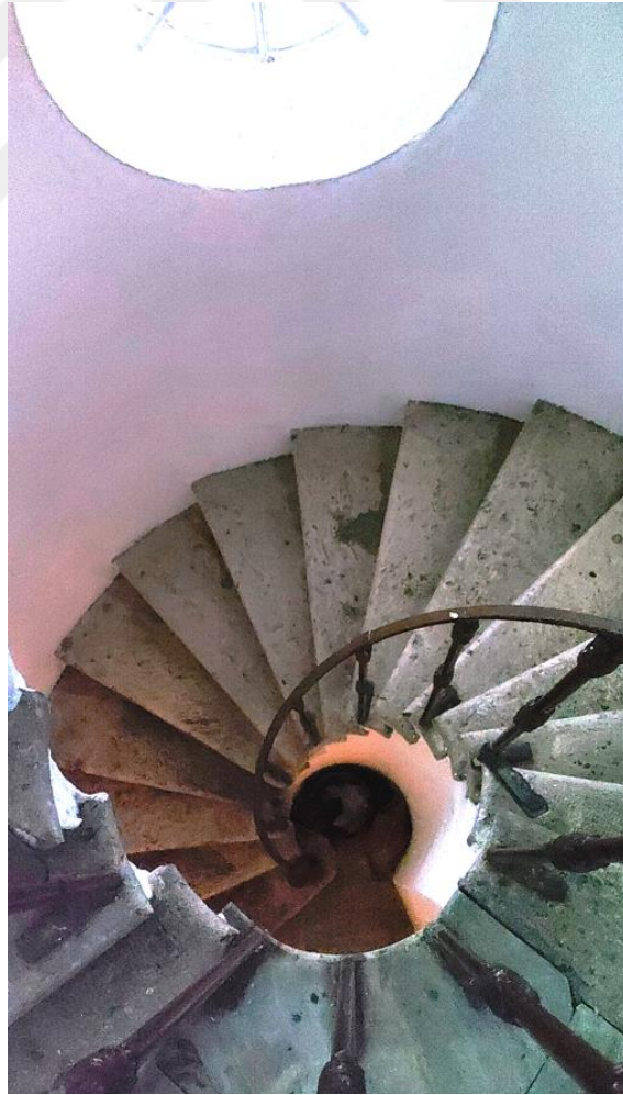
Şekil E.142 : K M01 merdiven holündeki kesme taş basamaklar.
