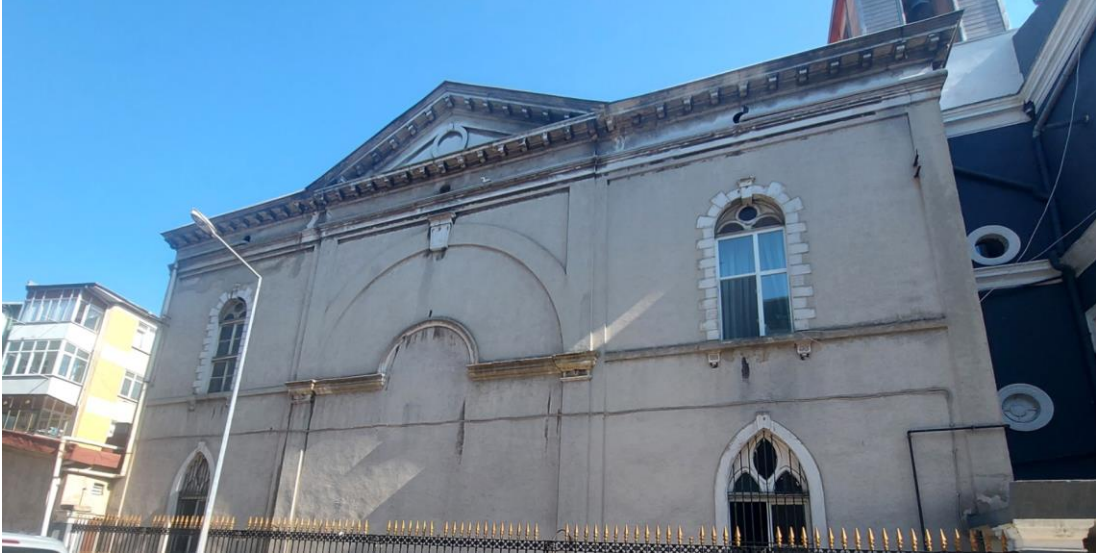
Şekil E.179 : Kilisenin kuzey cephe duvarında birinci katta yer alan sırası ile soldan sağa doğru P 07 ve P 06 kodlu pencereler.
