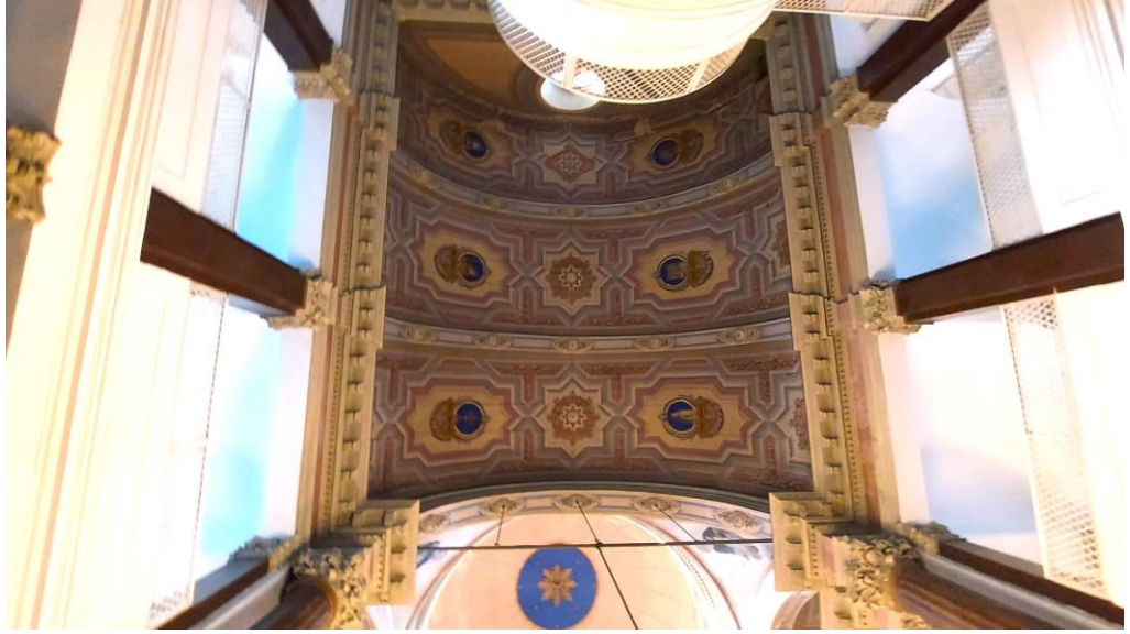
Şekil E.129 : Galerî katının yan kolları arasında kalan ve kubbeye kadar devam eden beşik tonoz ile geçilen ve üzeri kalem işi uygulaması ile kaplanmış tavan.
