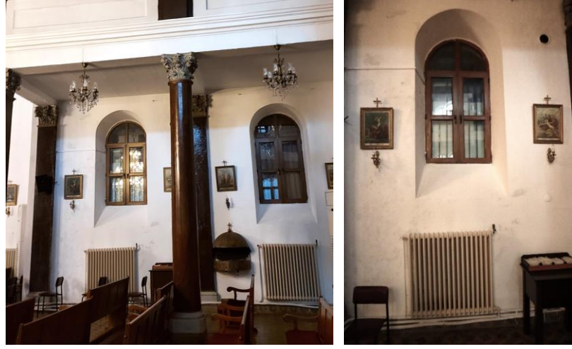
Şekil 4. 17 : Batı beden duvarında yer alan ve müştemilat yapısı tarafında kapatılmış durumda olan P04 kodlu pencereler (Yalçınkaya, 2022).
