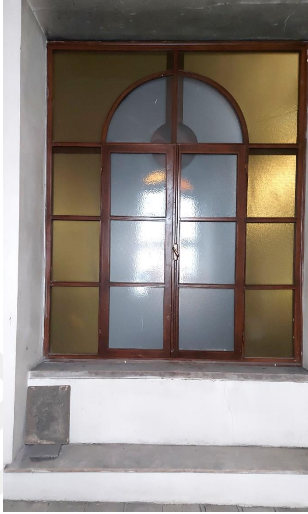
Şekil E.49 : K 105 oda mekanının güney duvarında yer alan P 09 kodlu pencere.
