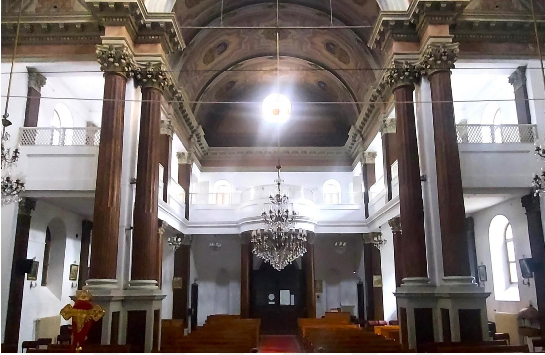
Şekil E.123 : Kilisenin beşik tonozlu tavanını taşıyan sütunlar.
