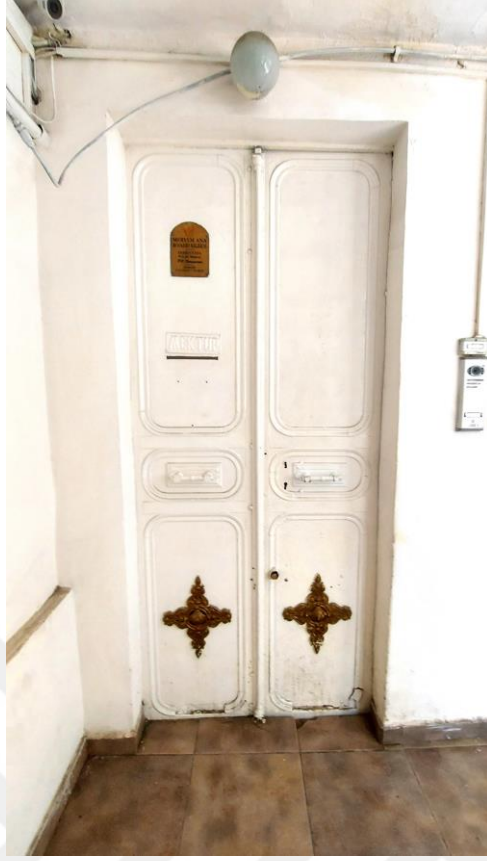
Şekil E.171 : K 04 kodlu çift kanatlı demir doğramalı giriş kapısı.
