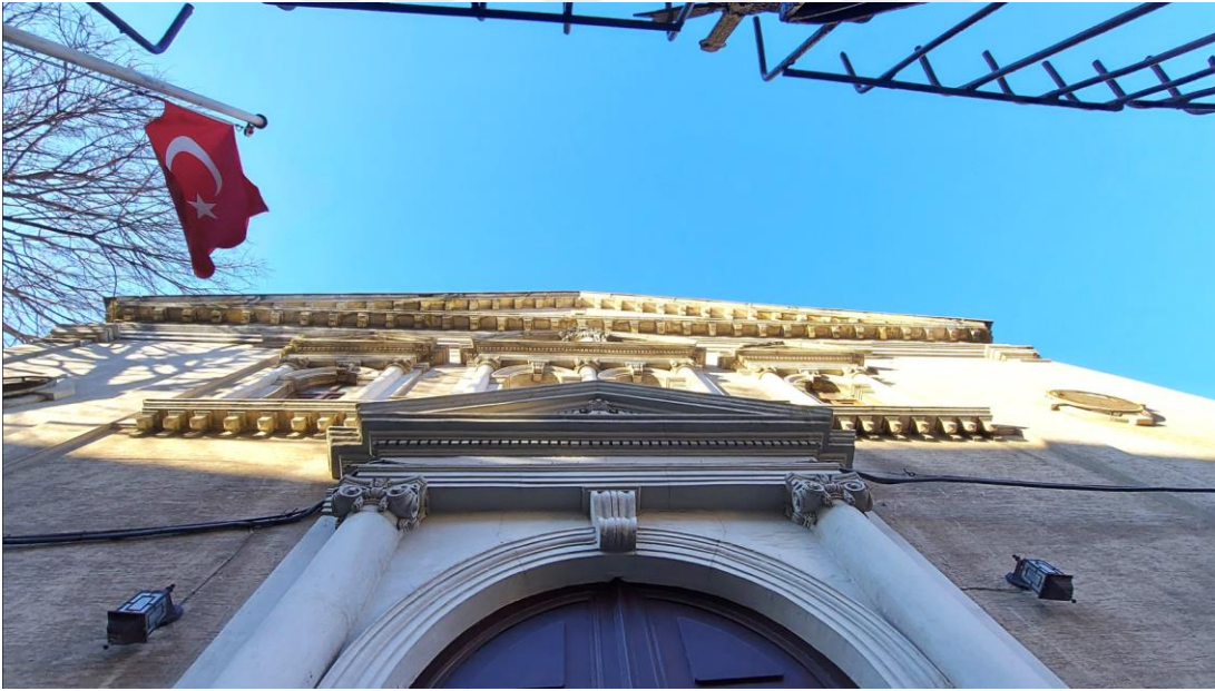
Şekil E.156 : Güney cephedeki taş malzemeden yapılmış olan; silmeler, üçgen alınlıklar, frizler, kapı ve pencerelerin yanlarındaki pilastrlar, pencere söveleri ve nişler.
