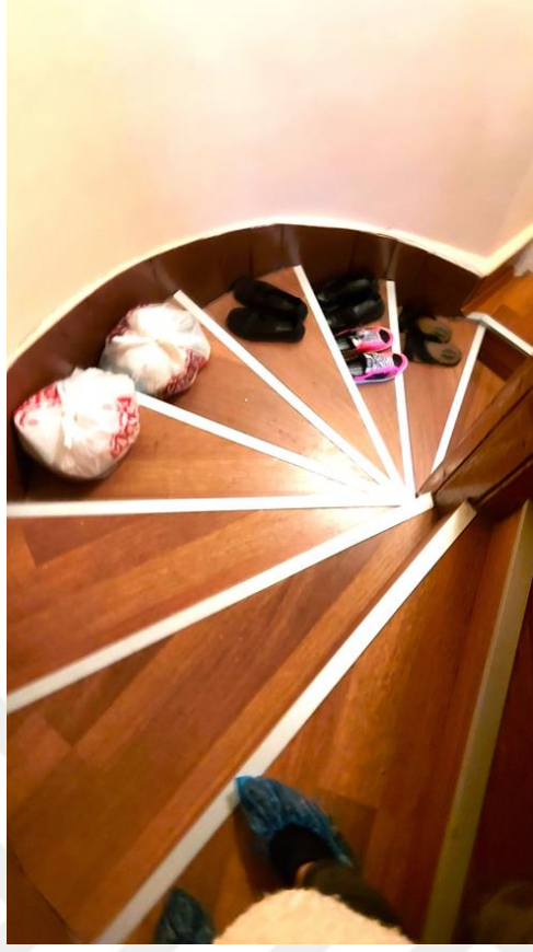
Şekil E.51 : Kagir apartman yapısının ikinci katına çıkan dairesel merdiven.
