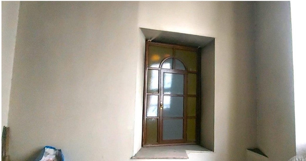
Şekil E.50 : K 105 oda mekanının batı duvarında yer alan P 09 kodlu pencere.
