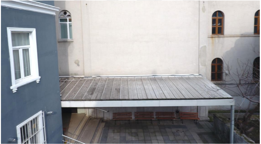
Şekil E.162 : Kilisenin batı cephesinde yer alan sundurma çatısı.
