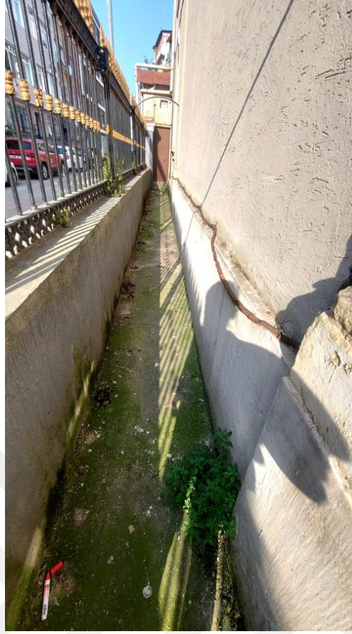
Şekil E.139 : Kilisenin kuze cephe duvarı ile ba he duvarı arasında kalan beton kaplı zemini.
