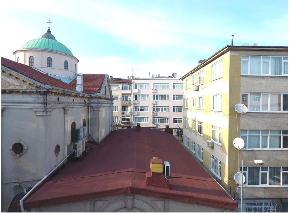
Şekil E.114 : Kilisenin doğu cephesi.
