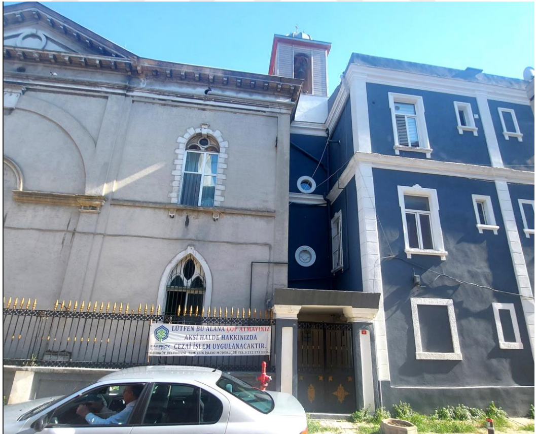
Şekil E.110 : Kilise ile kagir apartman (lojman) yapısı arasındaki bağlantıyı sağlayan kısım.
