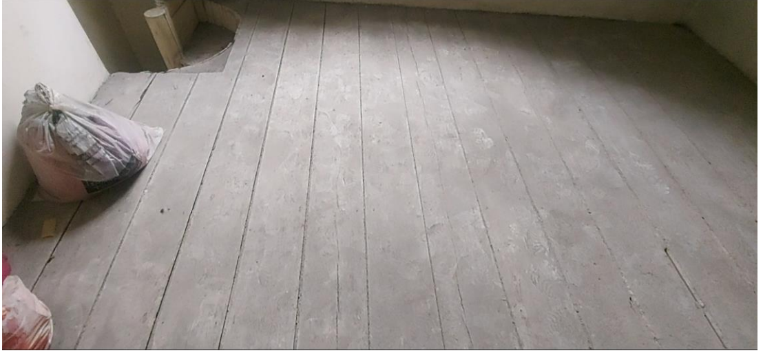
Şekil E.145 : K 105 oda mekanının ahşap zemin kaplaması.
