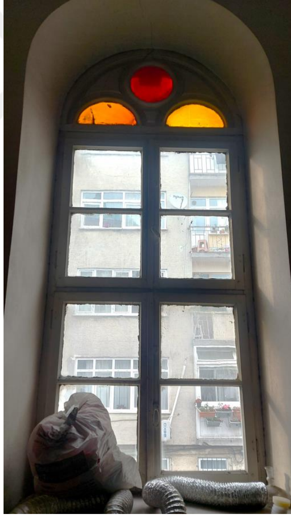
Şekil E.48 : K 105 oda mekanının kuzey duvarında yer alan P 07 kodlu pencere.
