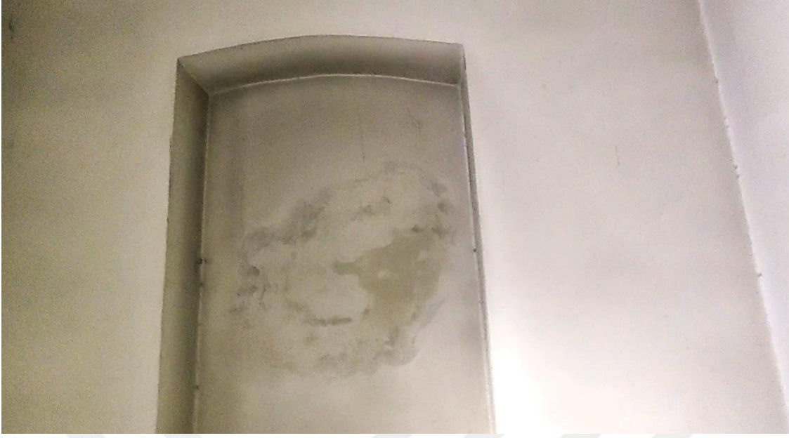
Şekil E.47 : K 105 oda mekanının doğu duvarında yer alan niş.
