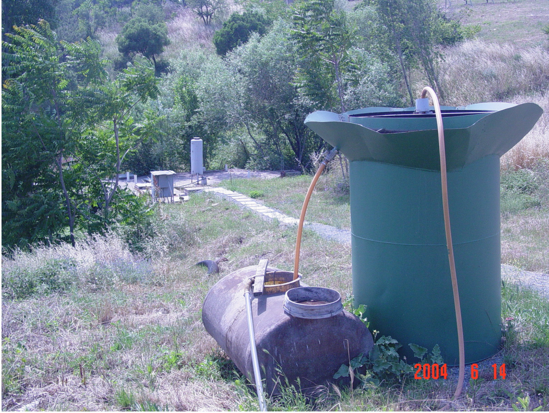
Foto D.7: Foseptikten atıksu beslemesi ve ön çöktürme tankından atıksu dağıtımı
