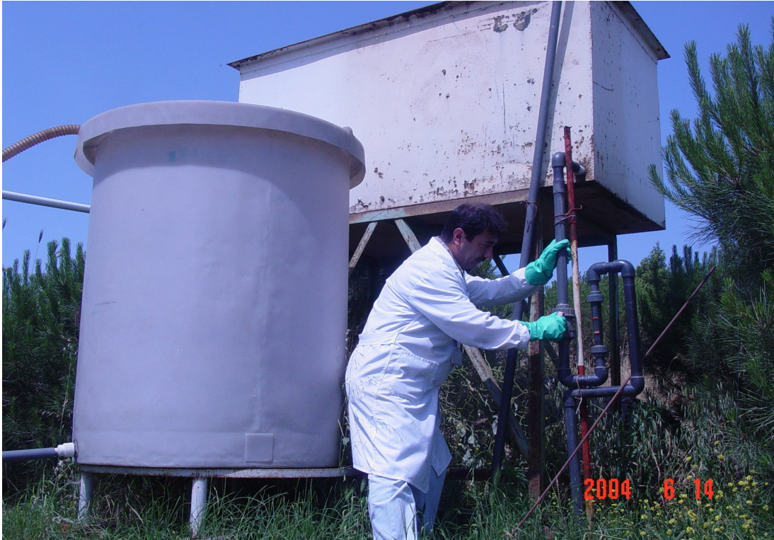
Foto D.8: Ana dağıtma tankından 100 m 2 'lik sisteme atıksu dağıtımı
