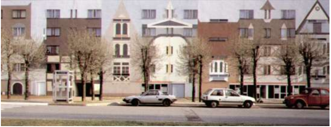
Şekil 4. 16: Cephe yüzeyinde duvar resmi (Lassus, 1998).
