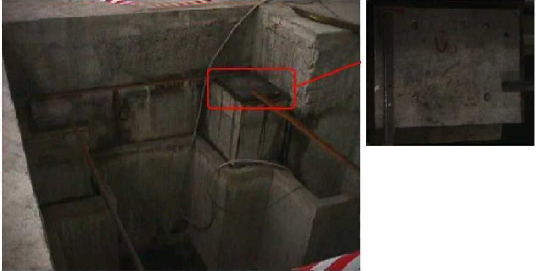
Şekil 3.13 Presin oturacağı beton ayaklar
