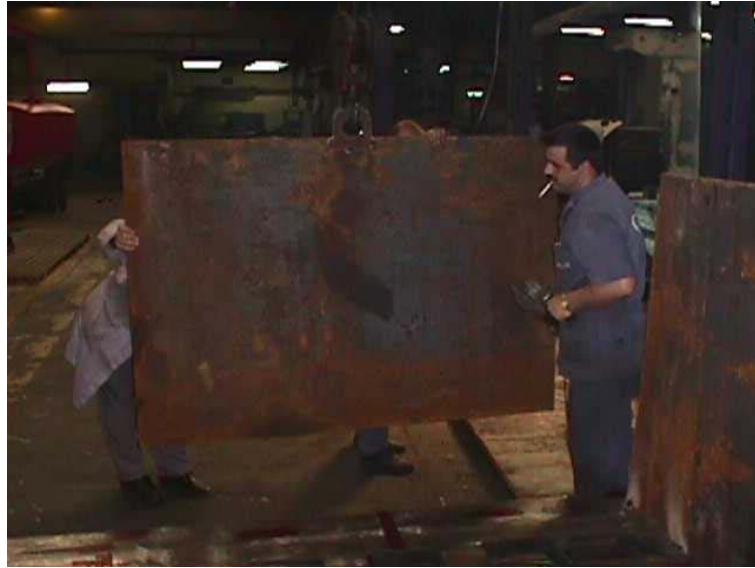
Şekil 3.7 Alt gövdede puntalama işleminin yapılması
