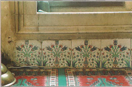
Şekil D. 114. İç mekân, güneydoğu duvarı, P9 alt başlık altındaki çini levhalardan detay. 1999
