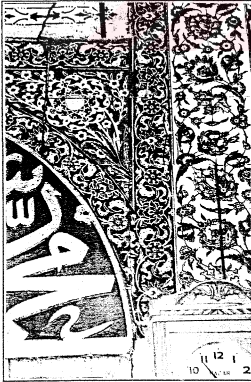
Şekil D.181. İç mekân, güneydoğu duvarı, P10 ve mihrap arasındaki çini derzlerinde açılma (çatlak). 1999
