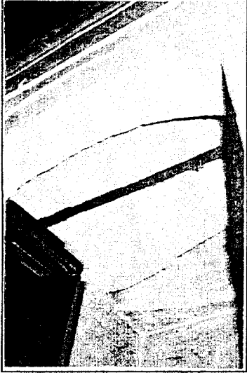
Şekil D. 173. İç mekân, minare giriş kapısı boşluğundaki yardımcı kiriş. 1999
