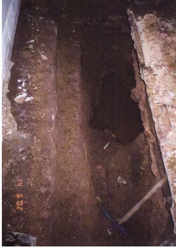
Şekil D15. Kuşakla ma perdesi kazısı; ayrış mış yapıdaki kireç harçlı temel duvarı
