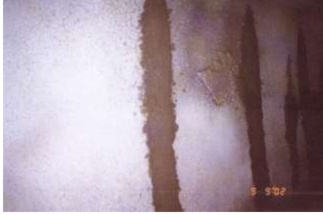
Şekil D32. İkinci kademeye püskürtme betonu uygulanması öncesi
