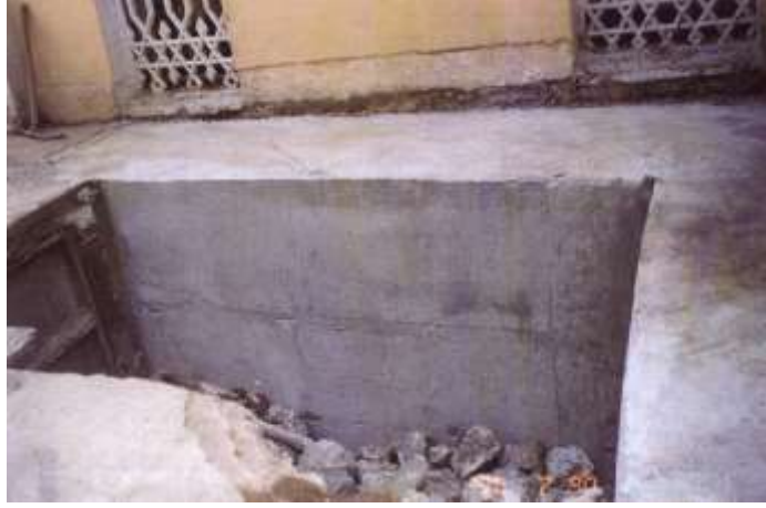
Şekil D23. Eğitim Binası teşviş takviyesi taahhütlenen kuşak perdesi betonu
