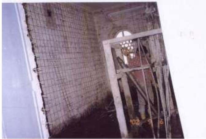
Şekil D31. Shotcrete uygulanması
