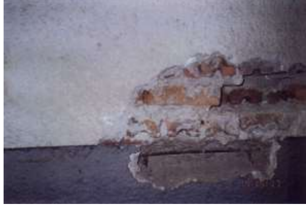
Şekil 4.11. Taşıyıcı tuğla duvarların mevcut durumu
