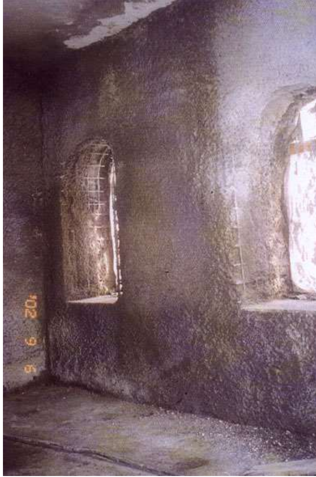
Şekil D33. Püskürtme betonu sonu, sıva düzeltilmesi öncesi
