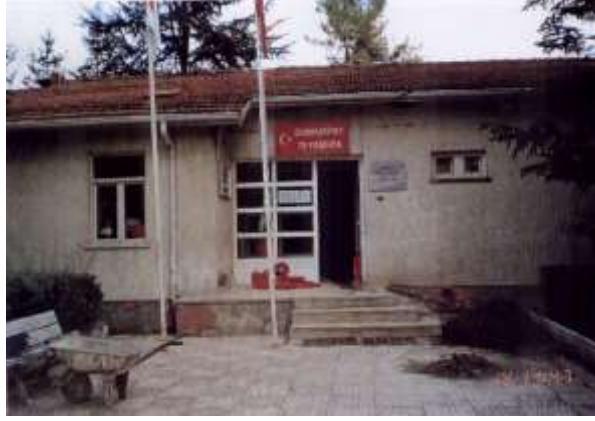
Şekil 4.7. Düzce 1 nolu merkez sağlık ocağı
