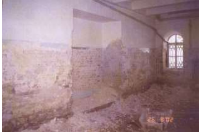
Şekil D27. Taşıyıcı duvarların kompozit hale getirilmesi için duvar sıvalarının kaldırılması, tabana yakın duvarlarda az pişmiş-bozulmuş tuğlalar
