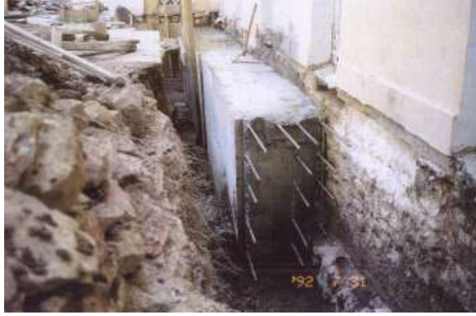
Şekil D22. Teşviş takviyesi taahhütlenen kuşak perdesi betonu
