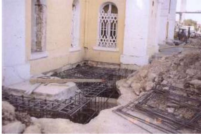
Şekil D18. Te melleri n kar nış k yapı sı di kkte al ınarak donatıları n yerleřtiril mesi
