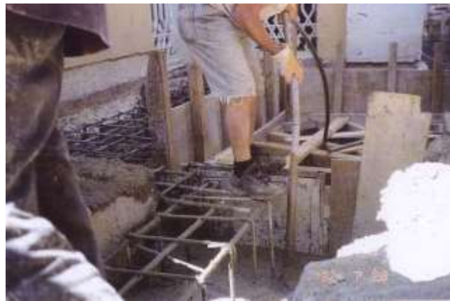
Şekil D21. Temel takviyesi, kuşak perdesi beton dökülmesi ve betonun vibratörle enerek yerleştirilmesi
