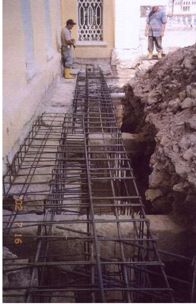
Şekil D20. Yatakhane B'nası Ön Cephe temel ve duvarın karışık yapısı, kötü temel malzemesi dikkate alınarak donatılar yerleştirilmesi ve ankrajlar yapılması
