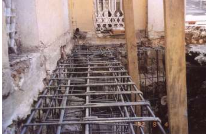
Şekil D17. Eğiti m B nasında te melleri n kar nış k yapı sı, köt ü te mel mal zemesi di kkte al ınarak donatılar yerleřtiril mesi ve ankrajlar yapıl ması
