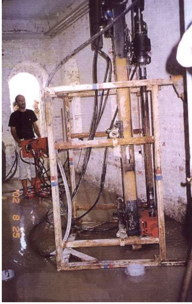
Şekil D25. Eğitimi nası jet grout ve enjeksiyon uygulanması
