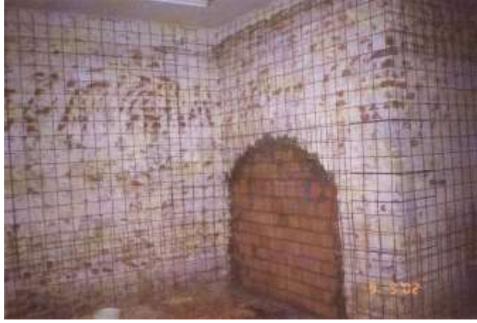
Şekil D30. Duvar yüzlerine hasır çelik yerleştirilmesi, taban-tavan ve duvar yüzlerine ankrajların yerleştirilmesi
