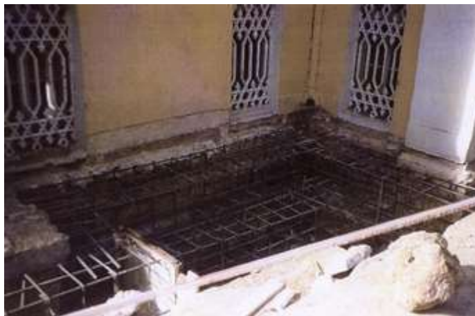
Şekil D19. Yatakhane B nası Arka Cephe te melleri n kar nış k yapı sı, köt ü te mel mal ze mesi di kkte al ınarak donatılar yerleřtiril mesi ve ankrajlar yapıl ması
