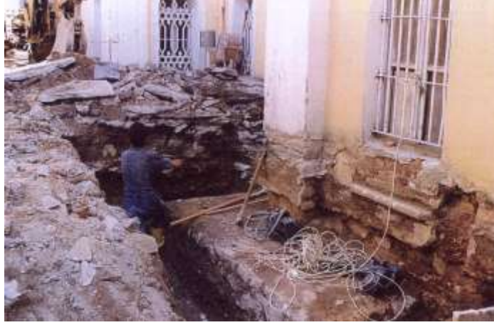
Şekil D12. Yatıkhane Binası Kuşaklama Perdesi kazısı; temellerin karışık yapısı
