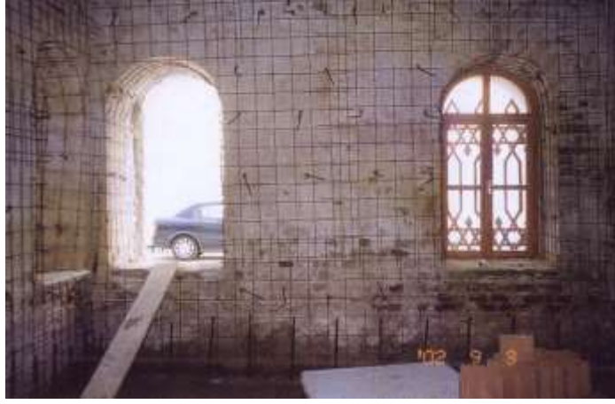
Şekil D29. Duvar yüzlerine ve pencere içlerine hasır çelik yerleştirilmesi, taban-tavan ve duvar yüzlerine ankrajların yerleştirilmesi
