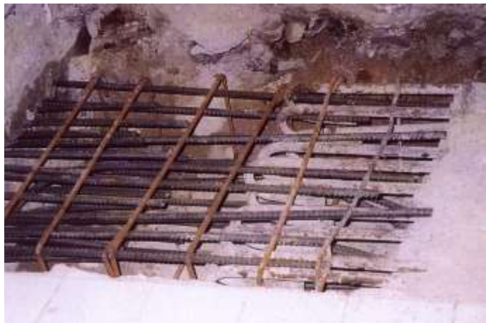
Şekil D24. Yatakhane binası ön ve orta bloğun birleştirilmesi
