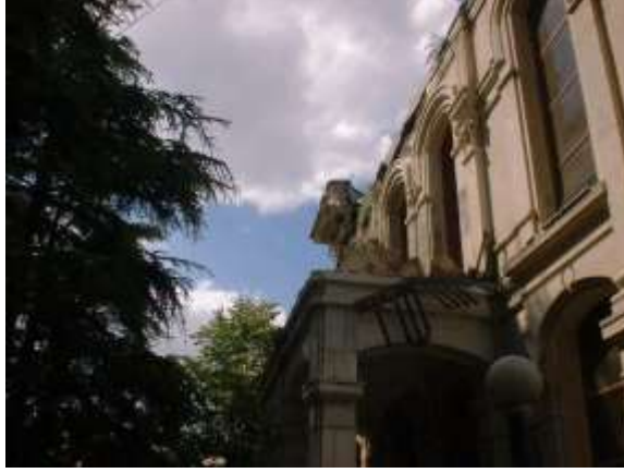
Şekil 4.2 Güney cephe duvarında oluşan hasarlar
