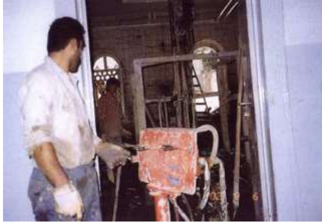
Şekil D26. Jet grout ve enjeksiyon uygulanması
