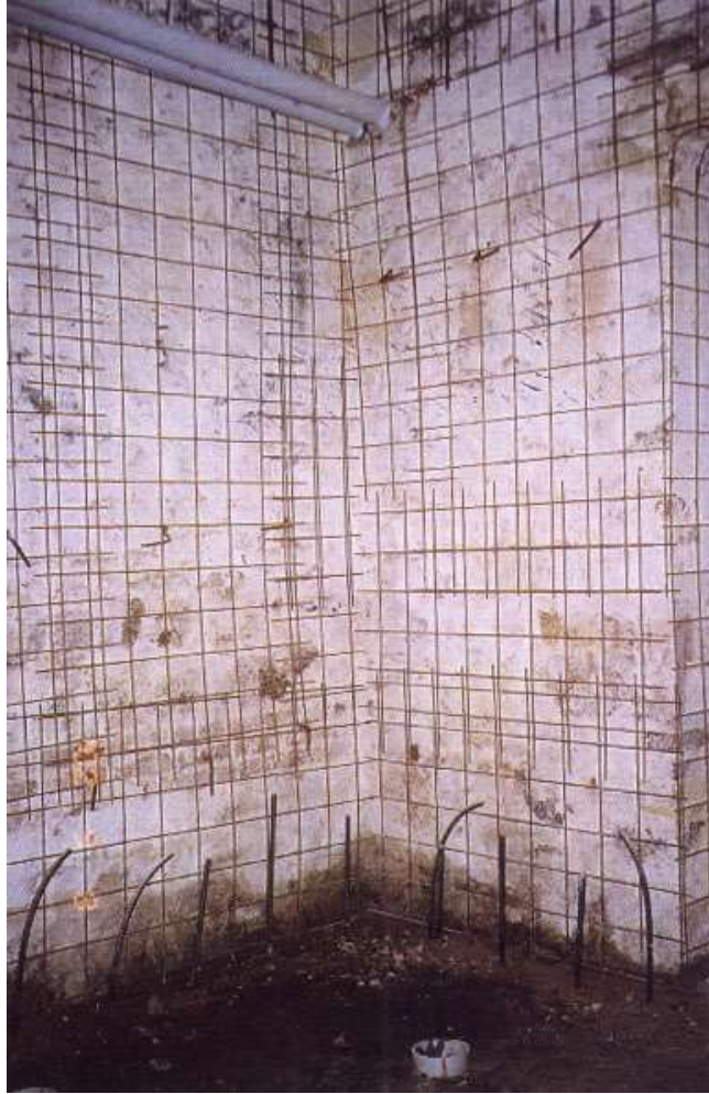
Şekil D28. Duvarda hasır çelik yerleştirilmesi, taban ve tavanda epoksili ankraj yerleştirilmesi
