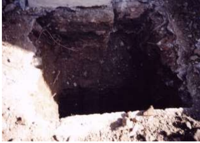
Şekil D3. Yatakhane binası kuzeydoğu muayene çukuru
