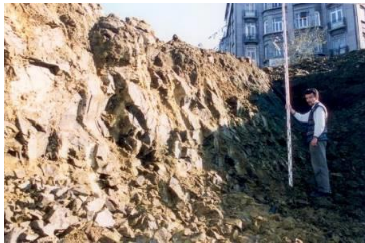
Şekil 5.7 : Şişhane Metro istasyonu 1 no.lu konkors yapısının kazısı (İBB,1999).
