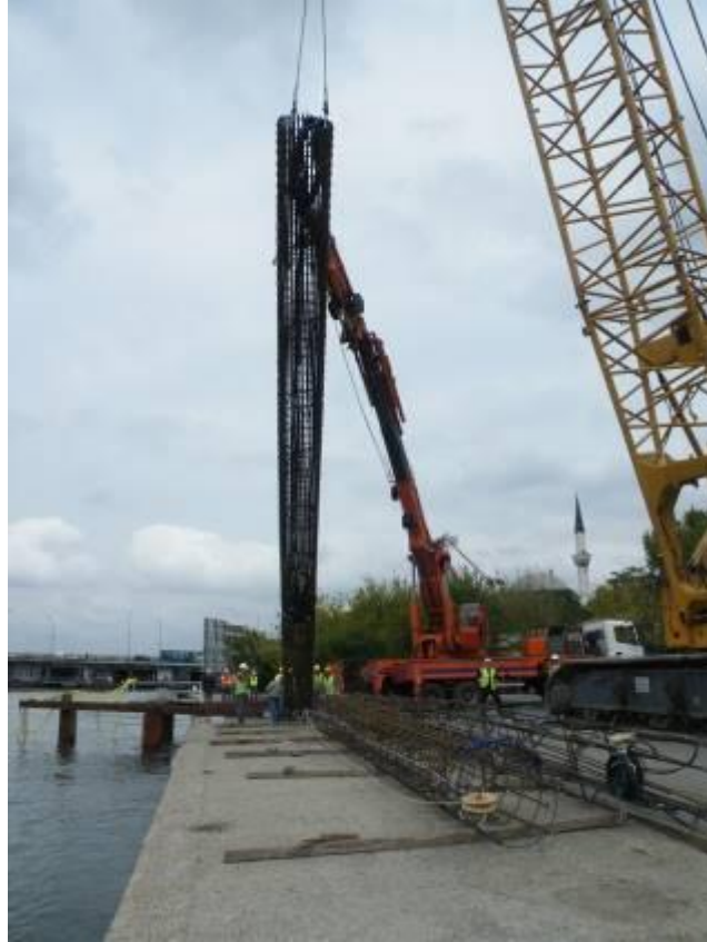
Şekil C-2 : TP1 no.lu test kazığının çakımı ve donatı yerleştirilmesi.
