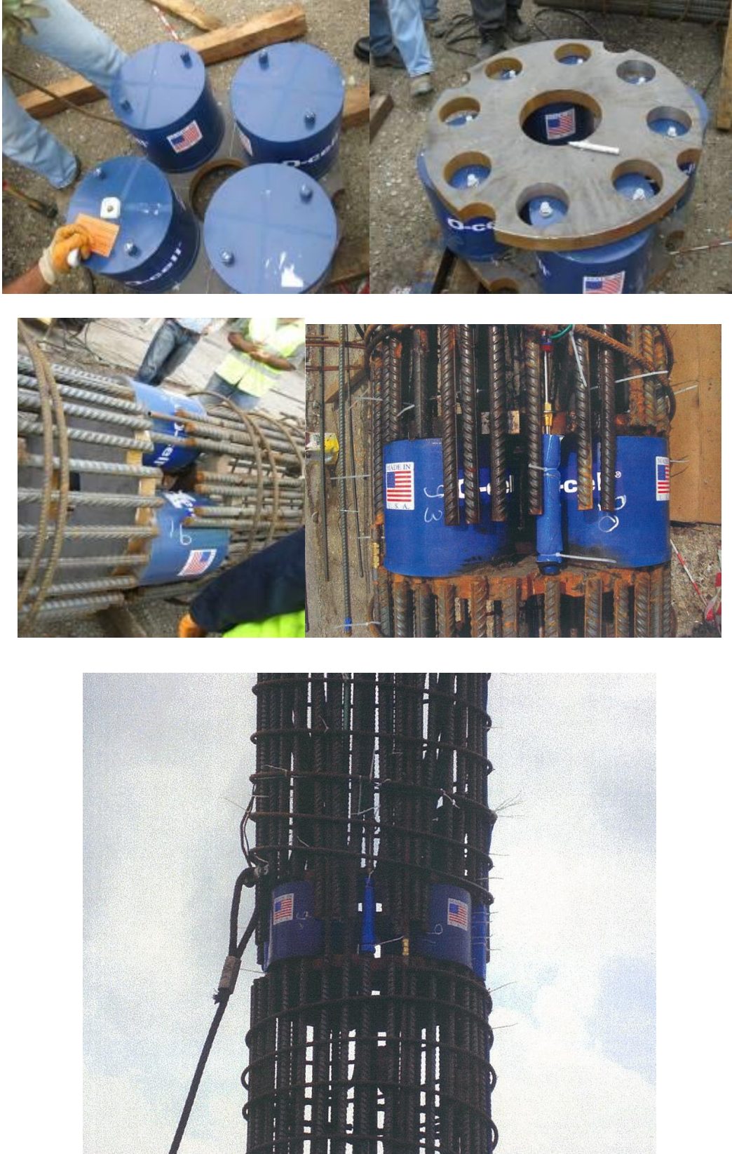
Şekil C-3 : TP1 no.lu test kazığında Osterberg hücrelerinin montaj aşamaları.
