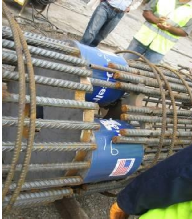
Şekil D-2 : P3-4B no.lu proje kazığına O-cell hücresi montajı.
