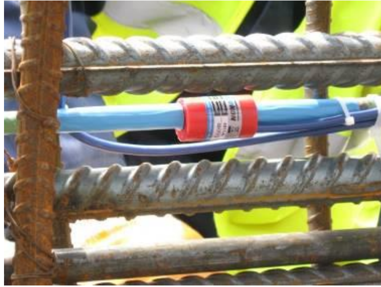
Şekil C-4 : TP1 no.lu test kazığında deformasyon ölçer montajı.
