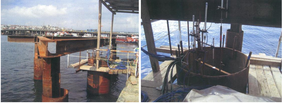
Şekil 6.13 : TP1 no.lu deney kazığı çevresinde servis kazıklarıyla teşkil edilen referans giriş.
