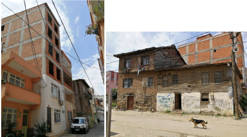
Şekil 5.3 : Köyde yeni yapılan betonarme yapılar ve eski tip evler.
