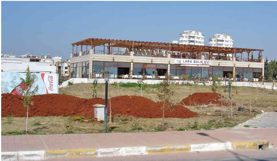
Şekil 5.19: Kent meydanında kaçak çıkmalara maruz kalan yapılar.
