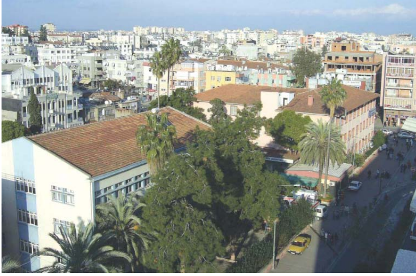
Şekil 5.11: Okullar bölgesinde yıkılan üç yapı (MO arşivinden).
