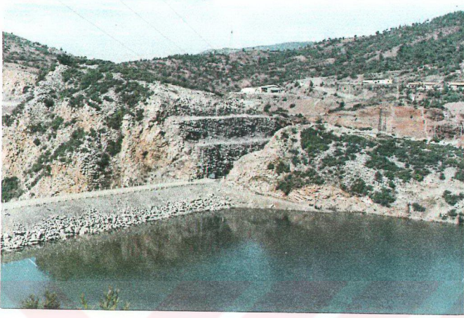
Foto: D-5 Kalecik Barajında Geçirimli Kireçtaşının Membadan görünüşü
