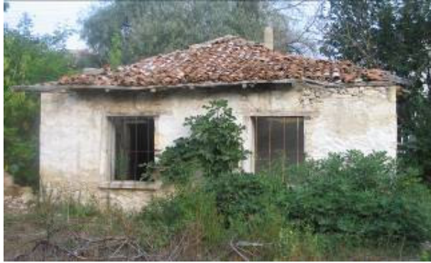
Şek.C2.3D/6. [39.7/1] no'lu evin batı cephesi (yıl:2005)
