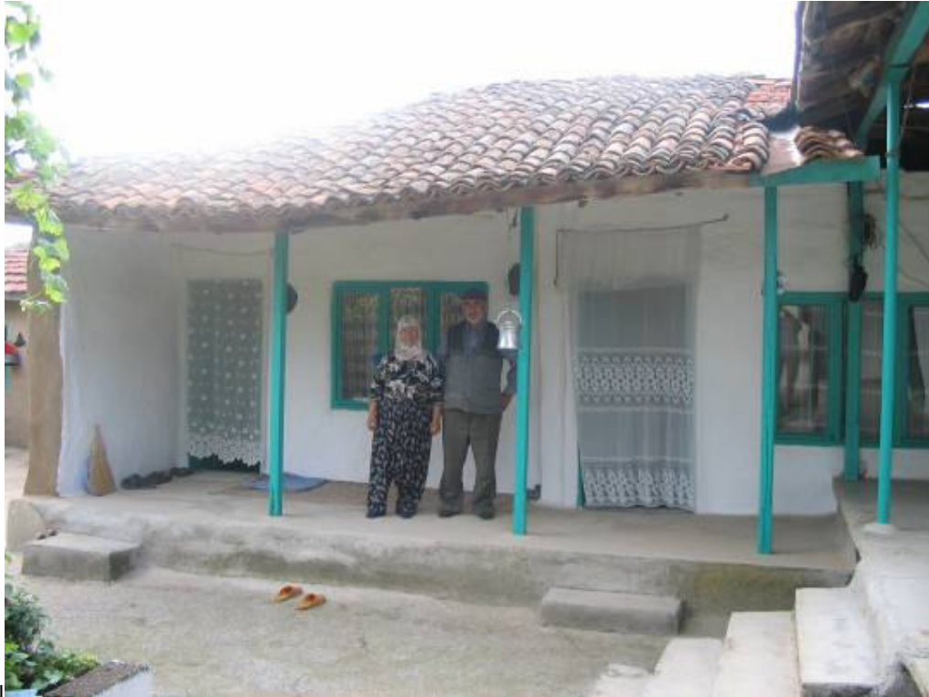
Şek.C2.5D/2. [39.1.8/2] no'lu evin giriş cephesi
