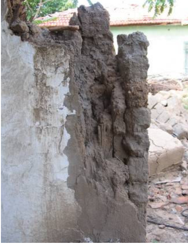
Şek.C2.5D/7. [39.1.8/1] no'lu evin ahşap taşıyıcılı kerpiç duvarı
