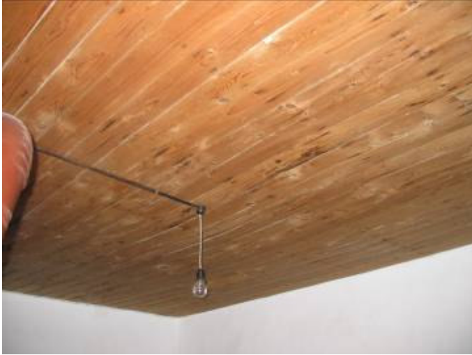
Şek.C2.5D/10. [39.1.8/2] no'lu evin oda tavan kaplaması
