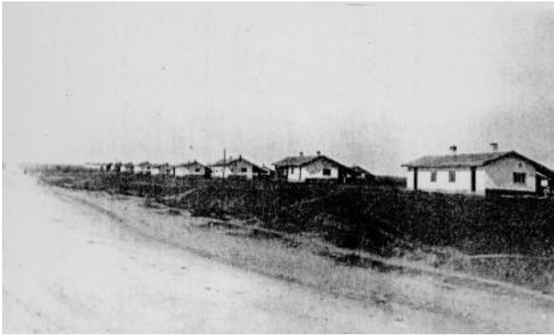
Şek.B2/12. Edirne'nin Havsa Nahiyesi'nde yapılan göçmen evleri (EİY, 1938:85)
