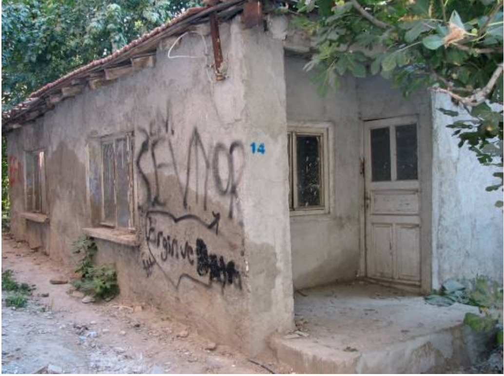
Şek.C2.3A/3. [39.1/1] no'lu yapının güney ve batı cephesi
