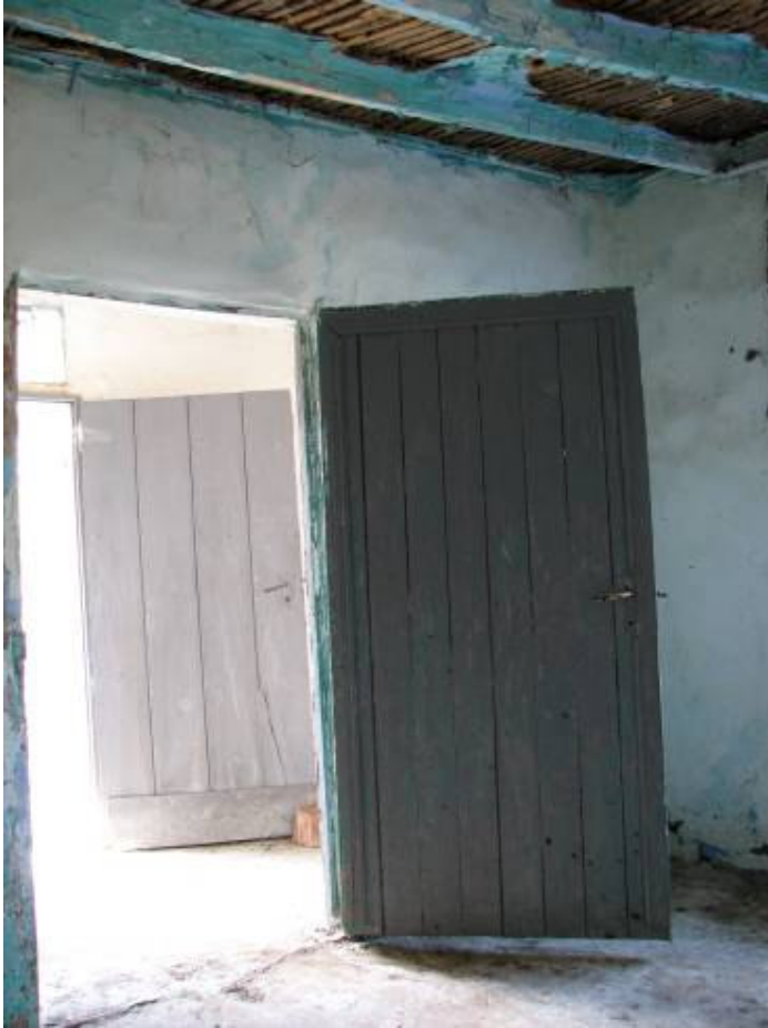
Şek. C2.3C/8. [39.7.1/1] no'lu evin mutfak ve dış kapısı
