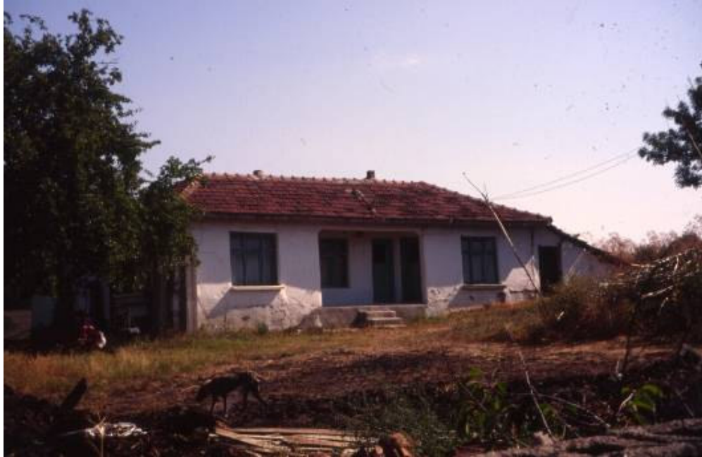
Şek.C2.6A/2. [39.2.1/1] no'lu evin giriş cephesi
