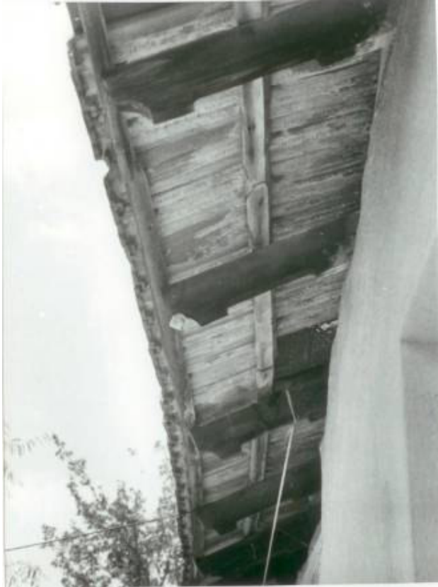
Şek. C3B/21. [59.03.075] no'lu evin saçak detayı
