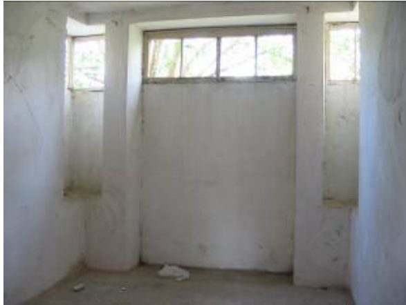
Şek.C2.3D/32. Zemin katta kuzeydoğuda yer alan odanın pencerelerinin içten görünümü
