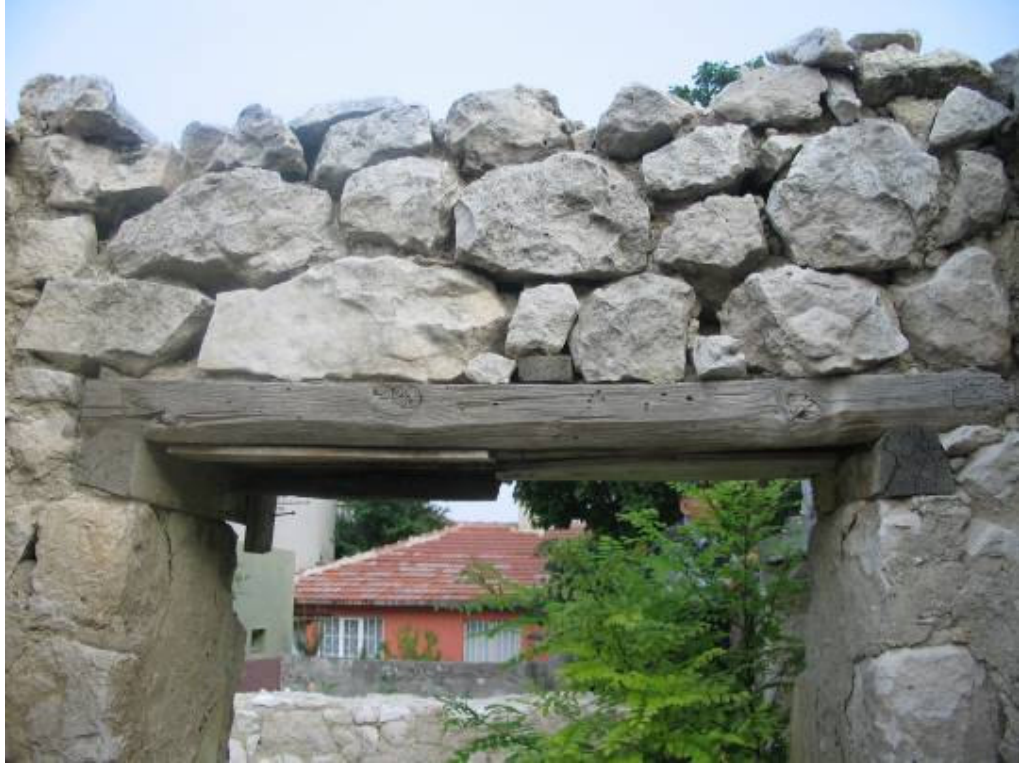
Şek.C2.3D/11. [39.7/2] no'lu evin duvar örgü detayı
