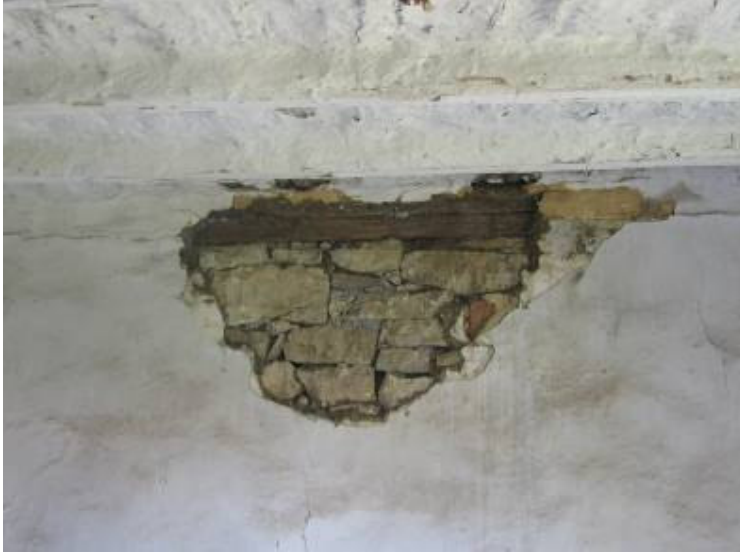
Şek.C2.3F/5. [39.8.1/1] no'lu evin duvar örgü detayı
