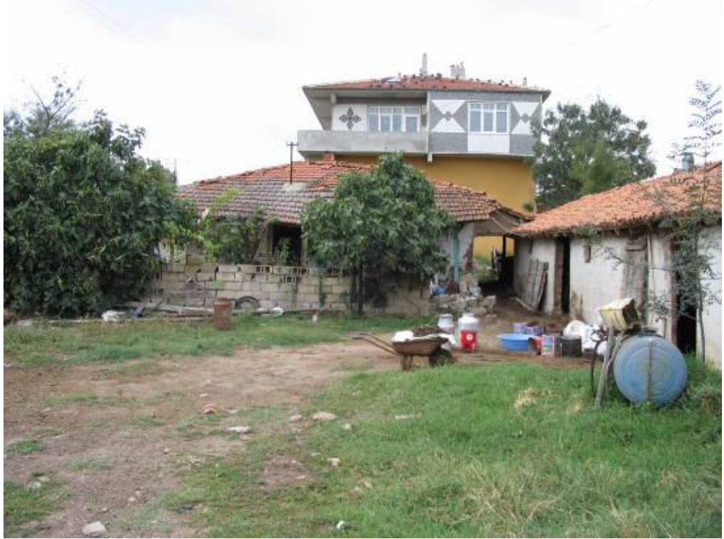
Şek. C3A/20. Çok katlı betonarme yapılaşma ile Erken Cumhuriyet Dönemi yapılarının ilişkisi
