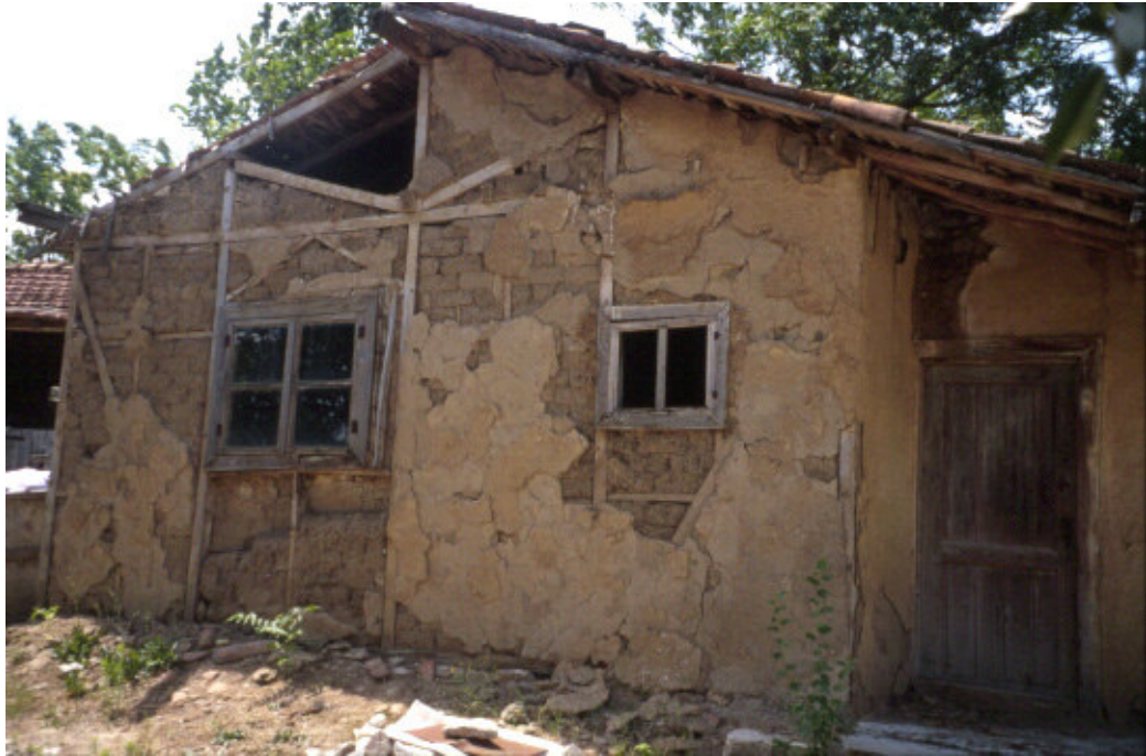
Şek.C2.4B/7. [39.5.1/2] no'lu evin ahşap karkas sistemi
