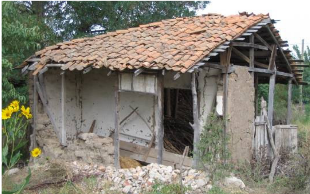
Şek.C2.5C/2. [39.1.7/1] no'lu evin güney cephesi
