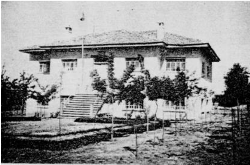
Şek.B4/11. Afyon Haydarlı Köyü Köy Konağı (AfîY, 1938:155)
