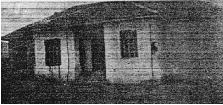
Şek.B3/50. Eskişehir'de İsmet Paşa Okulu (EsiY, 1938:103)
