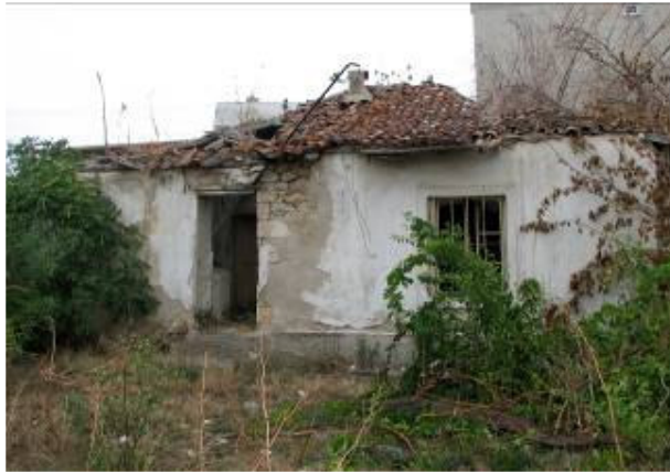
Şek.C2.3D/7. [39.7/1] no'lu evin güney (giriş) cephesi (yıl:2007)
