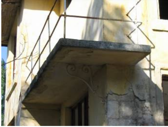
Şek.C2.3D/30. [39.7/5] no'lu numune fidanlık binasının batı cephesindeki balkon
