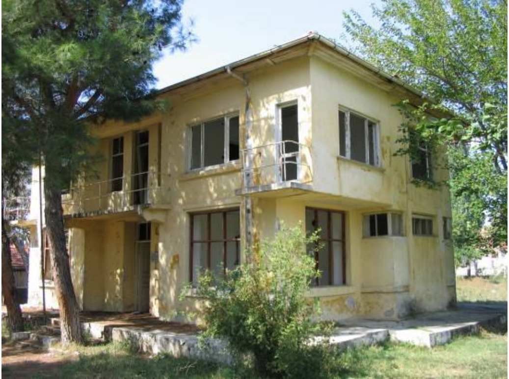
Şek.C2.3D/25. [39.7/5] no'lu numune fidanlık binasının güney ve doğu cephesi
