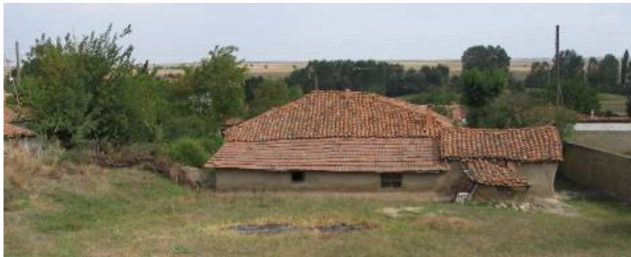
Şek. C3A/16. Arkasında ek yapılar bulunan bir yapının arkadan (batıdan) görünüşü
