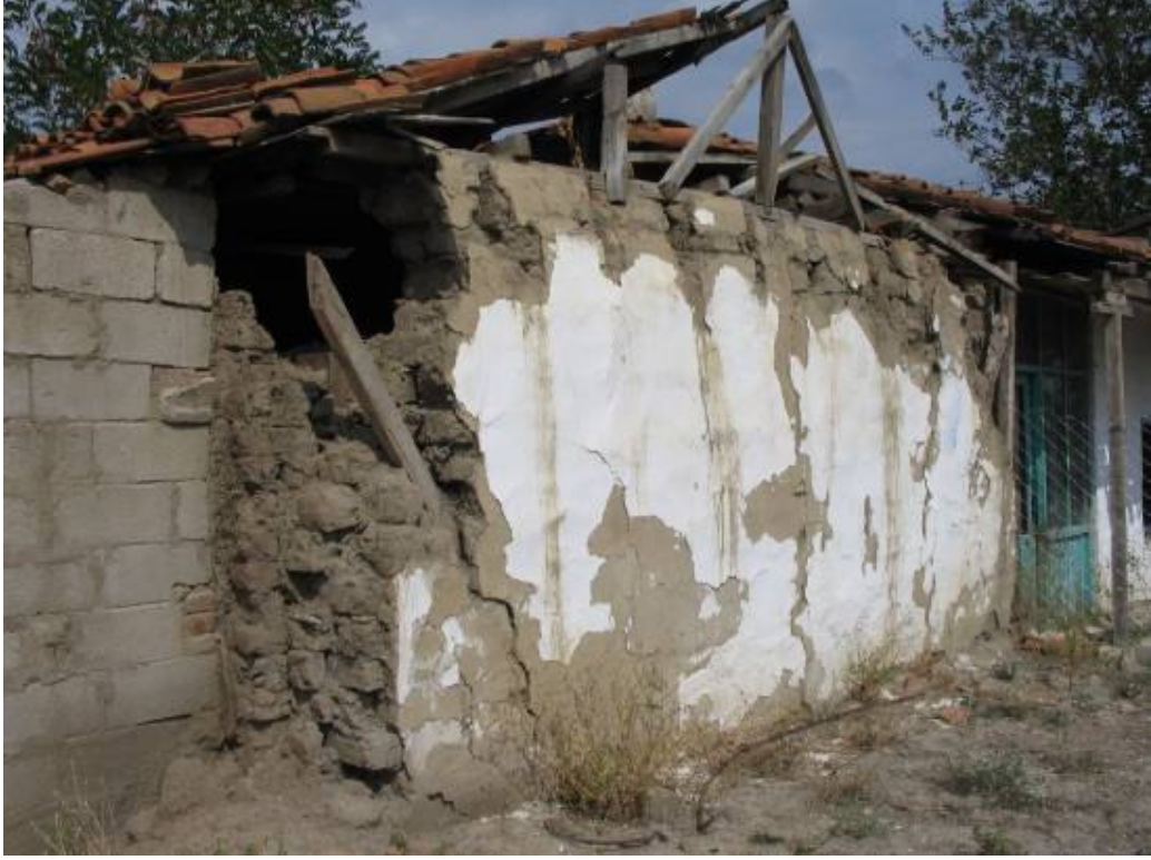
Şek. C3A/17. Ahşap karkas ve kerpicin birlikte kullanıldığı “bütünleşik yapı sistemi”
