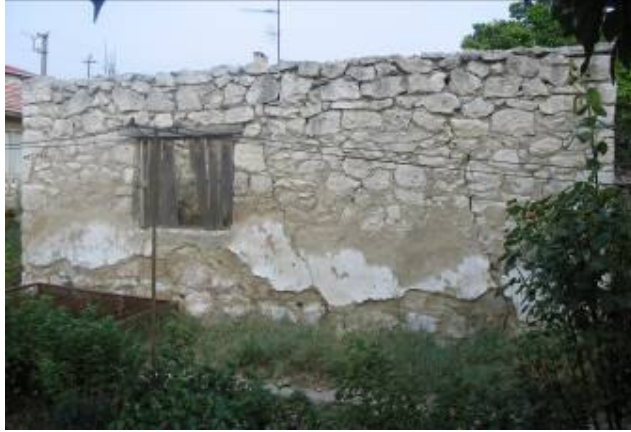
Şek.C2.3D/9. [39.7/2] no'lu evin batı cephesi
