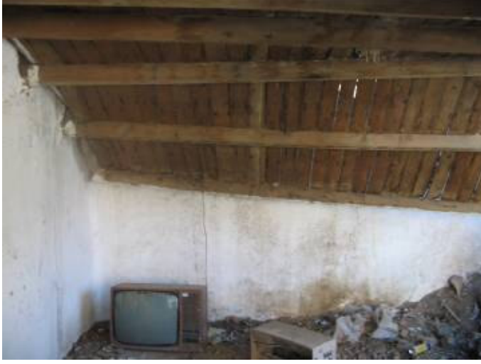
Şek.C2.5D/9. [39.1.8/1] no'lu evin iç mekânındaki ahşap tavan kaplaması
