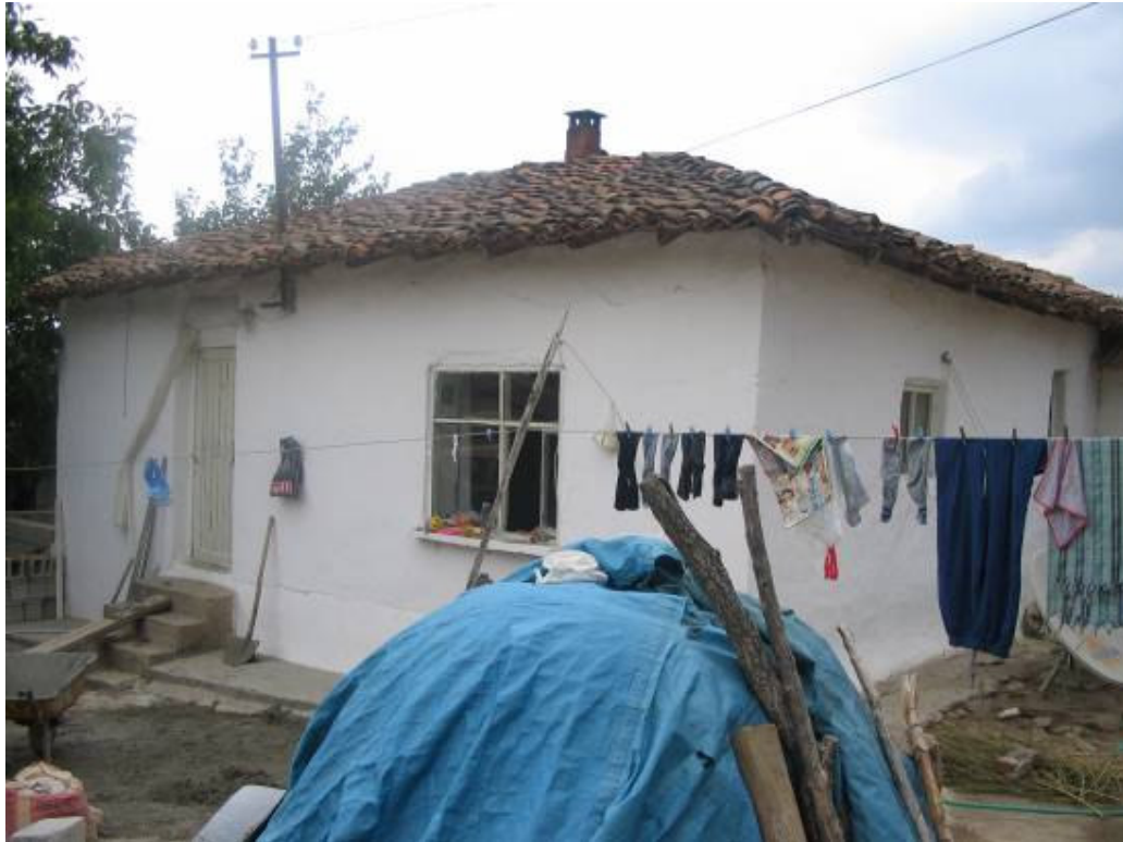
Şek.C2.5A/2. [39.1.5/2] no'lu evin giriş cephesi
