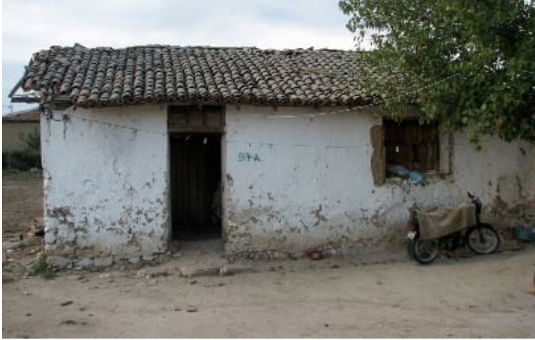
Şek.C2.5A/6. [39.1.5/4] no'lu evin doğu (giriş) cephesi
