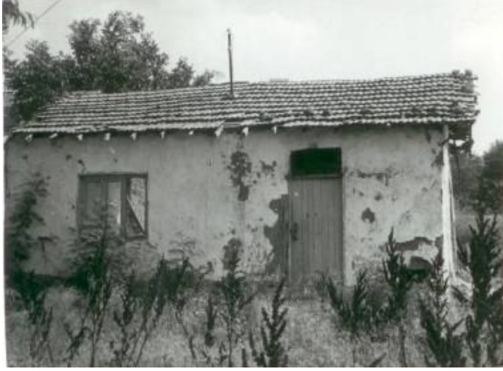
Şek. C3B/22. Batı kanadı yıkılmış olan [59.03.068] no'lu ikiz ev
