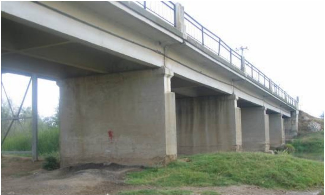
Şek.C2.5B/4. İnece Köprüsü
