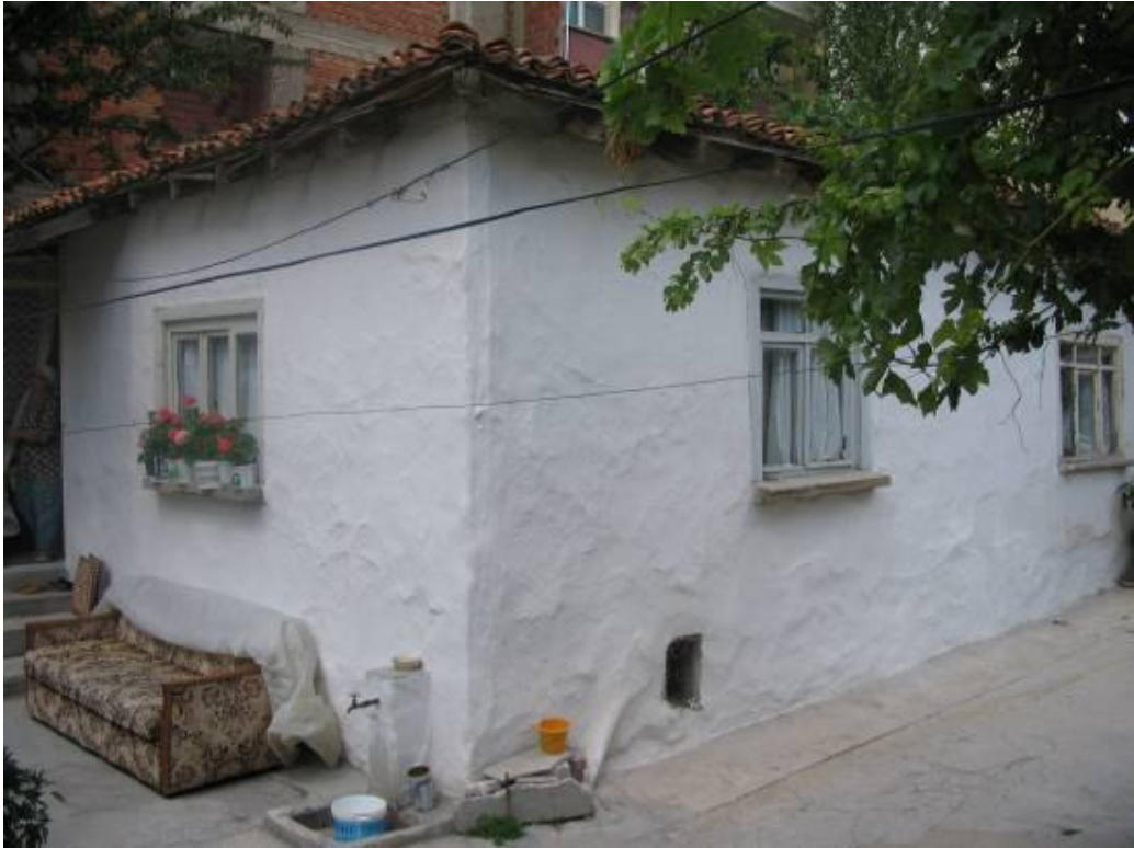
Şek.C2.3A/4. [39.1/2] no'lu yapının kuzey ve doğu cephesi
