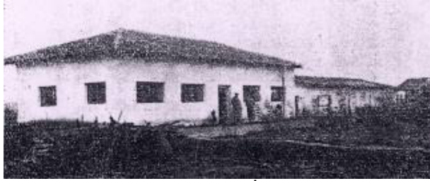
Şek.B6/3. Vize fidanlık binası (KİY, 1938:29)
