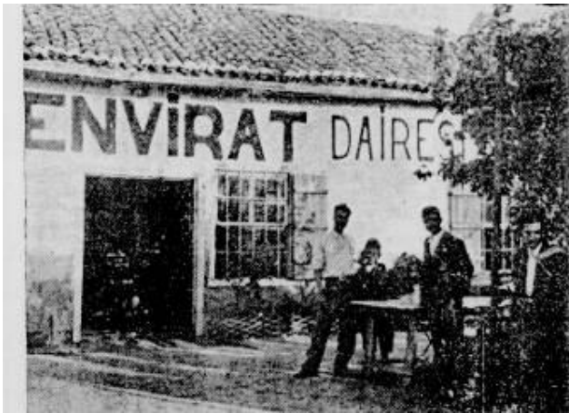
Şek.B5/3. İzmir Armutlu Köyü elektrik işleri yapısı (İzKK, 1935:27)
