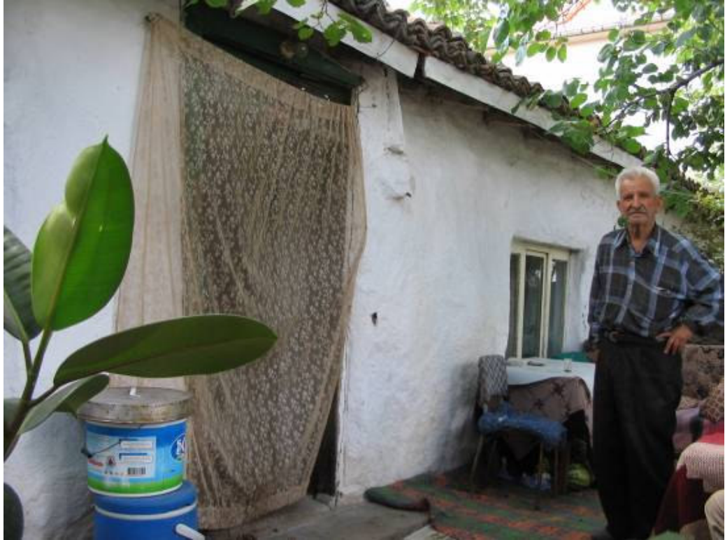
Şek.C2.3D/21. [39.7/4] no'lu evin kuzey cephesi
