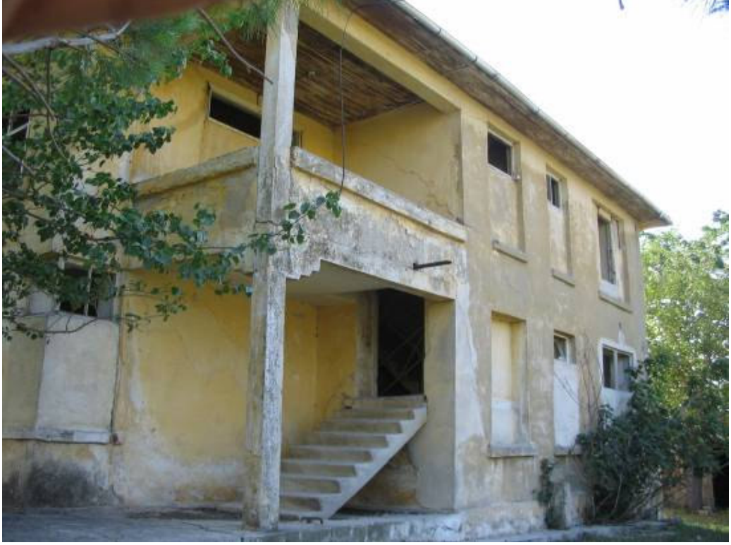
Şek.C2.3D/26. [39.7/5] no'lu numune fidanlık binasının kuzey cephesi
