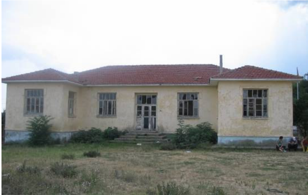
Şek.C2.5A/11. [39.1.5/5] no'lu okulun kuzey giriş cephesi
