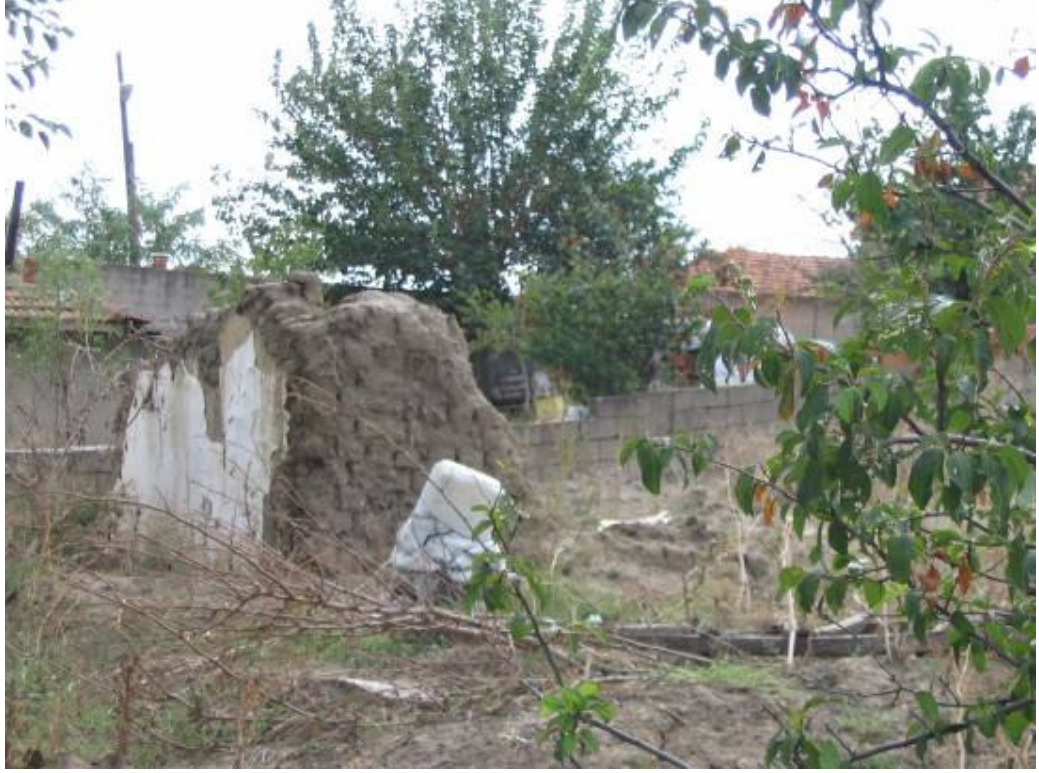
Şek. C3A/19. Yıkılmış bir yapının kalıntısı
