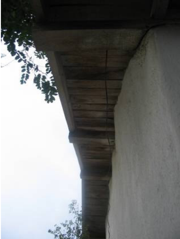
Şek.C.2.2A/4. [39.1.1/1] no'lu evin saçak detayı
