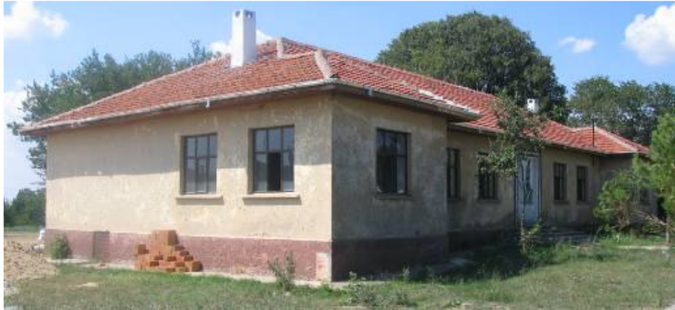
Şek.C2.3F/8. [39.8.1/2] no'lu okulun kuzey ve doğu cephesi
