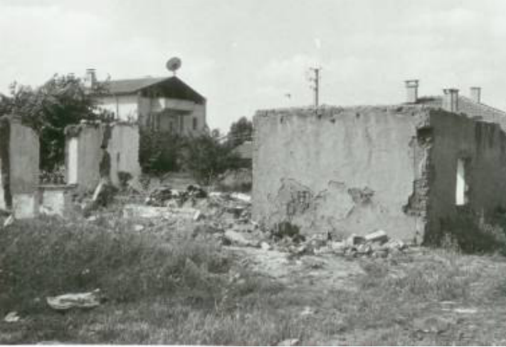
Şek. C3B/18. Yıkık durumdaki ev [59.03.026] no'lu yığma kerpiç ev
