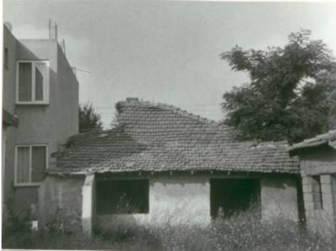
Şek. C3B/24. Yarısı yıkılarak yerine apartman yapılan [59.03.002] no'lu ev
