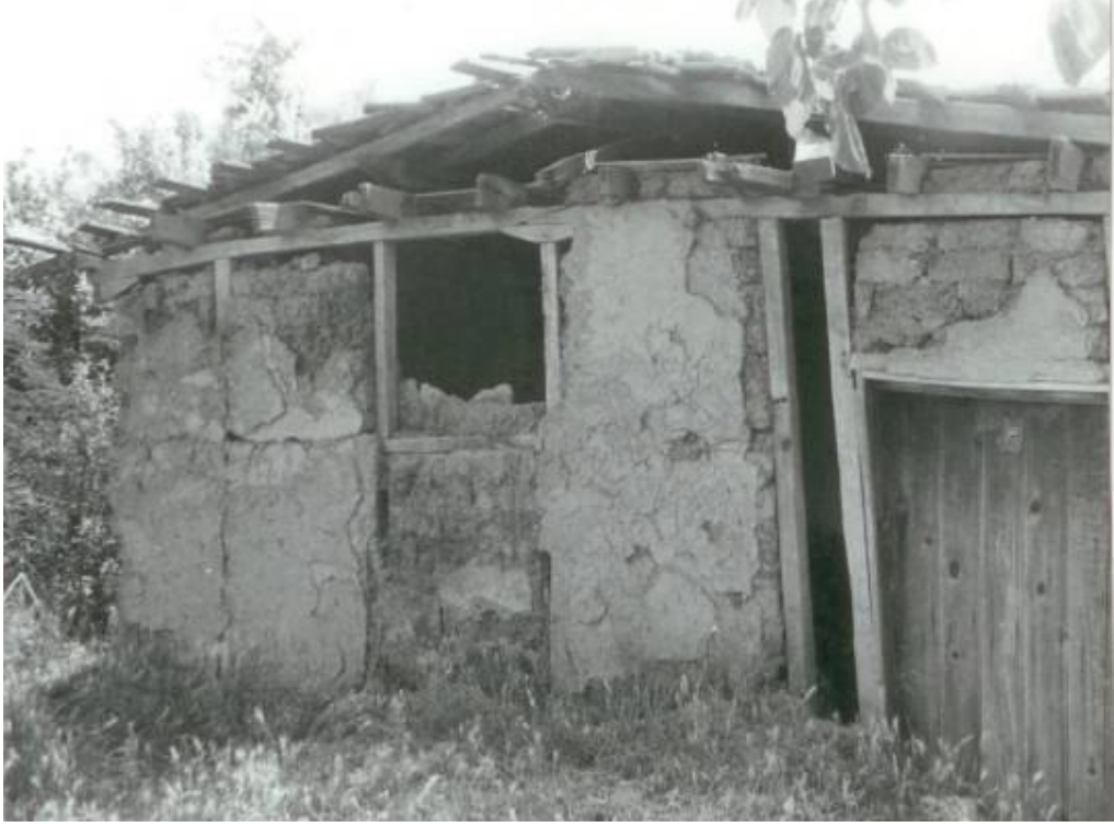
Şek. C3B/20. Ahşap karkas duvar sistemi, [59.03.052] no'lu ev
