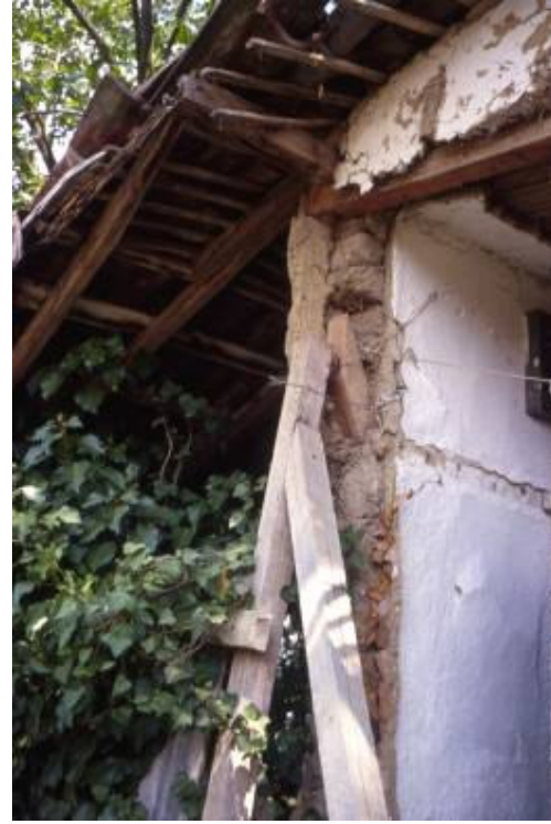
Şek.C2.4B/6. [39.5.1/2] no'lu evin karkas yapı sistemi detayı
