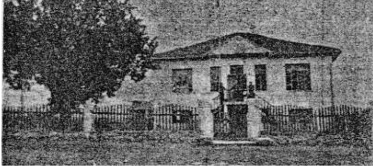
Şek.B3/49. Eskişehir Kırka Köyü Okulu (EsiY, 1938:103)
