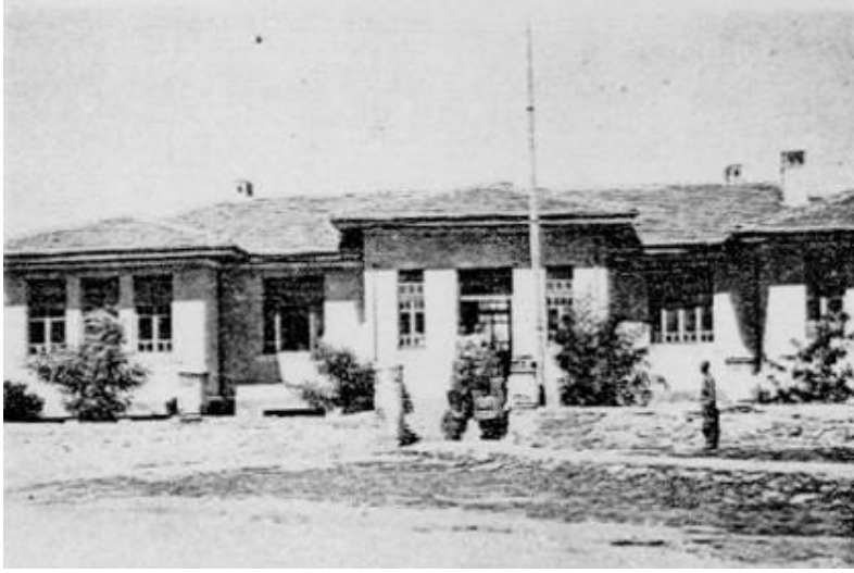
Şek.B4/5. Afyon Sinan Paşa Köyü Köy Konağı (AfîY, 1938:154)
