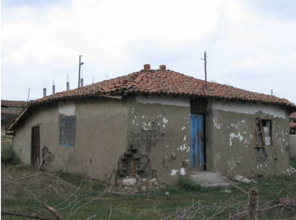
Şek. C3A/18. Taş temel ve üzerinde ahşap dikme ile kerpîç duvar örgüsünün görüldüğü “bütünleşik yapı sistemi”
