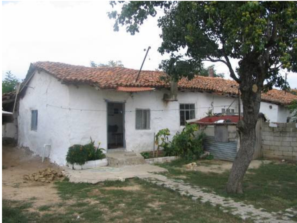
Şek.C2.5E/2. [22.3/1] no'lu ikiz evin güney cephesi
