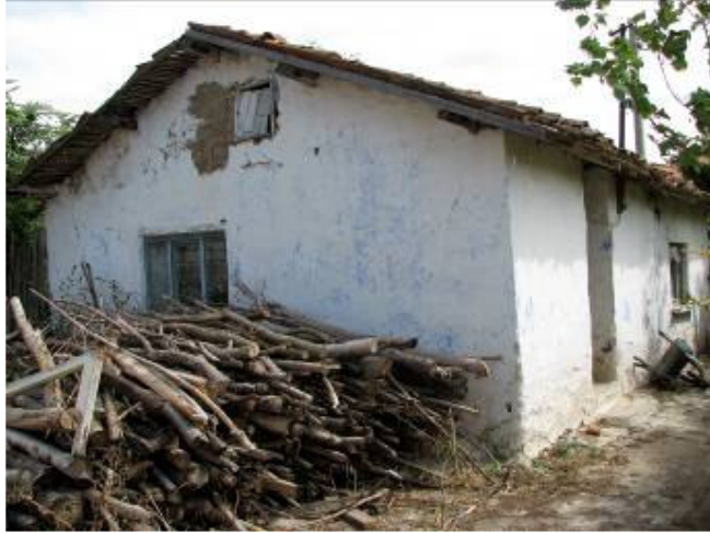
Şek. C2.3C/4. [39.7.1/1] no'lu evin batı ve güney cephesi
