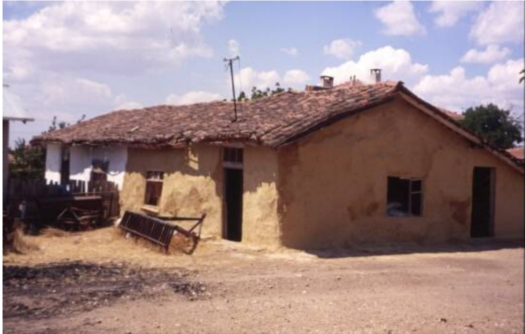
Şek.C2.4C/5. [39.5.2/2] no'lu ikiz evin güney cephesi
