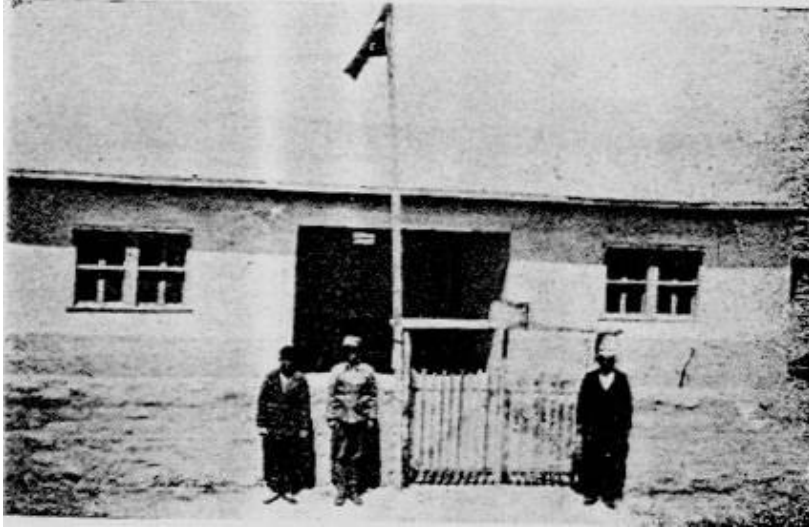
Şek.B4/10. Afyon Danık Köyü Köy Konağı (AfîY, 1938:149)
