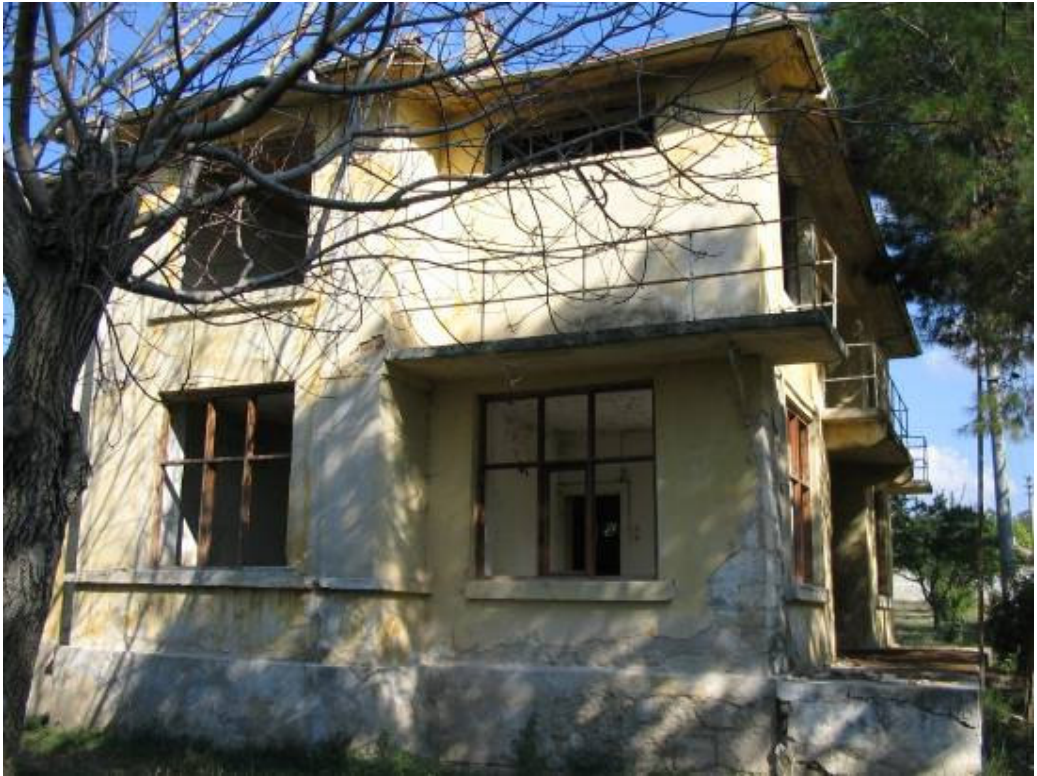
Şek.C2.3D/27. [39.7/5] no'lu numune fidanlık binasının batı cephesi
