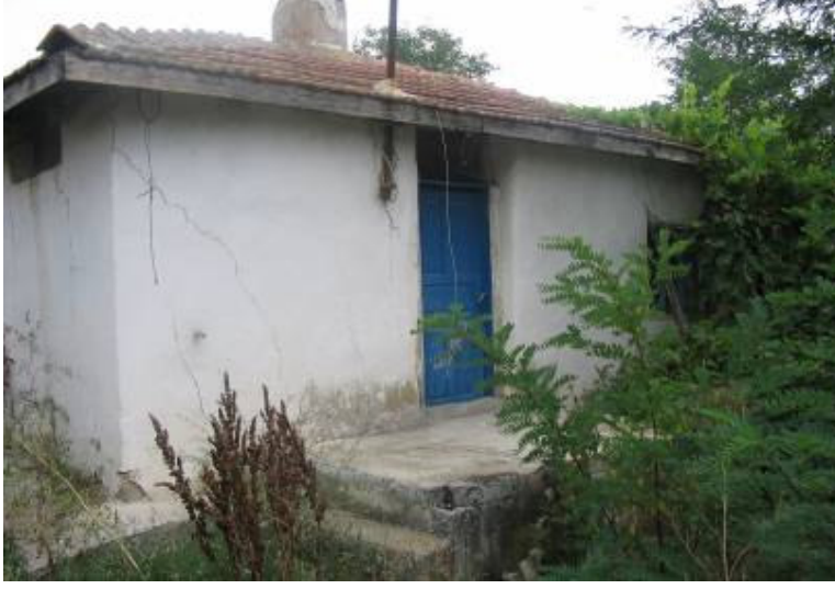
Şek.C2.5A/5. [39.1.5/3] no'lu evin giriş cephesi
