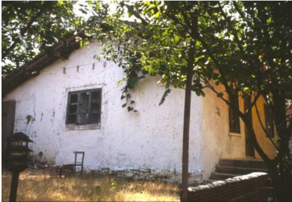
Şek.C2.4B/4. [39.5.1/1] no'lu evin kuzey ve batı (giriş) cephesi
