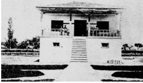
Şek.B6/1. Afyon Sandıklı'ya bağlı Sorkun Köyü'ndeki fidanlık binası (AfİY, 1938:145)
