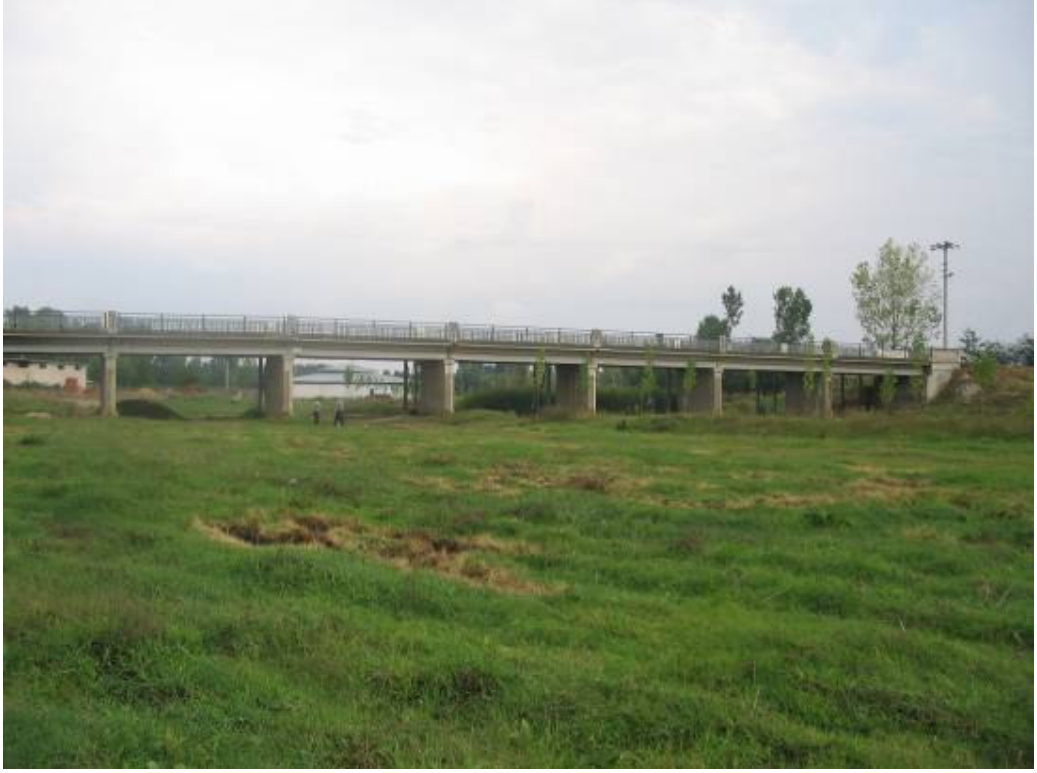
Şek.C2.5B/3. İnece Köprüsü
