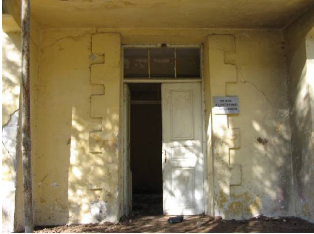
Şek.C2.3D/28. [39.7/5] no'lu numune fidanlık binasının ana giriş kapısı
