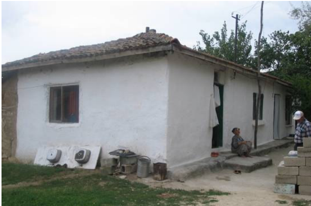
Şek.C2.5A/4. [39.1.5/1] no'lu evin giriş cephesi
