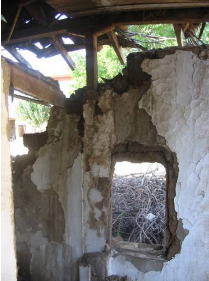
Şek.C2.5D/6. [39.1.8/1] no'lu evin ahşap taşıyıcılı kerpiç duvarı
