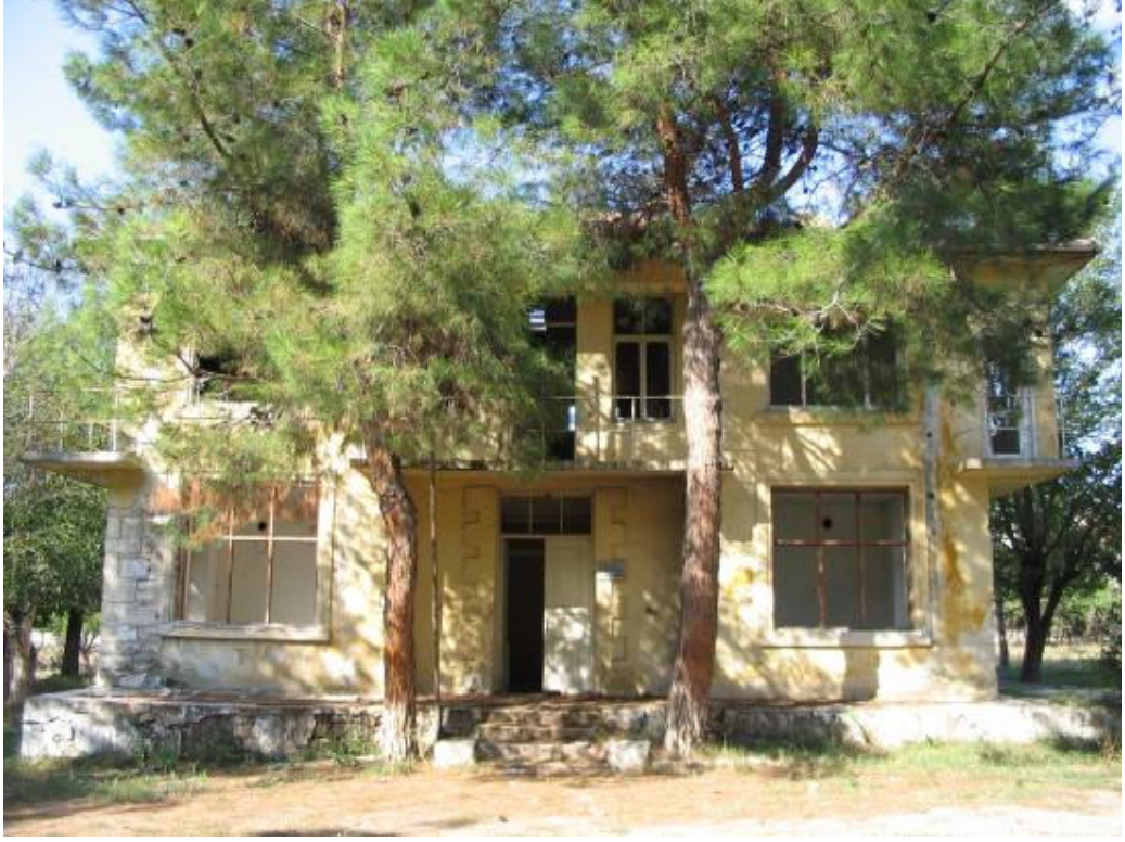
Şek.C2.3D/24. [39.7/5] no'lu numune fidanlık binasının güney cephesi
