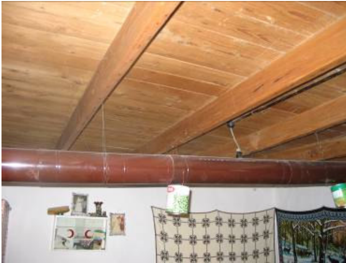
Şek.C2.5D/11. [39.1.8/2] no'lu evin oda tavan kaplaması
