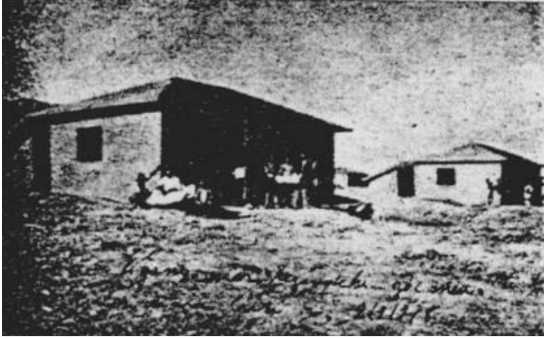
Şek.B2/10. Diyarbakır Ergani'ye bağlı Harbato Köyü'nde göçmen evleri (DiİY, 1938:106)
