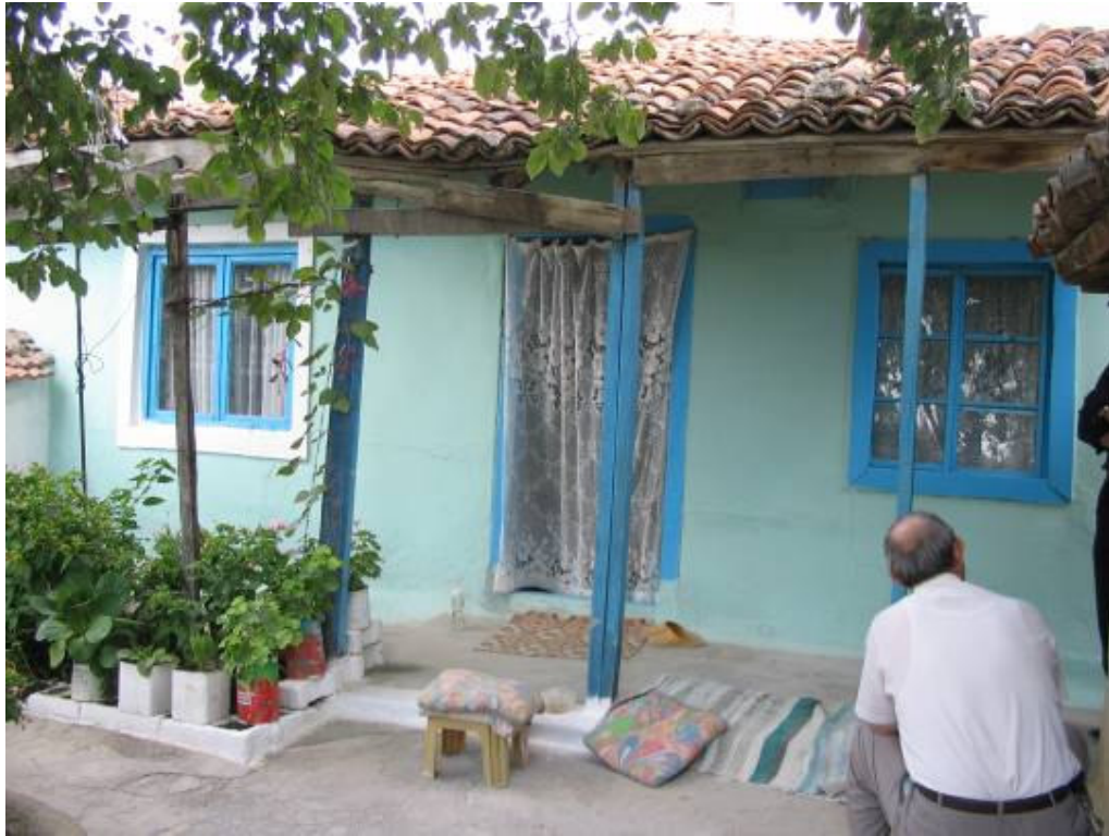
Şek.C2.3D/19. [39.7/3] no'lu evin güney cephesi
