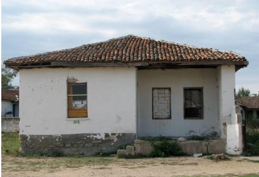
Şek.C2.5A/16. [39.1.5/6] no'lu öğretmen lojmanının doğu giriş cephesi
