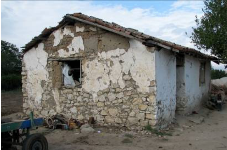
Şek.C2.5A/7. [39.1.5/4] no'lu evin güney cephesi
