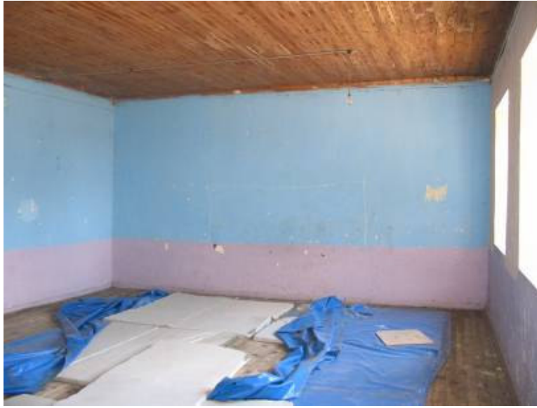
Şek.C2.3F/11. [39.8.1/2] no'lu okulun dersliğı
