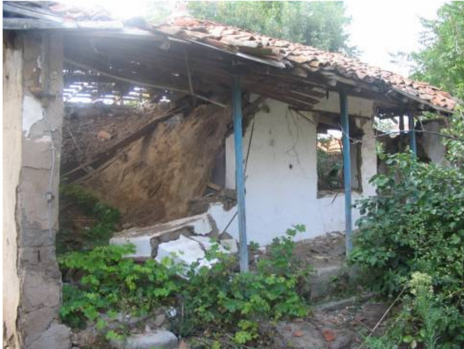
Şek.C2.5D/4. [39.1.8/1] no'lu evin güneydoğu cephesi
