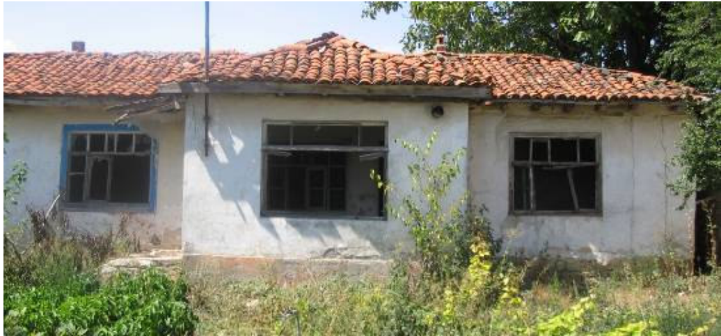
Şek.C2.3F/3. [39.8.1/1] no'lu evin doğu cephesi
