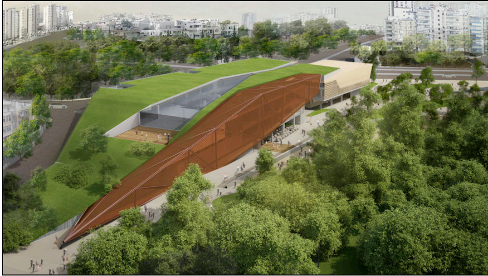
Şekil 3.37 : Adana Çukurova İlçe Belediyesi Hizmet Binası ve Kültür Merkezi, Kent Parkı aksıyla yükselen yeşil çatı formu (URL 10).
