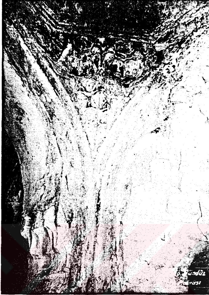
Resim 45. Saray Hamamı-kadınlar bölümü sıcaklık mukarnaslı düz-bingi
