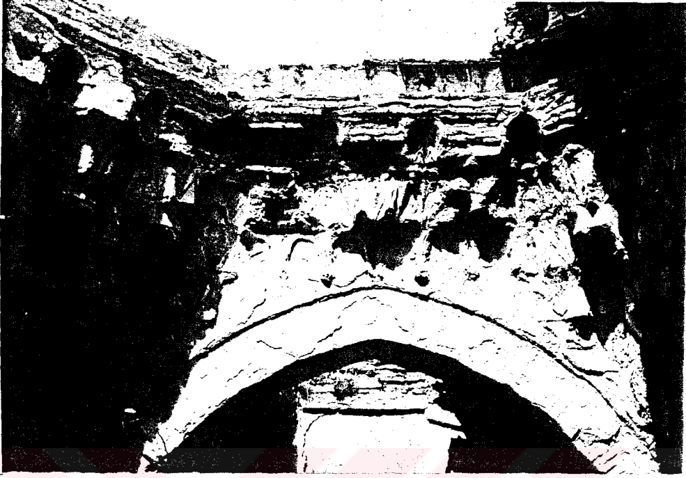
Resim 49. Beylerbeyi Hamamı-sıcaklık hacmi, mukarnaslı düz-bingi geçit alanı ve kubbe eteğinde devam eden mukarnas dizileri
