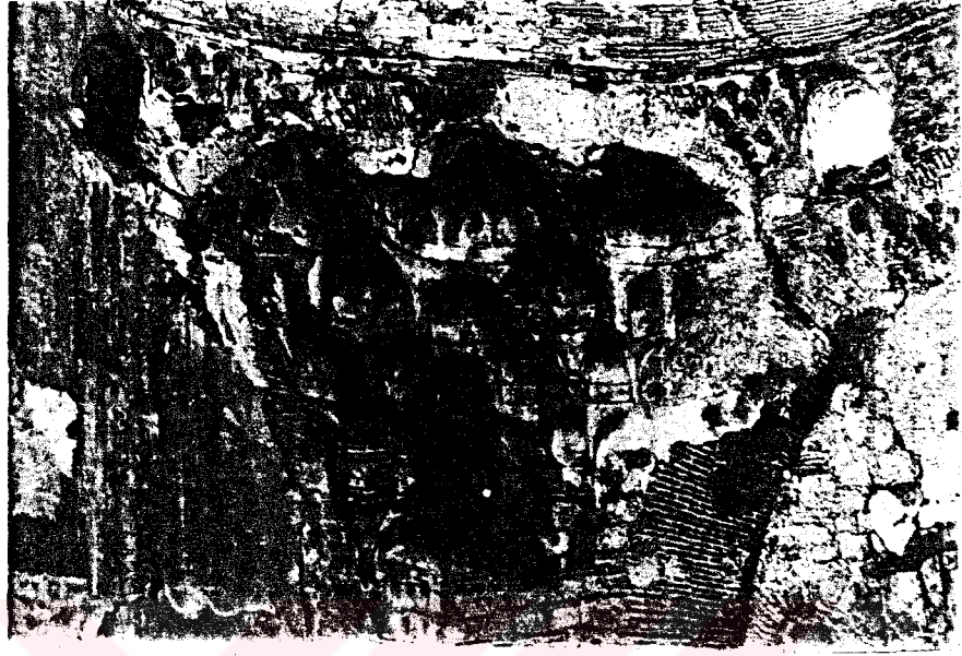
Resim 55. Tahtakale Hamamı-soyunmalık hacminin kubbesi, mukarnaslı düz-bingi
