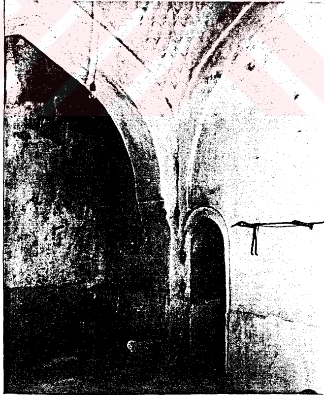
Resim 66. Mezit Bey Hamamı aynı hacimde mukarnaslı düz-bingi ve eyvan kemeri
