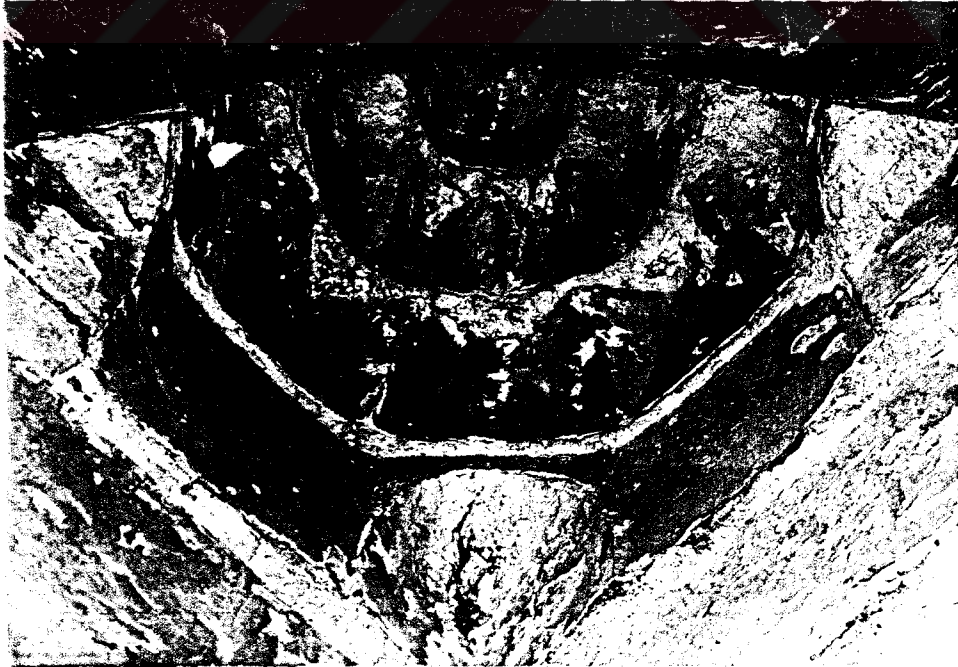
Resim 92. Topkapı Hamamı-aynı hacimde mukarnaslı tonoz-bingin alttan görünüşü
