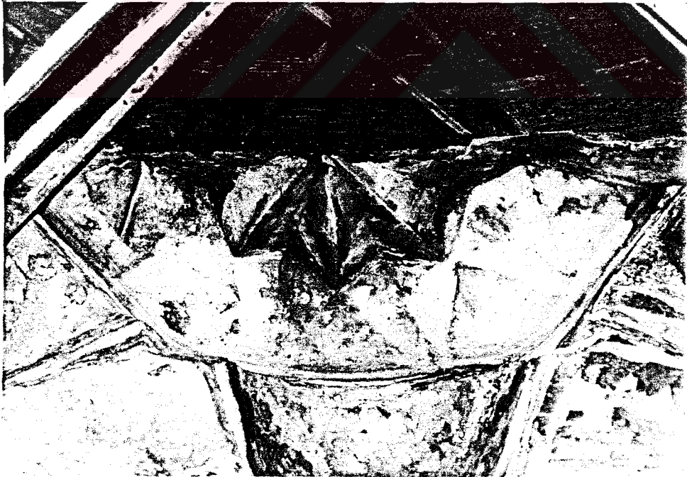
Resim 58. Tahtakale Hamamı-aynı hacimde mukarnaslı düz-bingin son dizisindeki biçimleniş
