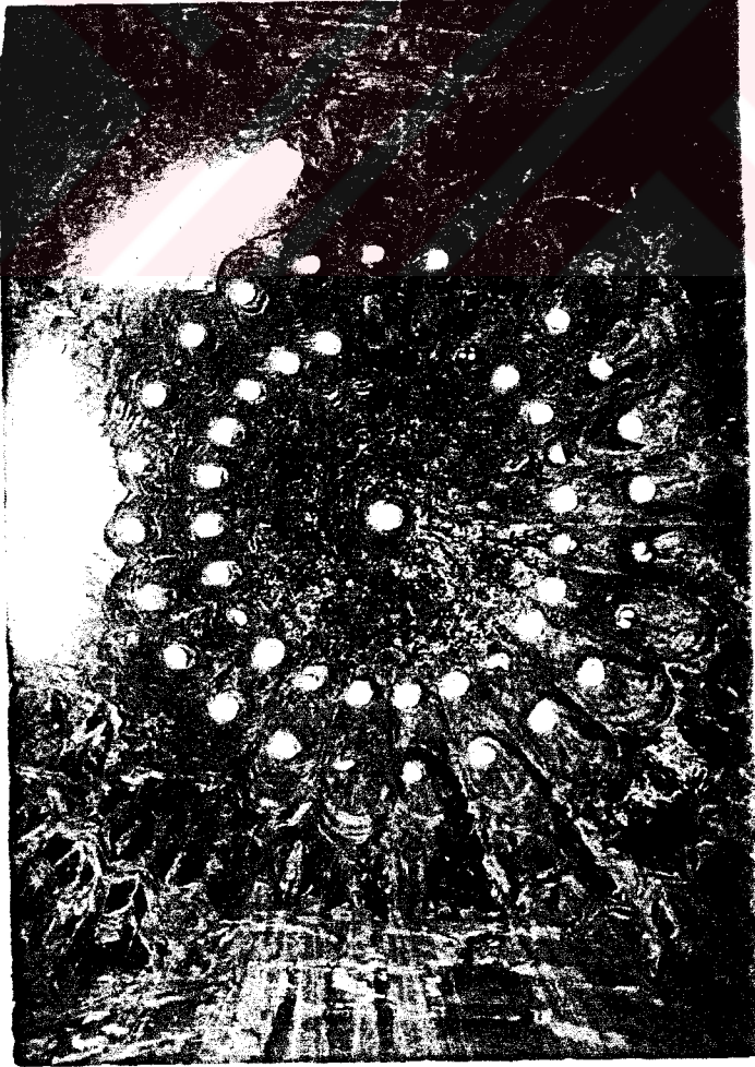
Resim 75. Beylerbeyi Hamamı-ıllıklık hacminin yivli kubbesi
