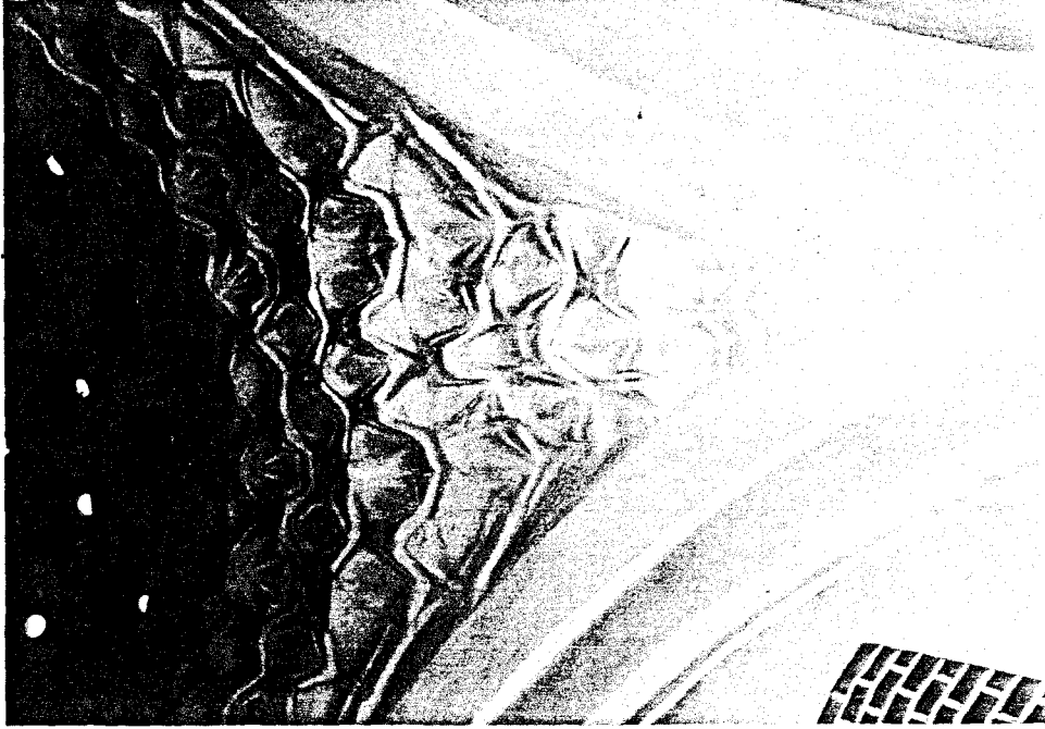
Resim 69. Tahtakale Hamamı-aynı hacimde mukarnaslı bileşik-bingin alttan görünüşü
