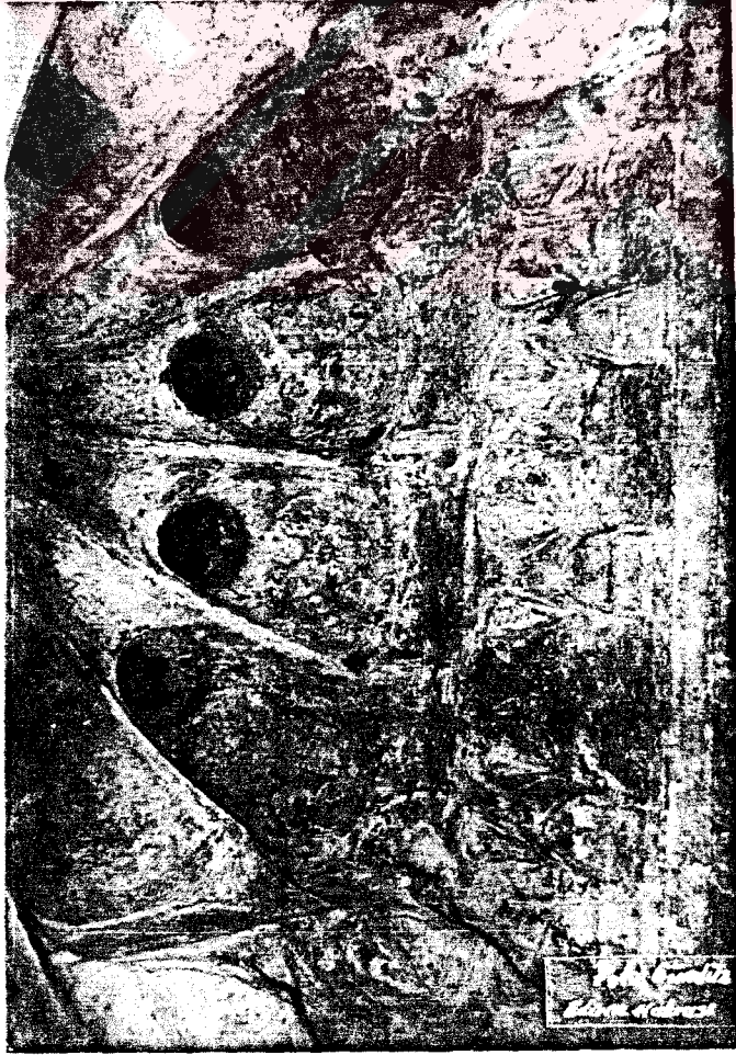
Resim 107. Saray Hamamı-kadınlar bölümü, sıcaklık eyvanının mukarnaslı geçiş bölgesi üzerinde yivli yarım kubbesi
