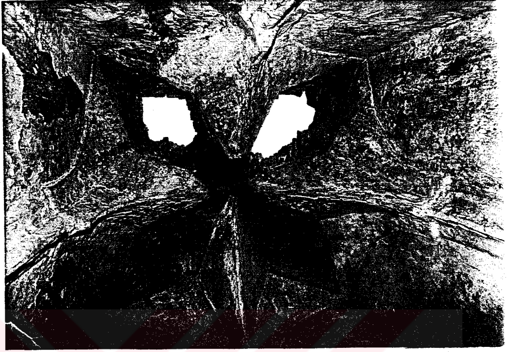
Resim 132. Yeniçeri Hamamı sıcaklık yan halvetinin çift cidarlı tonoz örtüsü
