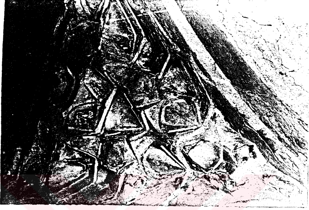
Resim 64. Topkapı Hamamı- mukarnaslı düz-binginin alttan görünüşü
