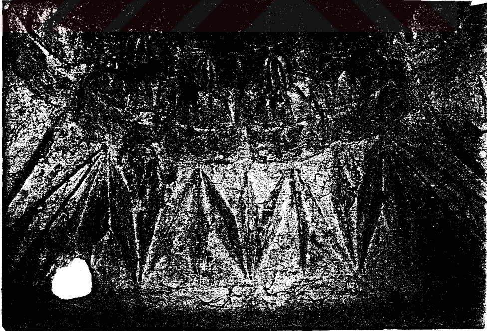
Resim 100. Yeniçeri Hamamı-aynı hacimde geçiş bölgesi (üçgen prizma kuşak üzerinde mukarnaslı geçiş bölgesi)
