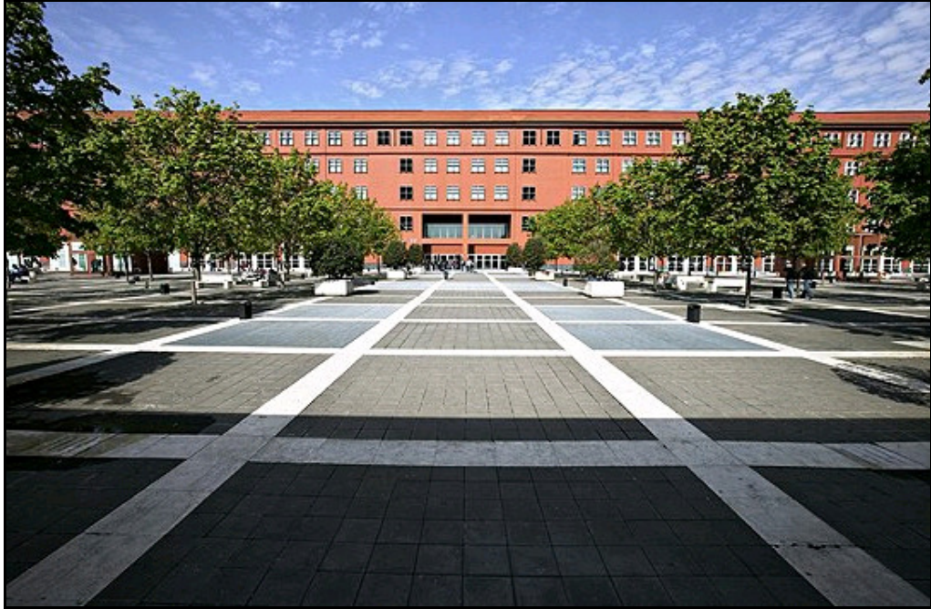
Şekil 3.19: Üniversite Binasının Cepheden Görünümü (Url, 7)
