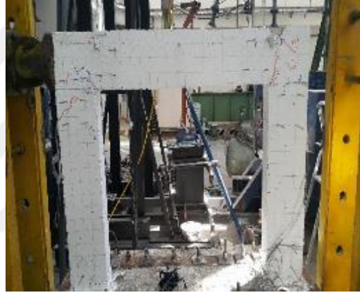
Şekil 4.56 : Numune 3 ileri hasar doğu cephesi
