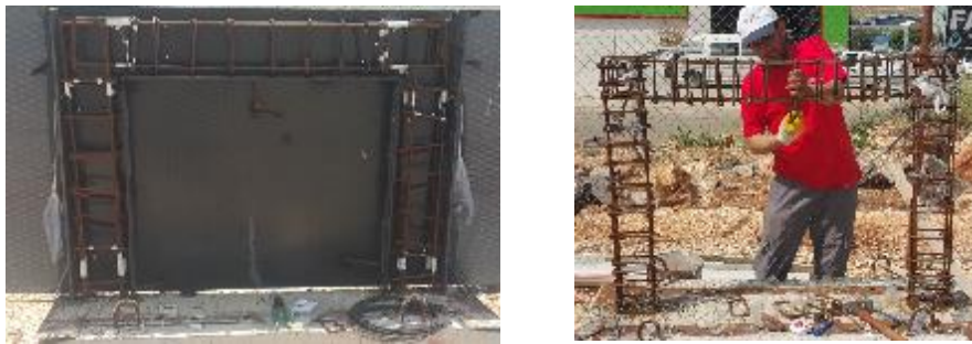
Şekil 2.2 : Çerçevelerin imalat aşamaları
