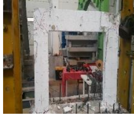
Şekil 4.73 : Numune 4 ileri hasar batı cephesi
