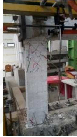
Şekil 4.38 : Numune 2 ileri hasar batı cephesi kuzey kolon temel birleşim bölgesi kabuk beton ezilmesi, donatı burkulması
