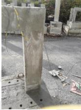
Şekil 2.22 : TRM öncesi yüzey ıslatıldı ve ilk kat harç öncesi ince bir şerbet tabakası (0.5 mm) serildi.
