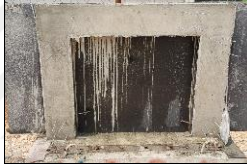
Şekil 2.5 : Çerçeve numunelere beton dökülmesi
