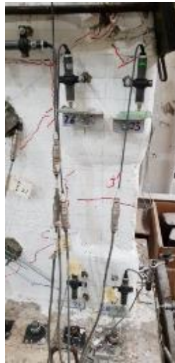
Şekil 4.131 : Numune 7 ileri hasar doğu cephesi, kiriş-kolon birleşim bölgesinde beton çekirdek ezildi.
