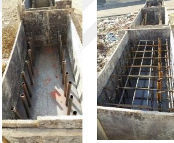
Şekil 2.1 : Temel içinde ankraj bırakılması ve nervürlü donatıların yerleştirilmesi
