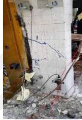
Şekil 4.175 : +28.50 mm itme çevrimi doğu cephesi
