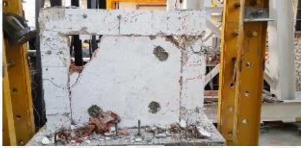
Şekil 4.151 : Numune 8 ileri hasar doğu cephesi
