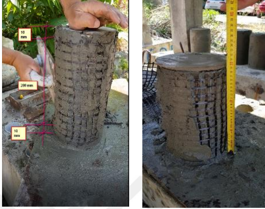
Şekil 2.34 : TRM sargı tabakası yerleşimi
