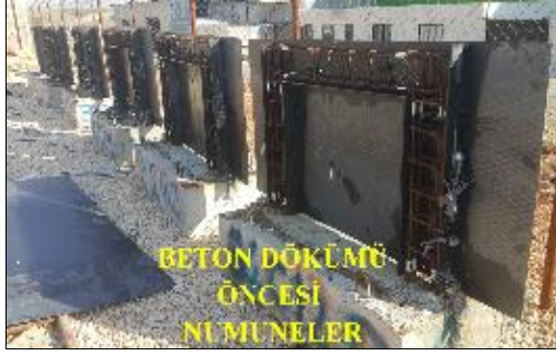
Şekil 2.4 : Çerçeve numunelerinin beton öncesi kalıbın kapatılması
