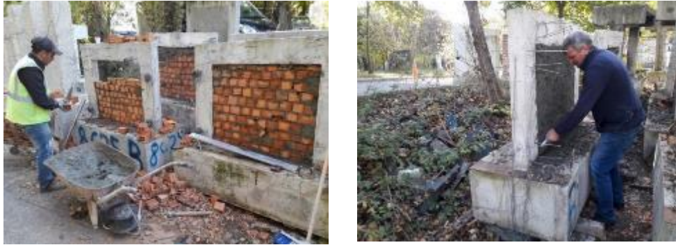
Şekil 2.20 : Her yüzeyde 7.5mm kalınlık oluşturacak şekilde tek kat sıva yapılması.
