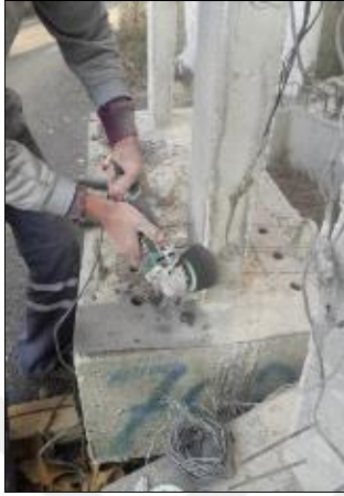
Şekil 2.21 : Kiriş ve kolon kritik uç bölgelerinin TRM öncesi köşelerinin 10 mm yuvarlatılması ve pah yapımı
