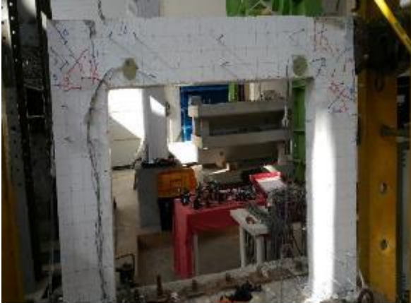
Şekil 4.55 : Numune 3 ileri hasar batı cephesi
