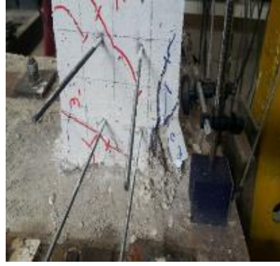
Şekil 4.36 : Güney kolonu alt temel bölgesi ileri hasarı, donatıda burkulma
