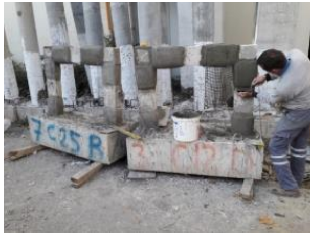
Şekil 2.25 : Çerçevelerde kiriş ve kolon kritik uç bölgelerinin TRM ile sargı yapılması
