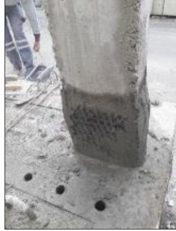
Şekil 2.23 : İlk kat TRM, Şekil 2.24 : Toplam 3kat kolon kritik uç bölgesinde TRM sarıldı. Her kat 200 mm boyunda sarılması. arasına 5 mm harç kondu.
