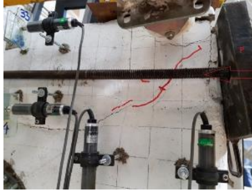
Şekil 4.128 : -4.48 mm çekme çevrimi, doğu cephesi duvarın köşe birleşiminden çerçevede meydana getirdiği kesme e' çatlağı w=0.5 mm, P=111.66 kN yatay yük altında.
