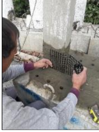
Şekil 2.23 : İlk kat TRM, Şekil 2.24 : Toplam 3kat kolon kritik uç bölgesinde TRM sarıldı. Her kat 200 mm boyunda sarılması. arasına 5 mm harç kondu.
