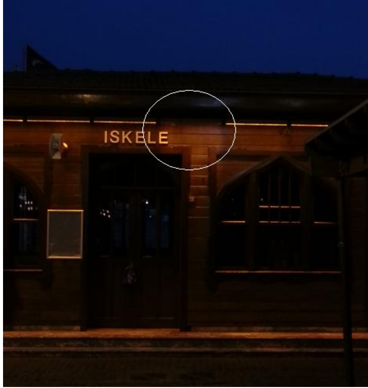
řekil 4.21 : Armat rlerin yanlıř y nlendirilmesi durumu (Fotoğraf: B. Aliřan, 2013).
