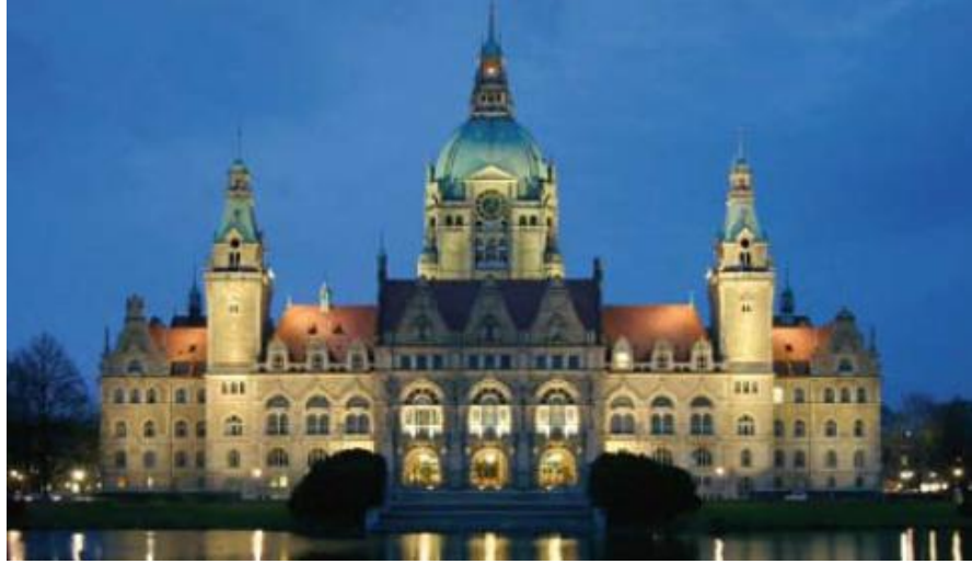
Şekil 2.1 : Örnek dış cephe aydınlatma uygulaması [11].
