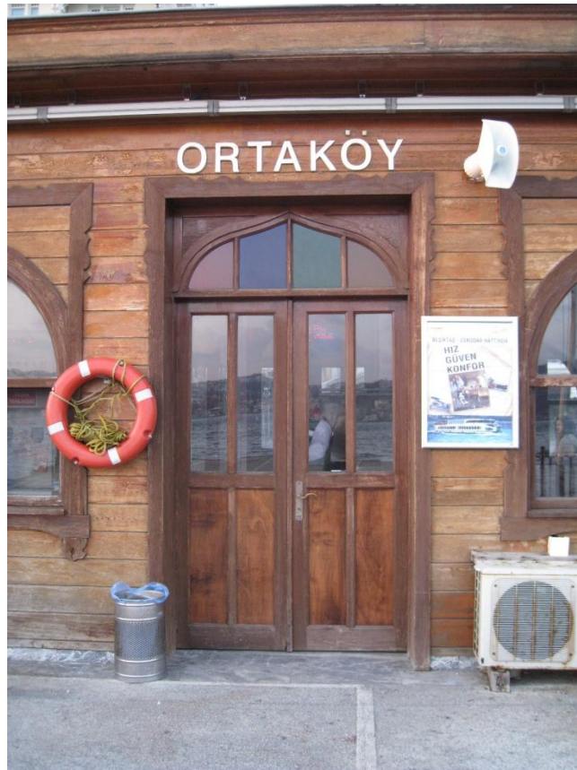
Şekil 4.18 : Cephe rengine uygun olmayan armatür kullanımı-2 (Fotoğraf: B. Alişan, 2013).
