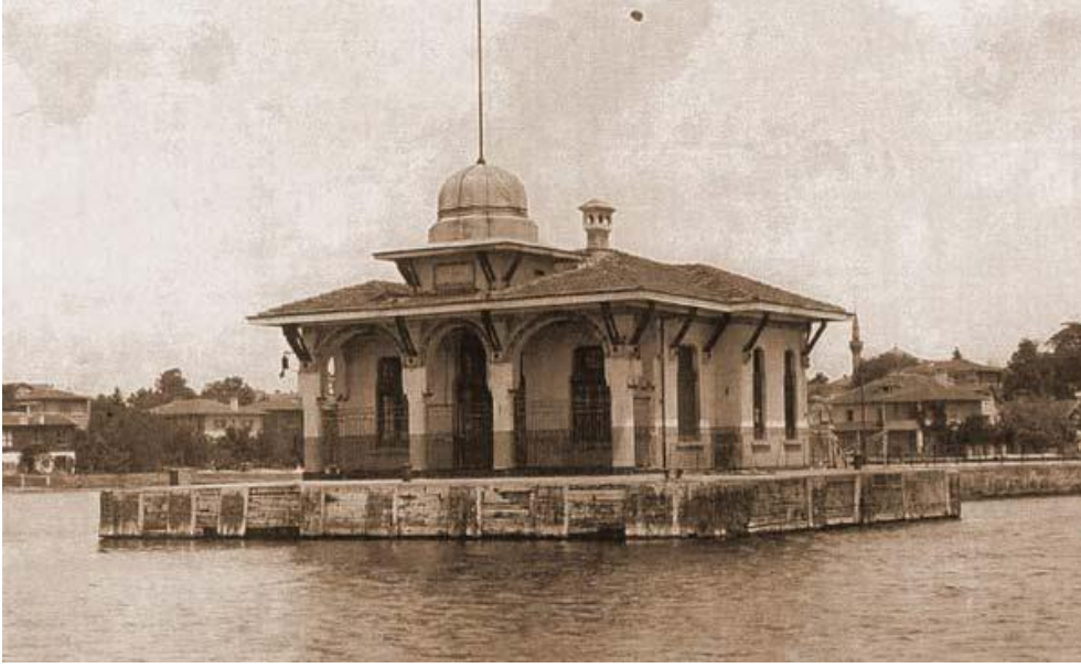
Şekil 3.1 : Bostancı vapur iskelesine ait eski bir görüntü [73].
