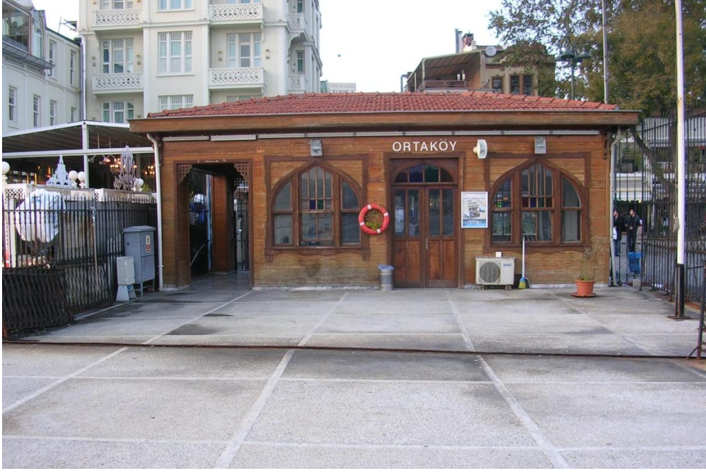
Şekil 4.5 : Ortaköy iskelesi kuzey cephesi görüntüsü (Fotoğraf: B. Alişan, 2013).
