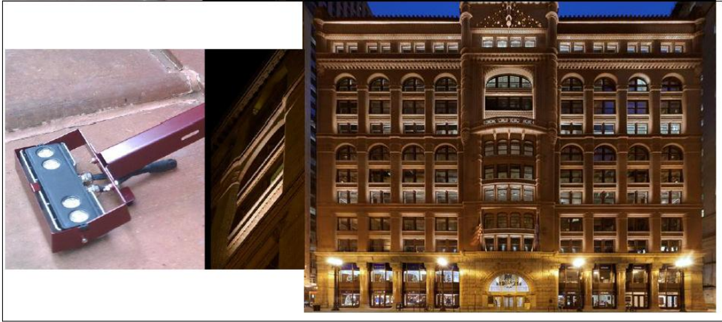
Şekil 2.33 : Chicago finans merkezi binası aydınlatması [60].
