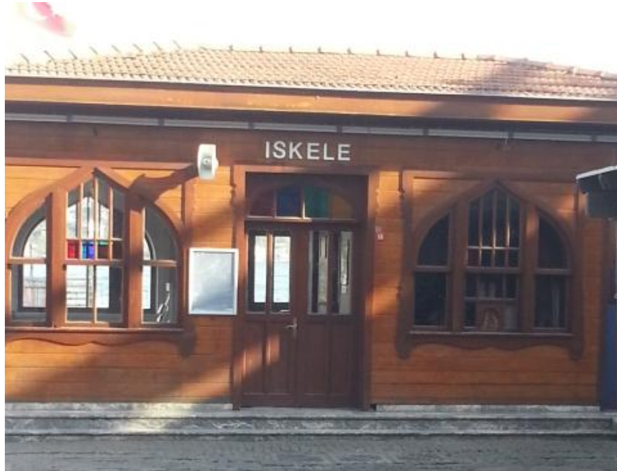
Şekil 4.4 : Ortaköy iskelesinin güney cephesi görüntüsü (Fotoğraf: B. Alişan, 2013).
