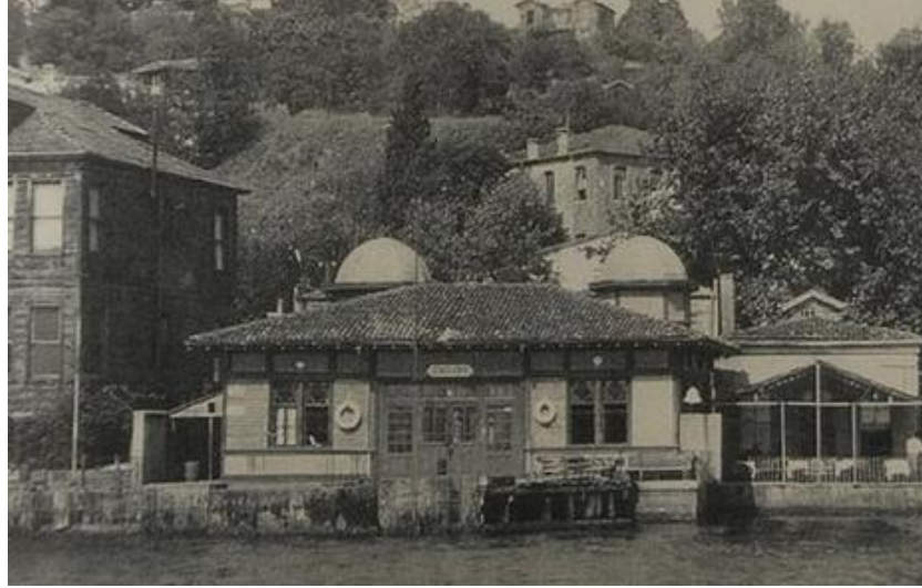
Şekil 3.54 : Çengelköy iskelesi eski görünümü [80].
