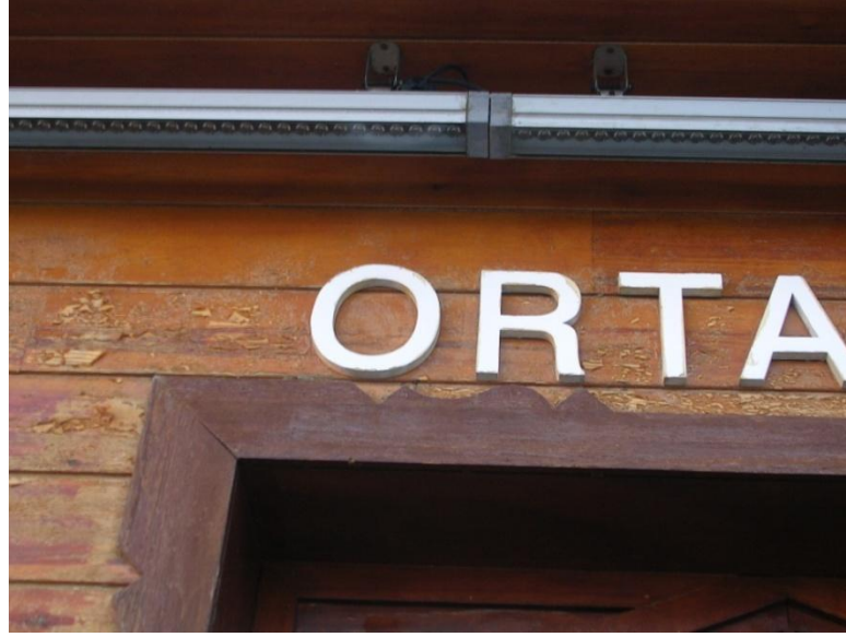
Şekil 4.22 : LED’li armatür kullanımı (Fotoğraf: B. Alişan, 2013).
