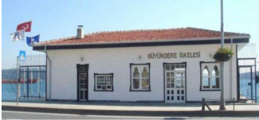
Şekil 3.34 : Yeni Büyükdere iskelesi [73].
