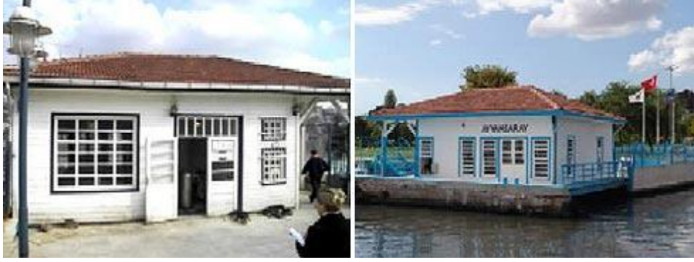
Şekil 3.31 : Restorasyon öncesi ve sonrası Ayvansaray iskelesi [73].
