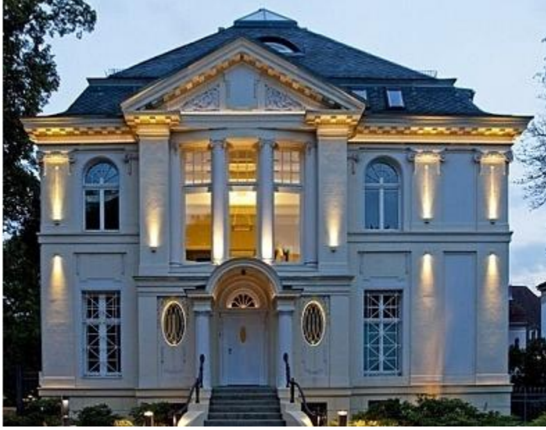
Şekil 2.29 : Duvar armatürleri ile tarihi bina aydınlatması [58].
