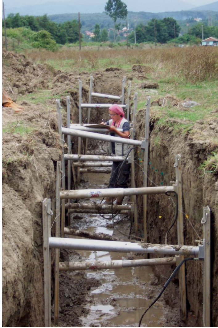
Şekil 5.40 : Hendek duvarlarının sabit kalmasını sağlamak amacıyla kullanılan hidrolik payandaların hendek içerisinde görünümü.
