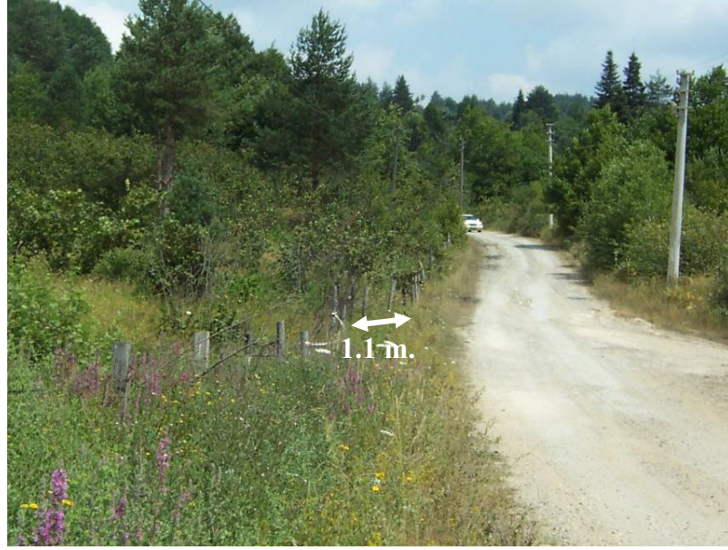
Şekil 5.51 : 1999 İzmit depreminde asphalt yolda ve bahçe çitinde meydana gelen sağ yanal yer değiştirme (fotoğrafın bakış yönü KKD'yadır).
