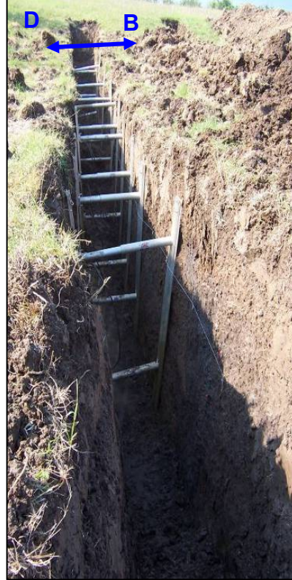
Şekil 5.5 : Acısu lokasyonunda hidrolik payanda desteği ile çalışılan hendeğin genel görünümü (fotoğrafın bakışı güneyedir).
