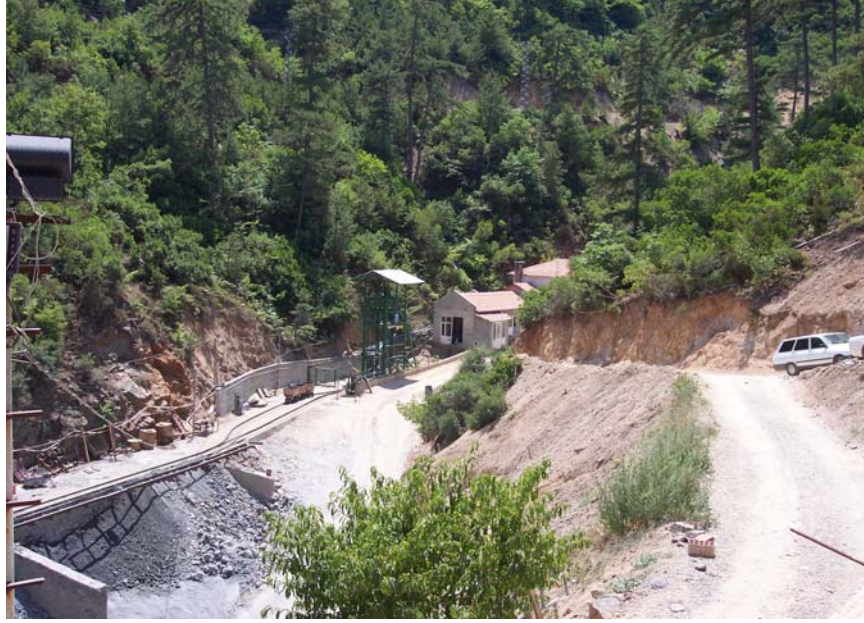
Şekil 4.11: Arapuçandere kuyu galeri girişı ve depolama alanı
