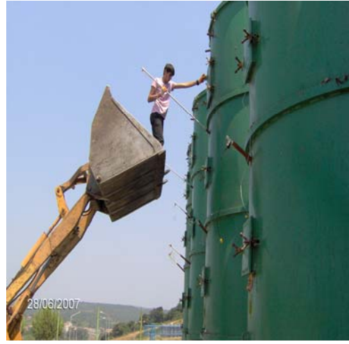
Şekil 4.9: Sıcaklık Problarının Yerleştirilmesi
