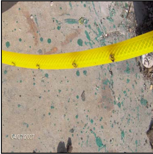
Şekil 4.4: Sızma Suyu Geri Devir Hattı
