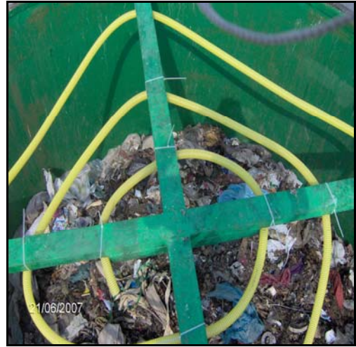
Şekil 4.5: Sızıntı Suyu Geri Devir Hattının Yerleşimi
