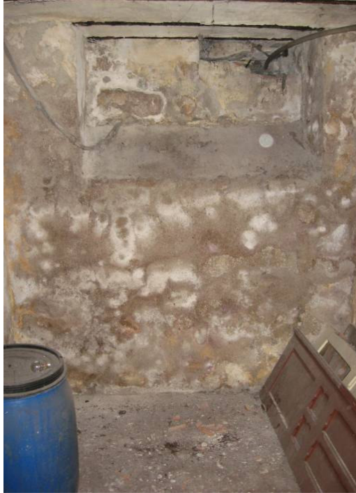
Şekil D.11: B.03 mekânında kapatılmış kuranglez(Kurt,2008).
