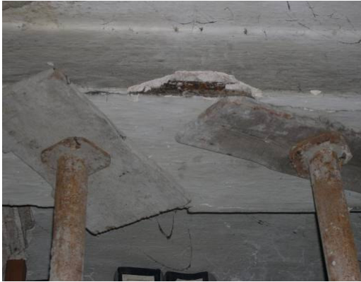
Şekil D.104: 3.07 mekânı giriş görünüşü. (Kurt,2008)
