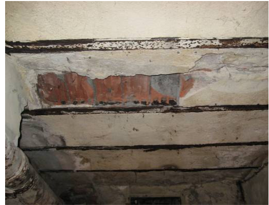
Şekil D.113: Bodrum kat volta döşeme (Kurt,2008).
