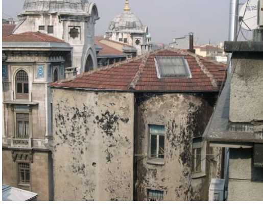
Şekil D.120: Arka cepheden çatı görünüşü (Kurt,2008).
