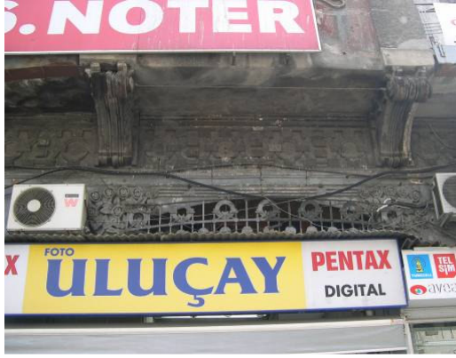
Şekil D.90: Tepe penceresi ve ahşap konsollar(Kurt,2008).
