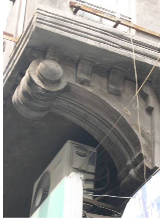
Şekil D.78: Ahşap konsol(Kurt,2008).
