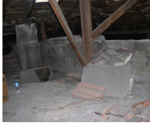
Şekil D.121: Çatı arasında devam eden duvar (Kurt,2008).
