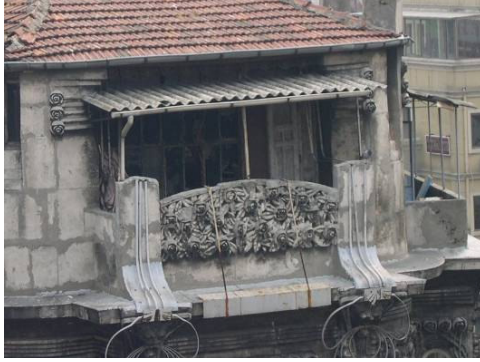
Şekil D.98: Büyük Postane Meydanı cephesi – 4.04.03 görünüşü (Kurt,2008).
