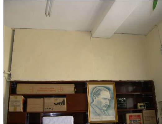
Şekil D.109: 2.05 mekânı-kiriş görünüşü (Kurt,2008).
