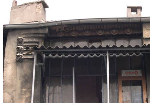
Şekil D.87: Çatı altı ahşap bezemeler(Kurt,2008).
