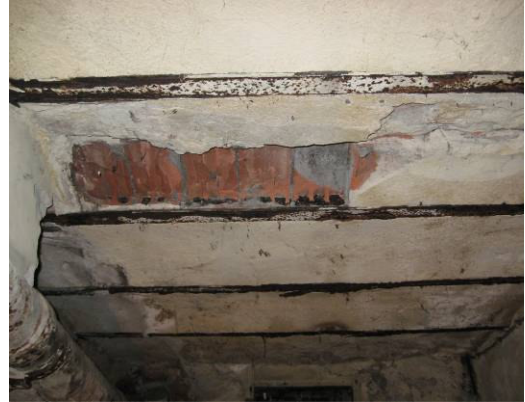
Şekil D.8: B.02 mekânında volta döşeme(Kurt,2008).
