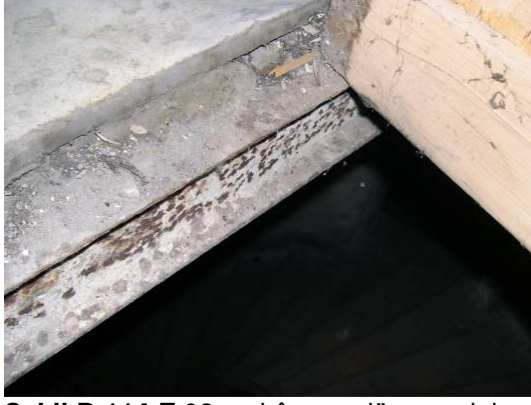
Şekil D.114: Z.02 mekânının döşemesini taşıyan putrel (Kurt,2008).
