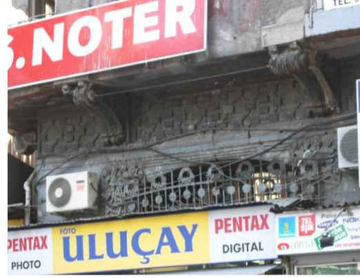
Şekil D.91: Tepe penceresi ve ahşap konsollar(Kurt,2008).
