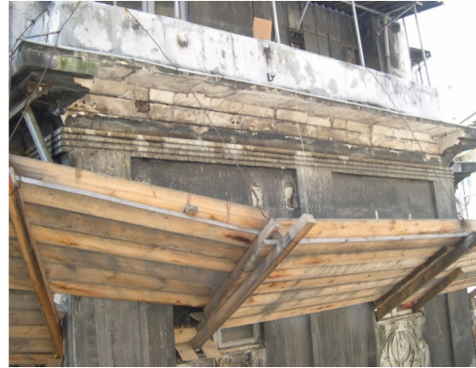
Şekil D.101: Muhzırbaşı Sokak cephesi- Kopan korniş (Kurt,2008).
