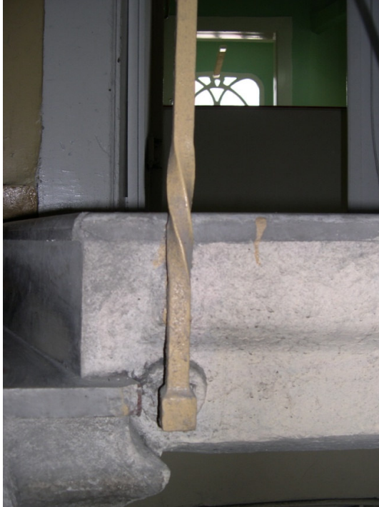
Şekil D.118: Yeni mermer kaplama (Kurt,2008).
