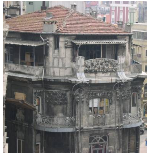
Şekil D.119: Büyük Postane Meydanı yönünden çatı görünüşü (Kurt,2008).
