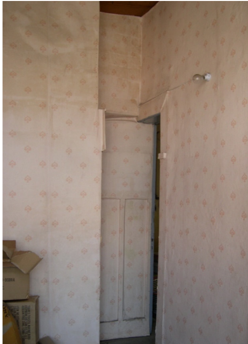
Şekil D.148: Bölücü olarak kullanılan K.04 kanatları (Kurt,2008).
