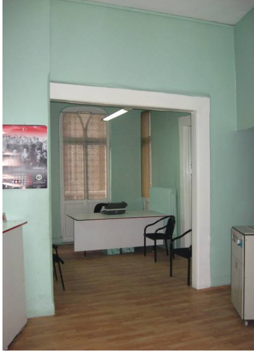
Şekil D.23: 1.01-1.07 mekânları arasındaki duvar(Kurt,2008).
