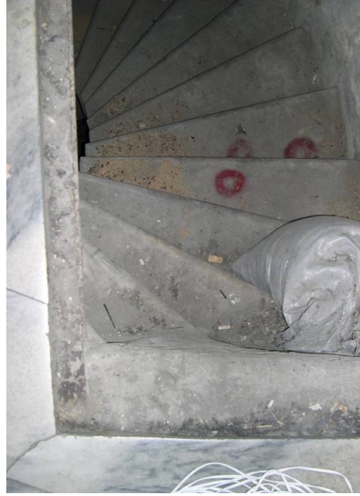
Şekil D.2: Z.02 mekânından bodrum kata inen merdiven (Kurt,2008).
