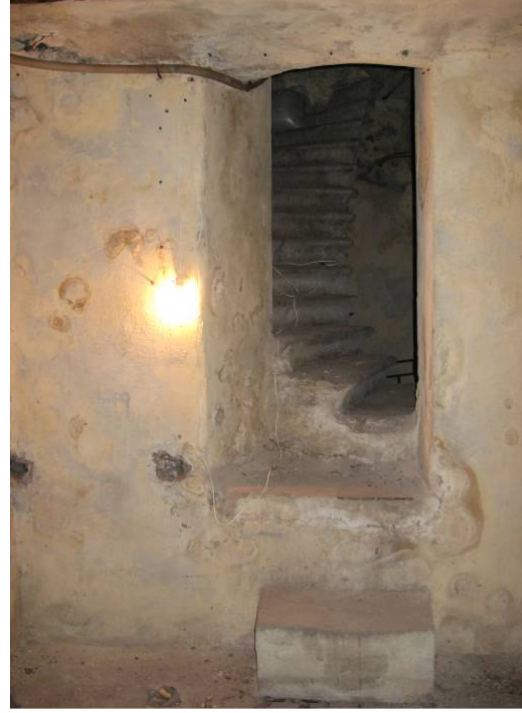
Şekil D.10: B.03 mekânının kapısı(Kurt,2008).
