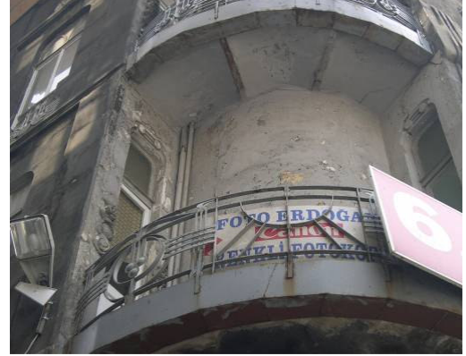
Şekil D.117: Balkonların altında bulunan volta döşeme putrelleri (Kurt,2008).
