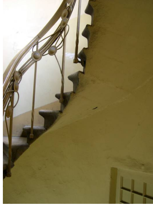
Şekil D.143: Merdiven- Arka görünüş (Kurt,2008).
