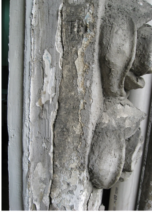
Şekil D.110: Taş kaplama kalınlığı (Kurt,2008).
