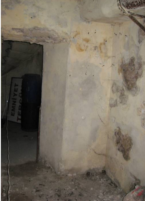
Şekil D.7: B.02 mekânında rutubet ve tuzlanma(Kurt,2008).
