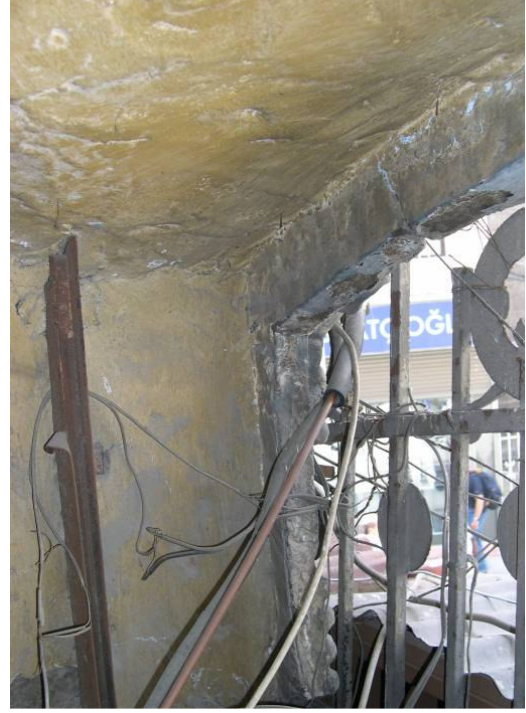
Şekil D.111: Taş kaplama kalınlığı, asma kat (Kurt,2008).
