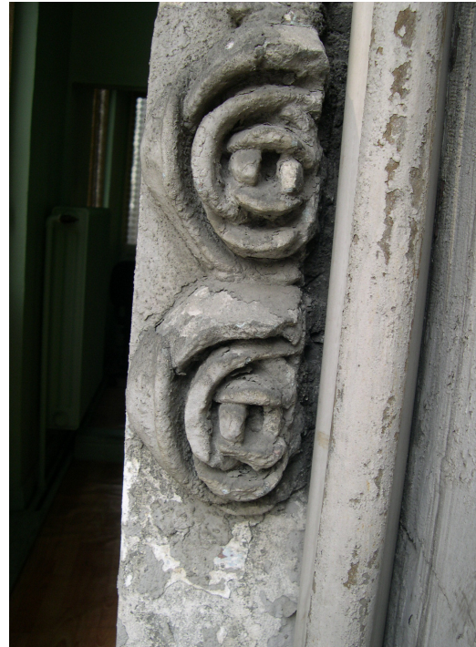
Şekil D.149: 1.05.02- Gül motiflerinde yüzey kaybı (Kurt,2008).
