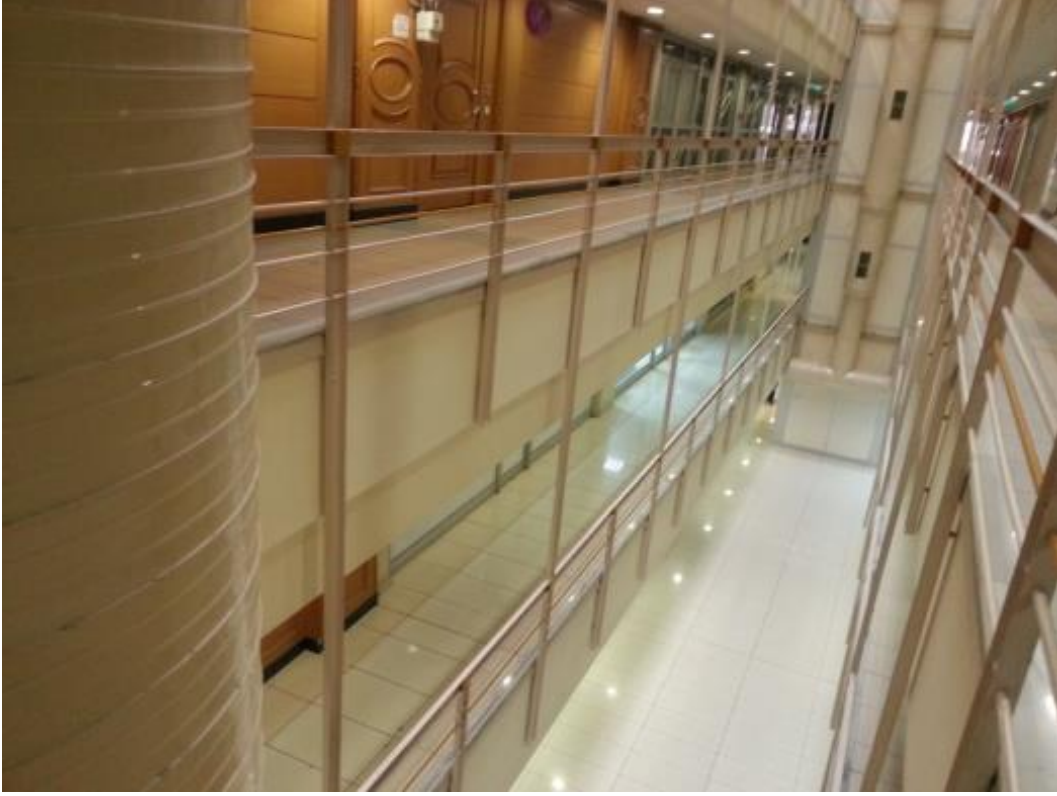
Şekil 4.12: Kuyumcukent'in Atölye Bölümünden Bir Görüntü
