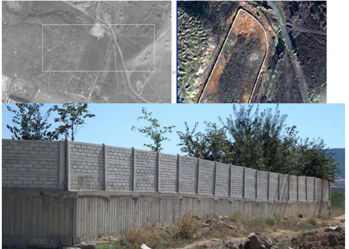
Şekil 5.8: Bahçe duvarı (Yanalak ve diğ., 2008).
