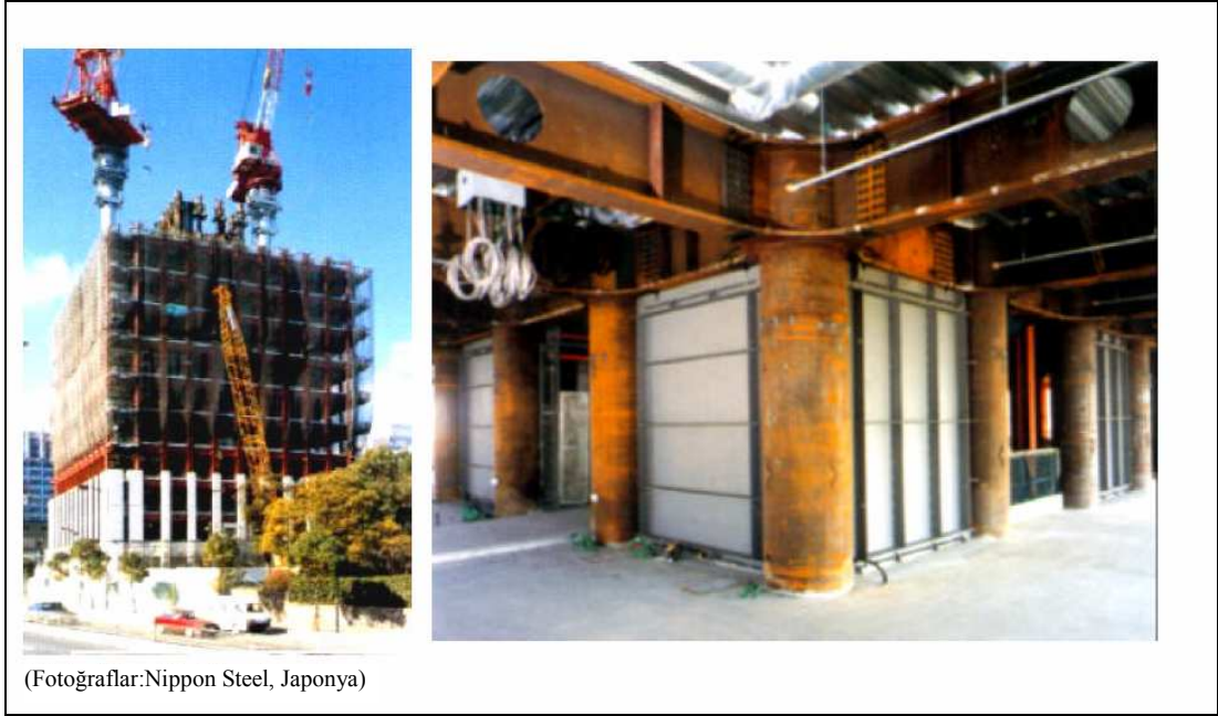
Şekil 4.17: Düşük Akma Noktalı (LYP) çelik plaka perde duvarlı binanın bir görünüşü ve duvarların yakın görünüşü. [20]
