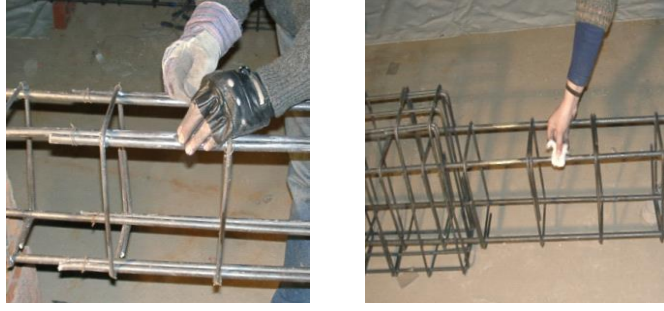
Şekil 3.8. Donatı Yüzeyinin Zımpara ve Aseton İle Temizlenmesi
