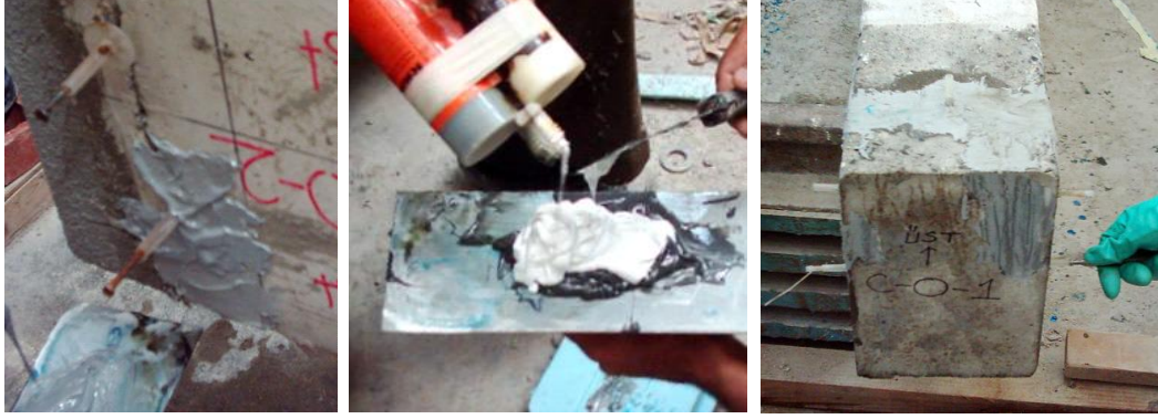
Şekil 3.14. Epoksi Enjeksiyonu Uygulaması
