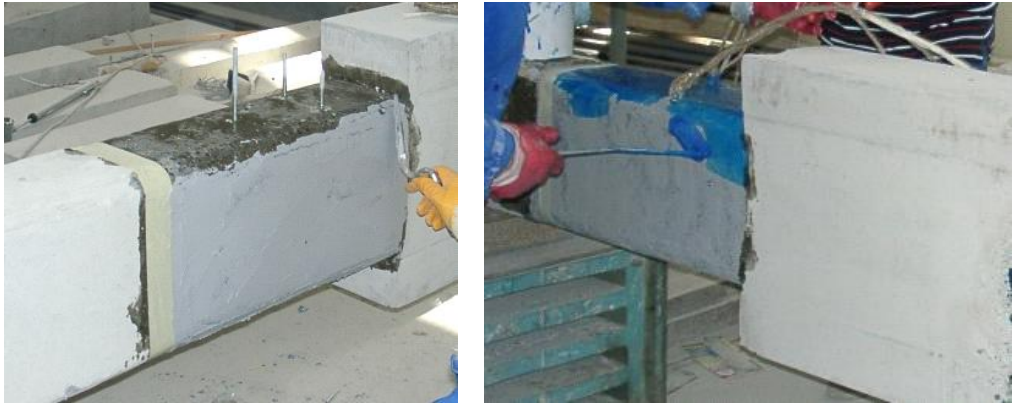
Şekil 3.17. Çift Bileşenli Epoksi Macun Karışım ve Yapıştırıcı Sürülmesi
