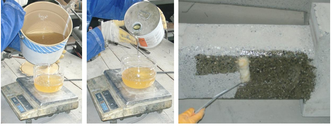
Şekil 3.16. Çift Bileşenli Epoksipolyamin Astar Karışımı Sürülmesi
