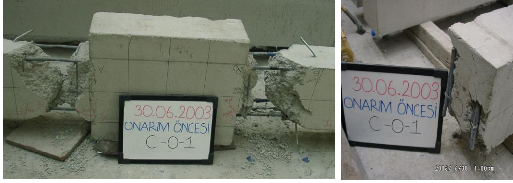
Şekil 3.12. C-O-1 Numunesinin Onarım Öncesi Durumu
