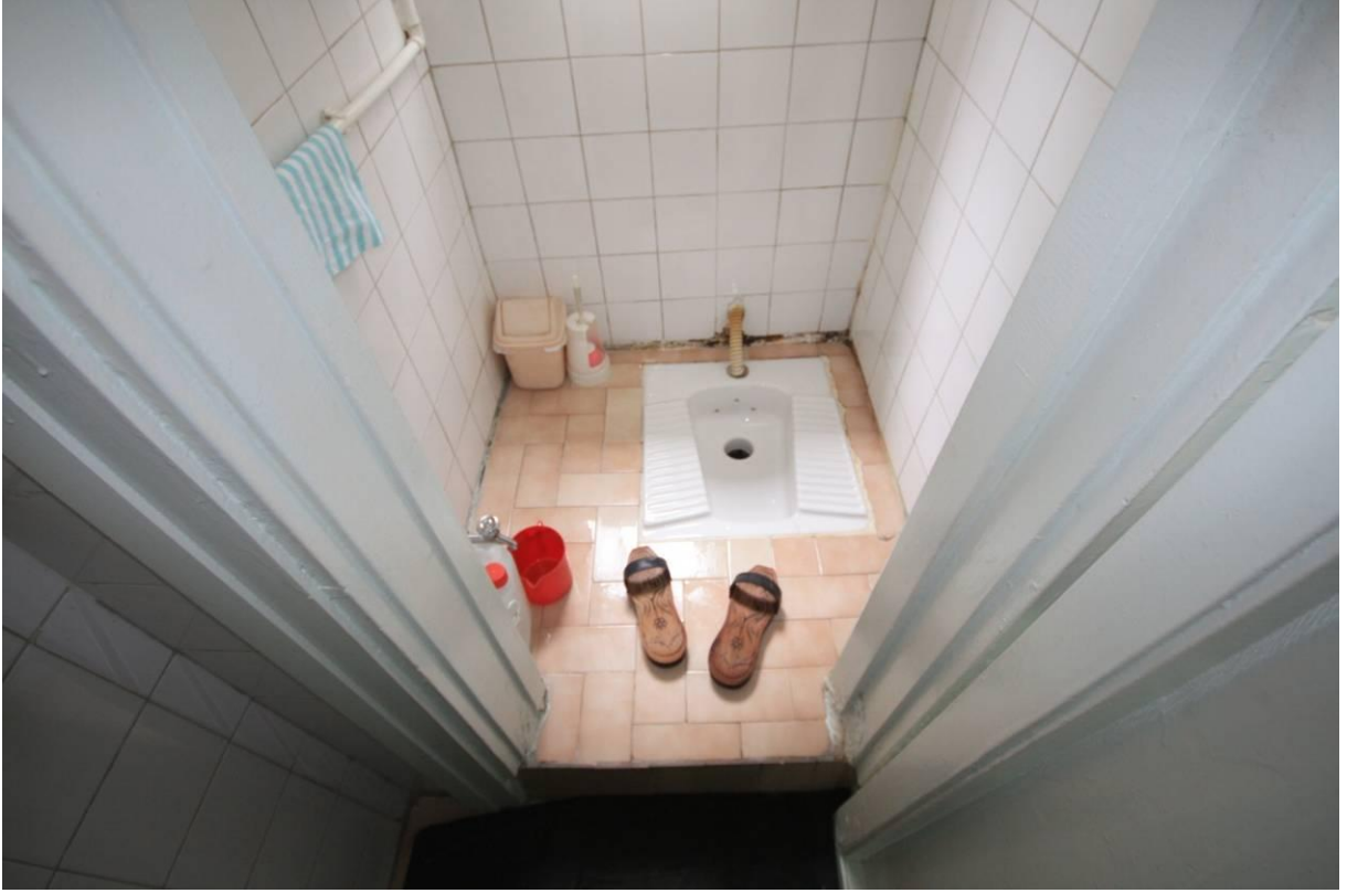
Şekil B.143: 1-04 mekânı döşemesi.
