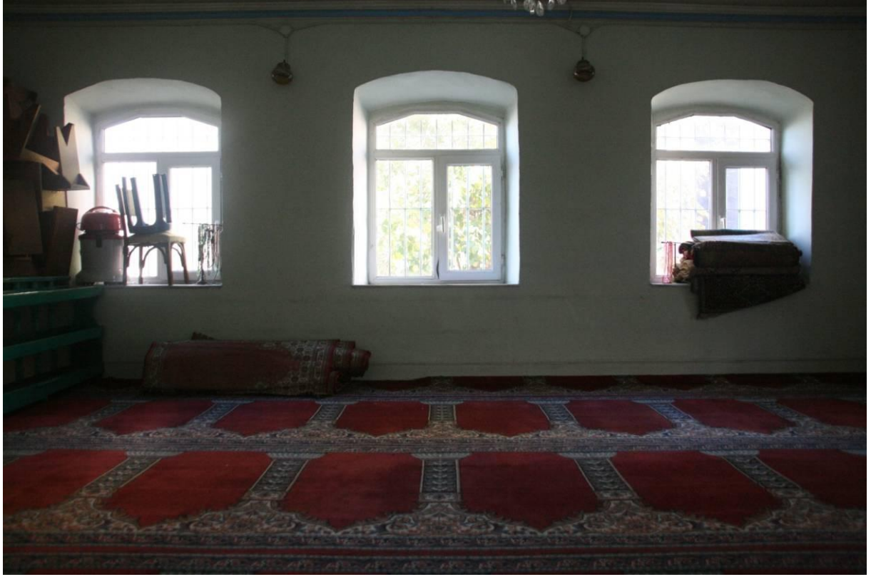
Şekil B.125: 1-01 mekânı kuzeybatı duvarı.
