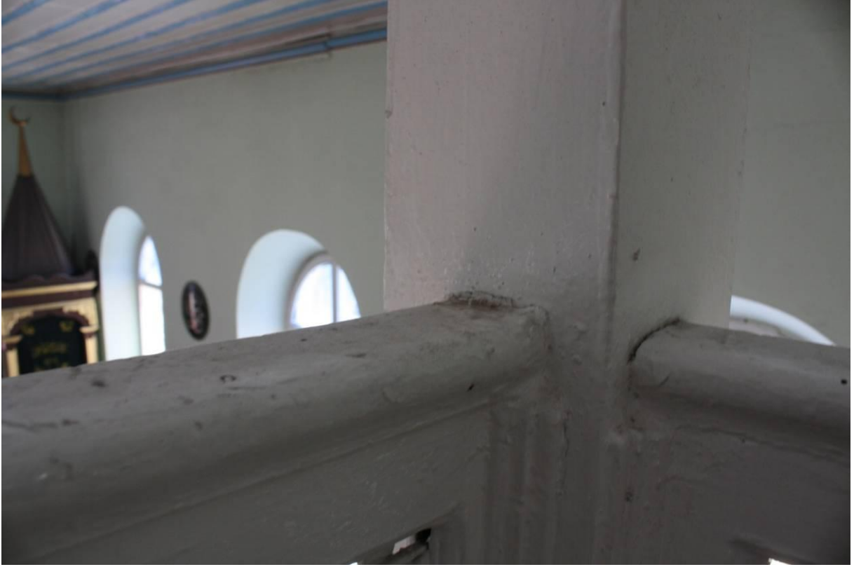
Şekil B.131: 1-01 mekânındaki ahşap direklerle ahşap kafeslerin birleşimi.
