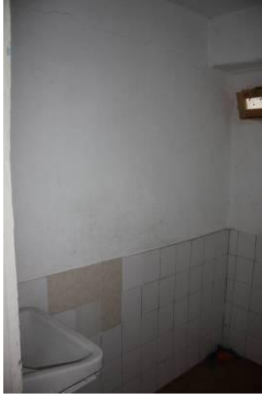
Şekil B.101: Z-09 mekânı doğu duvarı.
