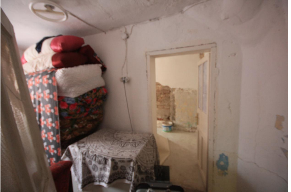
Şekil B.108: Z-10 mekânı doğu duvarı.
