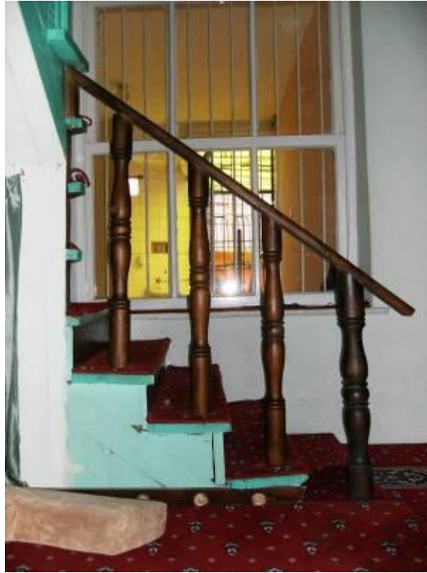
Şekil B.222: Cami merdiveni korkuluk görünüşü.
