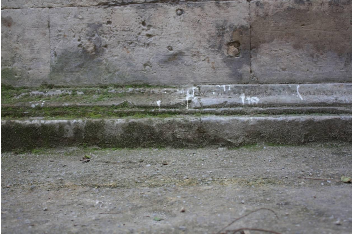
Şekil B.165: Caminin kuzeydoğu cephesinin zeminini sınırlayan taş profil.
