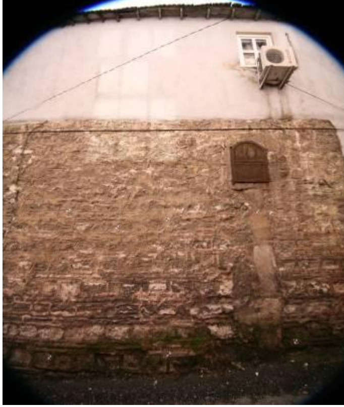
Şekil B.199:Konutun kuzey cephesi, parça 2/3.
