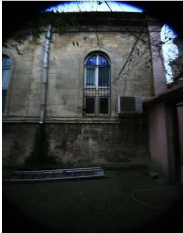
Şekil B.160: Caminin kuzeydoğu cephesi kuzey köşesi, parça 1/5.
