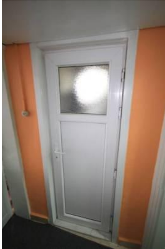
Şekil B.154: 1-08 mekânı güney duvarı.
