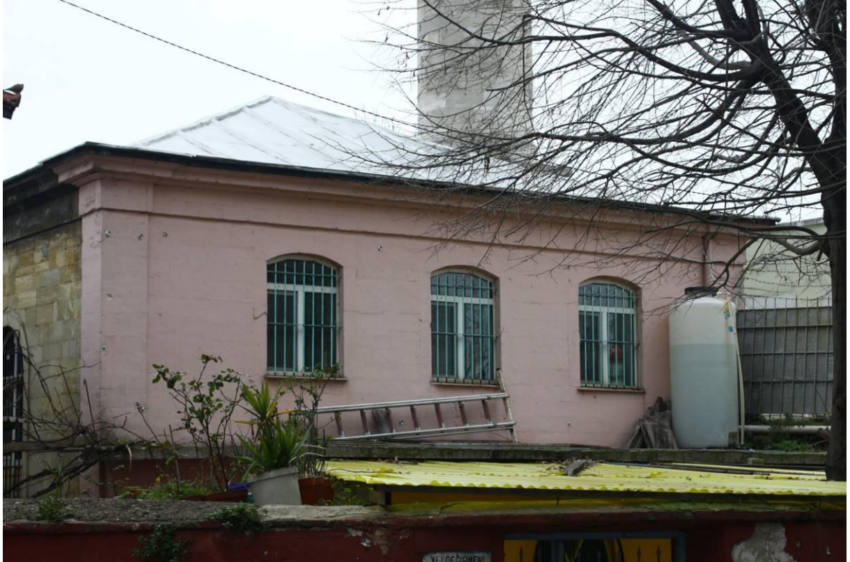
Şekil B.188: Caminin kuzeybatı cephesi.
