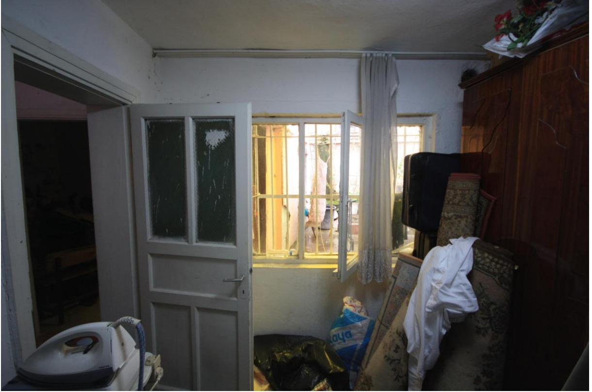
Şekil B.119: Z-12 mekânı güney duvarı.
