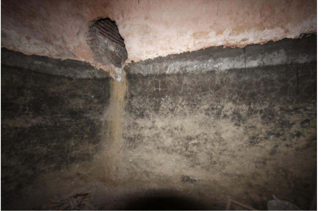
Şekil B.86: Z-06 mekânının kuzey duvarı.
