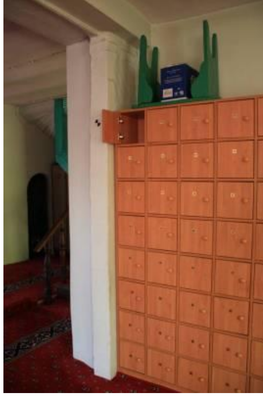
Şekil B.41: Z-01 mekânının güneydoğu duvarı.
