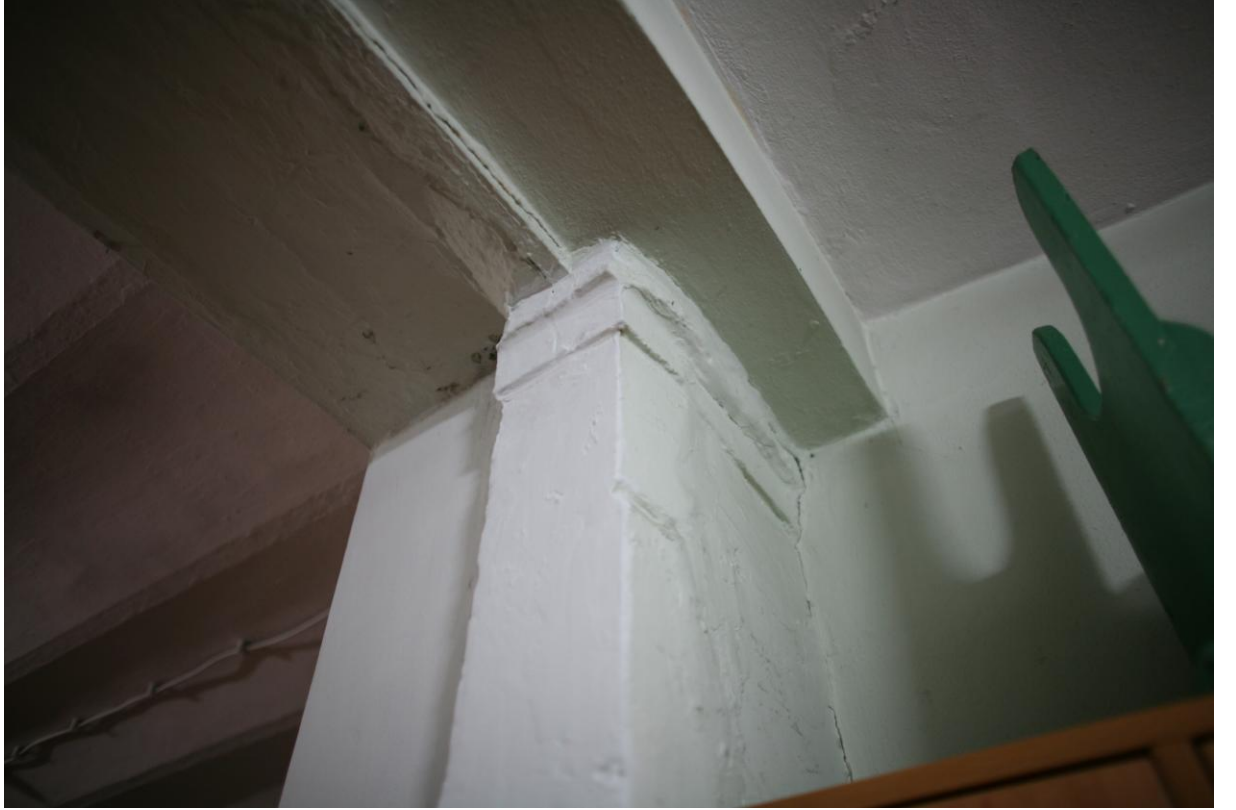
Şekil B.42: Z-01 mekânının güneydoğu duvarındaki taş profil.
