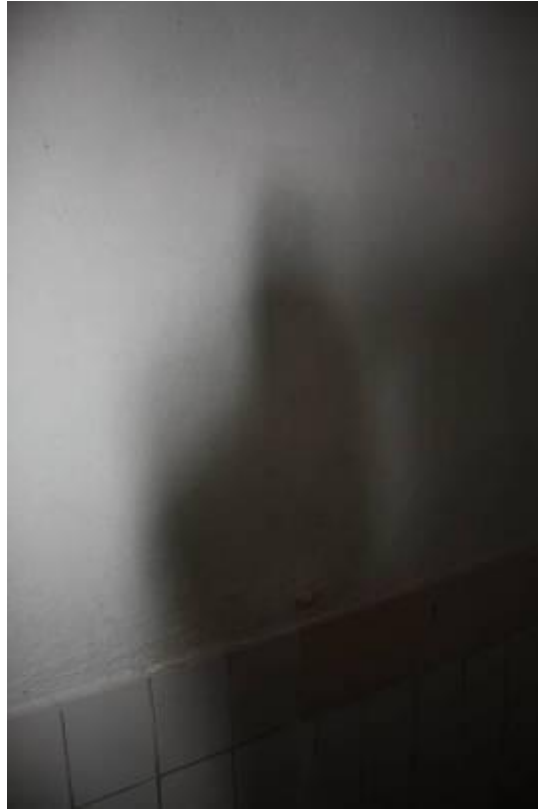
Şekil B.102: Z-09 mekânı batı duvarı.
