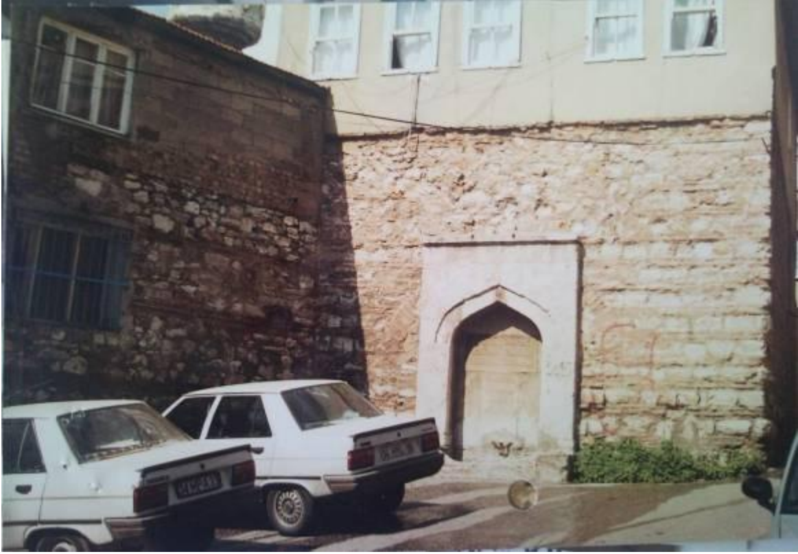
Şekil C.18: Konutun doğu cephesi, lojmanın kuzey cephesi (1994).
