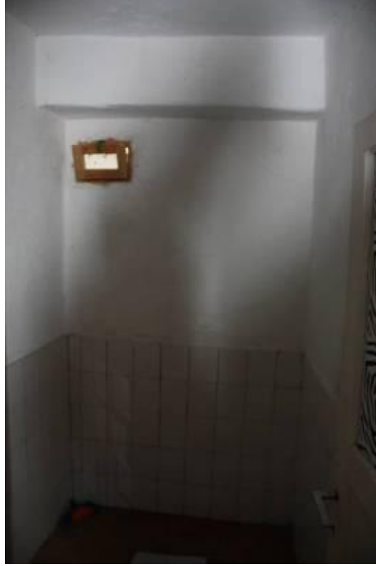
Şekil B.100: Z-09 mekânı güney duvarı.
