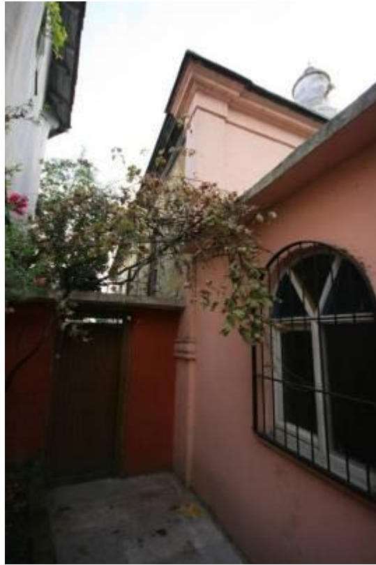
Şekil B.168: Caminin kuzeybatısına eklenmiş betonarme ekin kuzeydoğu cephesi.
