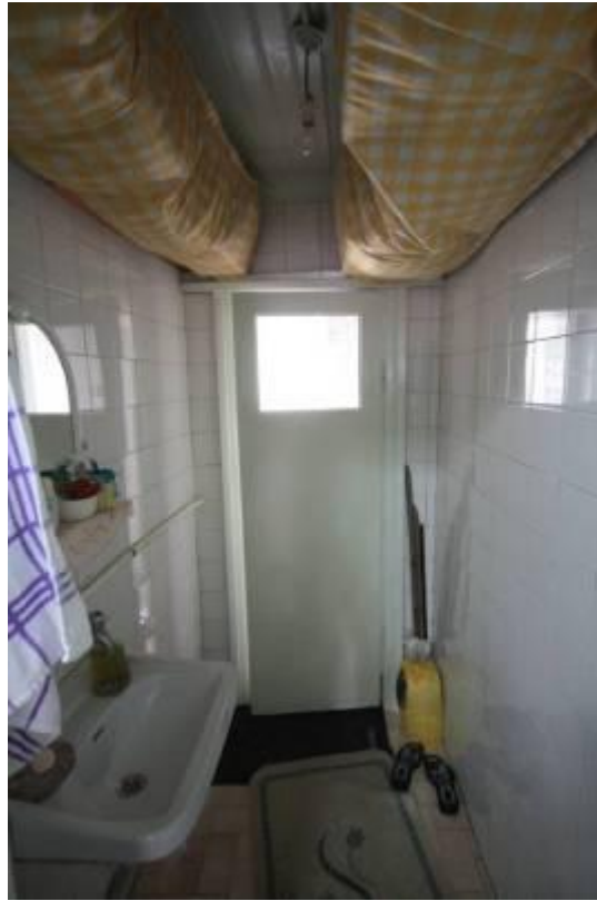
Şekil B.136: 1-03 mekânı batı duvarı.
