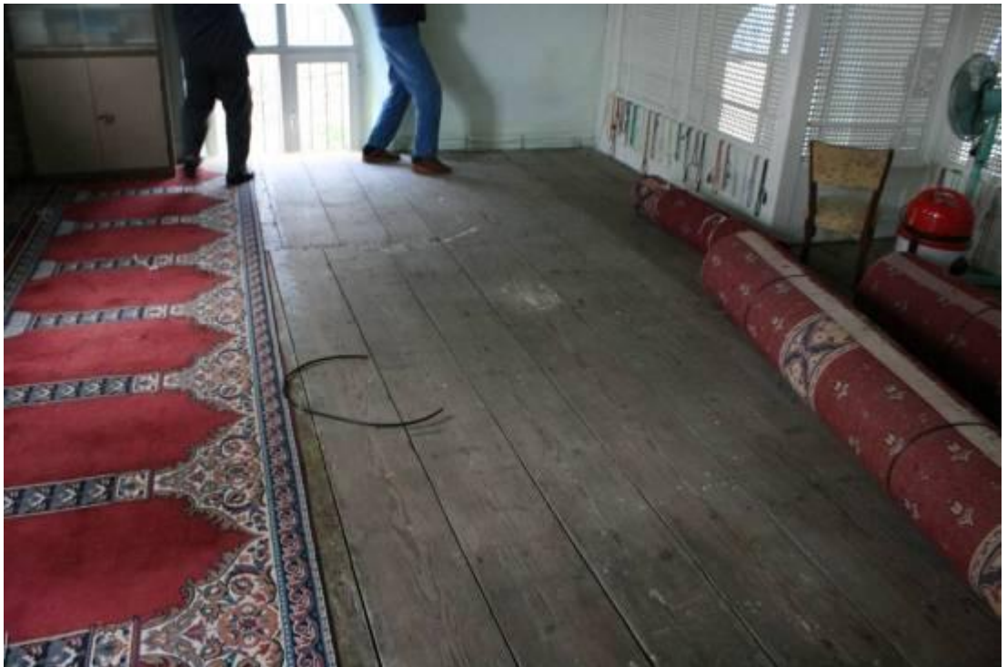
Şekil B.122: 1-01 mekânı döşemesi.
