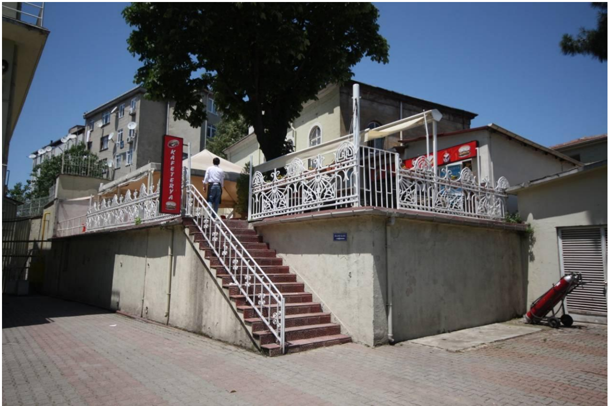
Şekil B.172: Caminin güneybatı cephesine bitişik inşa edilmiş betonarme müştemilat.
