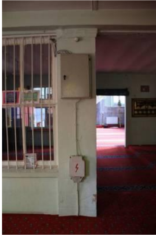
Şekil B.40: Z-01 mekânının güneydoğu duvarı.
