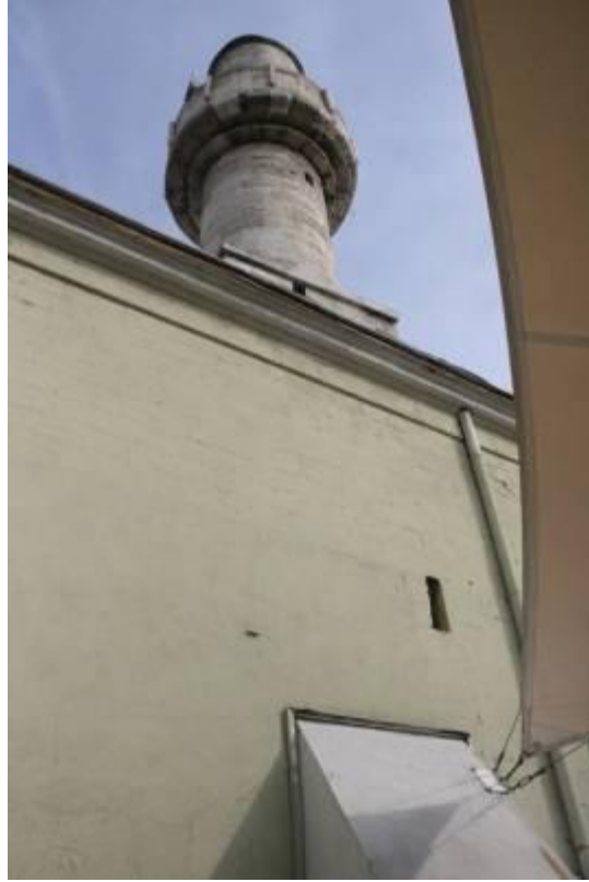
Şekil B.171: Caminin güneybatı cephesi.
