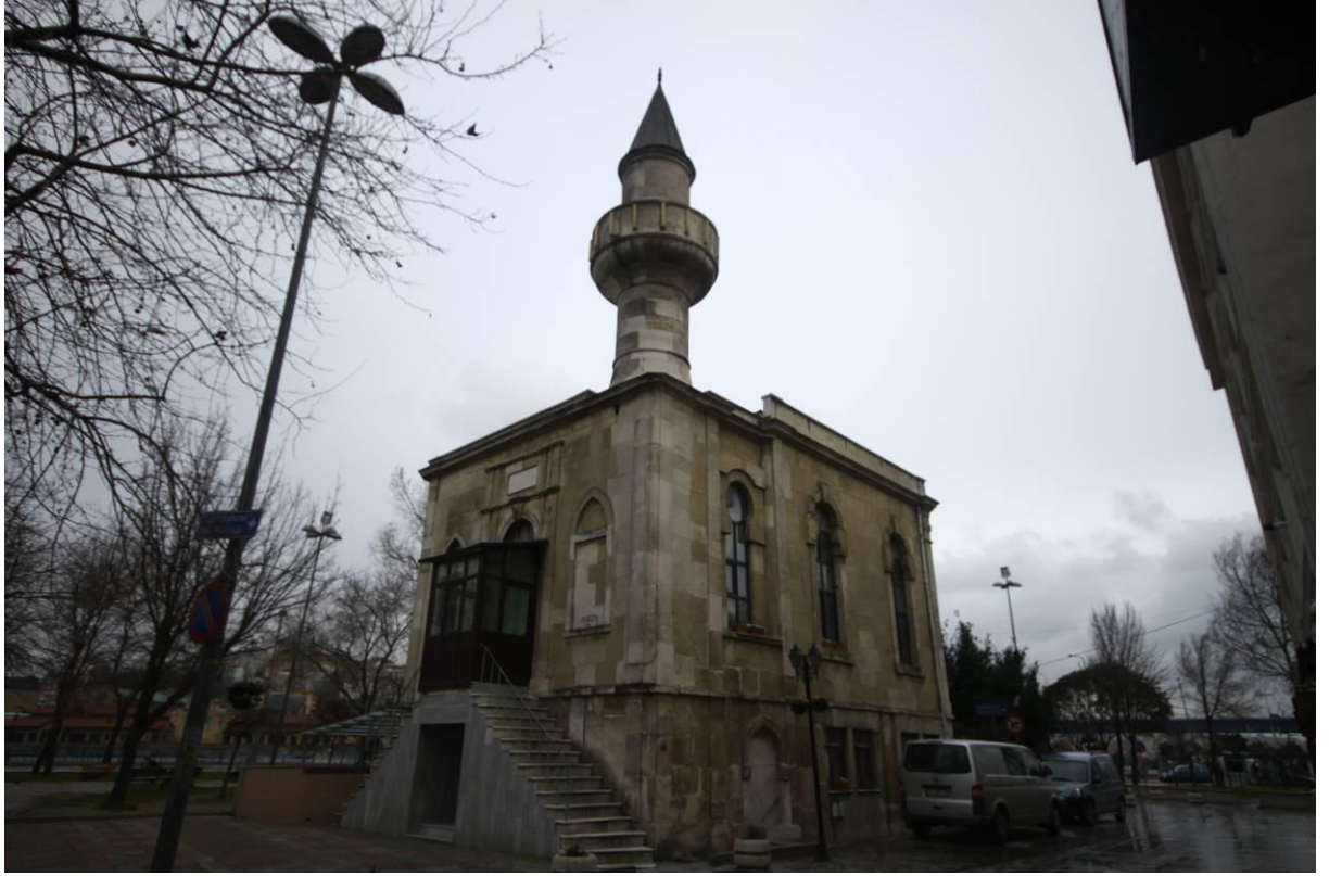
Şekil C.8: Büyük İskele Camii genel görünüş.
