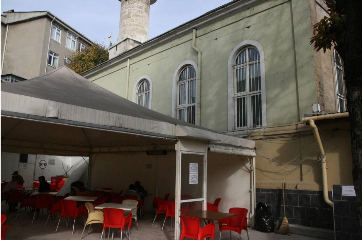
Şekil B.175: Caminin güneybatı cephesi.
