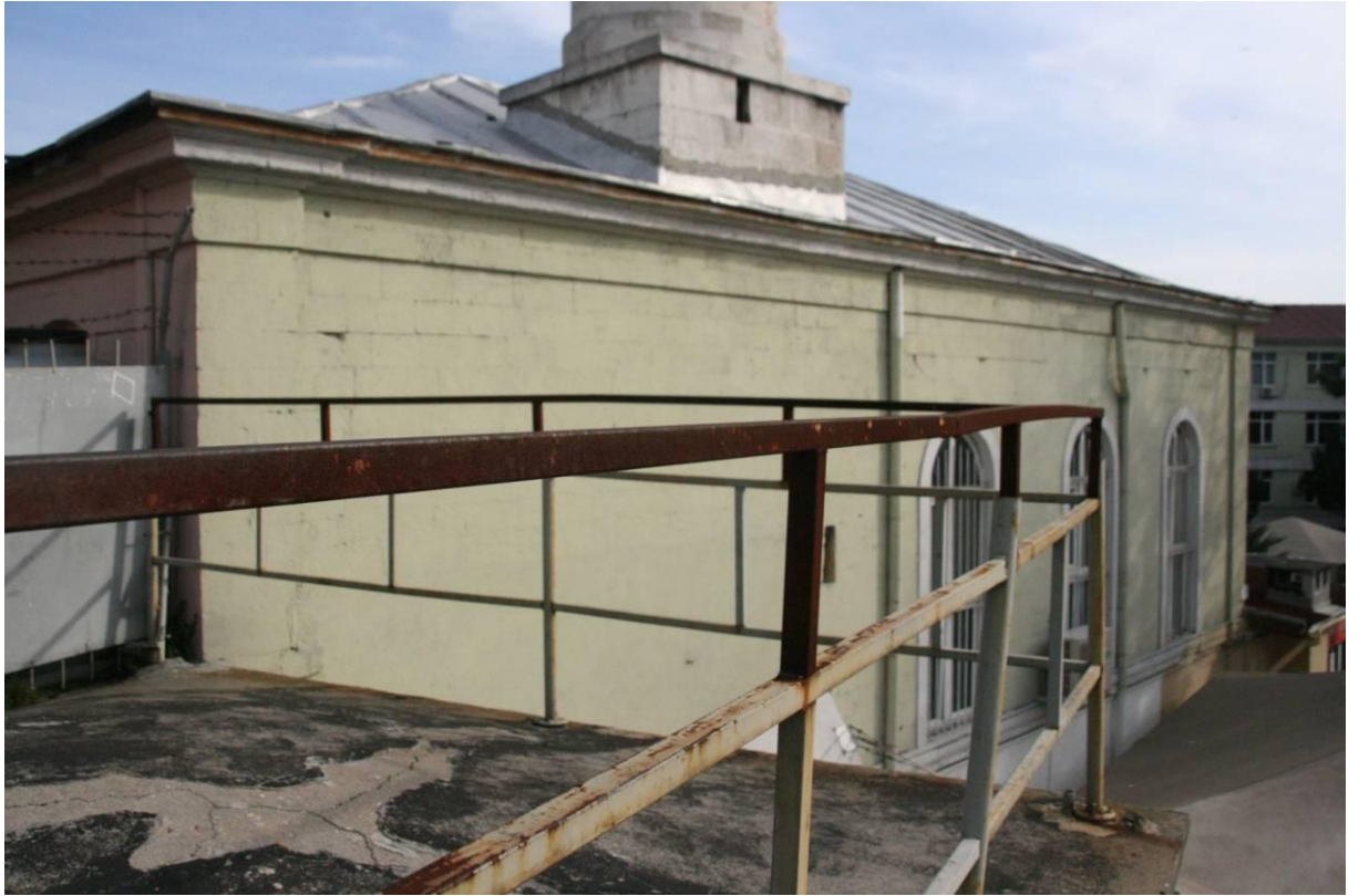
Şekil B.170: Caminin güneybatı cephesi.
