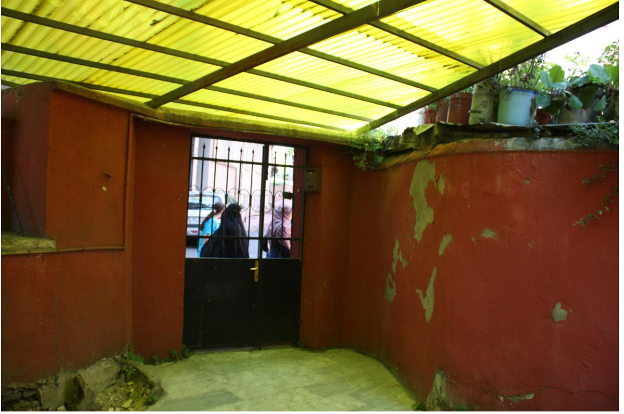
Şekil B.15: Avlunun batı ve kuzey duvarları.
