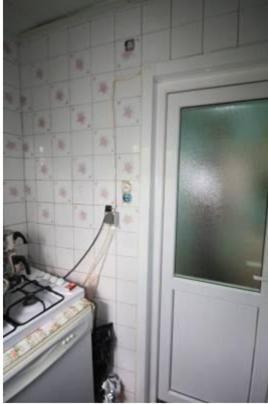
Şekil B.146: 1-05 mekânı kuzey duvarı.
