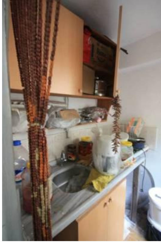
Şekil B.97: Z-08 mekânı doğu duvarı.
