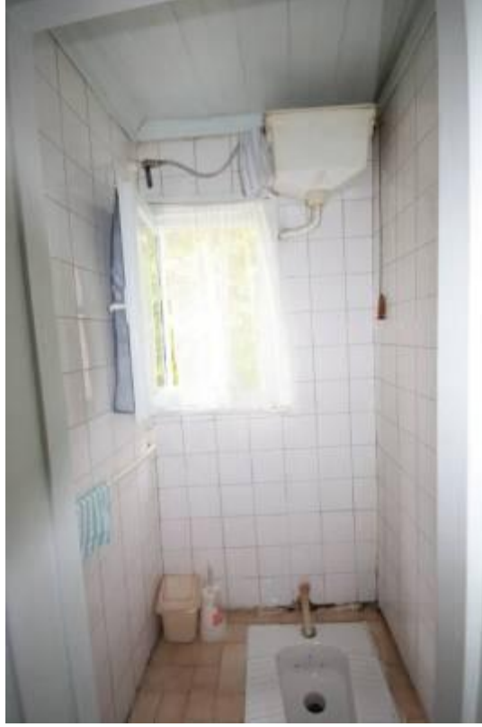
Şekil B.141: 1-04 mekânı batı duvarı.
