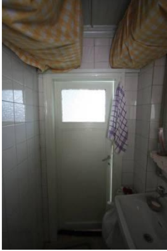
Şekil B.137: 1-03 mekânı doğu duvarı.
