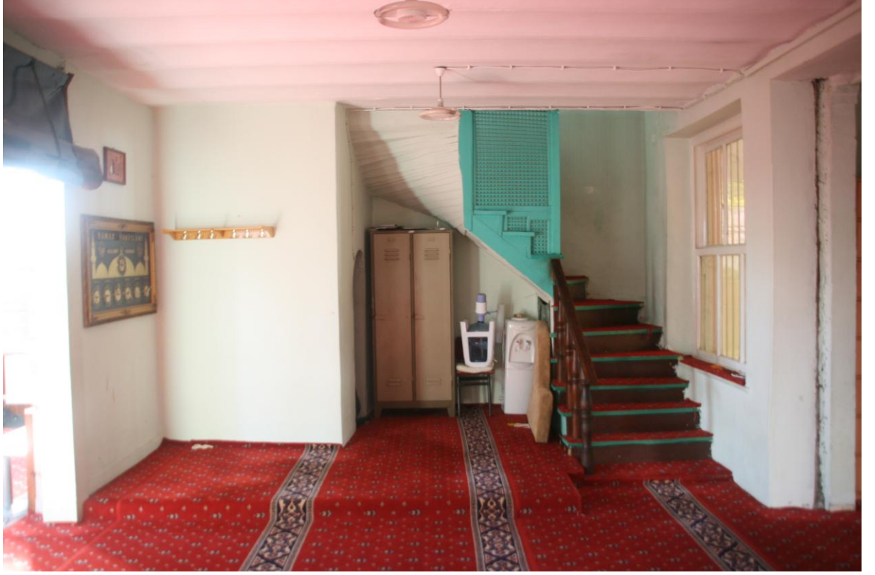
Şekil B.49: Z-02 mekânı güneybatı duvarı.
