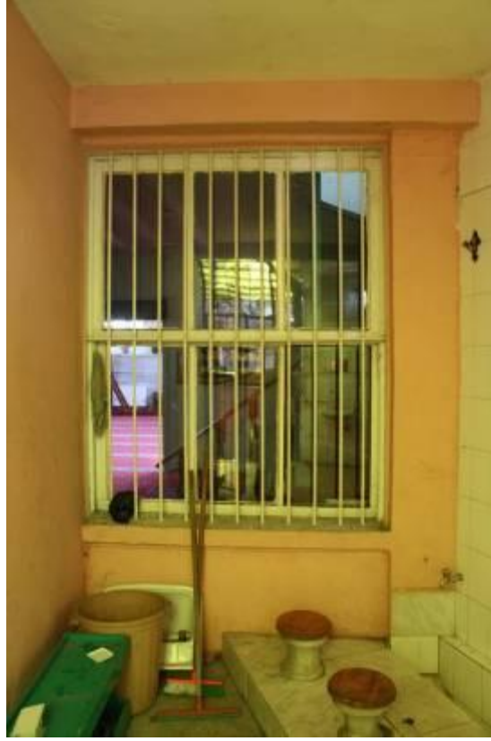
Şekil B.187: Caminin kuzeybatı cephesi, betonarme ekin batısındaki doğrama.
