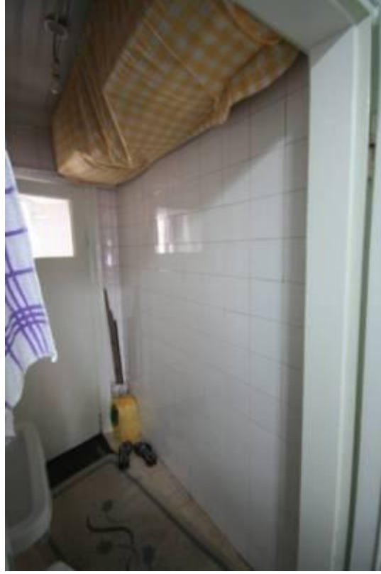
Şekil B.139: 1-03 mekânı kuzey duvarı.
