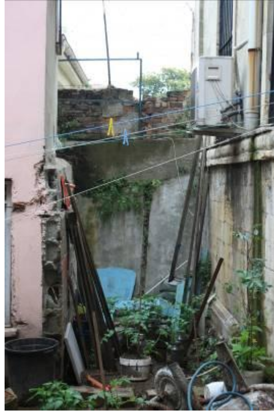
Şekil B.28: İç avluyu güneydoğu yönünde sınırlandıran duvar.
