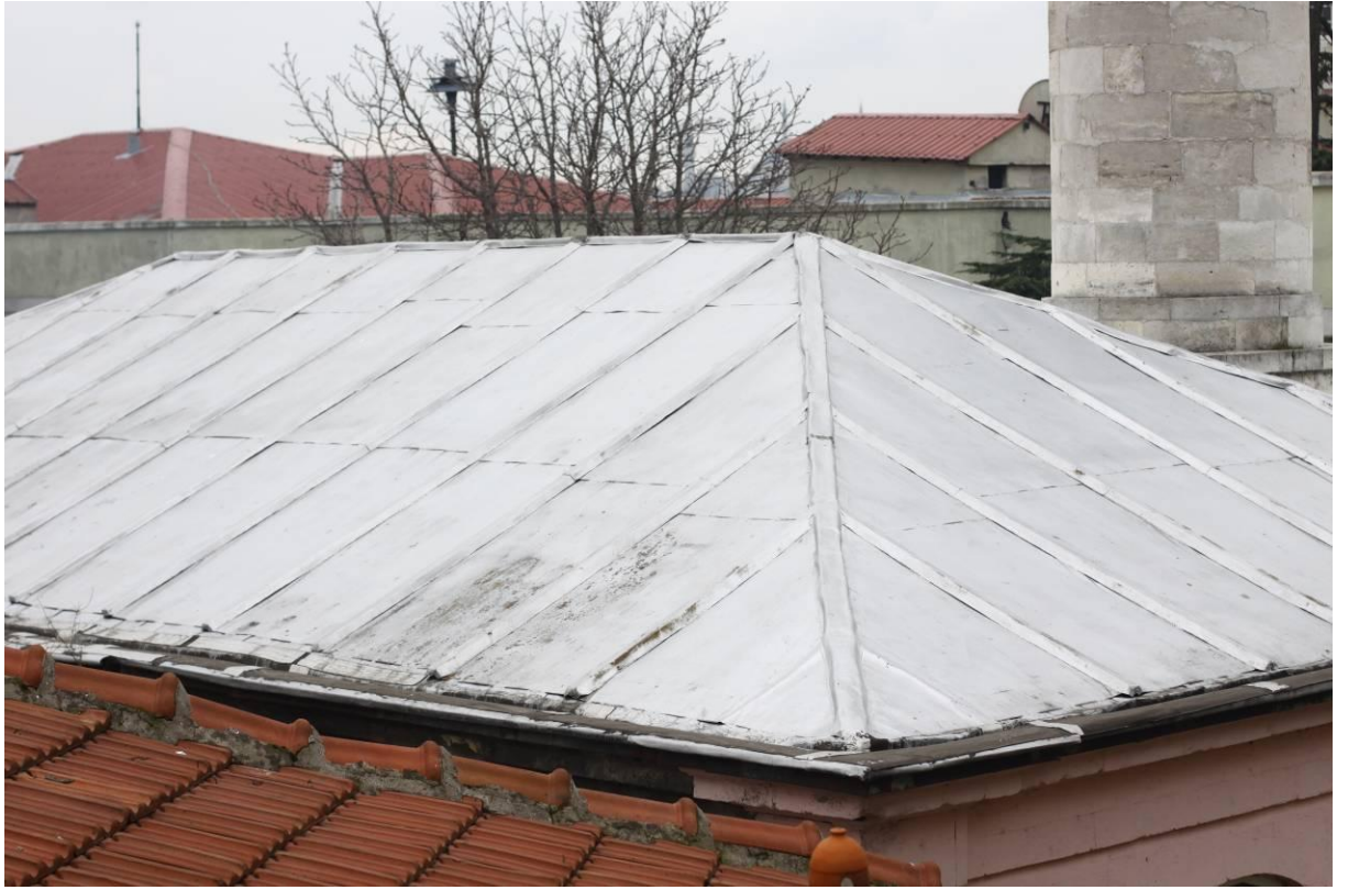
Şekil B.202: Cami çatısı genel görünüş.
