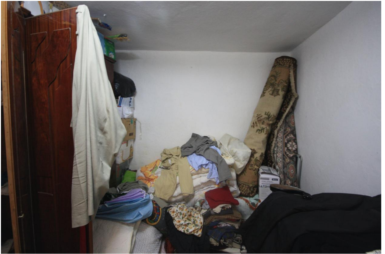
Şekil B.118: Z-12 mekânı kuzey duvarı.
