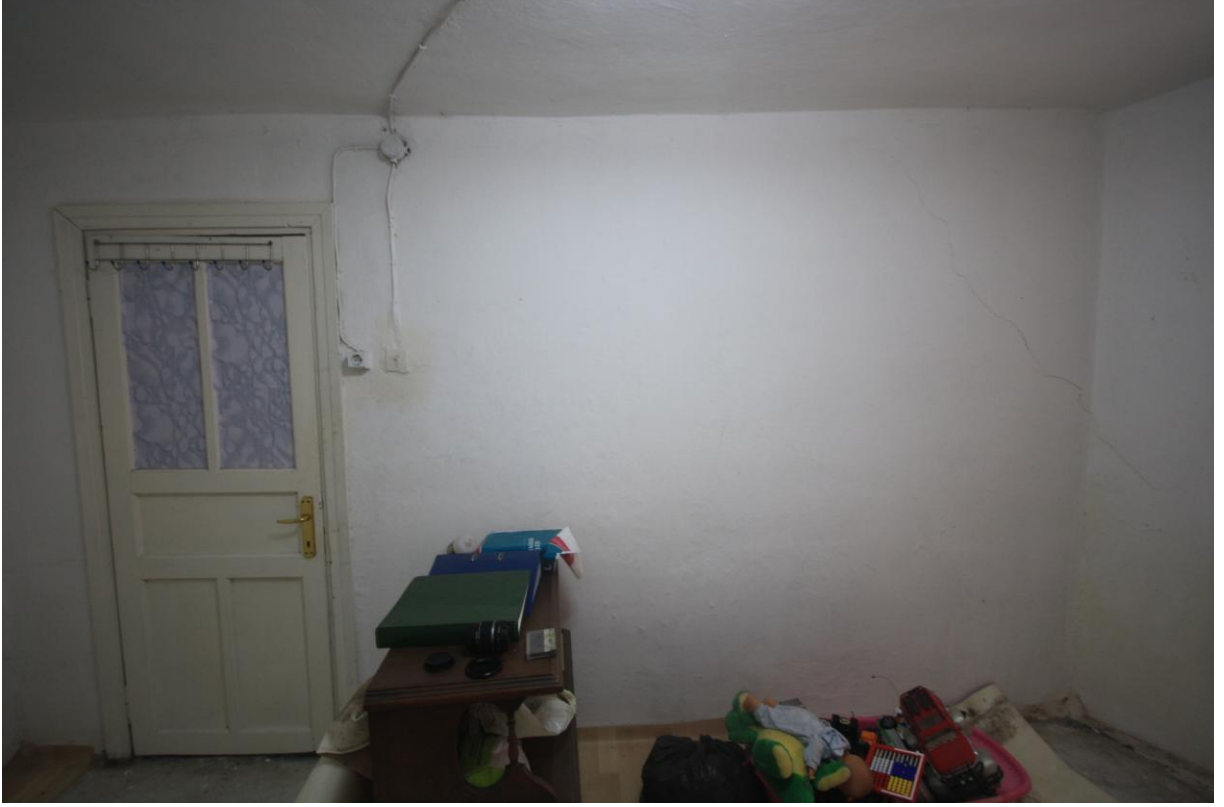
Şekil B.115: Z-11 mekânı batı duvarı.
