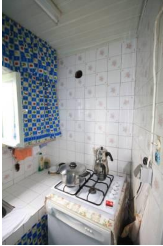
Şekil B.145: 1-05 mekânı batı duvarı.
