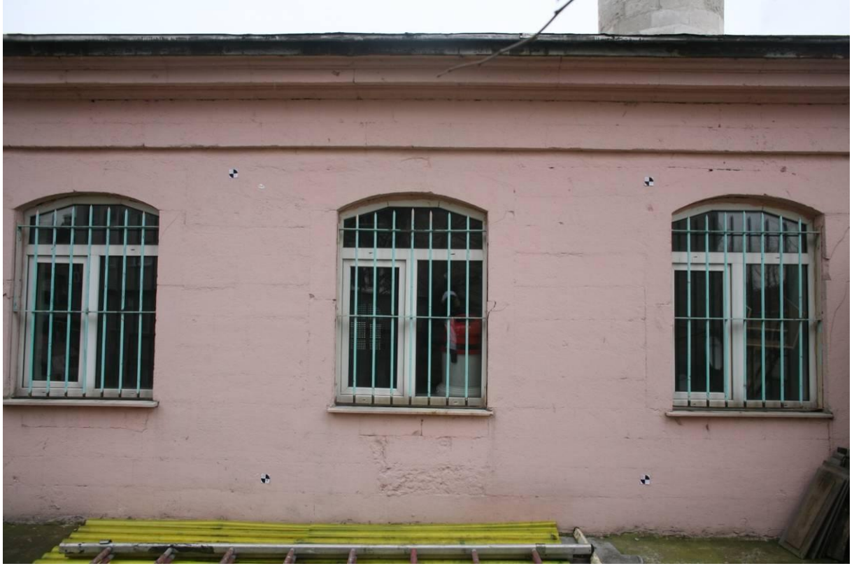
Şekil B.189: Caminin kuzeybatı cephesi.
