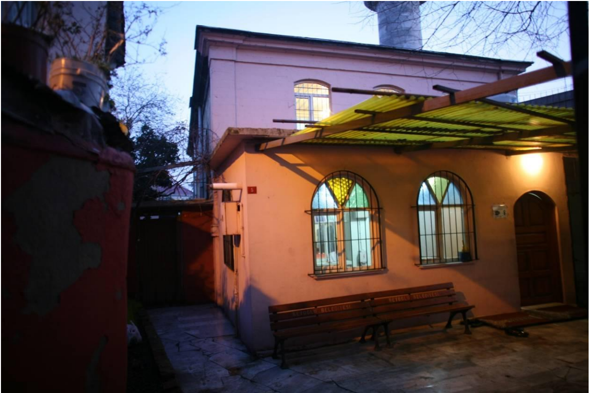
Şekil B.184: Caminin kuzeybatı cephesi.
