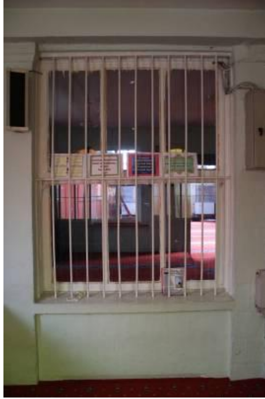
Şekil B.39: Z-01 mekânının güneydoğu duvarı.
