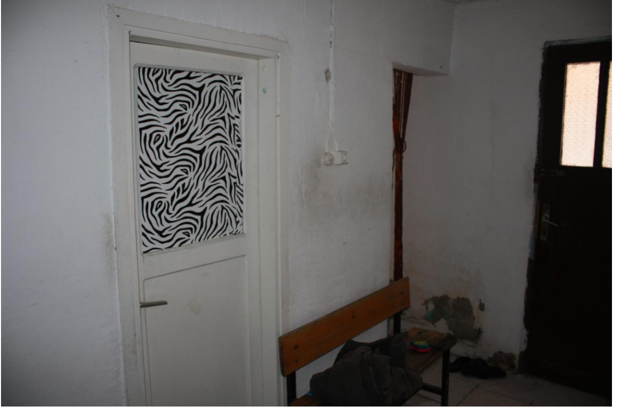
Şekil B.92: Z-07 mekânı güney duvarı.
