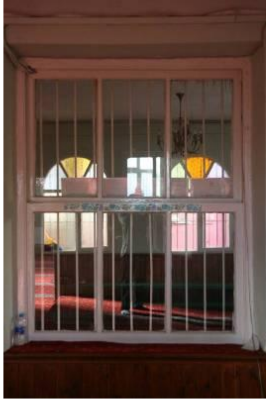
Şekil B.209: Z-01-Z-02 mekanları arasında bulunan ahşap giyotin pencere.
