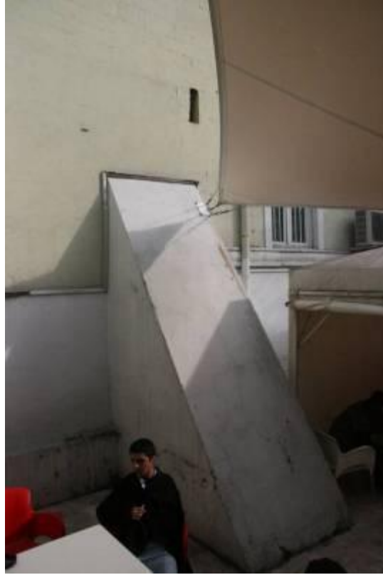
Şekil B.177: Caminin güneybatı cephesinde bulunan payanda.
