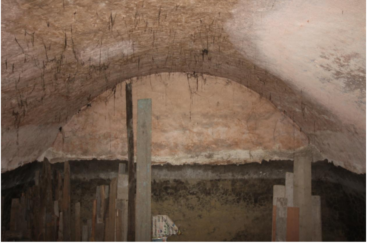
Şekil B.85: Z-06 mekânının doğu duvarı.
