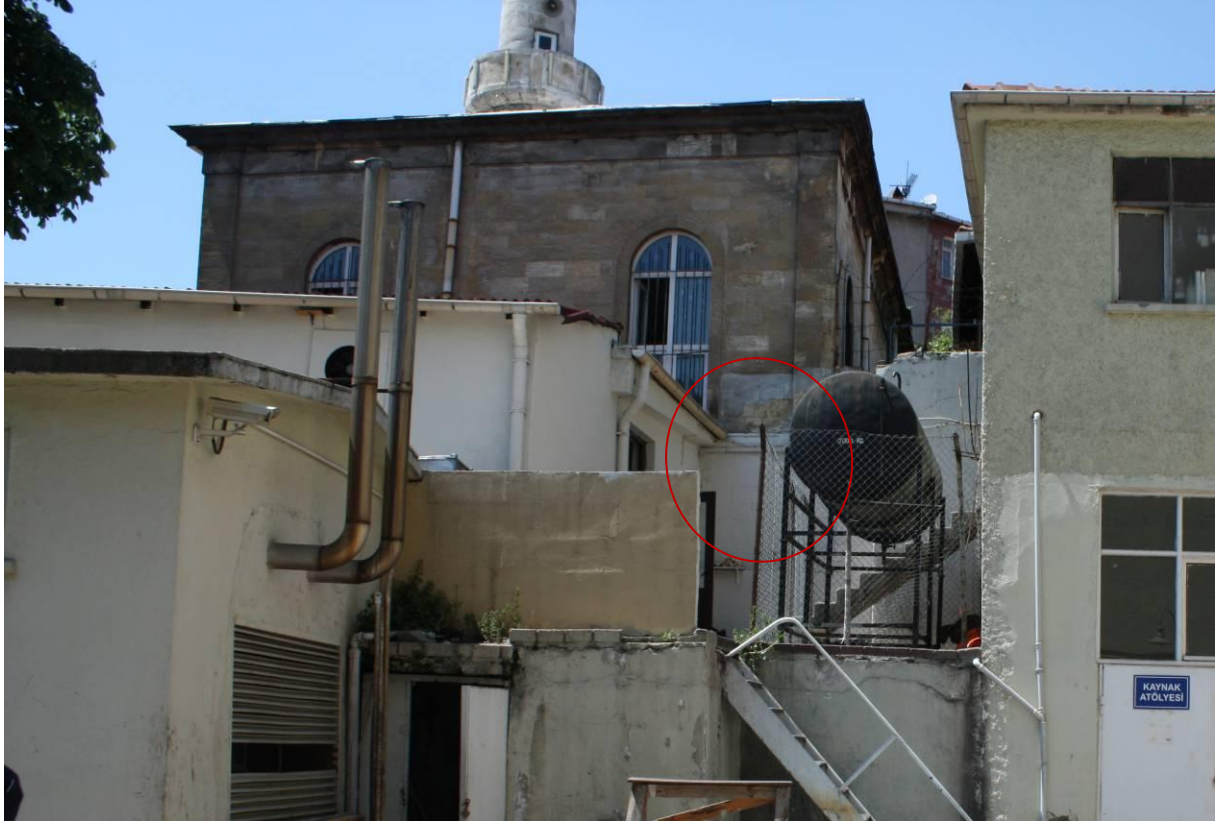
Şekil B.237: Caminin güneydoğu cephesinde görülen çimento esaslı sıva.
