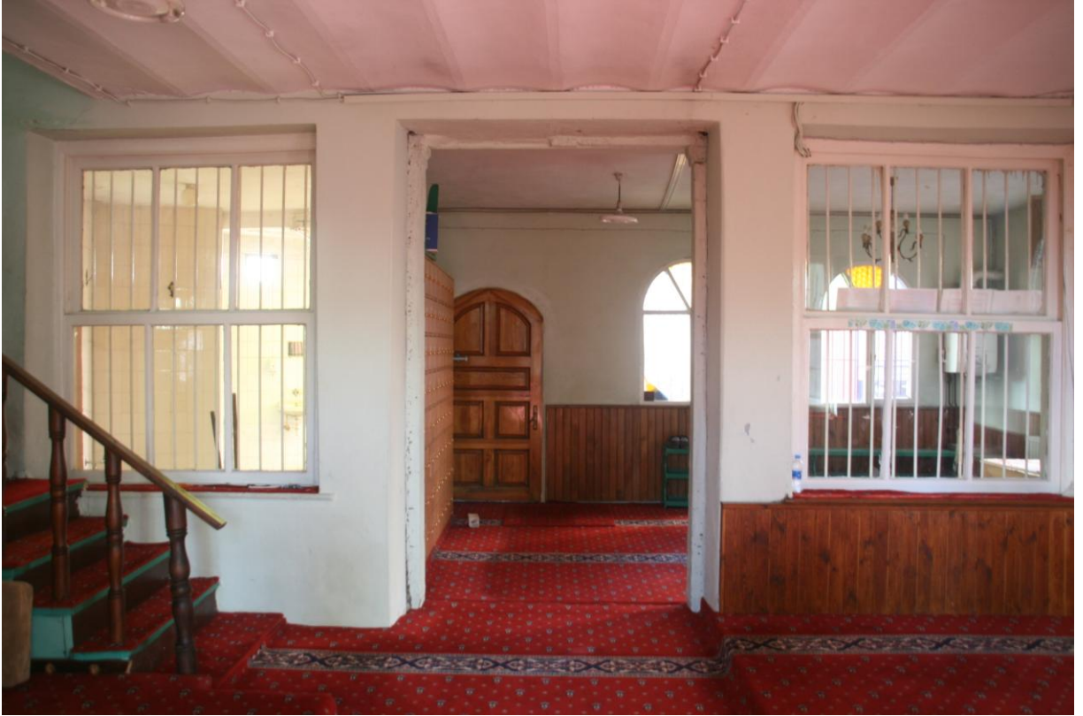
Şekil B.52: Z-02 mekânı kuzeybatı duvarı.
