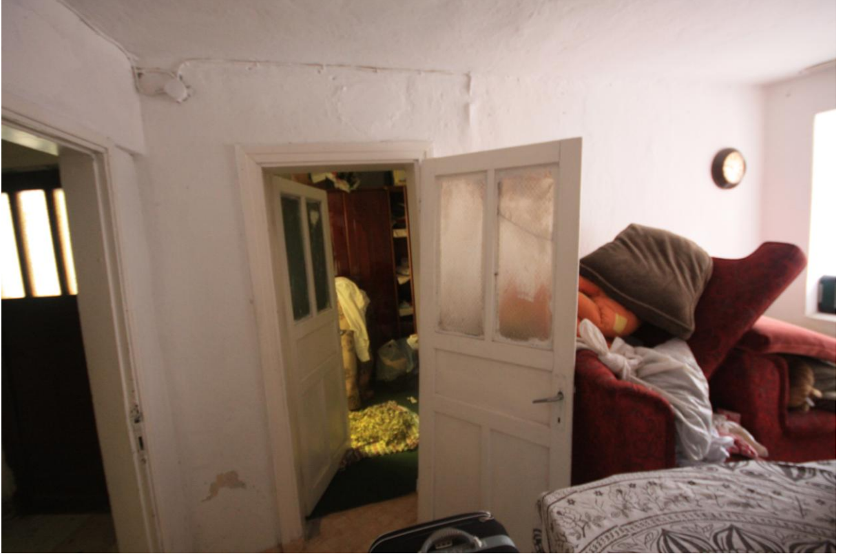
Şekil B.107: Z-10 mekânı batı duvarı.
