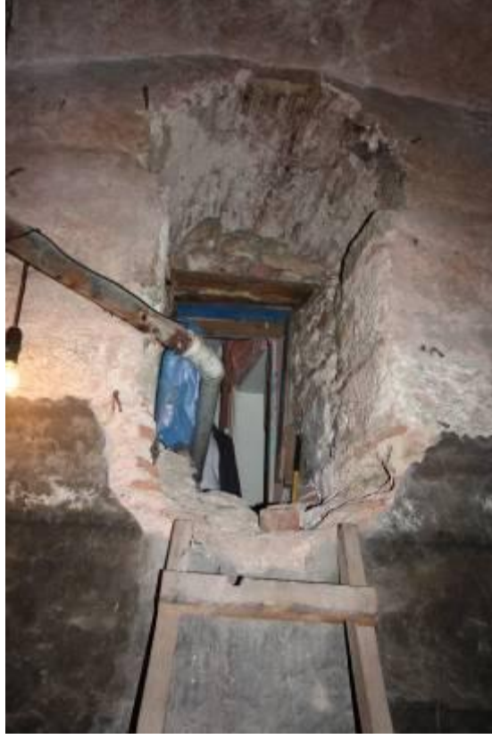
Şekil B.83: Z-06 mekânının batı duvarı.
