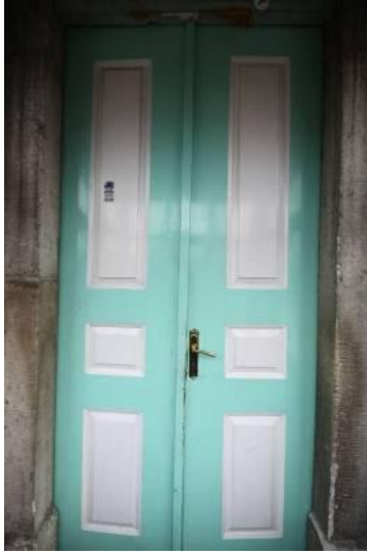
Şekil C.12: Büyük İskele Camii ana giriş kapısı.
