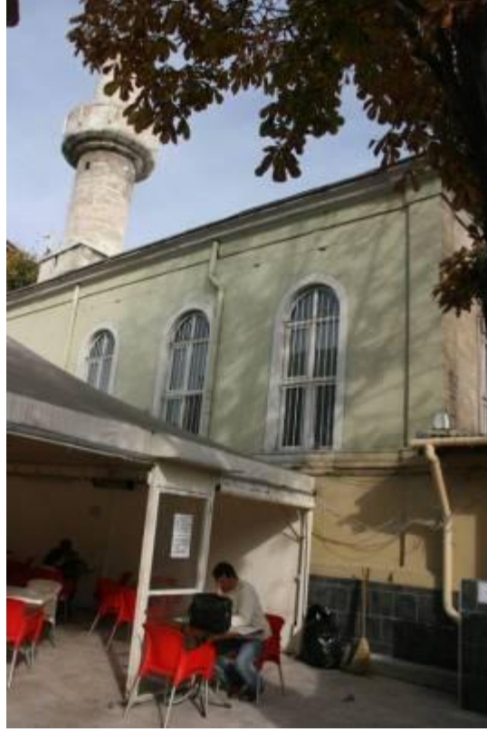
Şekil B.169: Caminin güneybatı cephesi.
