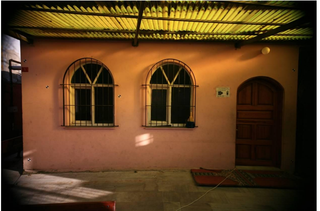
Şekil B.186: Caminin kuzeybatı cephesi, betonarme ek.
