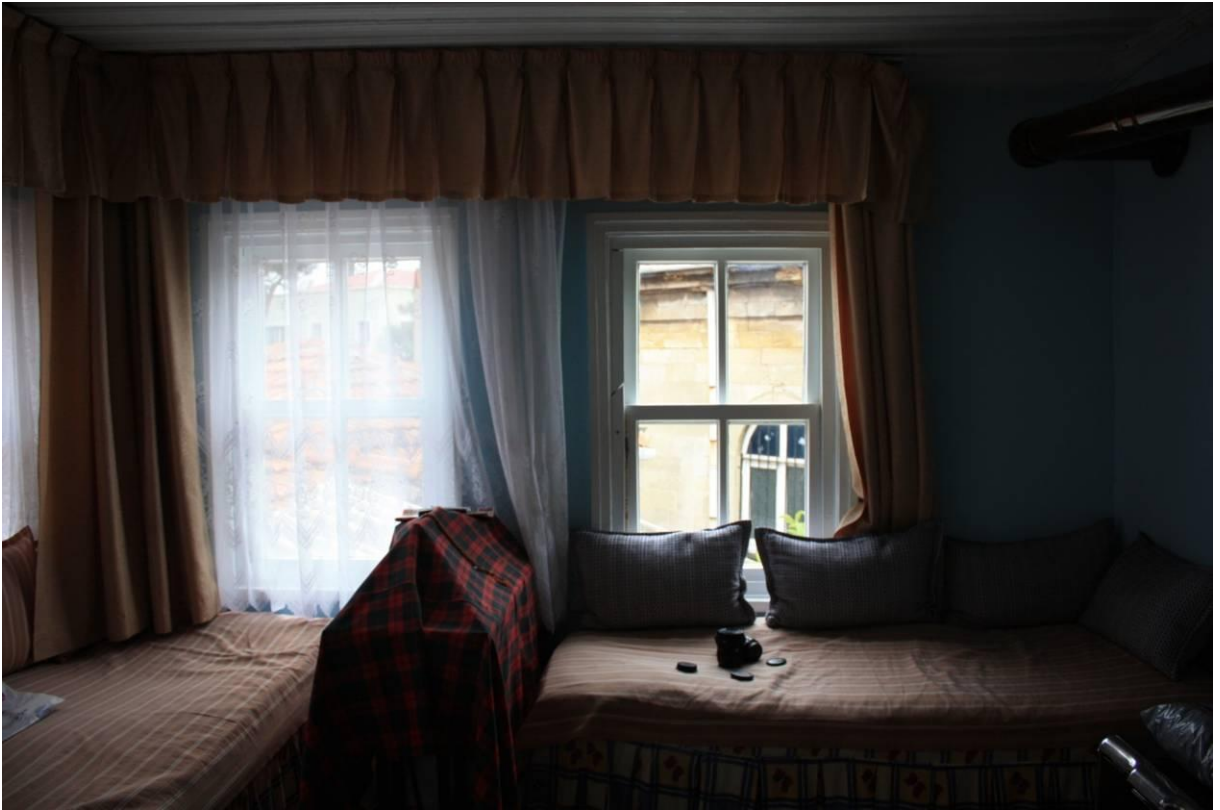
Şekil B.156: 1-10 mekânı güney duvarı.
