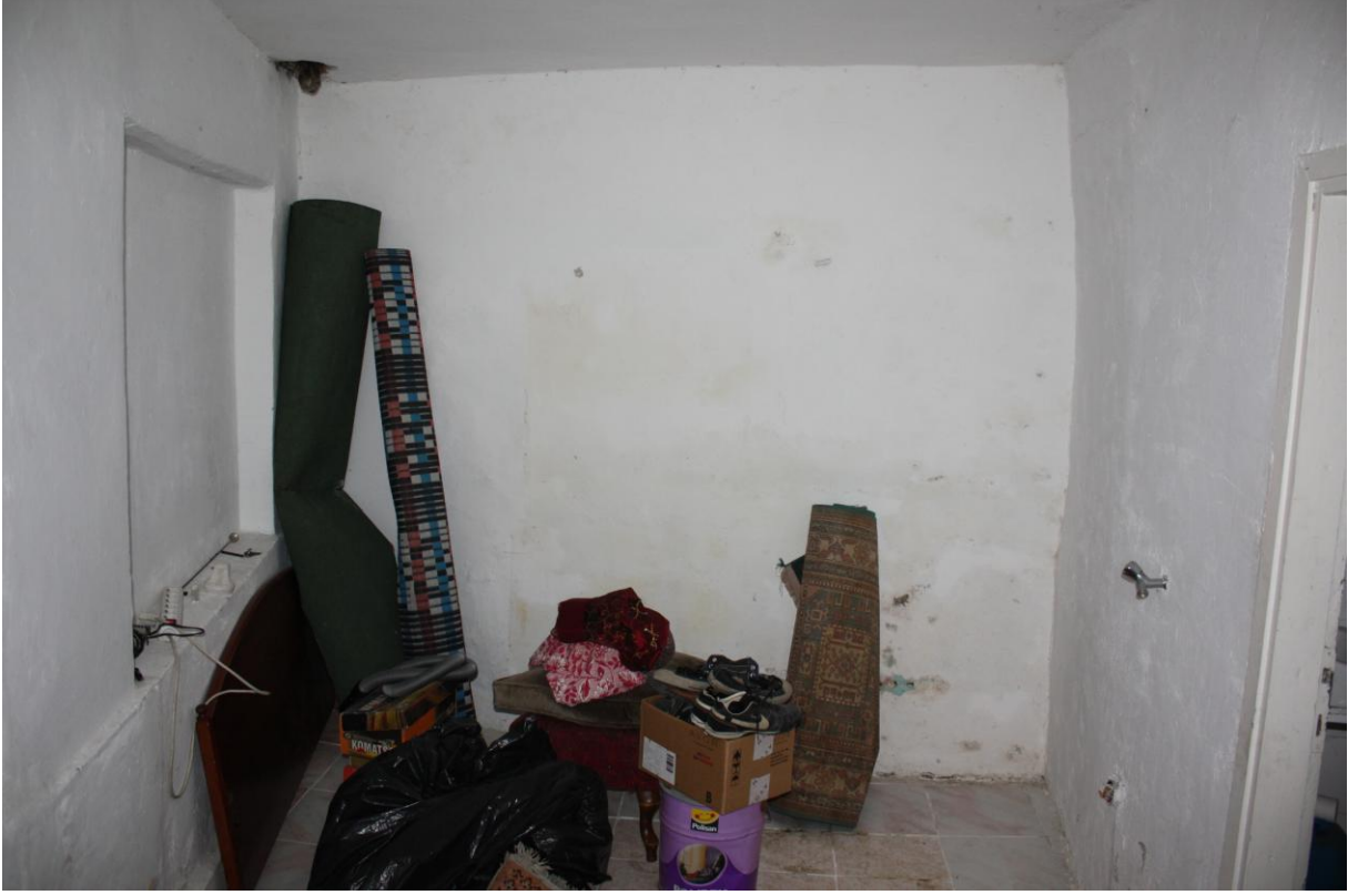
Şekil B.91: Z-07 mekânı doğu duvarı.
