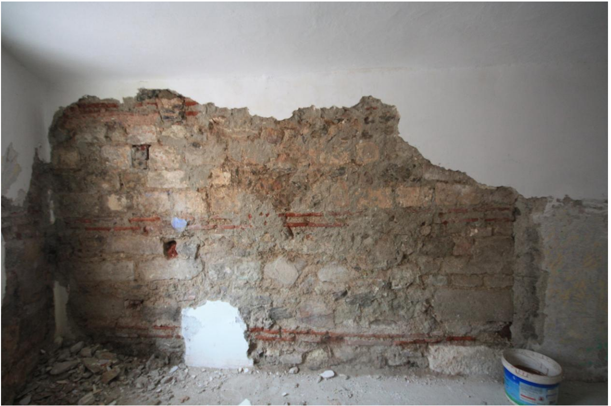
Şekil B.112: Z-11 mekânı doğu duvarı.
