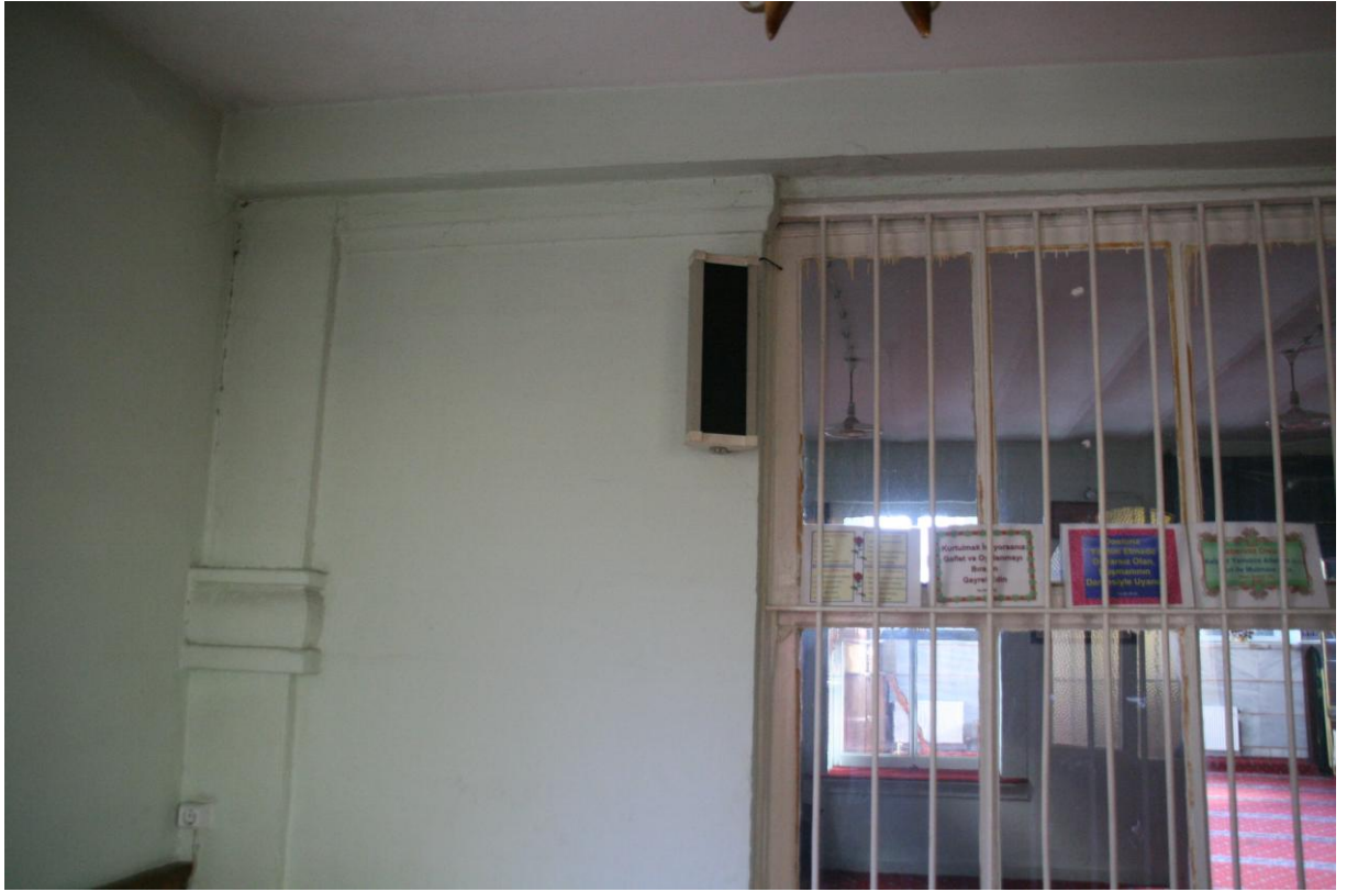
Şekil B.38: Z-01 mekânının güneydoğu duvarı.
