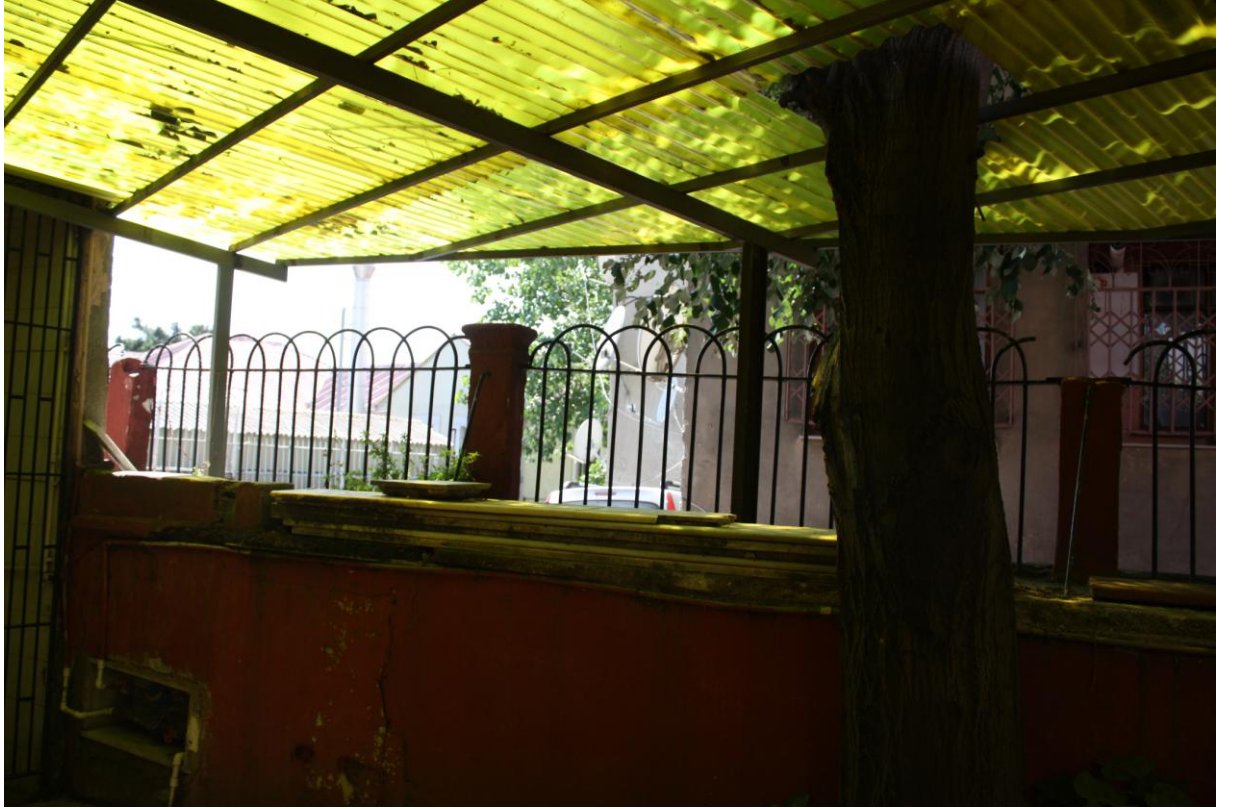
Şekil B.13: Avlu batı duvarı.
