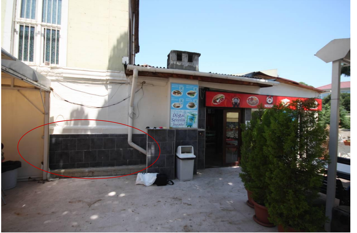
Şekil B.233: Caminin güneybatı cephesi.
