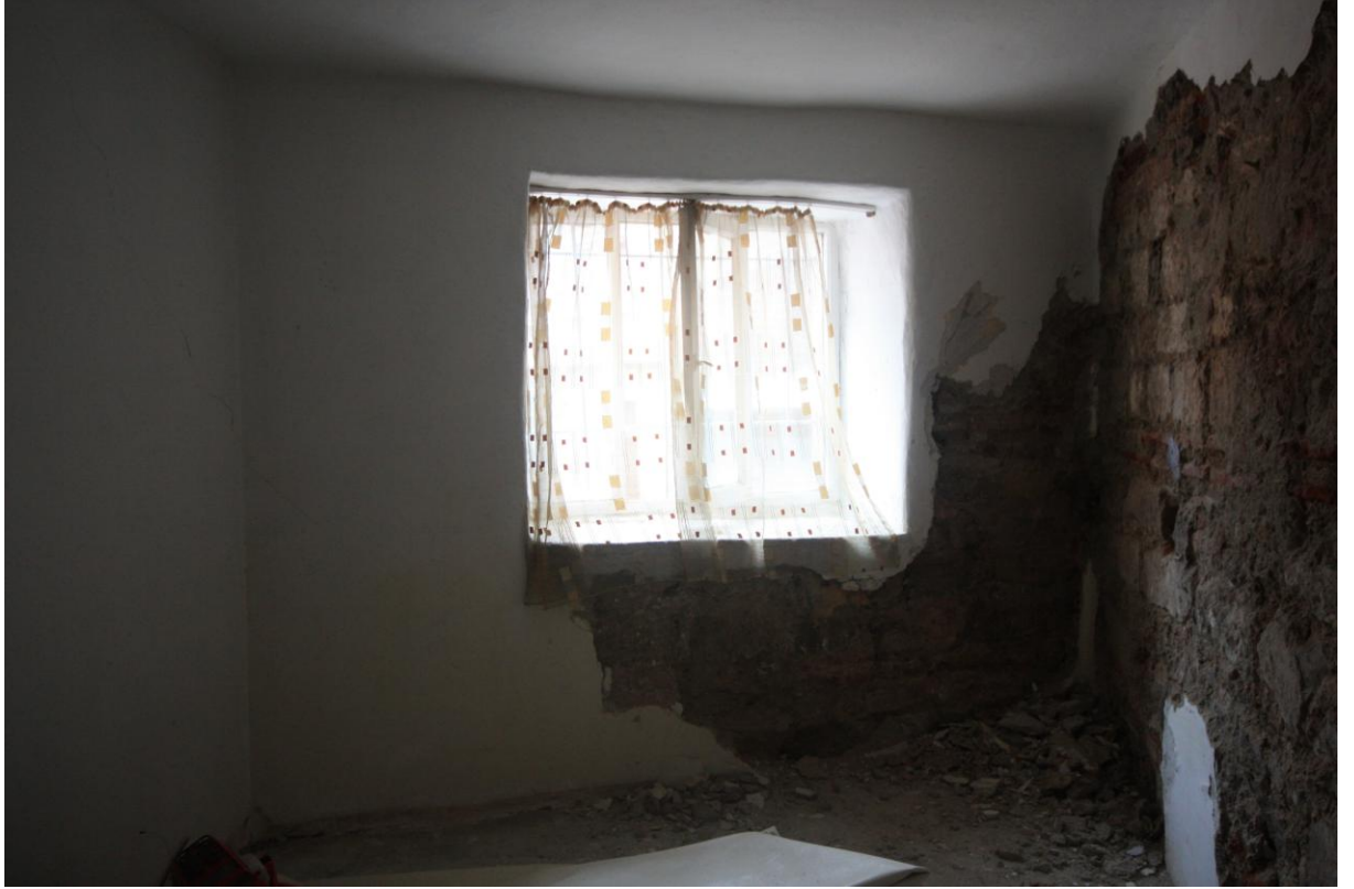
Şekil B.113: Z-11 mekânı kuzey duvarı.
