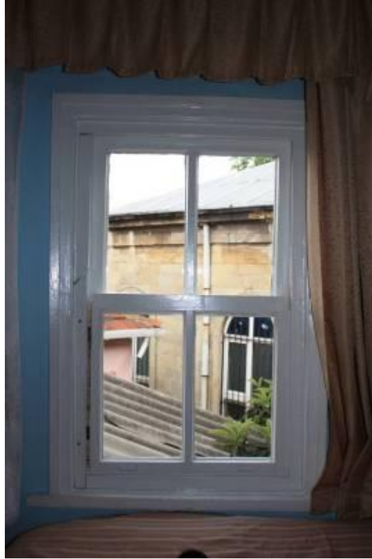
Şekil B.210: Konutta bulunan ahşap giyotin pencere.
