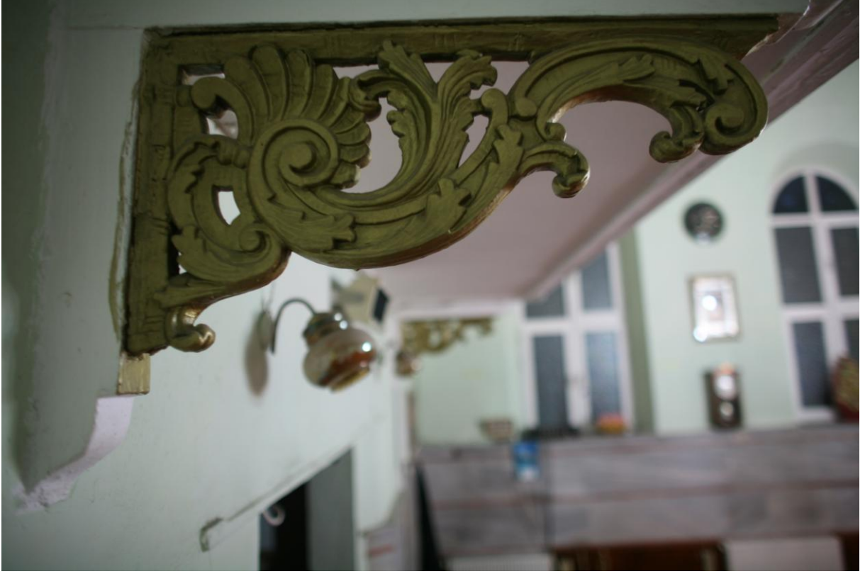
Şekil B.63: Kadınlar mahfili altındaki taşıyıcı.
