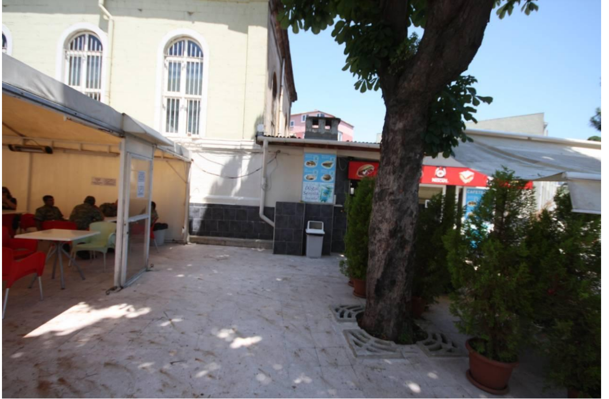
Şekil B.173: Caminin güneydoğu cephesine bitişik inşa edilmiş müştemilat.
