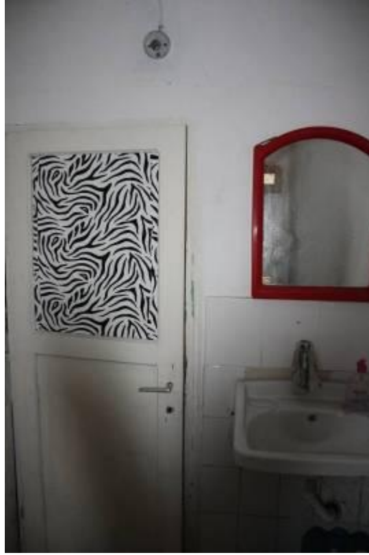
Şekil B.103: Z-09 mekânı kuzey duvarı.
