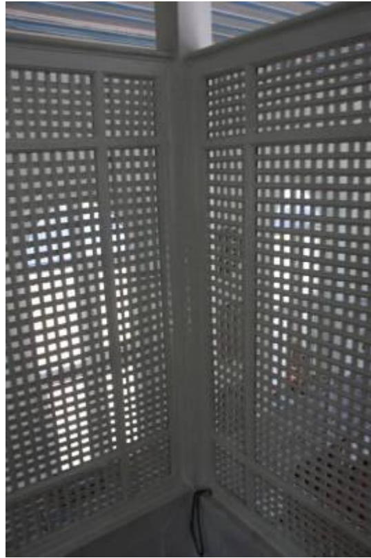
Şekil B.130: 1-01 mekânındaki ahşap direklerle ahşap kafeslerin birleşimi.
