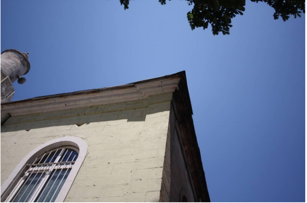
Şekil B.179: Caminin güneybatı cephesi boyunca devam eden taş profil.
