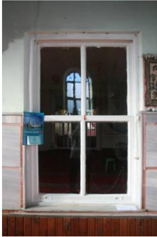
Şekil B.208: Z-02-Z-03 mekanları arasında bulunan ahşap giyotin pencere.
