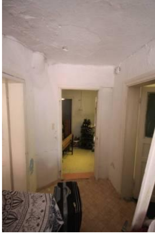
Şekil B.109: Z-10 mekânı güney duvarı.
