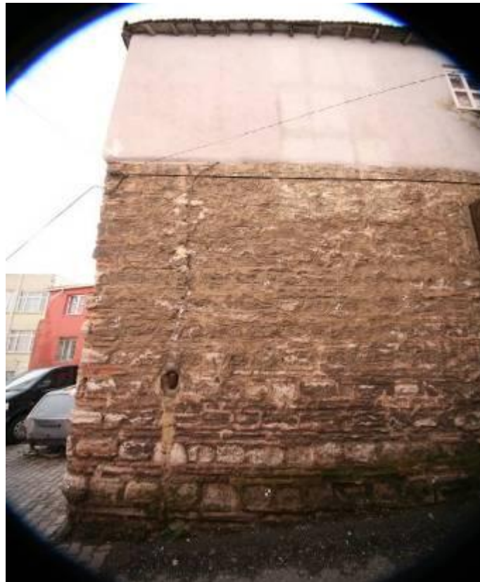
Şekil B.198: Konutun kuzey cephesi, doğu köşesi parça 1/3.
