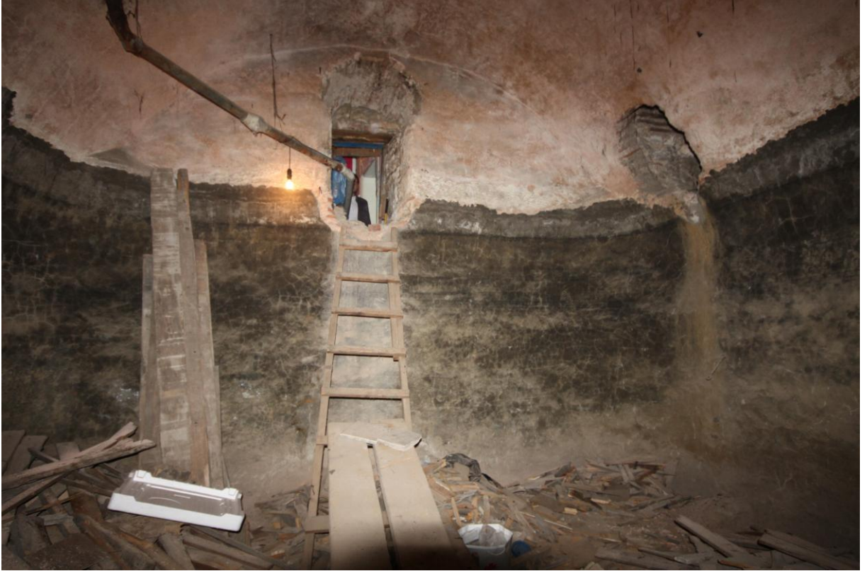
Şekil B.84: Z-06 mekânının batı ve kuzey duvarı.
