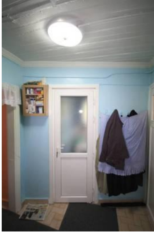
Şekil B.133: 1-02 mekânı güney duvarı.
