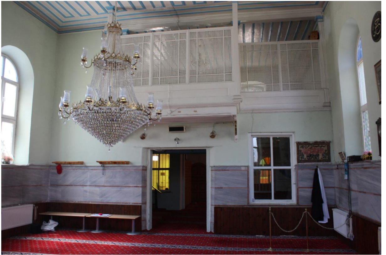
Şekil B.62: Z-03 mekânı kuzeybatı duvarı.
