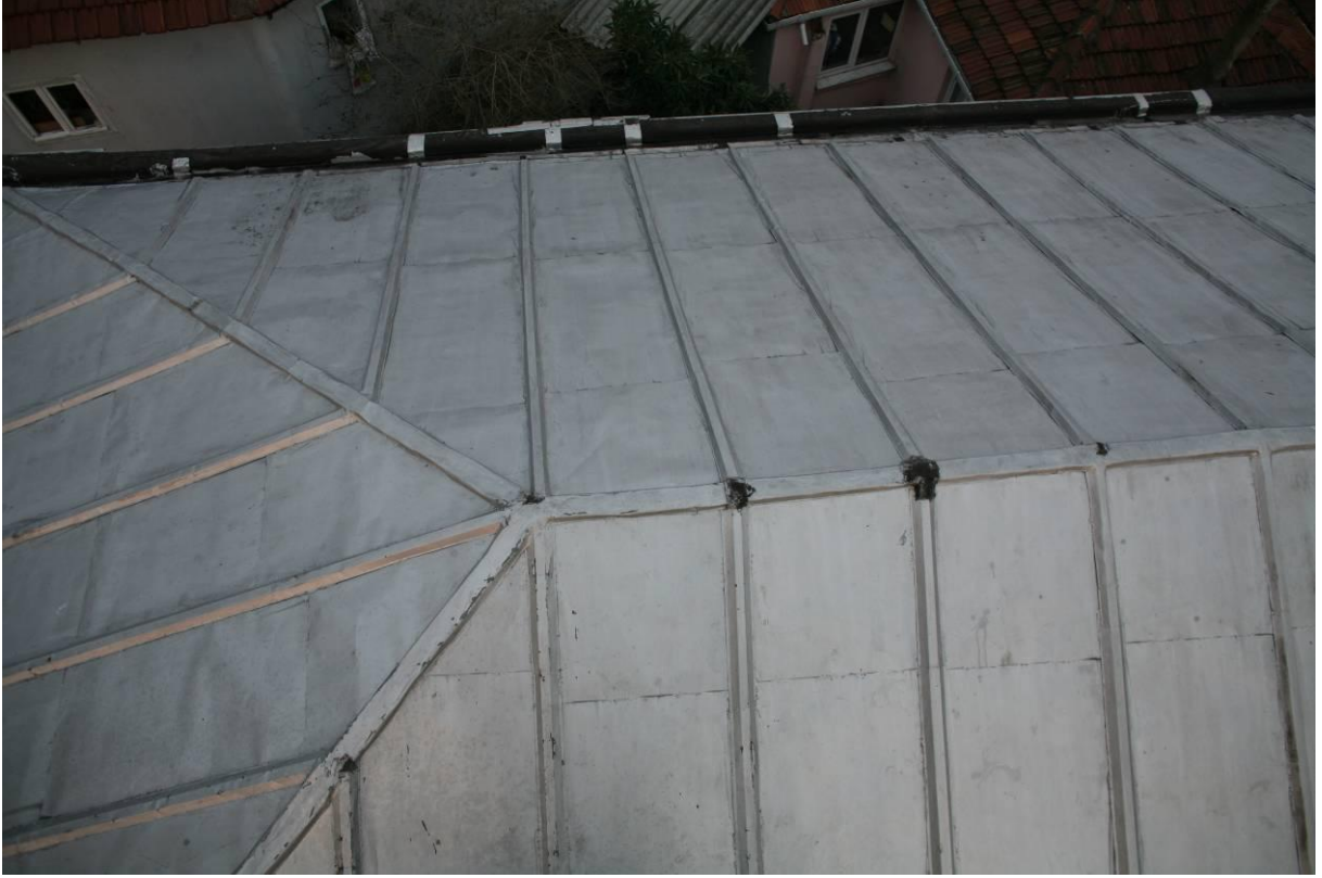
Şekil B.203: Cami çatısı genel görünüş.
