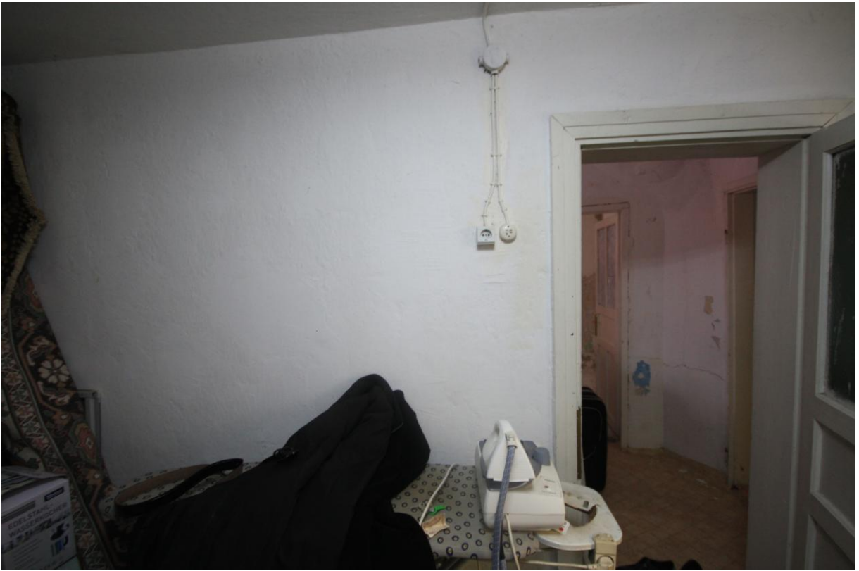
Şekil B.120: Z-12 mekânı doğu duvarı.
