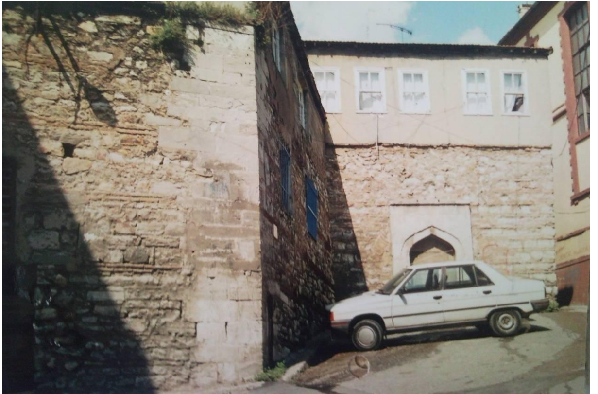
Şekil C.17: Konut ve lojmanın doğu cepheleri (1994).
