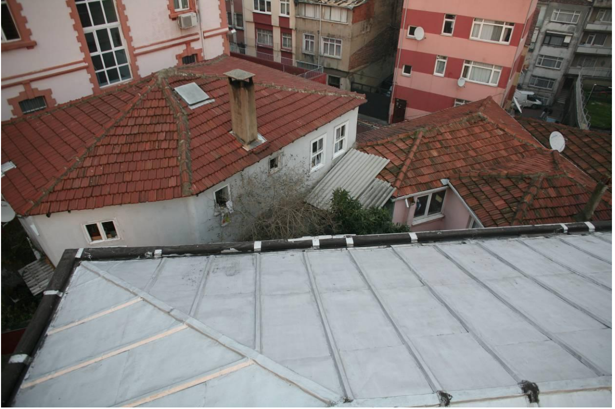
Şekil B.207: Lojman çatısı, genel görünüş.
