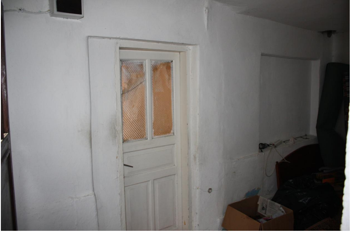
Şekil B.89: Z-07 mekânı kuzey duvarı..
