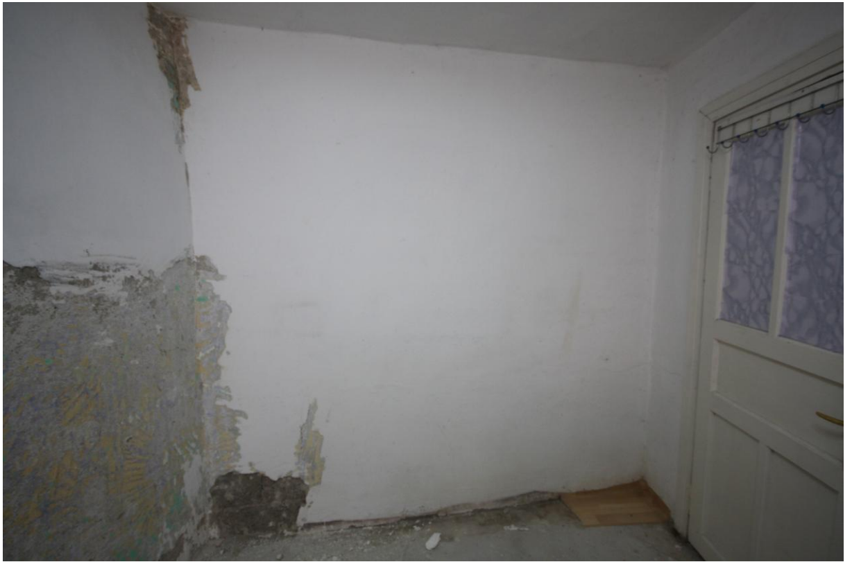
Şekil B.114: Z-11 mekânı güney duvarı.
