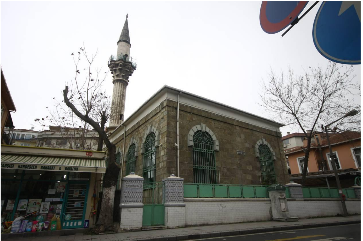
Şekil C.7: Hasan Paşa Camii genel görünüş.
