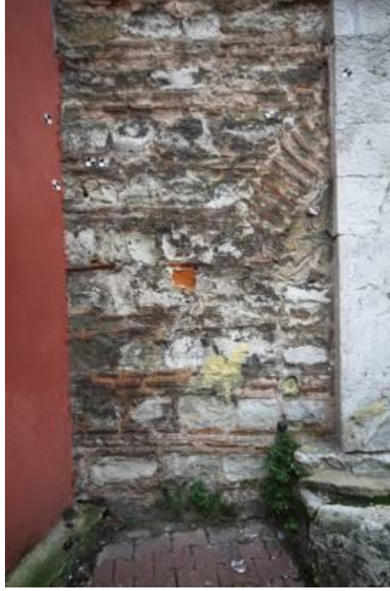
Şekil B.235: Konutun doğu cephesinde görülen kirlenme ve bitkilenme.
