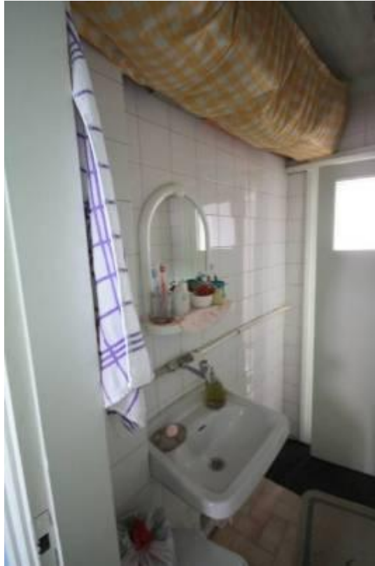
Şekil B.138: 1-03 mekânı güney duvarı.
