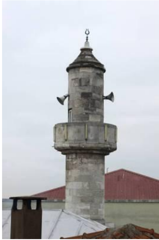
Şekil B.216: Minare genel görünüş.
