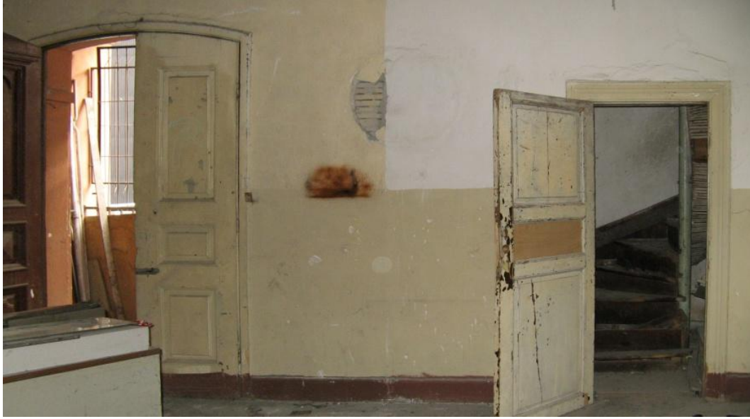
Şekil 3.67: Şapelin ana giriş kapısı ve Z-03 Merdiven Mekânı kapısı.
