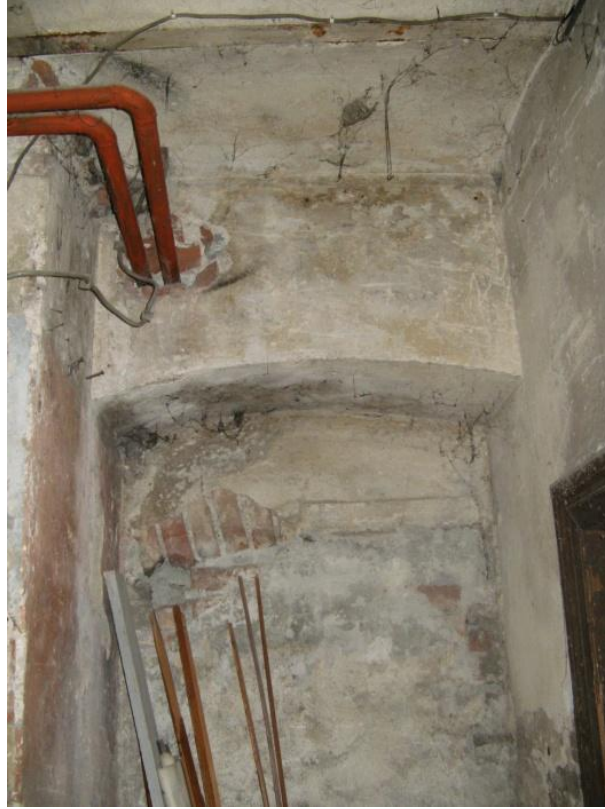
Şekil 3.59: B-05 Mekânını manastır binasına bağlayan sonradan kapatılmış geçit.
