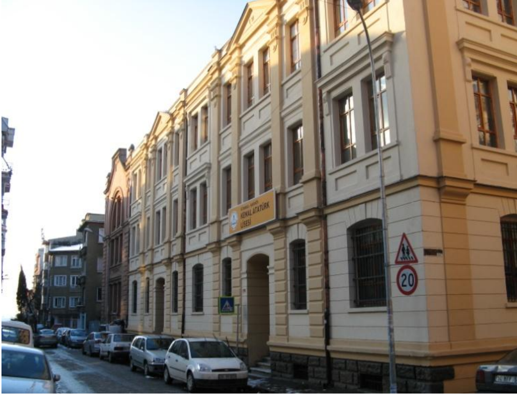
Şekil 3.32: St. Euphemie Ortaokulu manastır binasının İskele Sokağı cephesi.
