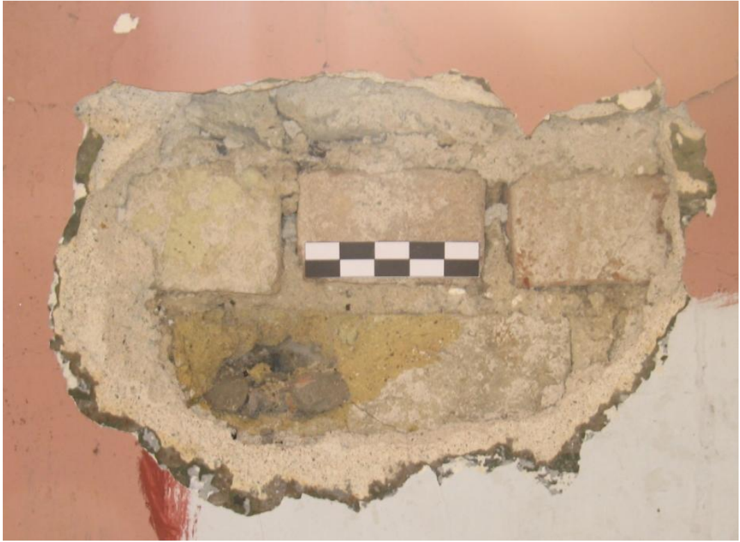
Şekil 3.114: B-01 Toplantı Salonu duvarlarında kullanılan tuğla.
