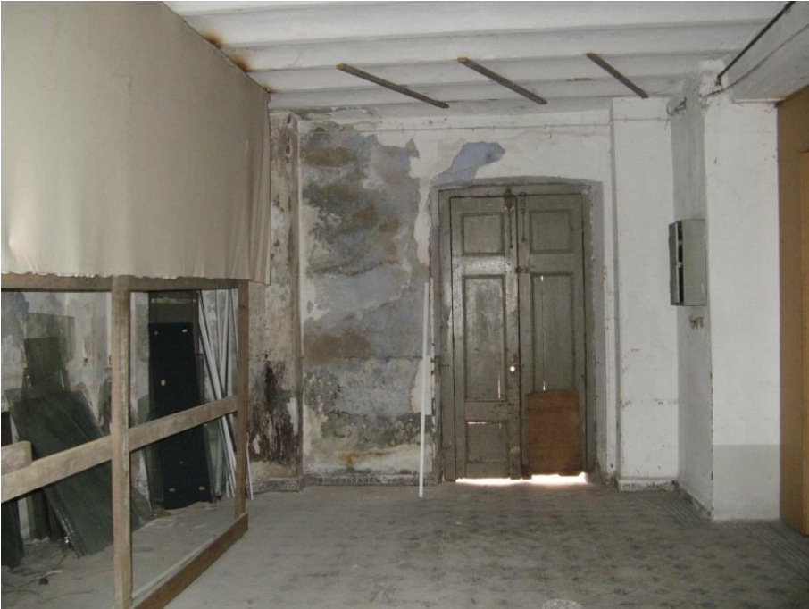
Şekil 3.44: B-01 Mekânı Toplantı salonu sahne bölümünün doğu duvarına bakış.
