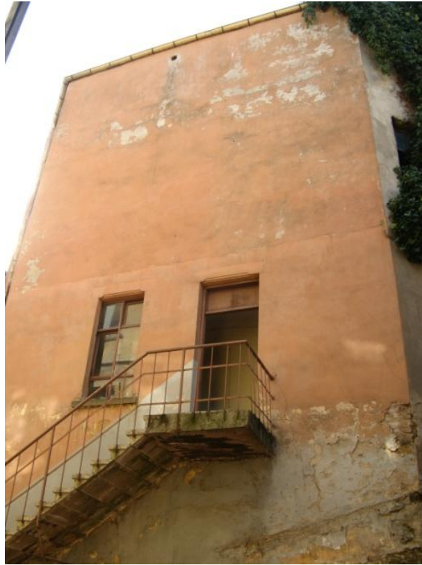
Şekil 3.102: Şapelin kuzey cephesi, sonradan açılan giriş.
