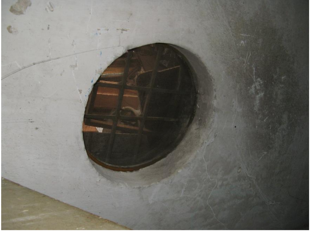
Şekil 3.77: Z-03 Merdiven Mekânından Z-01 Giriş Mekânına bakan gül pencere.
