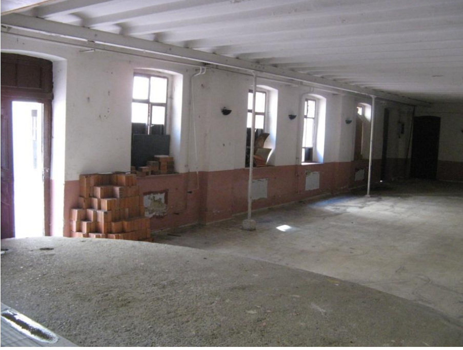
Şekil 3.39: B-01 Mekânı Toplantı salonu, doğu duvarına bakış.
