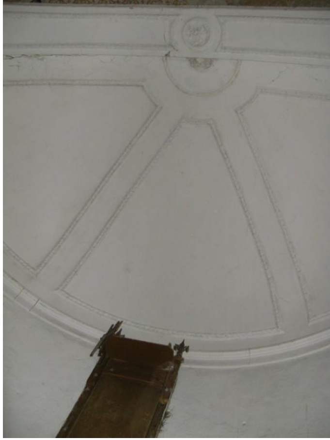
Şekil 3.73: Apsisi örten yarım kubbe.
