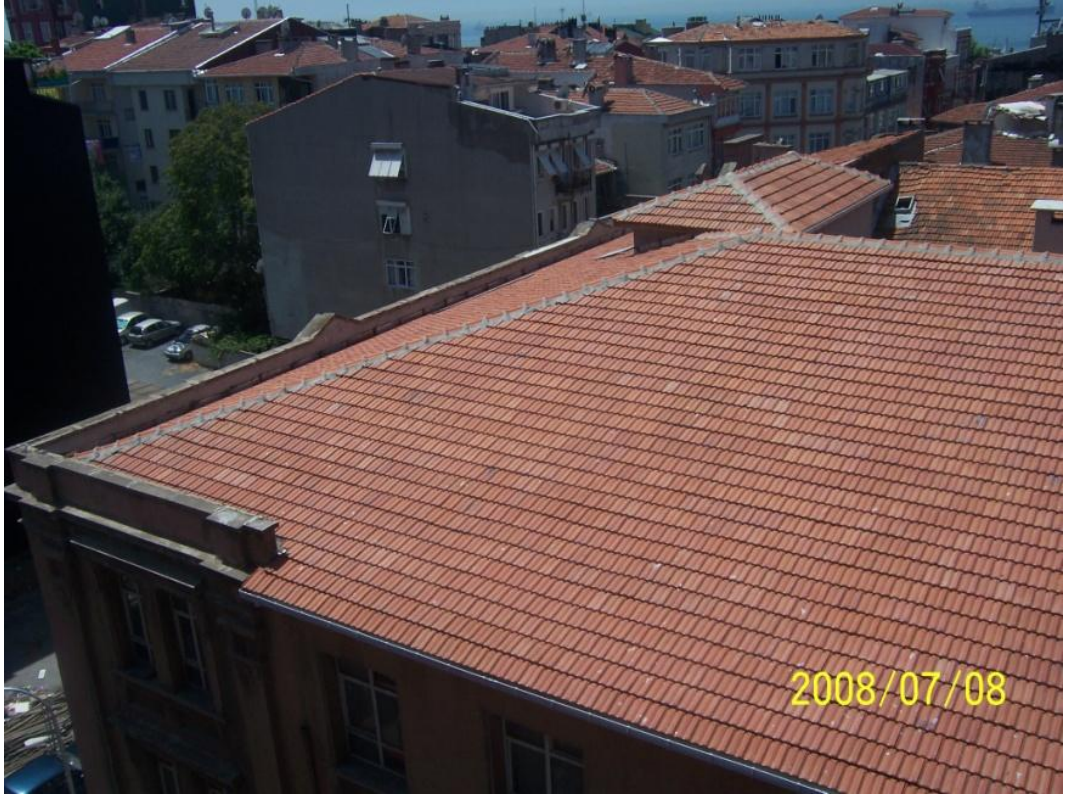
Şekil 3.121: Manastır binası çatısının güneydoğu köşesi (İTÜ Arşivi, 2008).
