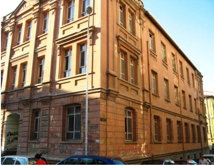
Şekil 3.33: St. Euphemie Ortaokulu manastır binasının Taşlıbayır Sokağı cephesi.
