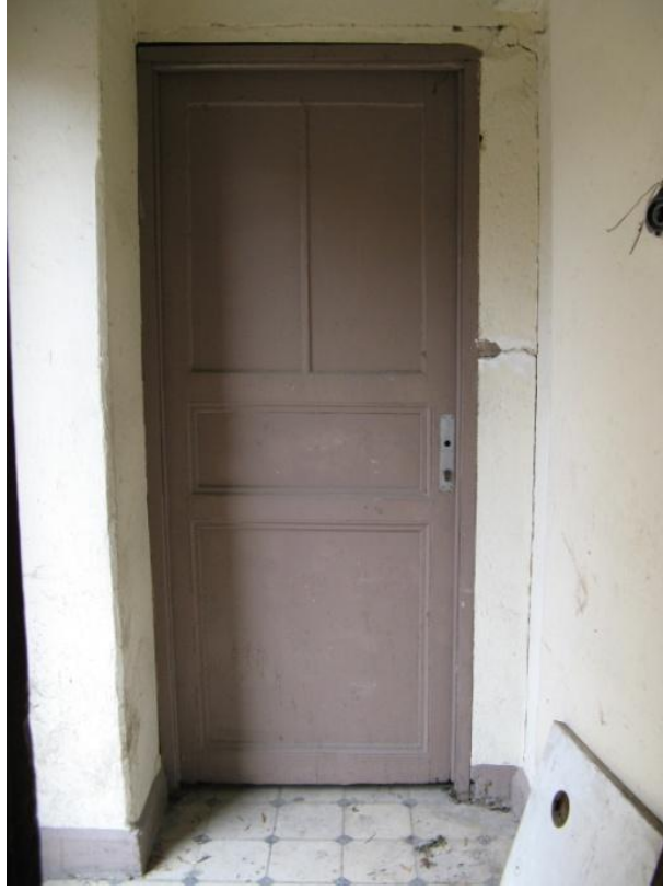
Şekil 3.85: Z-05 Mekânını Z-06 Mekânına bağlayan kapı.
