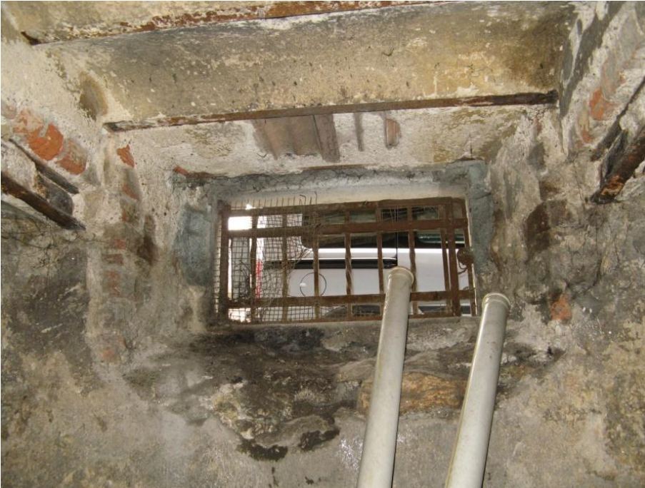
Şekil 3.52: B-03 Mekânı güney duvarındaki mazgal pencere.
