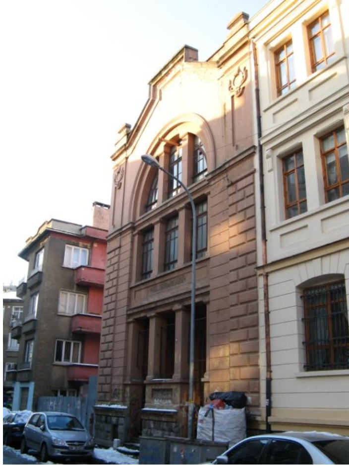
Şekil 3.34: Notre Dame du Rosaire Şapeli İskele Sokağı cephesi.
