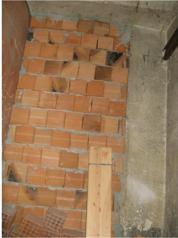
Şekil 3.58: B-05 ve B-02 Mekânları arasında yer alan sonradan kapatılmış geçit.
