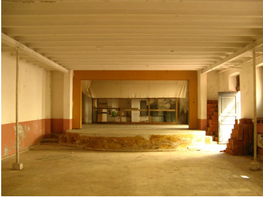
Şekil 3.37: B-01 Mekânı Toplantı salonu, kuzeye bakış.
