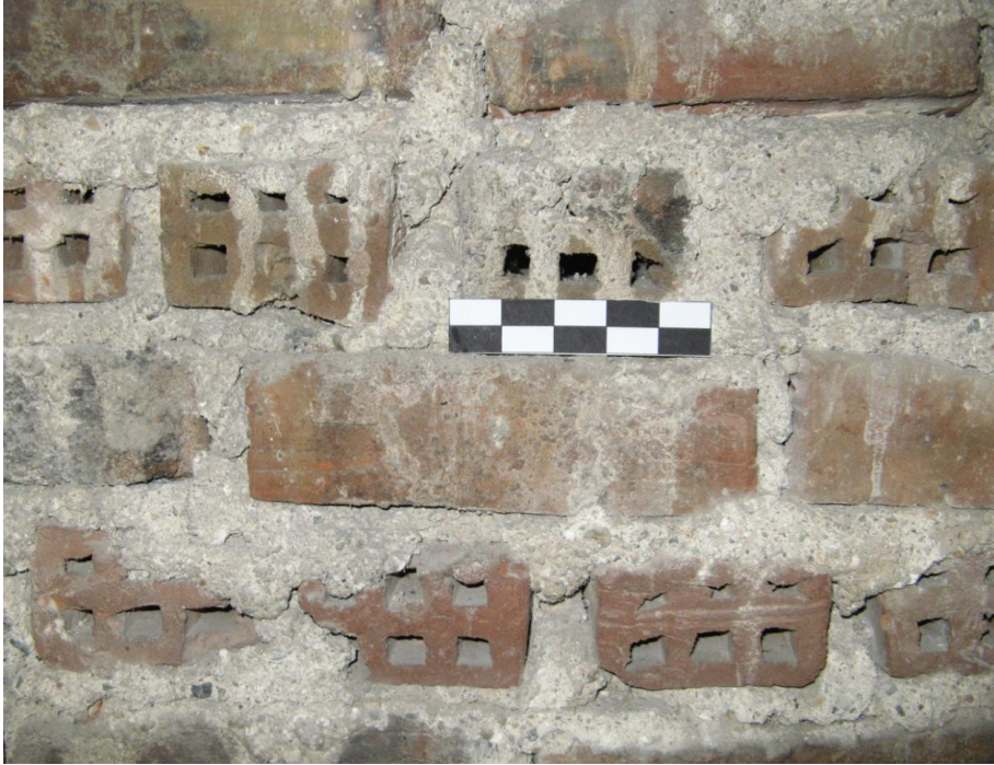
Şekil 3.116: Şapelin üst kısmında kullanılan delikli tuğla.
