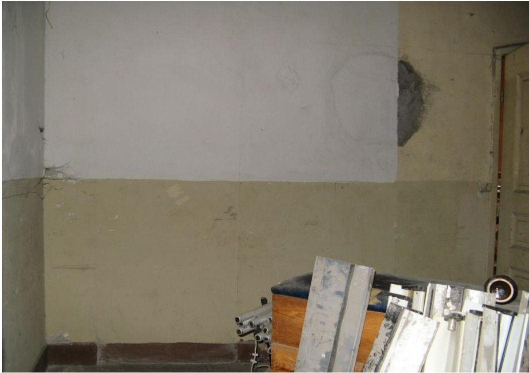
Şekil 3.68: Narteks bölümü güney duvarında kapatılmış kapı ve pencere izleri.
