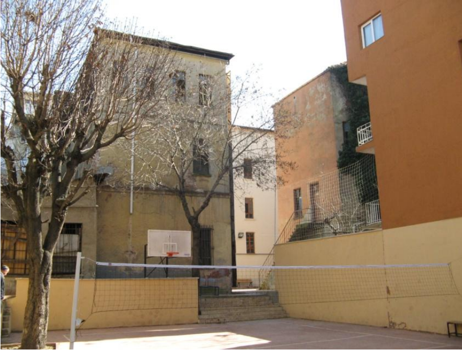
Şekil 3.36: St. Euphemie Ortaokulu okul ve şapel binalarının avludan görünümü.
