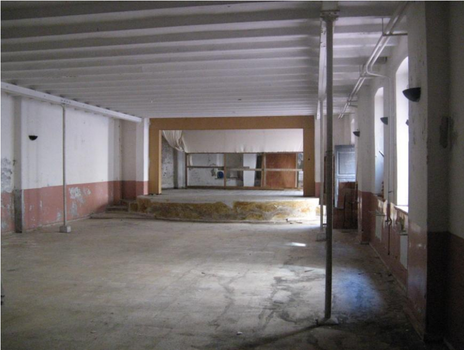
Şekil 3.40: B-01 Mekânı Toplantı salonu, sahne bölümüne bakış.
