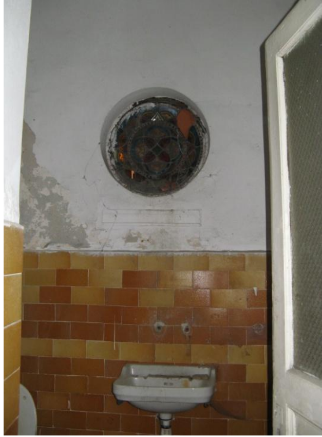
Şekil 3.81: Z-04 Tuvalet Mekânından Z-01 Giriş mekânına bakan gül pencere.
