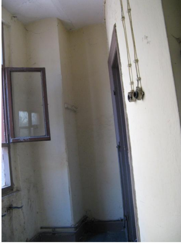
Şekil 3.87: Z-06 mekânını apsise bağlayan kapı.
