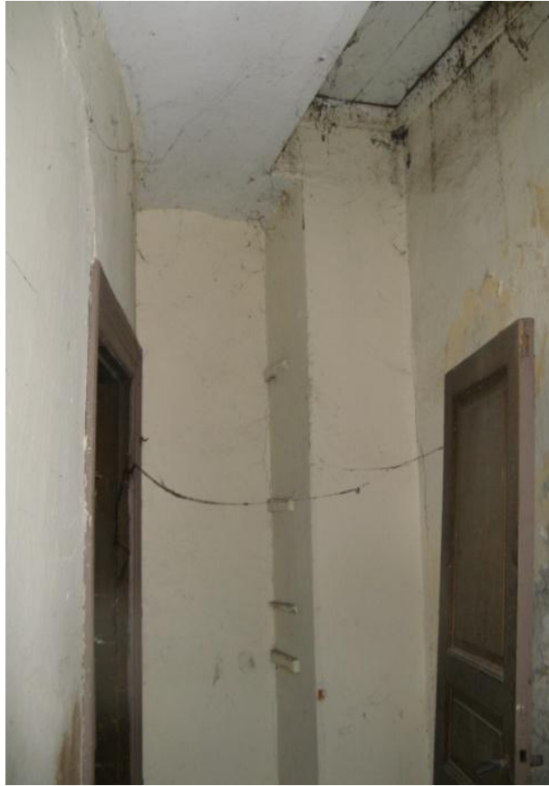
Şekil 3.118: Z-05 Mekânı tavanında volta döşemenin bittiği nokta.
