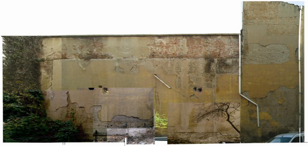
Şekil 3.110: Şapelin batı cephesi.
