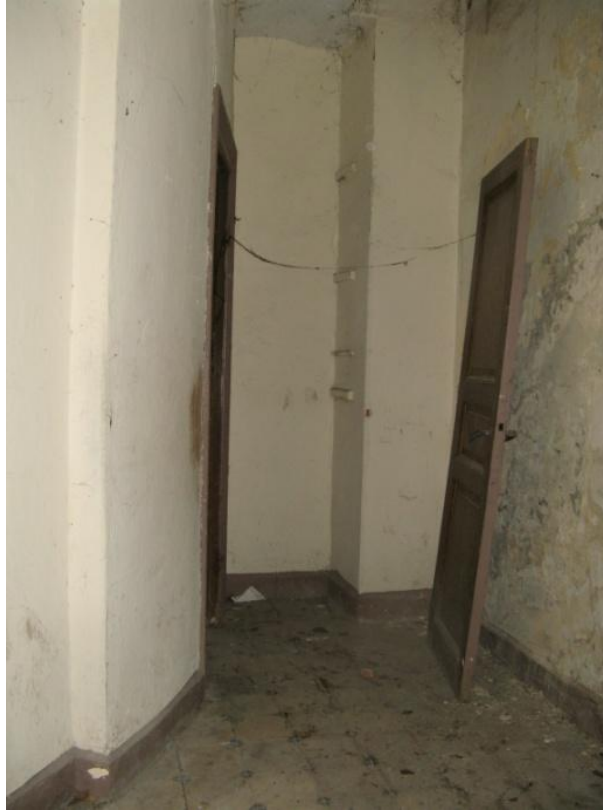
Şekil 3.84: Z-05 Mekânını apsise bağlayan kapı.
