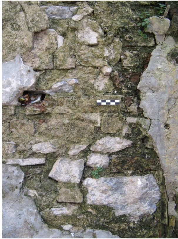
Şekil 3.112: Bodrum katta kullanılan taş-tuğla almasıık duvar örgüsü.
