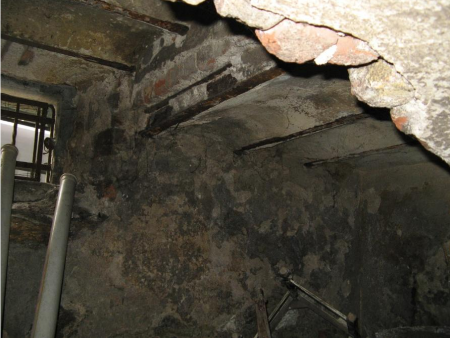
Şekil 3.51: B-03 Mekânı tavanındaki kademelenme.
