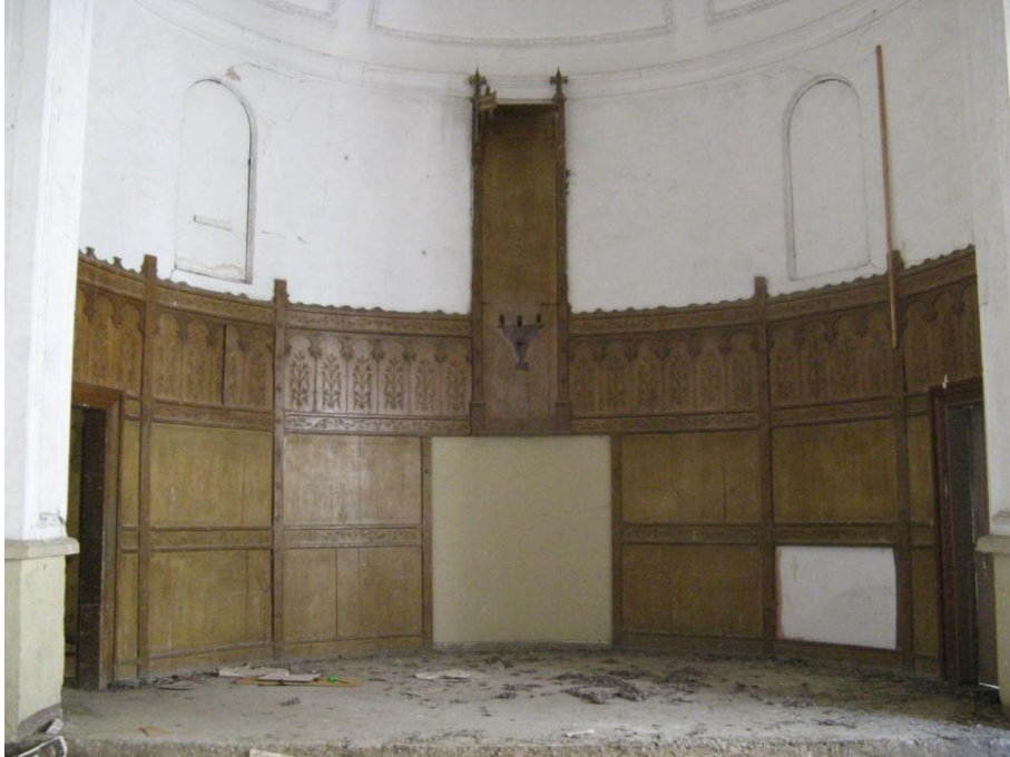
Şekil 3.74: Apsisi içeriden çeviren ahşap kaplama.
