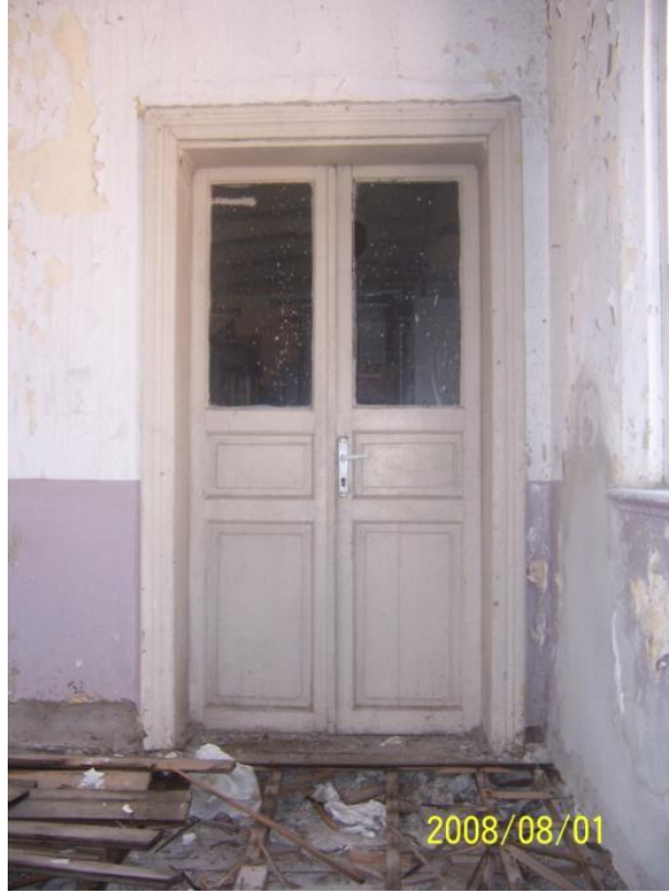
Şekil 3.93: 2-01 Mekânı giriş kapısı (İTÜ Arşivi, 2008).
