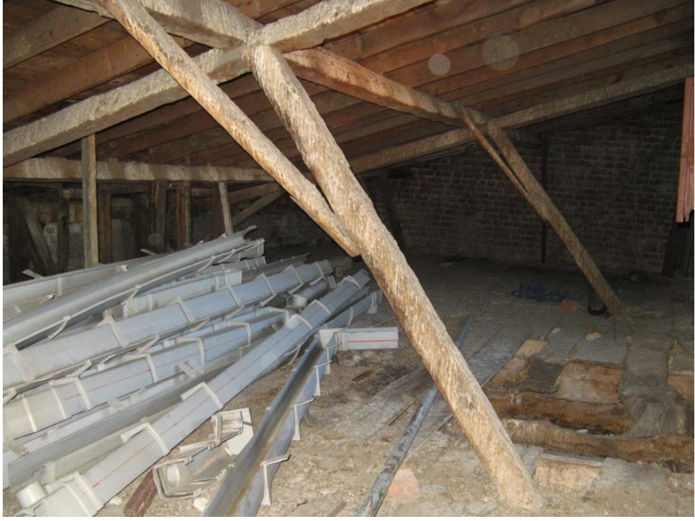
Şekil 3.125: Manastır binası güneybatı bölümü çatı strüktürü.
