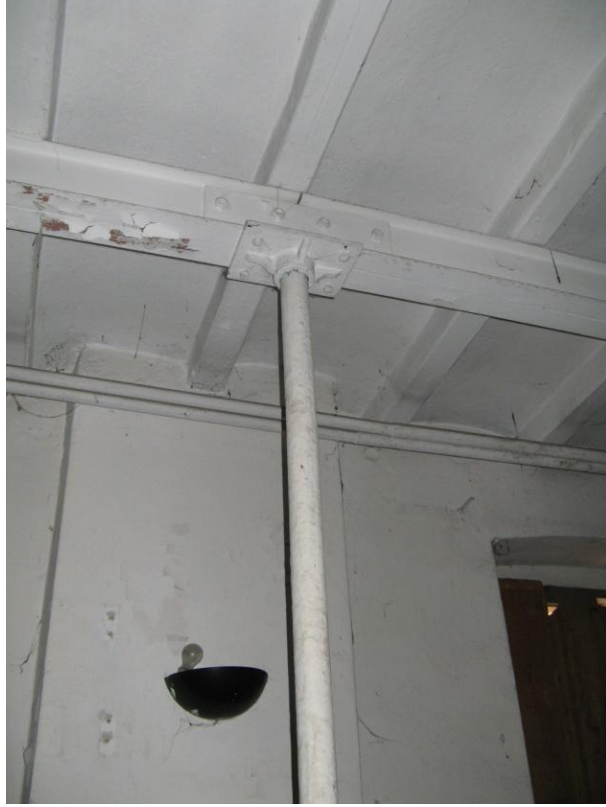
Şekil 3.117: B-01 Toplantı Salonunda kullanılan takviye kirişleri.
