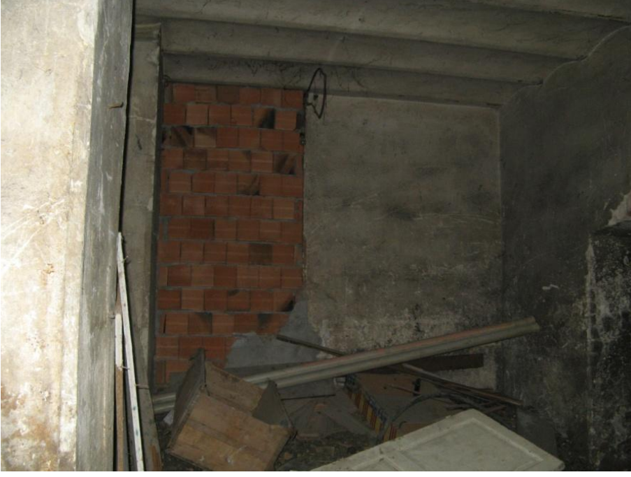
Şekil 3.47: B-02 Mekânı, doğu duvarındaki kapatılmış geçite bakış.
