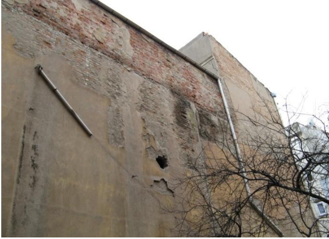
Şekil 3.115: Şapelin duvarlarında kullanılan iki farklı tür tuğla.
