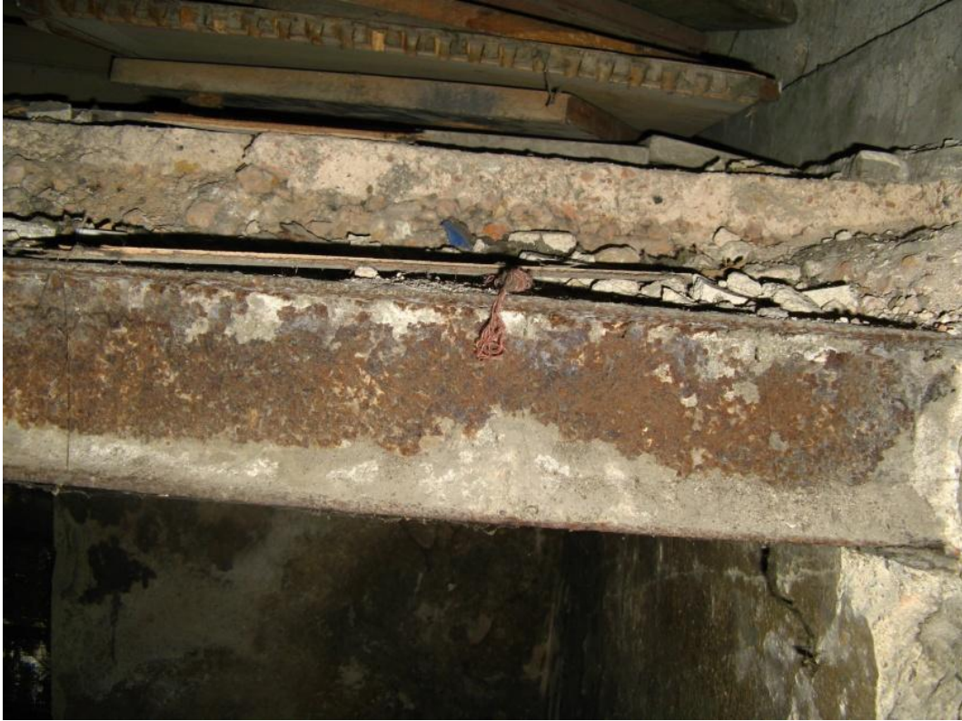
Şekil 3.120: B-02 Mekânı tavanında kullanılan volta döşeme detayı.
