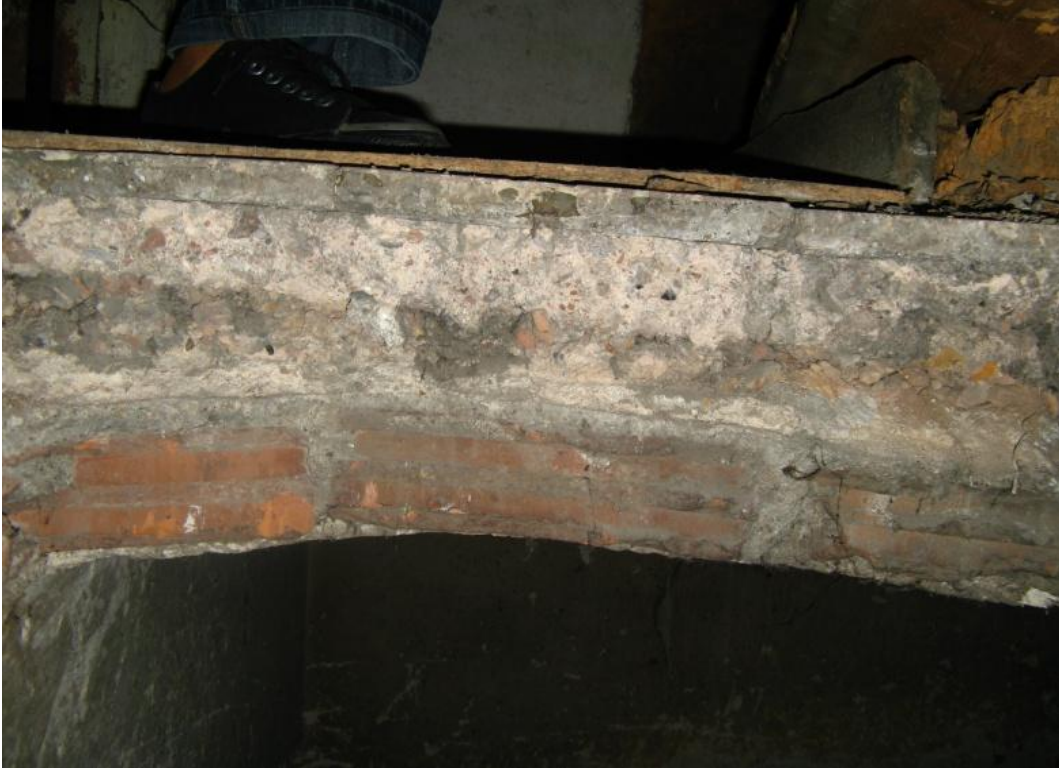
Şekil 3.119: B-02 Mekânı tavanında kullanılan volta döşeme detayı.
