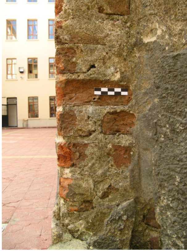
Şekil 3.113: Şapel beden duvarlarında kullanılan dolu tuğla çeşidi.
