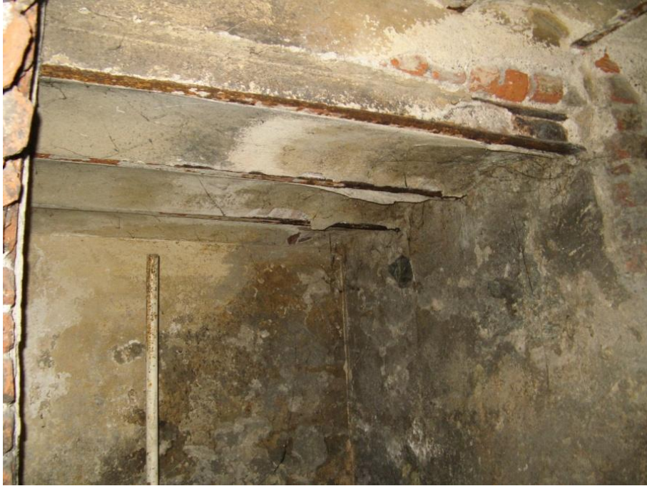
Şekil 3.50: B-03 Mekânı tavanındaki kademelenme.
