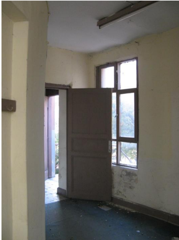
Şekil 3.88: Z-06 Mekânı içinden giriş kapısına bakış.
