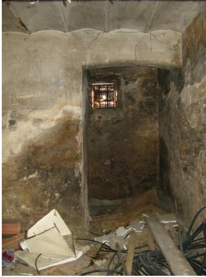
Şekil 3.45: B-02 Mekânı, güneye bakış.
