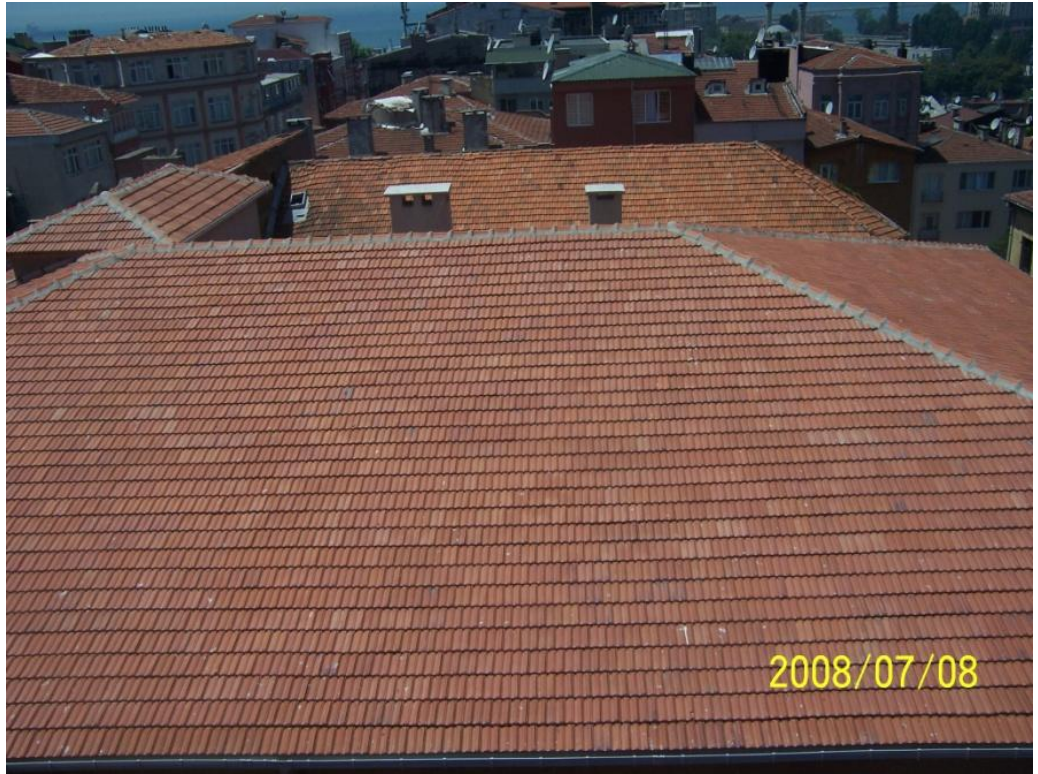
Şekil 3.122: Manastır binası ve şapel çatıları (İTÜ Arşivi, 2008).
