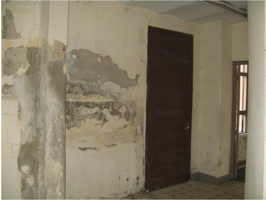
Şekil 3.86: Şapelin Z-05 Mekânından avluya açılan girişi.
