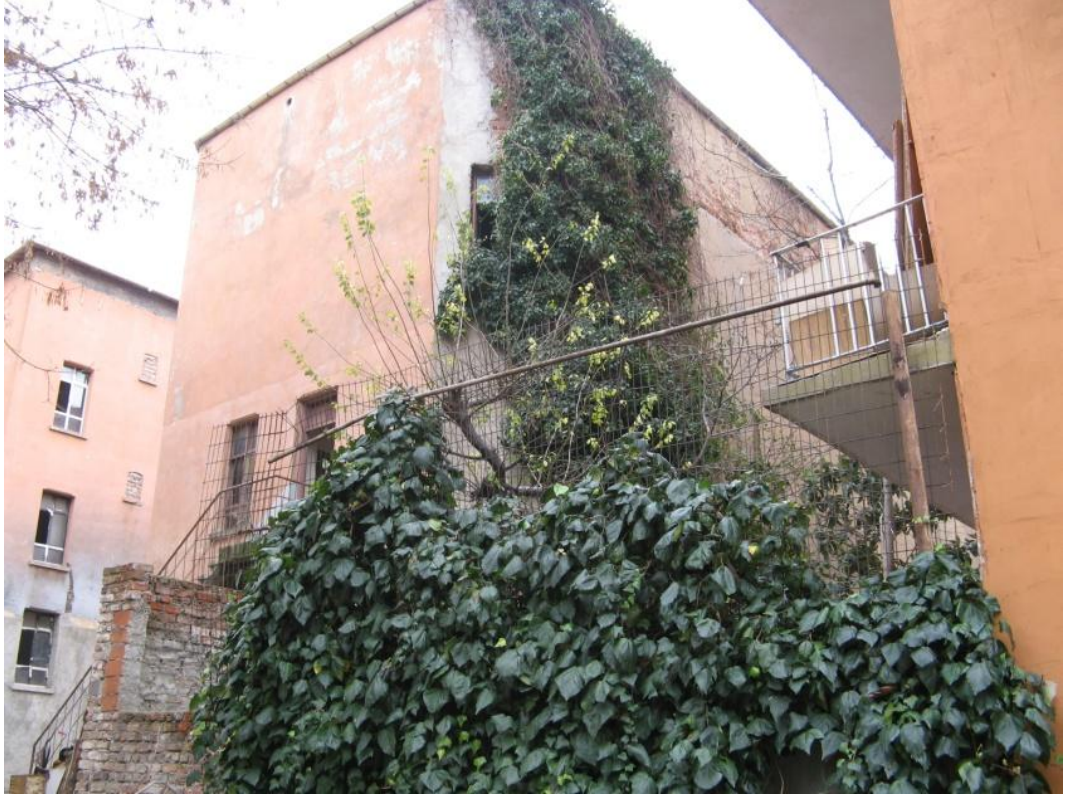
Şekil 3.101: Şapelin kuzey cephesi.
