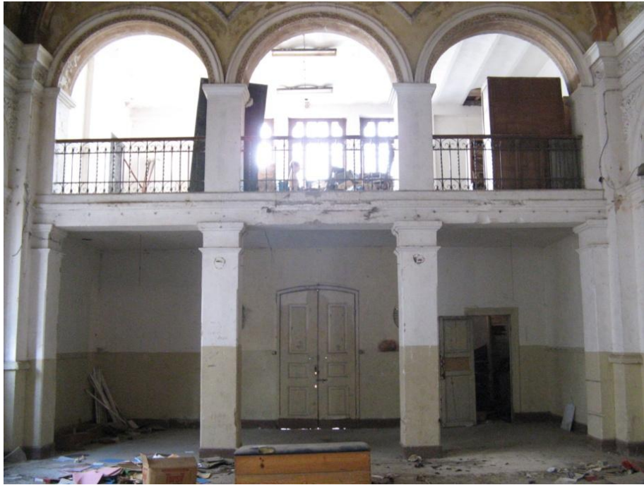
Şekil 3.66: Z-02 Sahin Mekânının Narteks bölümü.
