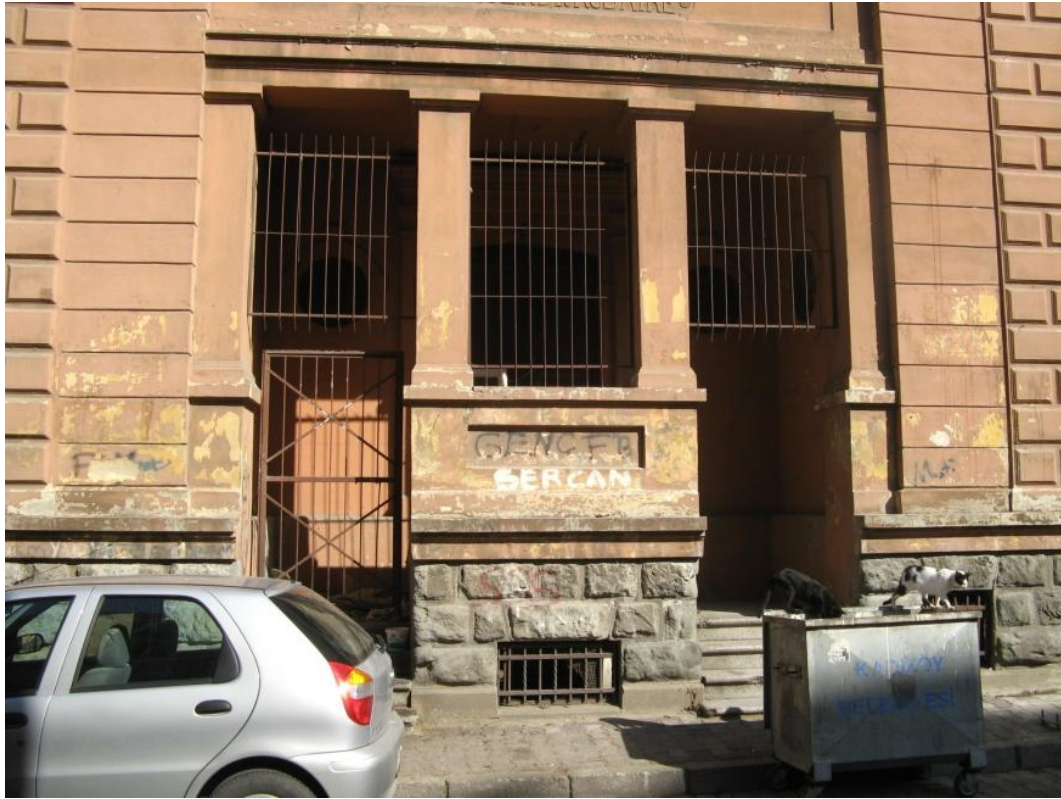
Şekil 3.100: Şapelin İskele Sokağından ana girişi.
