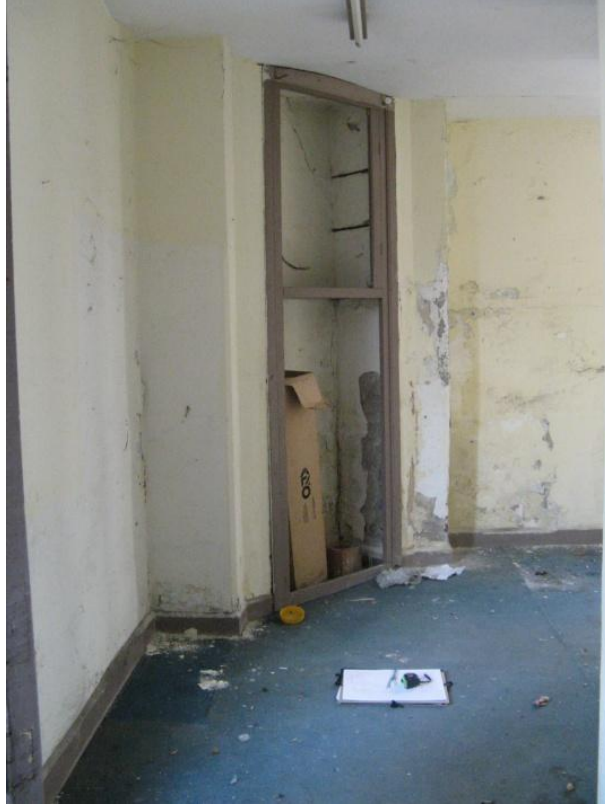
Şekil 3.89: Z-06 Mekânı kuzeybatı köşesinde yer alan niş.
