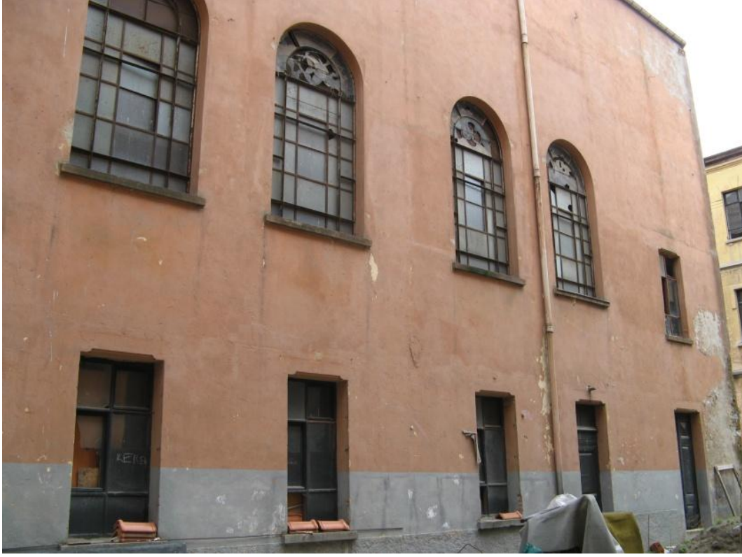
Şekil 3.107: Z-02 Sahın mekânına ve B-01 Toplantı Salonuna bakan pencereler.
