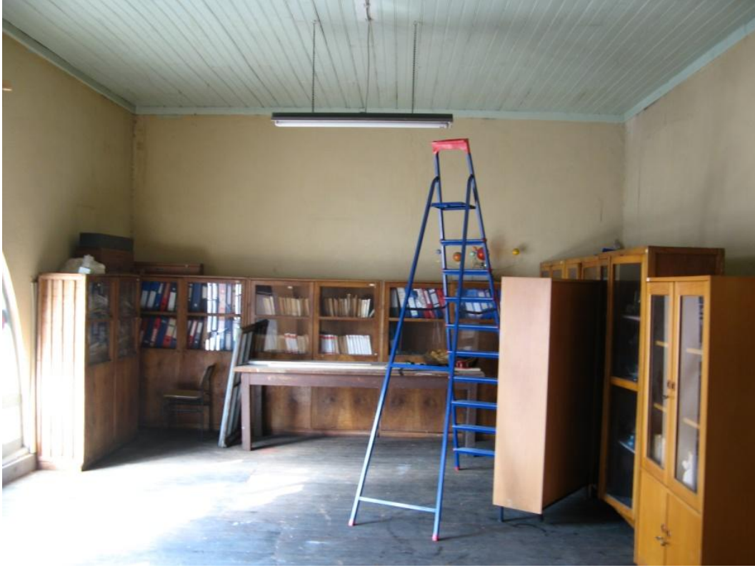
Şekil 3.95: 2-01 Mekânı, batıya bakış.
