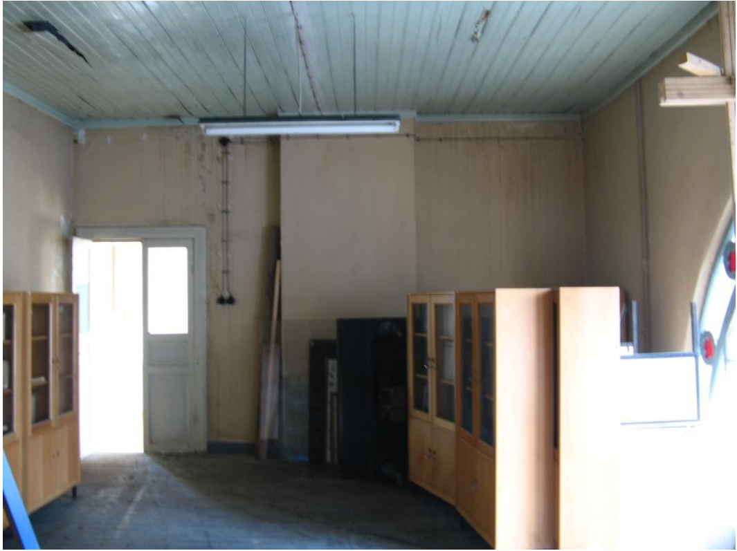
Şekil 3.94: 2-01 Mekânı, manastır binasına açılan giriş.
