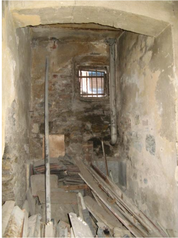
Şekil 3.54: B-04 mekânı güney duvarı üzerindeki mazgal pencere.
