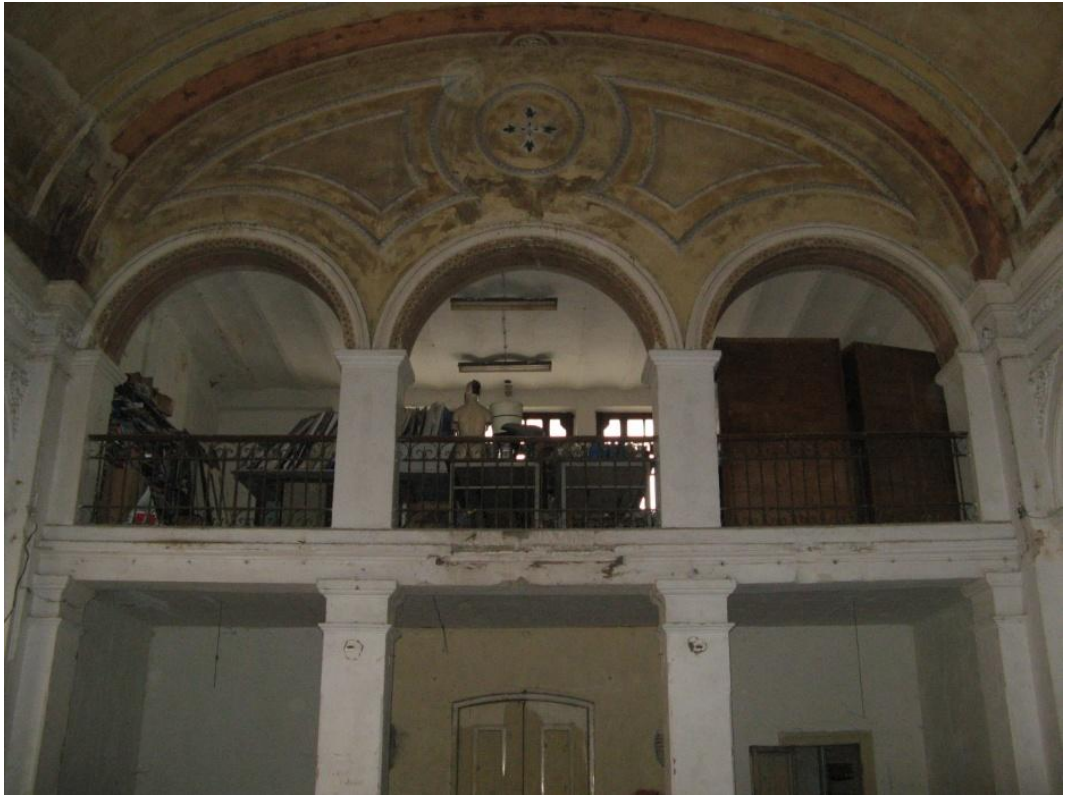
Şekil 3.90: Sahından +3.80 kotunda yer alan 1-01 Mekânına bakış.
