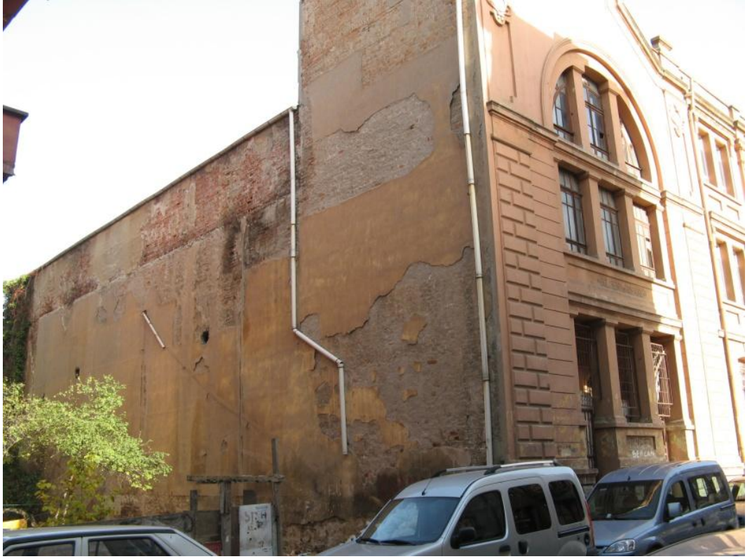
Şekil 3.109: Şapelin batı cephesi.
