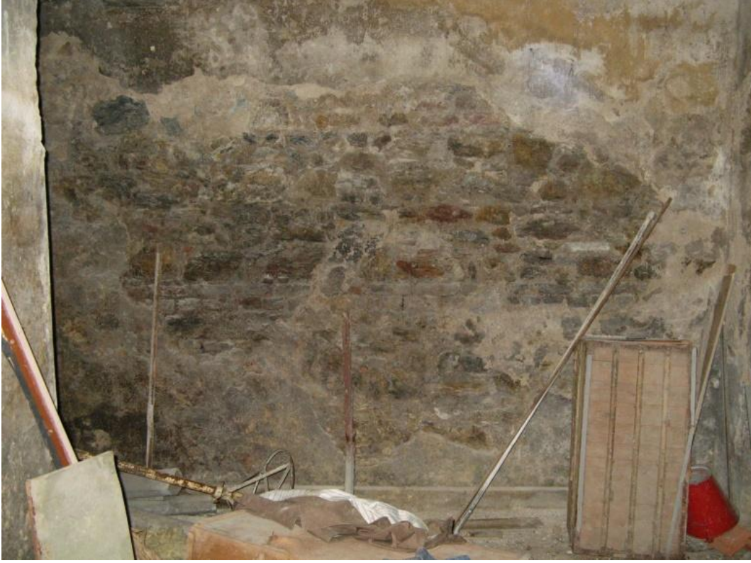
Şekil 3.111: B-02 Mekânı duvarlarındaki taş-tuğla almasıık örgü.
