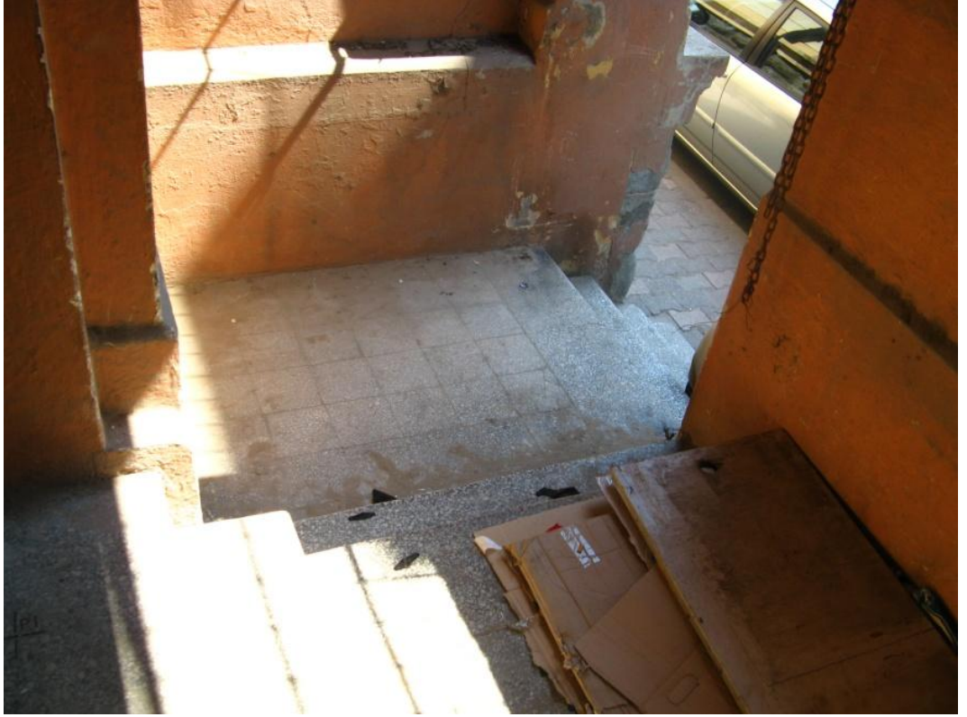
Şekil 3.61: Z-01 Giriş Mekânında yer alan dökme mozaik basamaklar.
