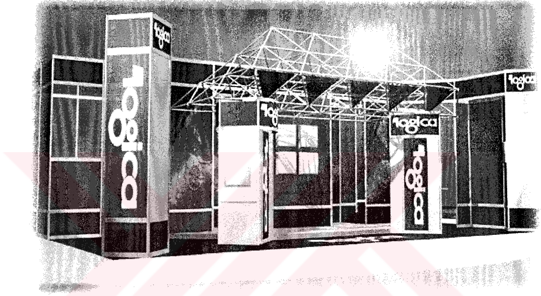
Şekil [137] Çubuk ve levha sistemlerinin bir arada kullanıldığı bir bileşik sistem. [50]
