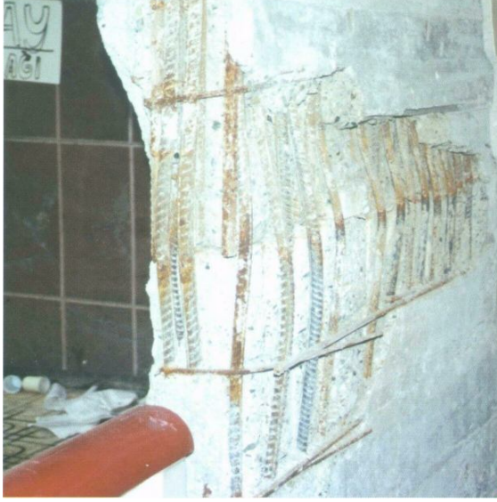
Şekil 19.15 Perde uç bölgelerinde görülen donatı düzenleme hataları
