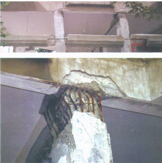
Şekil 19.3 Kolonlarda Basınç Hasarı
