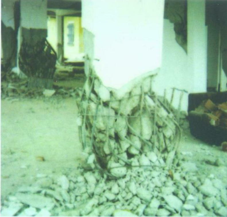
Şekil 19.4 Sarmal bölgede yetersiz etriye sonucu meydana gelen hasar
