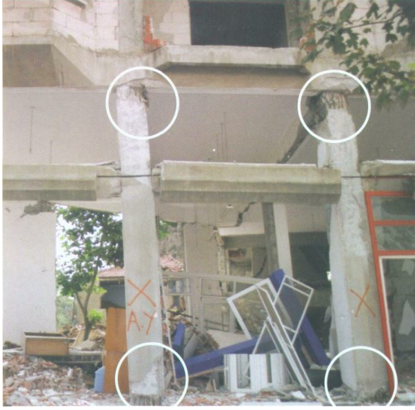
Şekil 19.9 Kolon kiriş birleşim detayı hatası
