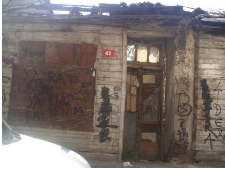
Şekil 7.42: Yapı 450/12-Ahmet Rasim Sokağı, kullanılmayan 42 kapı numaralı yapı.
