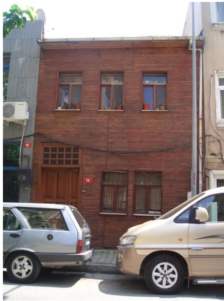
Şekil 7.52 : Yapı 450/26- Ahmet Rasim Sokağı,tadilat gören 14 kapı numaralı yapı.
