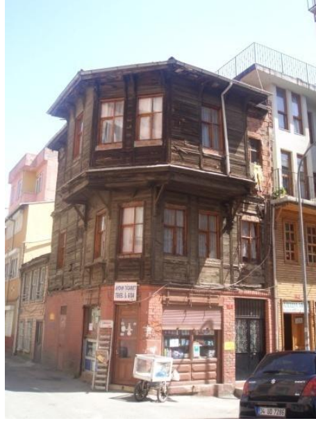
Şekil 7.65 : Yapı 459/19-Necip Usta Çıkmazı, 1 kapı numaralı yapı.
