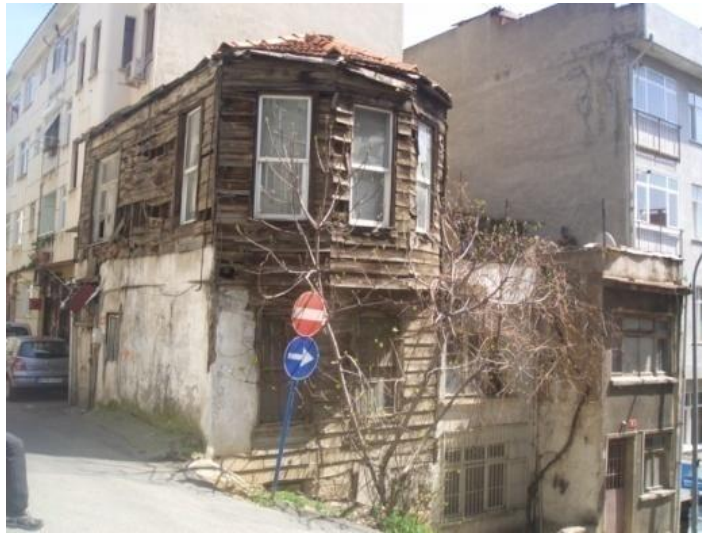
Şekil 7.69 : Yapı 468/21-Nazif Bey Sokağı, kullanılmayan 26 kapı numaralı yapı.
