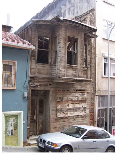
Şekil 7.89 : Yapı 491/10-Mehtap Sokağı, kullanılmayan 12 kapı numaralı yapı.
