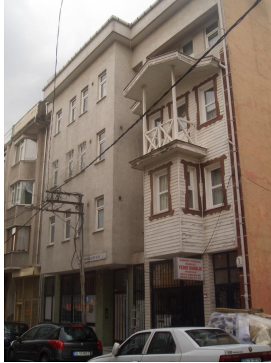
Şekil 7.34 : Yapı 449/42-Andelip Esat Sokağı,yeniden yapılan 12 kapı numaralı yapı.
