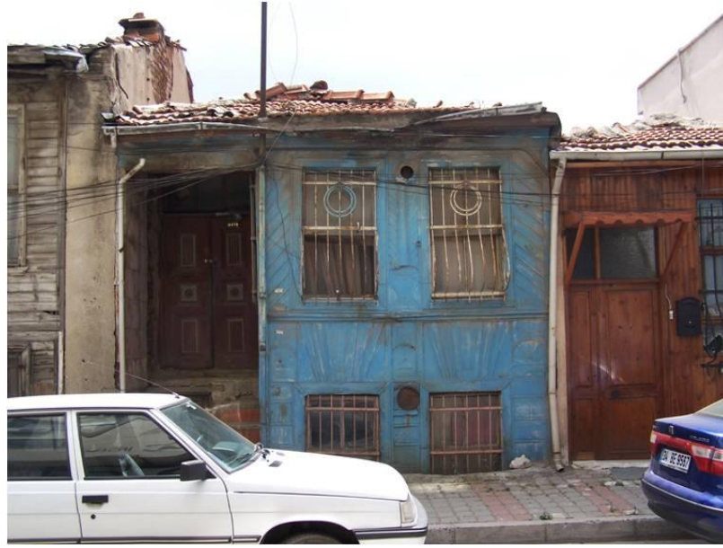
Şekil 7.46: Yapı 450/17-Ahmet Rasim Sokağı, kullanılmayan 34 kapı numaralı yapı.
