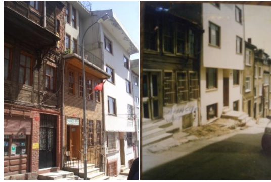
Şekil 5.19 : Hacı Recai Sokağı, 18.parselde bulunan yapının restorasyonu.
