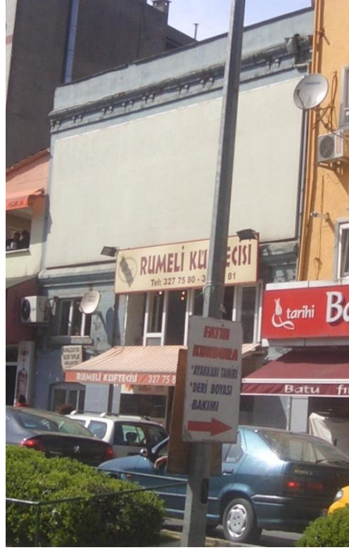
Şekil 7.86 : Yapı 491/3-Sarayardı Caddesi,tadilat gören 71 kapı numaralı yapı.
