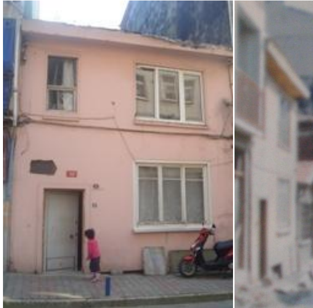
Şekil 7.18 : Yapı 448/11-Andelip Esat Sokağı, tadilat gören 13 kapı numaralı yapı.
