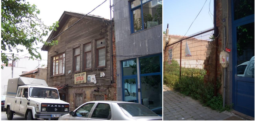
Şekil 7.51 : Yapı 450/24-Ahmet Rasim Sokağı, yok olan 20(18) kapı numaralı yapı.
