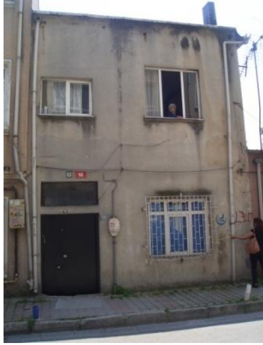
Şekil 7.53 : Yapı 450/28 - Ahmet Rasim Sokağı,tadilat gören 10 kapı numaralı yapı.
