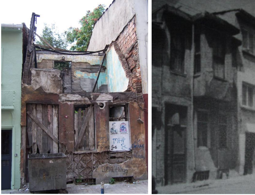
Şekil 7.26 : Yapı 448/31-Ali Ruhi Sokağı, yok olan18 kapı numaralı yapı.
