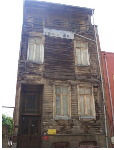
Şekil 7.54 : Yapı 450/31-Ahmet Rasim Sokağı,4 kapı numaralı yapı.
