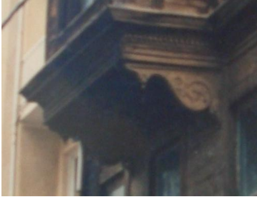
Şekil 4.48 : Nabizade Sokağı, 45.parselde yeniden yapılan yapının çıkma payandaları.
