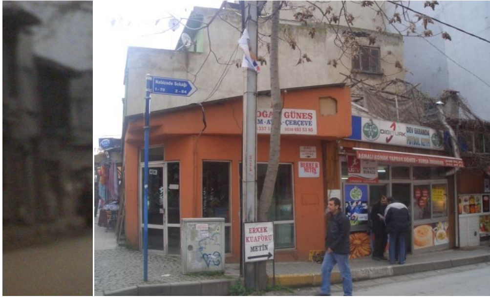
Şekil 7.27 : Yapı 449/25-Kurbağalıdere Caddesi, tadilat gören 16 kapı numaralı yapı.
