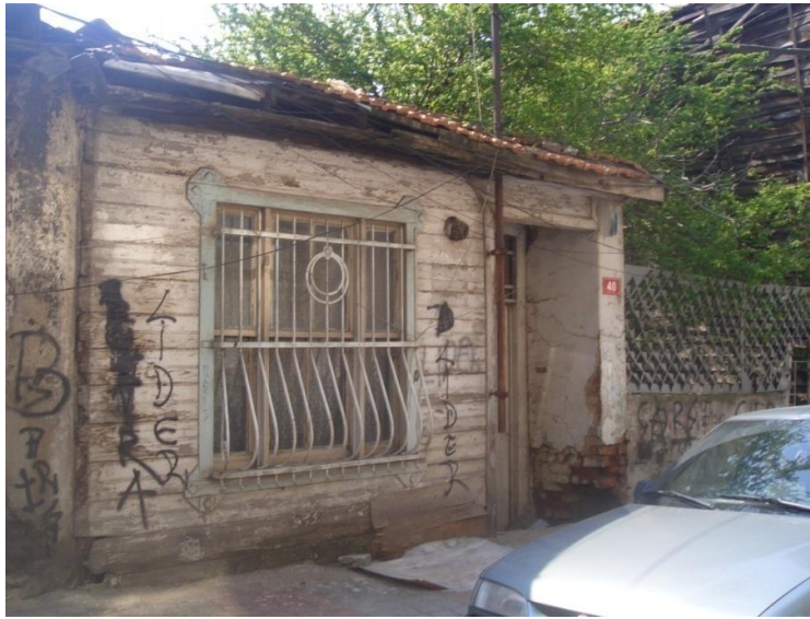
Şekil 7.43: Yapı 450/13-Ahmet Rasim Sokağı, kullanılmayan 40 kapı numaralı yapı.
