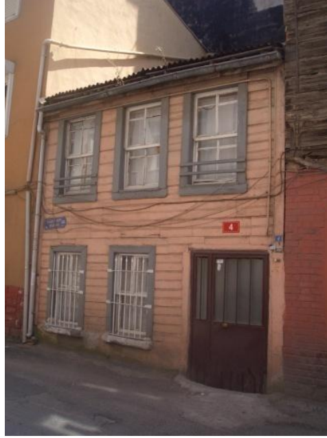
Şekil 7.66 : Yapı 459/29-Nazif Bey Sokağı, 4 kapı numaralı yapı.
