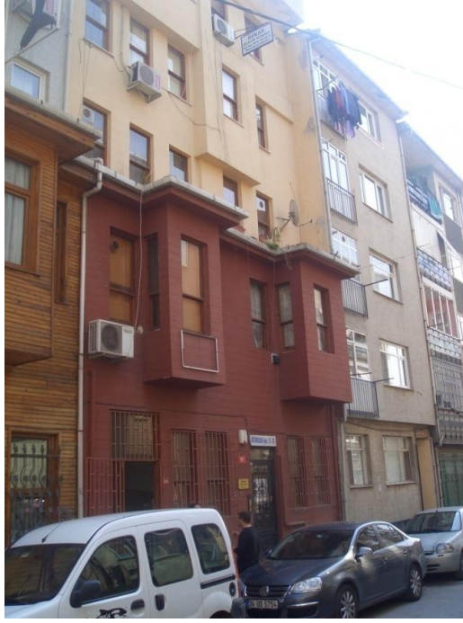
Şekil 7.13: Yapı 447/45-Ali Ferruh Sokağı, yeniden yapılan 17 kapı numaralı yapılar.
