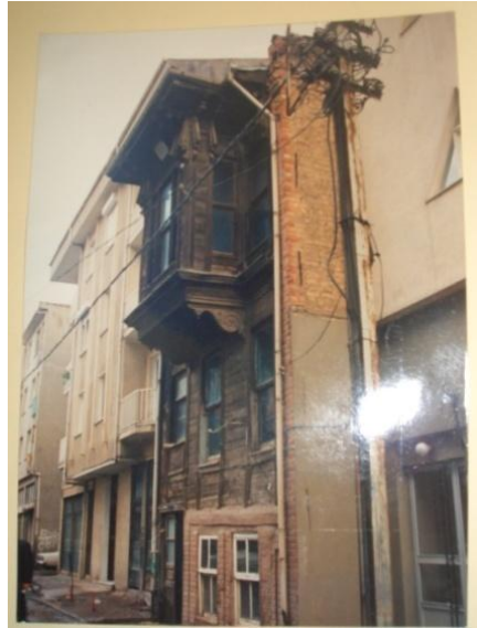
Şekil 7.60 : Yapı 450/45-Nabizade Sokağı, 47 kapı numaralı yapı.
