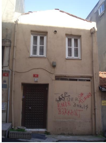
Şekil 7.88 : Yapı 491/8-Mehtap Sokağı, tadilat gören 8 kapı numaralı yapı.
