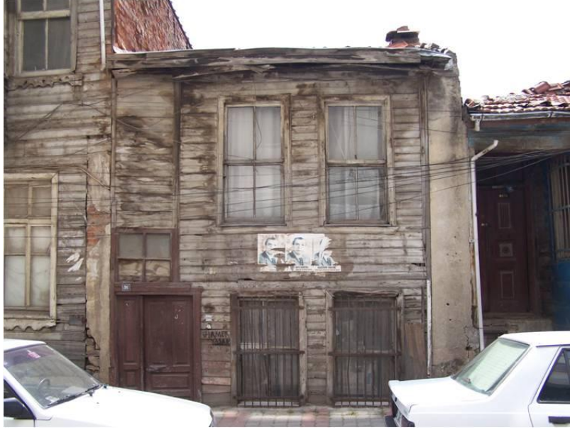
Şekil 7.45: Yapı 450/16-Ahmet Rasim Sokağı, kullanılmayan 36 kapı numaralı yapı.
