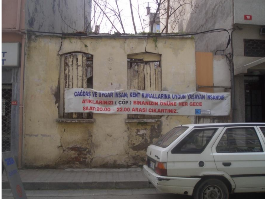
Şekil 7.63 : Yapı 451/53-Nabizade Sokağı, kullanılmayan 20 kapı numaralı yapı.
