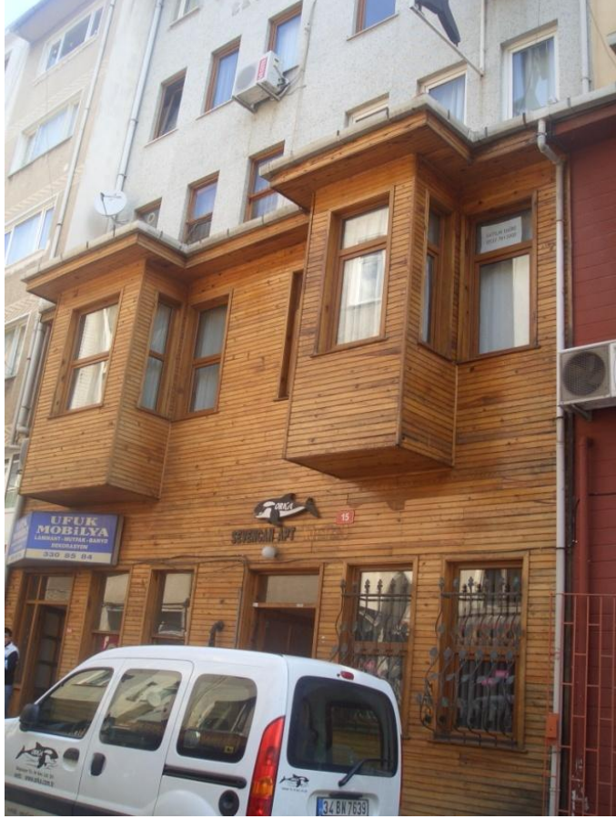
Şekil 7.12: Yapı 447/44-Ali Ferruh Sokağı, yeniden yapılan 15 kapı numaralı yapılar.
