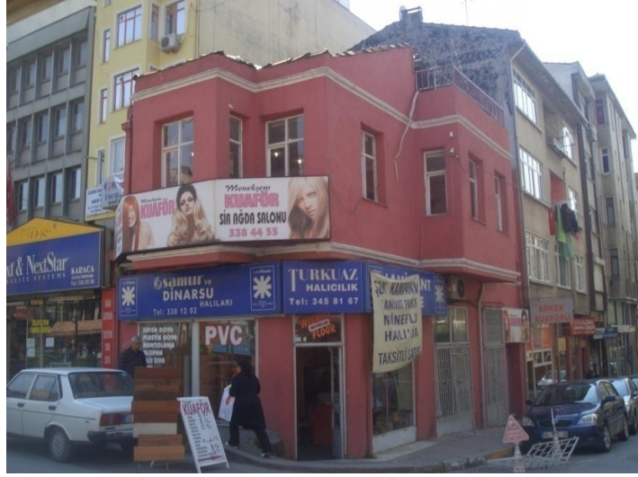
Şekil 7.9 : Yapı 447/19-Ali Ferruh Sokağı, 1 kapı numaralı yapı.
