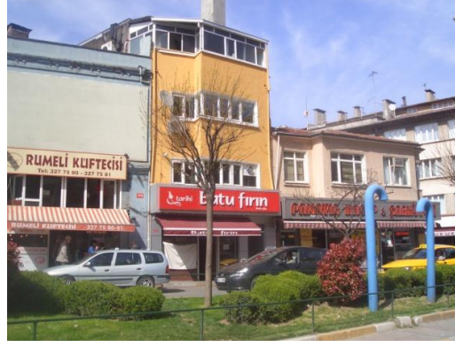
Şekil 5.16 : Sarayardı Caddesi'nde bulunan kagir yapılar.
