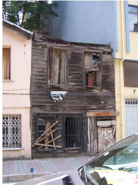
Şekil 7.14 : Yapı 448/6 - Andelip Esat Sokağı, yok olan 21 kapı numaralı yapı.
