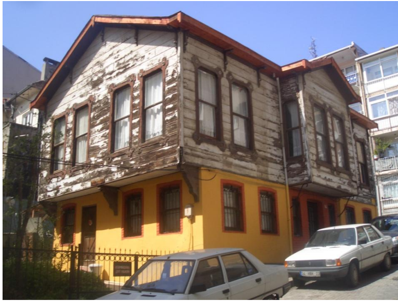
Şekil 4.27 : Faik Bey Sokağı, 50.parselde yeniden yapılan yapı.
