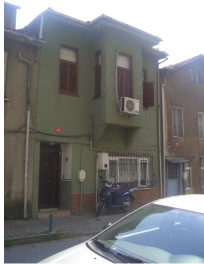
Şekil 7.55 : Yapı 450/34- Andelip Esat Sokağı,tadilat gören 31 kapı numaralı yapı.
