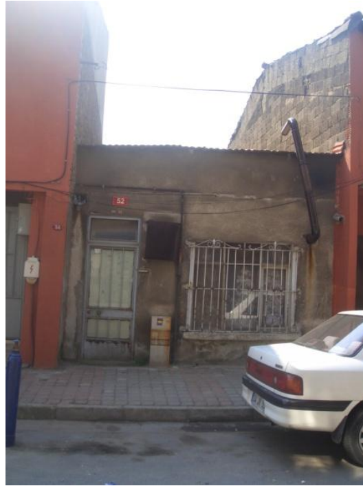
Şekil 7.37 : Yapı 450/7-Ahmet Rasim Sokağı, kullanılmayan 52 kapı numaralı yapı.
