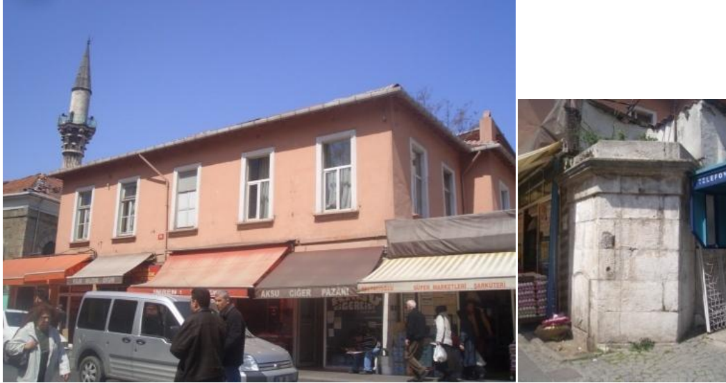
Şekil 7.72 : Yapı 469/60-Kurbağalıdere Caddesi, Sıbyan Mektebi ve Çeşmesi.
