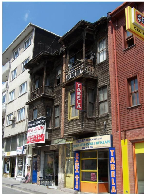
Şekil 7.97 : Yapı 1432/59-Sarayardı Caddesi, 43 kapı numaralı yapı.
