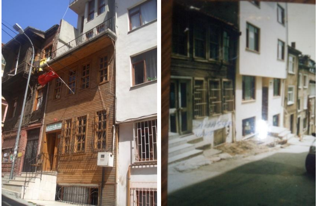
Şekil 7.64 : Yapı 459/18-Necip Usta Çıkmağı, 3 kapı numaralı yapı.
