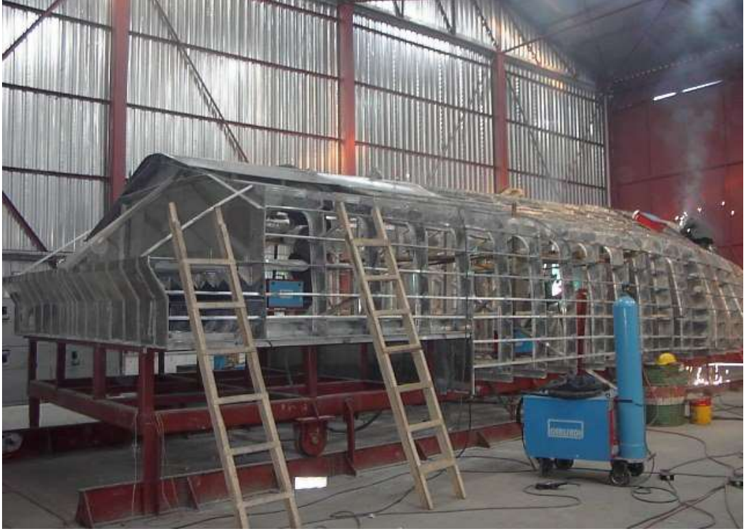
Şekil 4 1 : Mıdenci Gemi Sanayi nde Yapıl mış İnşaat halindeki A l ü m i n y u m T e k n e
