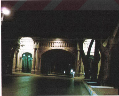
Şekil 6.13 Geçit aydınlatması örneği (Ortaköy, İstanbul-2003)
