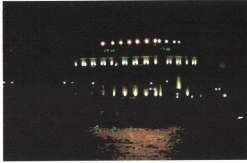
Şekil 6.12 Bina dış cephesi genel aydınlatması örneği ( İTO Binası, Eminönü, İstanbul-2003)
