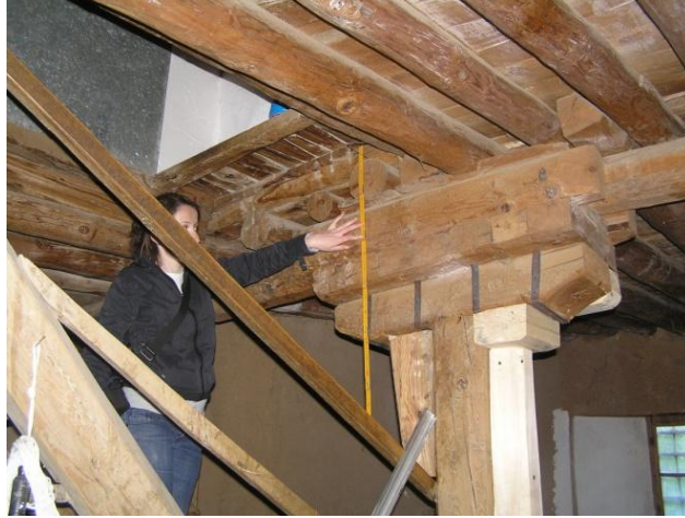
Şekil 4.28 : Taşıyıcı sistem detayı, Mahmut Efeoğlu Evi (Kolektif, 2009).
