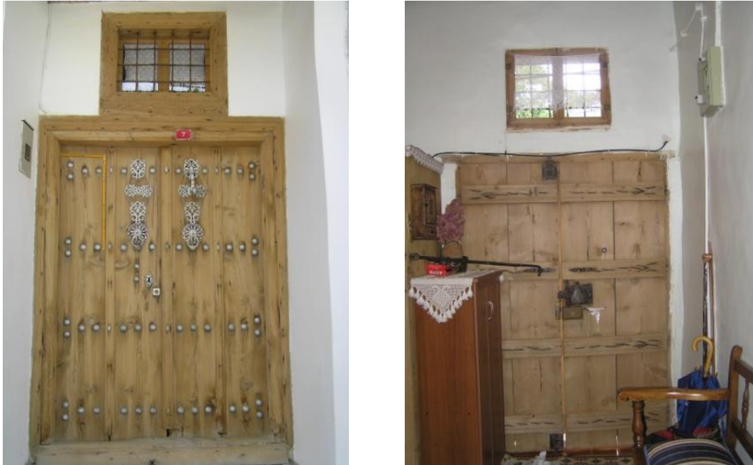
Şekil 4.40 : Giriş kapısı iç-dış görünüşü, Mustafa Haznedar Evi (Kolektif, 2009).
