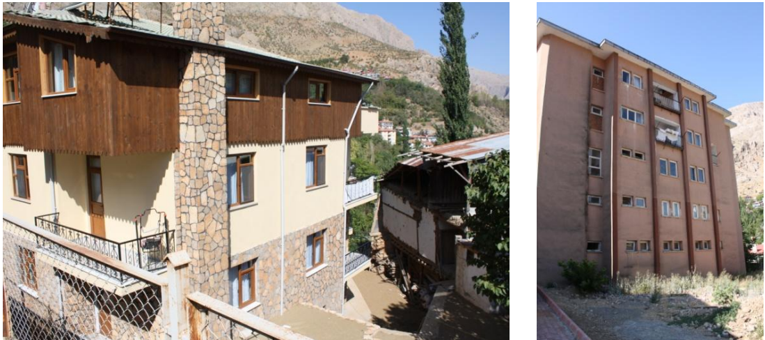
Şekil 5.15: Genççağa Sokak’taki betonarme binalar (Kolektif, 2009).
