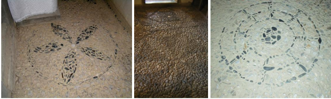
Şekil 4.46 : Çiçek ve çarkifelek desenli rıhtım döşemeler (KAG, 2002).
