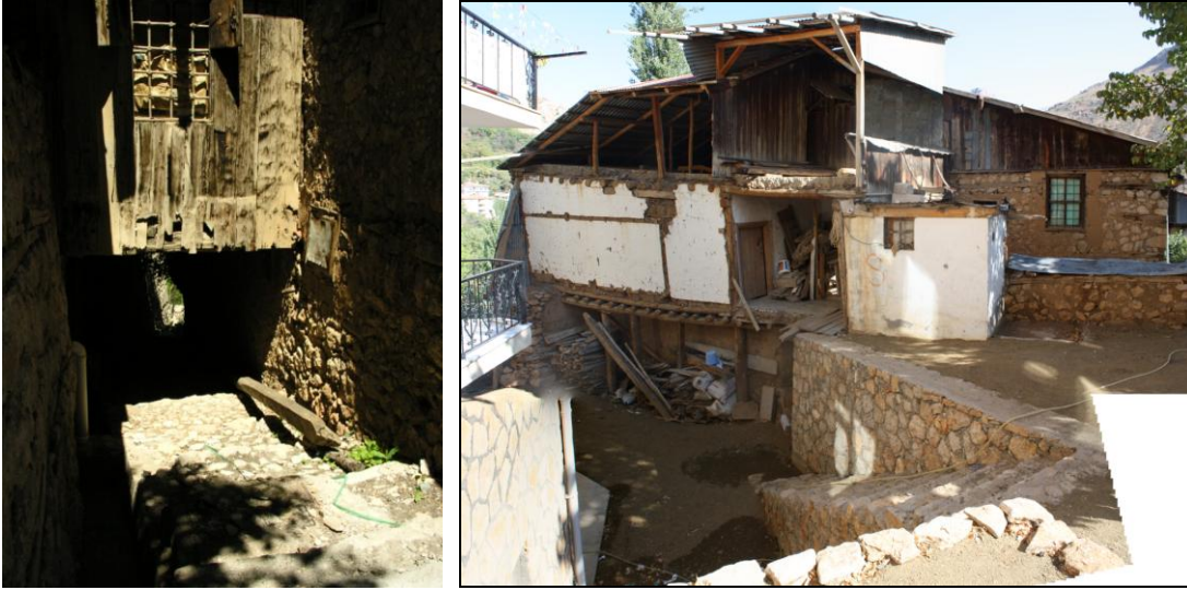
Şekil 5.16: “Yeni”nin yapılabilmesi için kısmen yıkılmış olan “torta”
