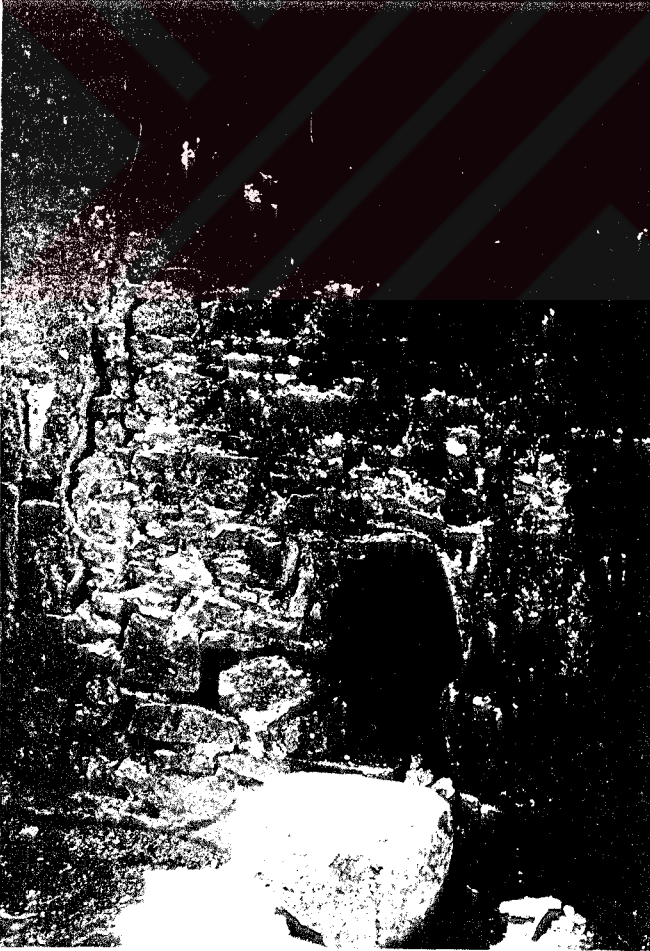
Foto C.81- Avludan M15 hücresinde sonradan örülerek kapatılmış P19 penceresine bakış
