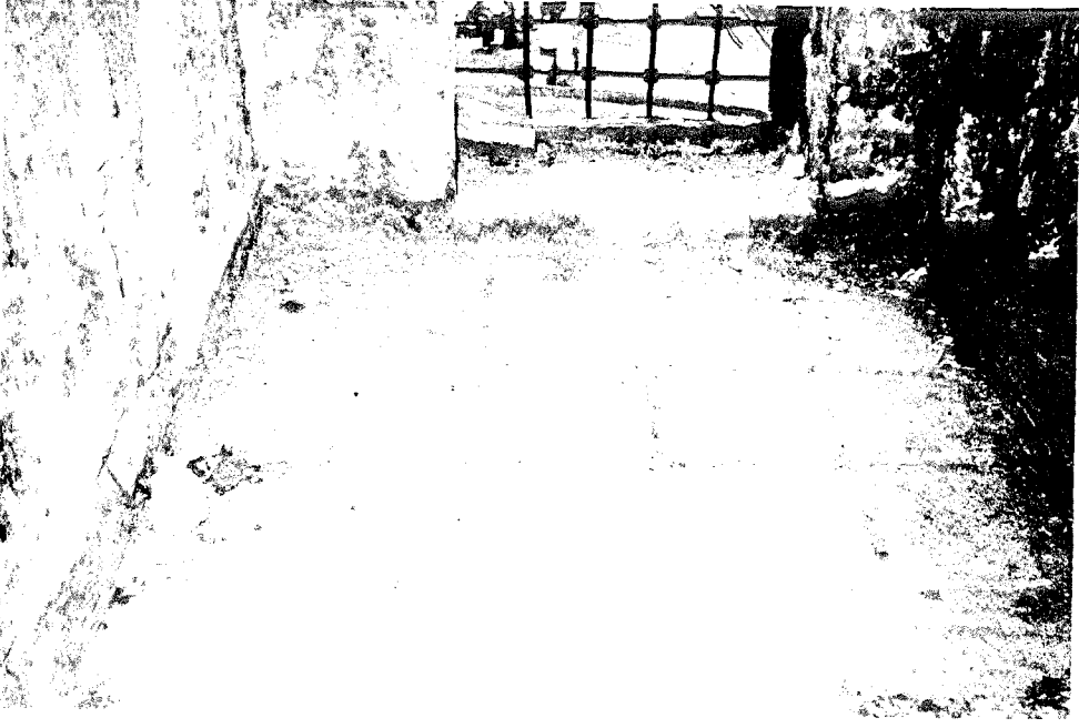
Foto C.100-M17 mekanındaki 35 X 35 cm boyutlarındaki taşlardan oluşturulmuş döşeme
