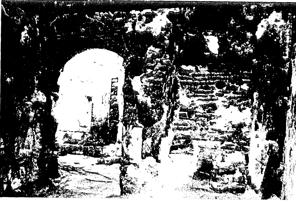
Foto C.80- M15 hücresi içinden K9 kapısı ile sonradan örülerek kapatılmış P19 penceresine bakış
