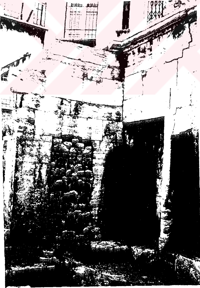
Foto C.73- Üst katta sonradan örülerek kapatılmış pencere (P16) ve kapı (K12)
