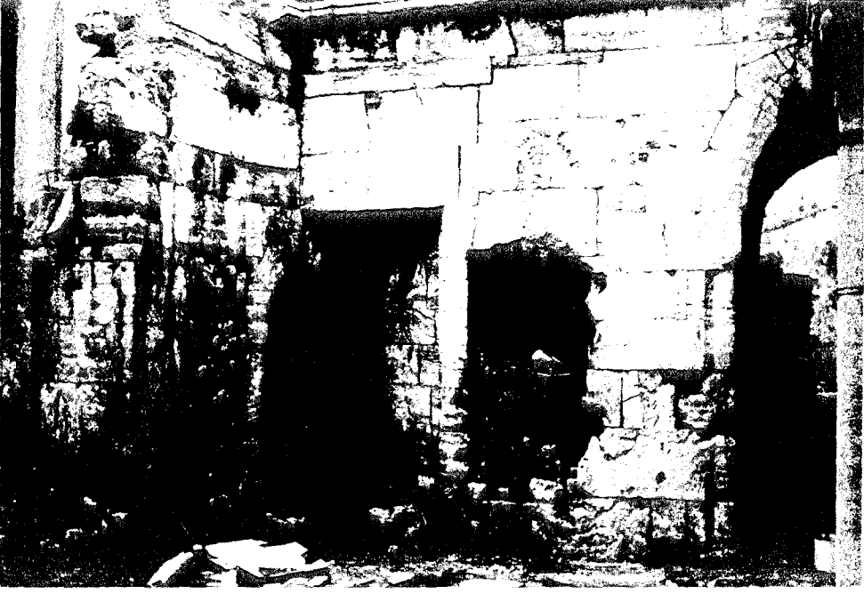
Foto C.72- Avludan M12 hücresi kuzeydoğu duvarına bakış
