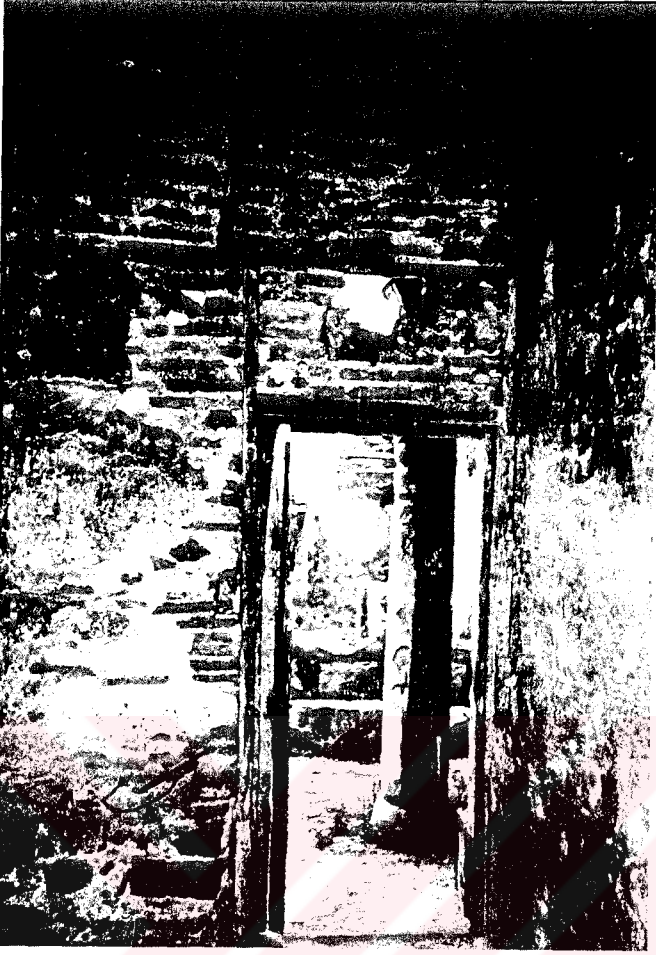
Foto C.94- M17 mekanında sonradan örölmüş kuzeybatı duvarı
