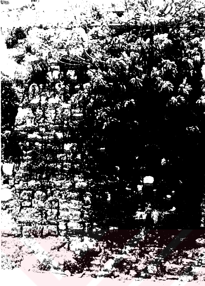
Foto C.13-Yol açma çalışmaları esnasında kesilen kuzeydoğu cephesi üzerinde sonradan örülerek kapatılan bölüm
