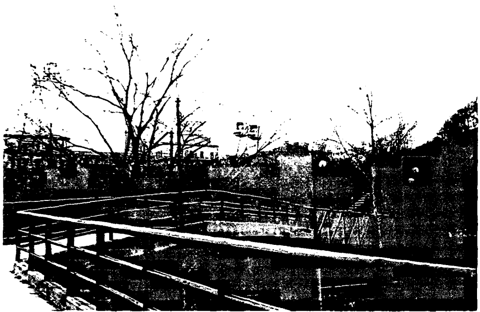
Şekil C. '24 Köprü' nün farklı açıdan görünüşü
