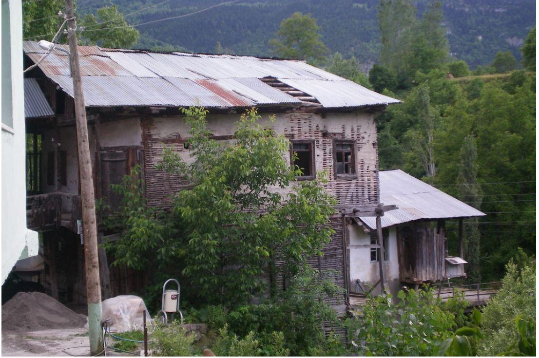
Şekil B.43 : 181 envanter nolu yapının kuzeydoğu cephesi.
