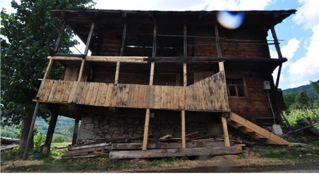
Şekil B.113 : 79 envanter nolu konutun giriş cephesi.
