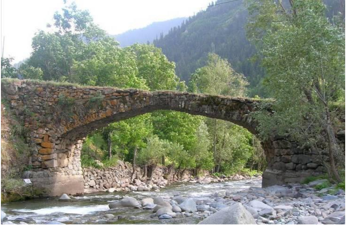
Şekil 4.3 : Tarihi taş köprüden bir görünüm 17 .
