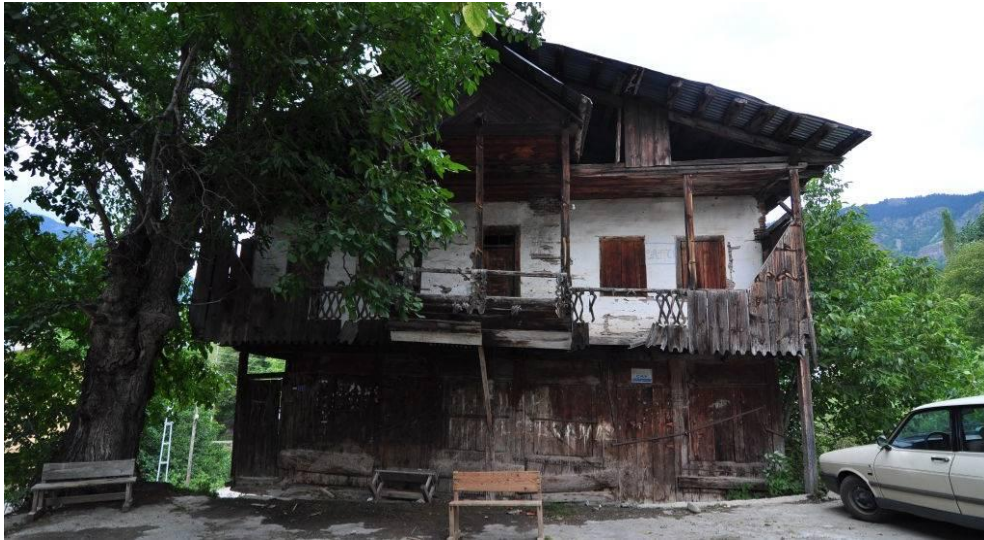
Şekil 4.12 : 181 envanter nolu yapının güneydoğu cephesi.
