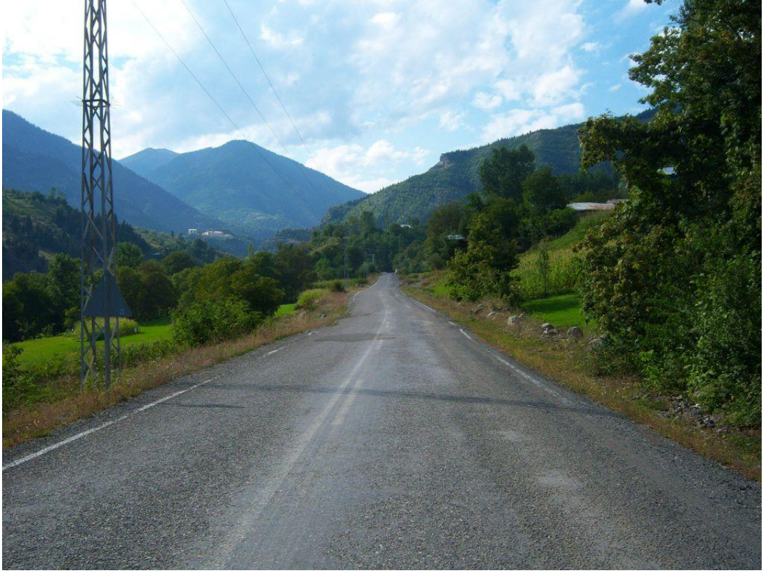
Şekil B.19 : 1994-1997 yılları arasında yapılan Meydancık - Şavşat karayolu.
