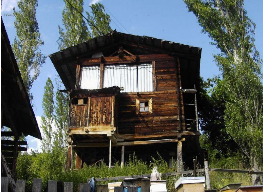
Şekil B.120 : 279 envanter nolu konutun ön cephesi.
