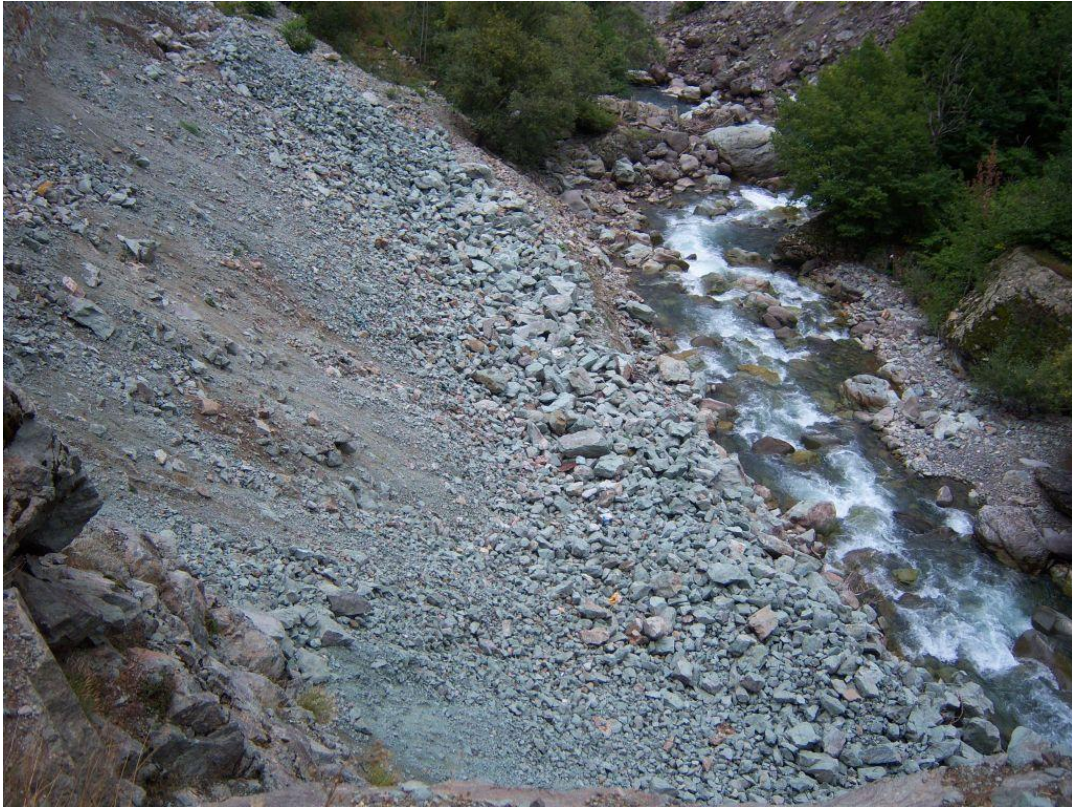
Şekil D.2 : Dere yataklarına dökülen hafriyat.
