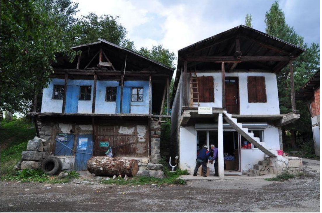
Şekil B.64 : 84 ve 85 envanter nolu yapıların güney cephesi.
