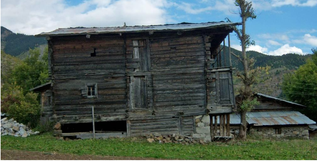
Şekil B.114 : 79 envanter nolu konutun yan cephesi .
