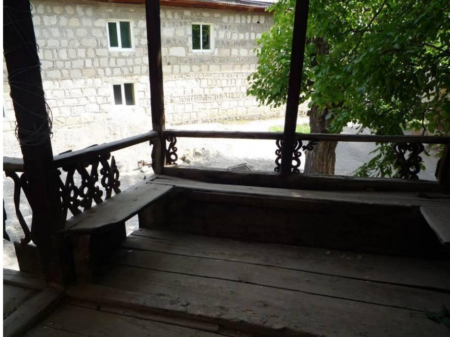
Şekil B.48 : 181 envanter nolu yapının ön cephesinde bulunan köşk.
