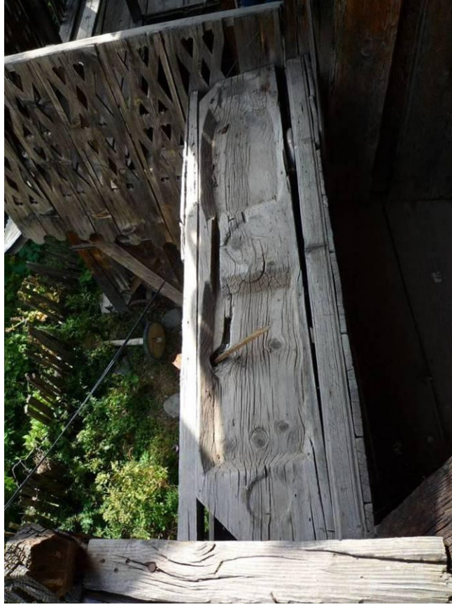
Şekil B.59 : 245 envanter nolu yapının dandrabasında bulunan ahşap lavabo.
