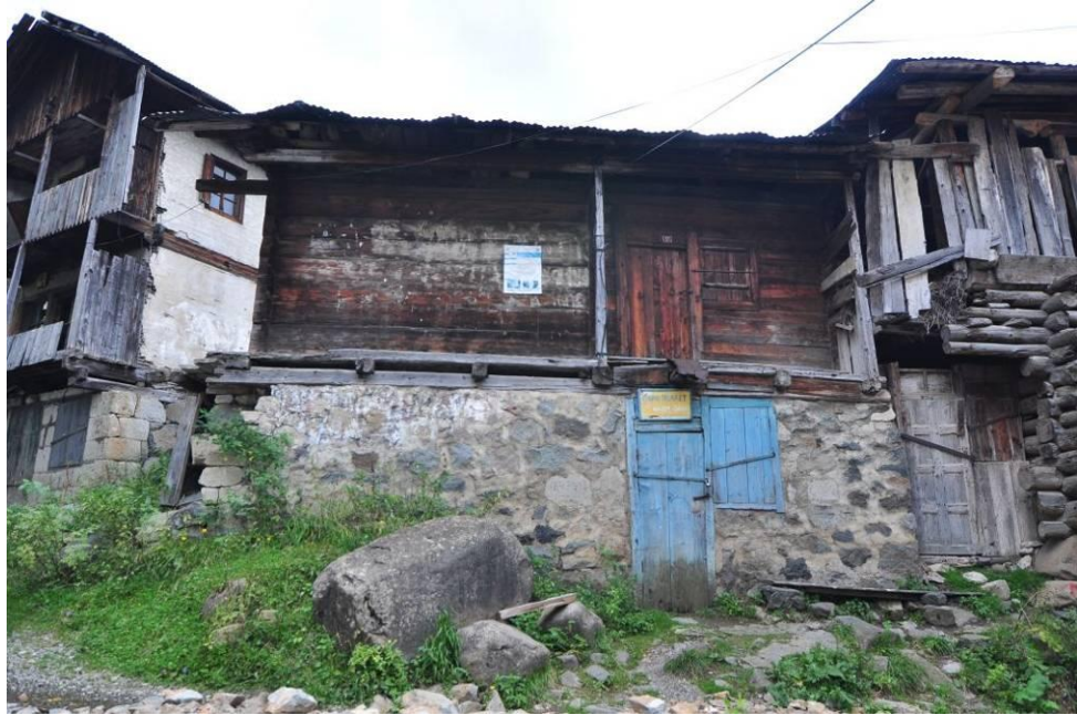
Şekil B.66 : 247 envanter nolu yapının kuzebatı cephesi.
