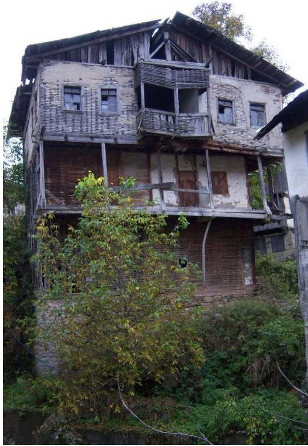
Şekil B.42 : 181 envanter nolu yapının kuzeybatı cephesi.
