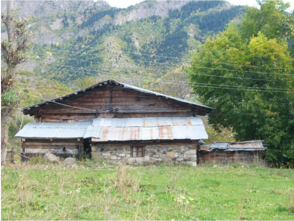
Şekil B.110 : 108 envanter nolu konutun arka cephesi.
