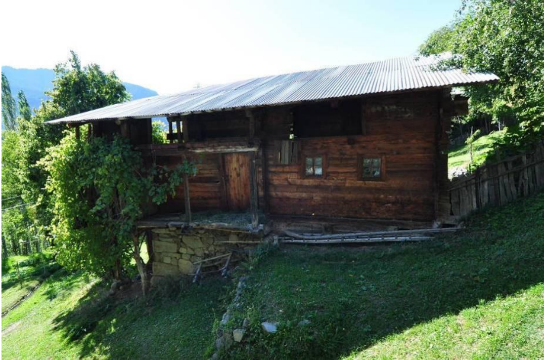
Şekil B.112 : 195 envanter nolu konutun yan cephesi.
