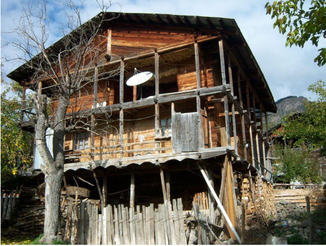
Şekil B.117 : 256 envanter nolu konutun ön cephesi.
