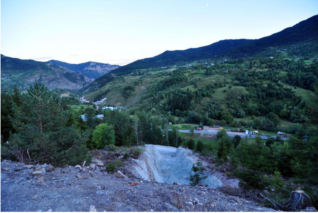
Şekil D.4 : Orman içine açılan HES boru çukuru.
