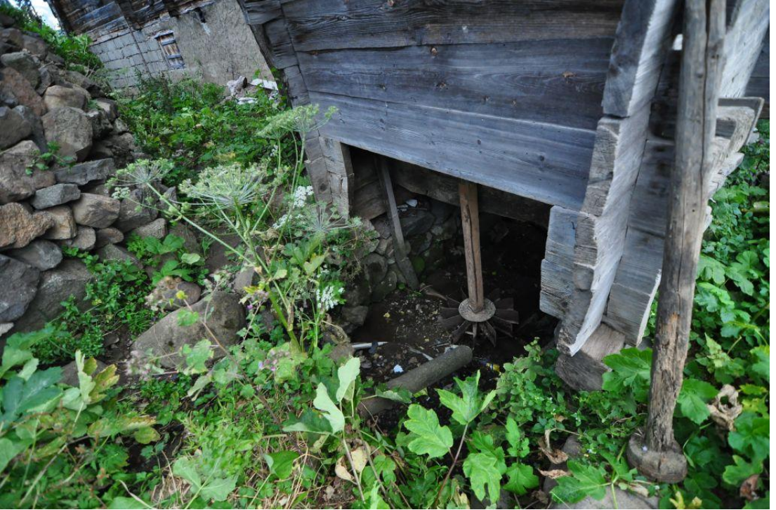
Şekil B.147 : 129 envanter nolu değirmenin altında bulunan çark.
