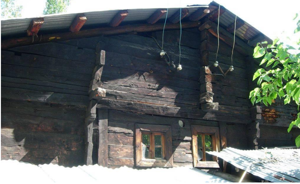
Şekil 6.14 : Cephede isten kaynaklı kirlenme.
