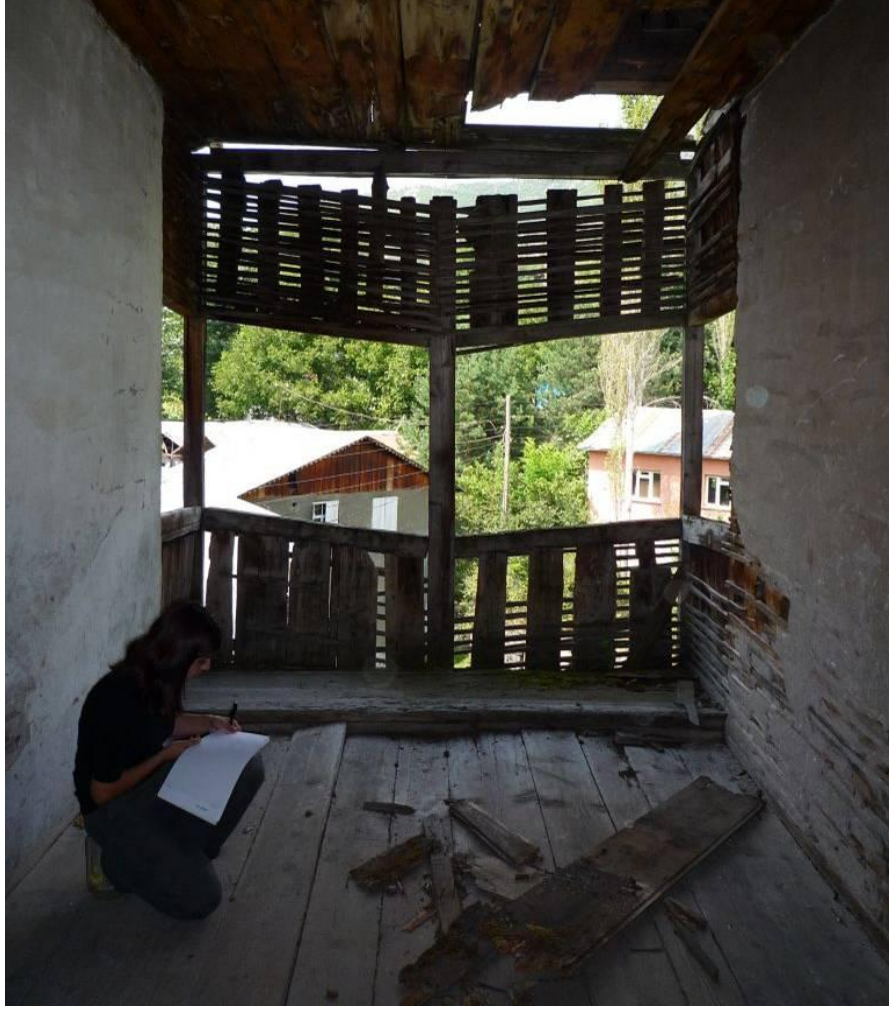
Şekil B.47 : 181 envanter nolu yapının arka cephesinde bulunan köşk.
