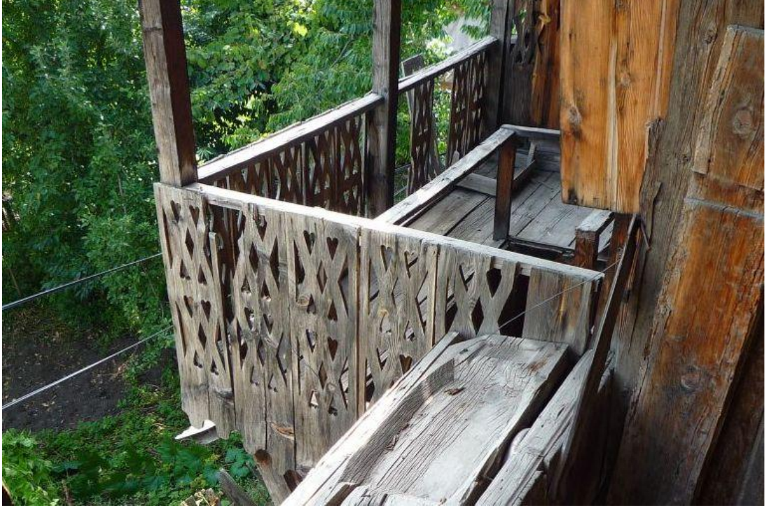
Şekil B.63 : 245 envanter nolu yapının köşk korkulukları.
