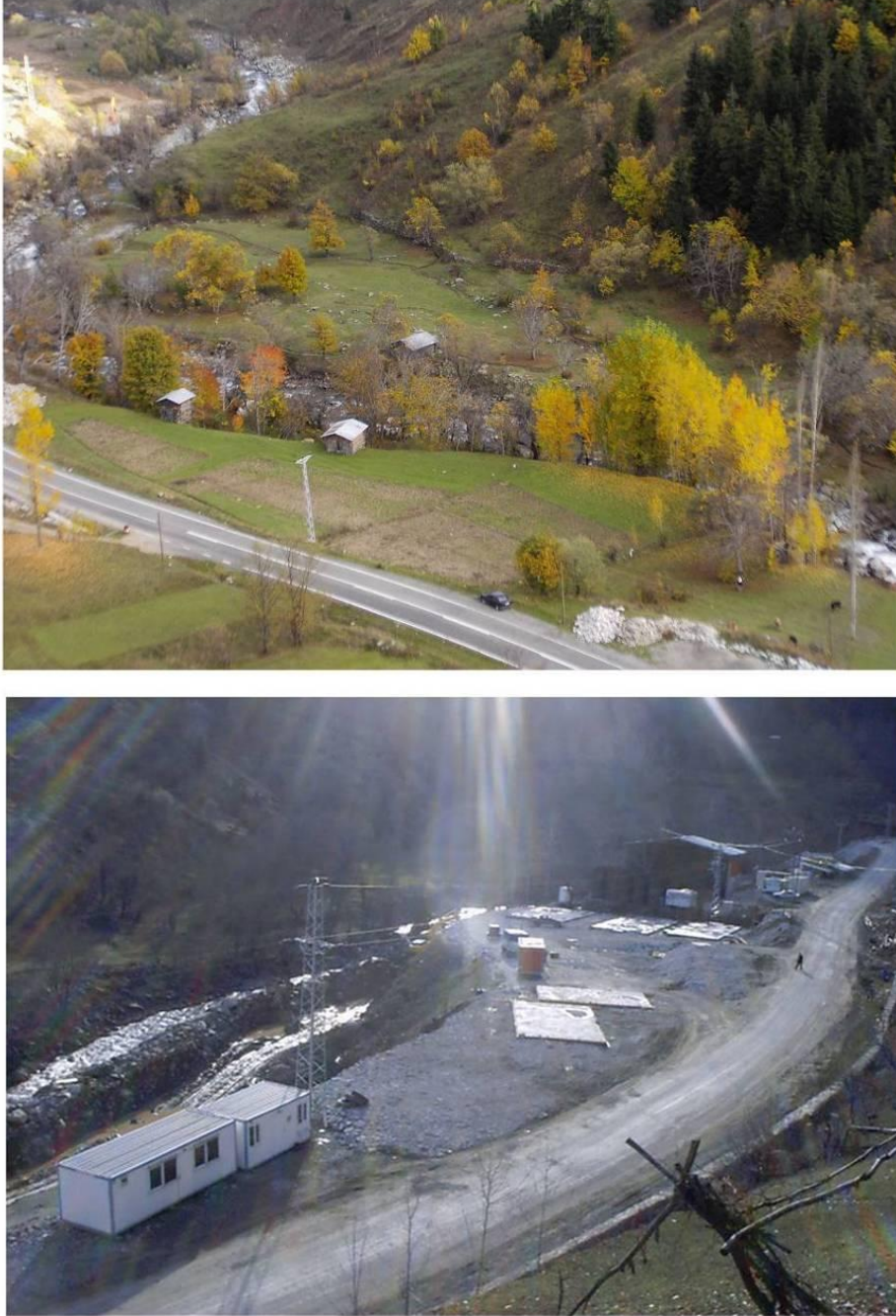
řekil 6.1 : Tarım arazilerinin zerinde yer alan reglatr tesisleri.
