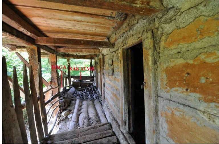
Şekil B.107 : 01 envanter nolu konutun ahorun kapısı .
