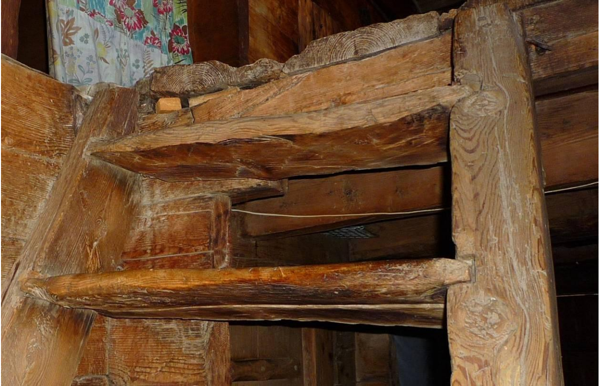
Şekil B.132 (devam) : Birleşim detayları.
