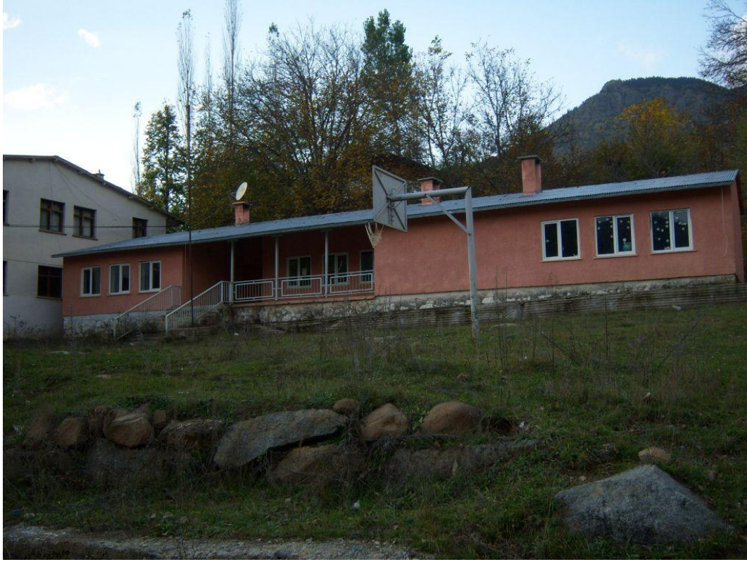
Şekil D.11 : Balıklı İlköğretim Okulu binası.
