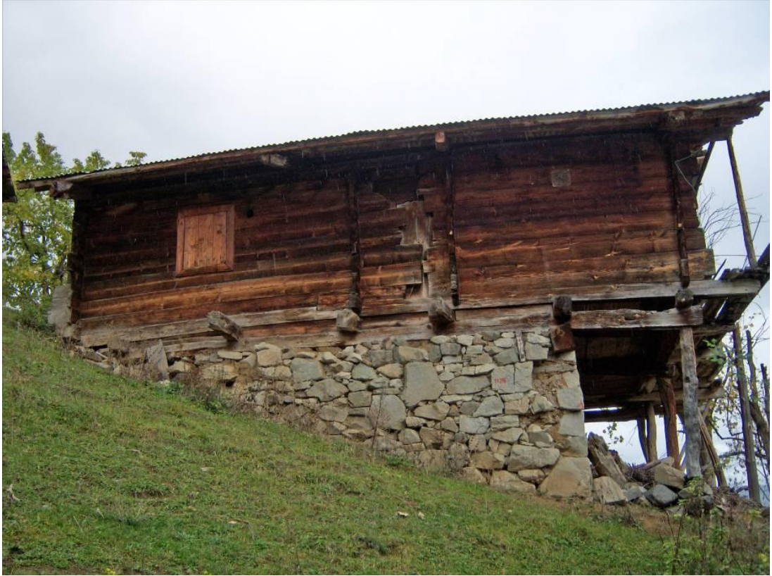
Şekil 4.26 : Taş yığma ve yaka yapım tekniği.
