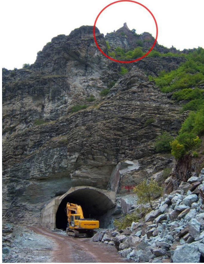
Şekil B.2 : Parih Kalesi'nin altında sürdürülen karayolu çalışmaları.
