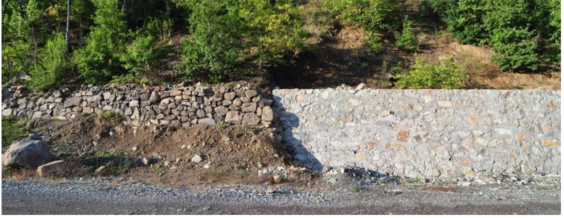
Şekil 6.7 : Eski ve yeni duvar örgüsü.
