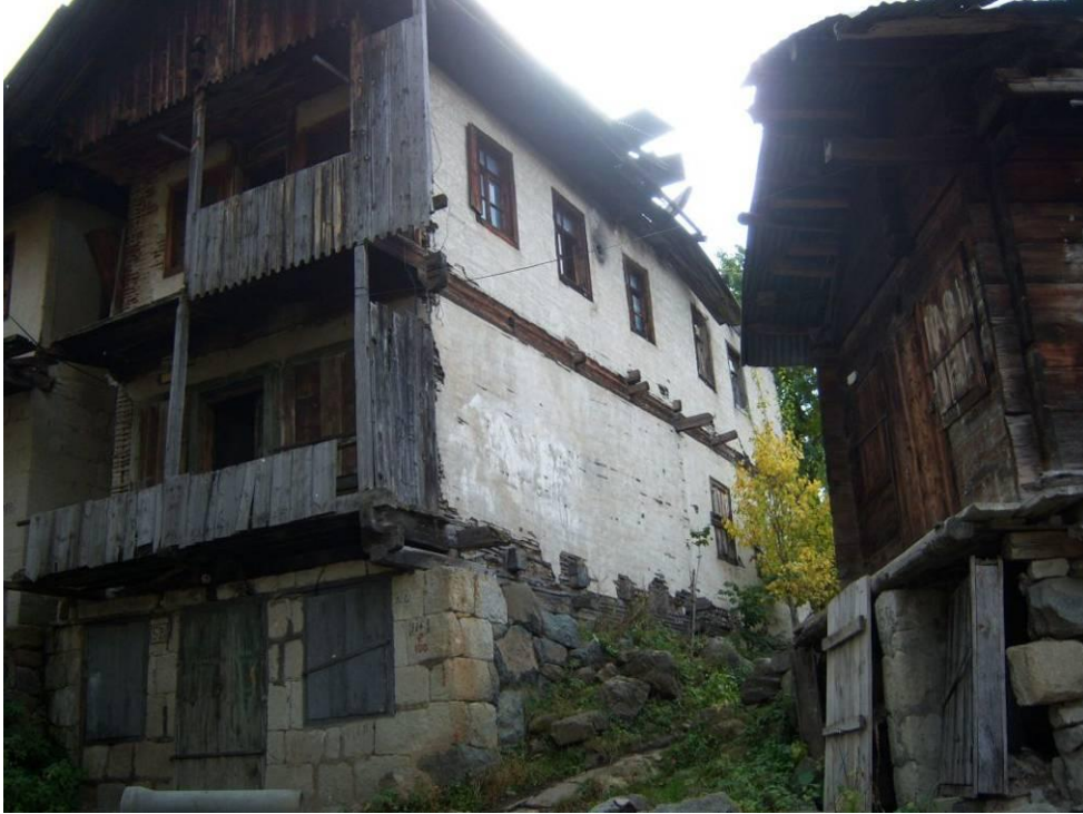
Şekil B.54 : 246 envanter nolu yapının batı cephesi.
