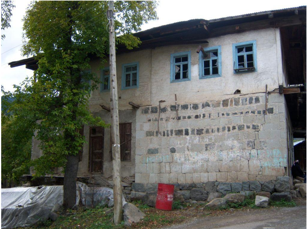
Şekil B.52 : 245 envanter nolu yapının doğu cephesi.
