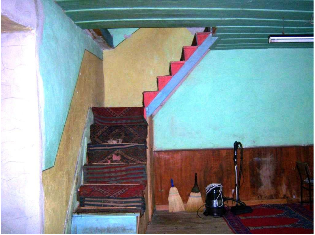
Şekil B.30 : Ana mekandan kadınlar mahfiline ulaşımı sağlayan merdiven.
