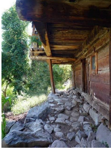
Şekil B.106 : 151 envanter nolu konutun ahorun kapısı .
