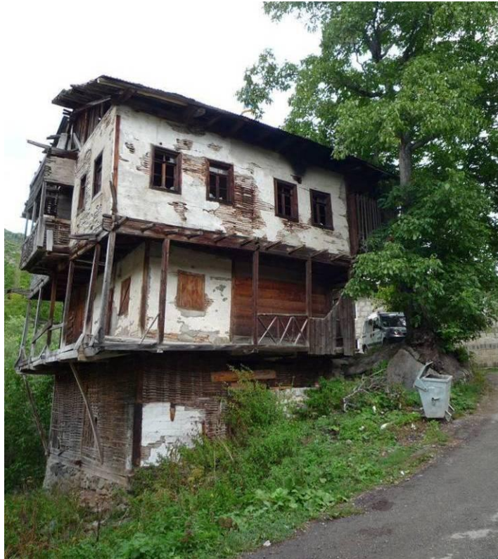
Şekil B.44 : 181 envanter nolu yapının güneybatı cephesi 70 .
