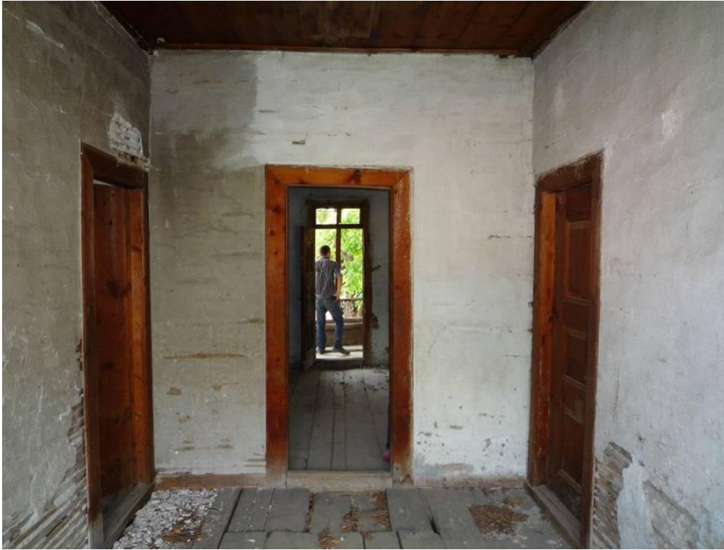
Şekil B.46 : 181 envanter nolu yapının I. katındaki koridor.
