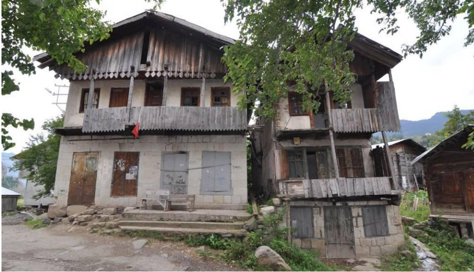
Şekil 4.13 : 245 ve 246 envanter nolu yapıların kuzey cephesi.
