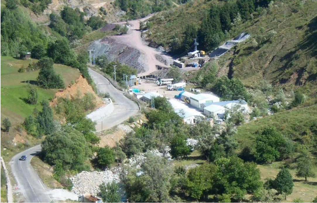
Şekil D.5 : HES inşaat sahası.
