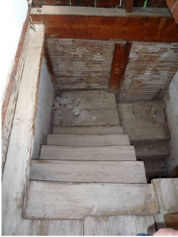
Şekil B.55 : Zemin katta ve I.kat arasındaki bağlantıyı sağlayan merdiven 71 .
