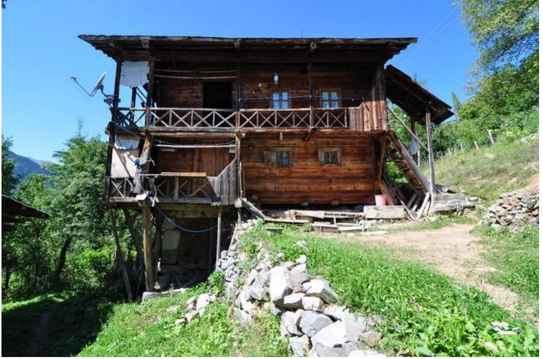
Şekil B.111 : 236 envanter nolu konutun yan cephesi 76 .
