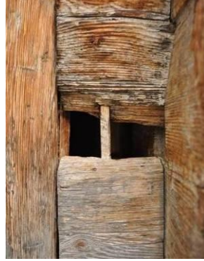
Şekil 4.29 : Duvar tahtaları arasında kullanılan ahşap çivi.
