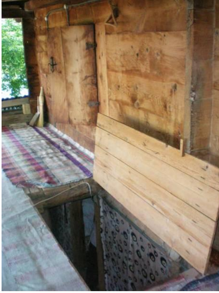
Şekil B.75 : Merdiven boşluğunun üstünü örten kapak.
