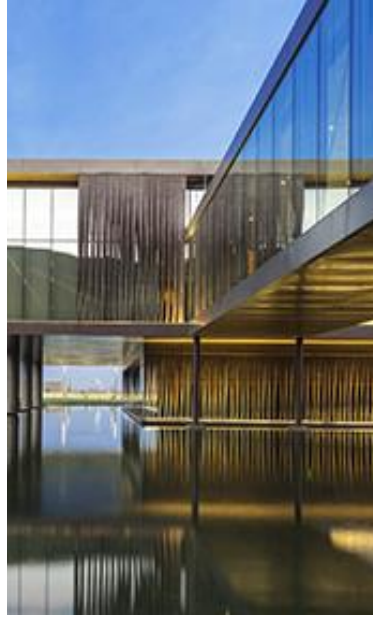
Şekil 4. 12: Cephe panelleri (Mesh Curtain)
