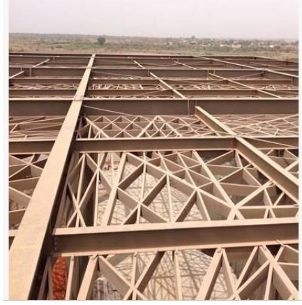
Şekil 4. 11: Canopy taşıyıcı sistemi (Summa A.Ş)
