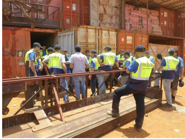
Şekil 4. 9: Malzemeler konteyner ile proje alanına getirilmesi (Summa A.Ş)
