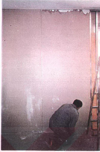
Şekil 6.9: Cam yünü levhalar üzerine tespit edilen alçı plakalar [58]
