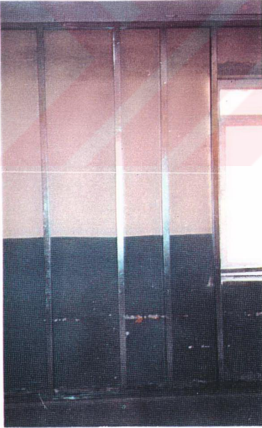
Şekil 6.7: Duvar iç yüzeyinden tespit edilen galvanizli saç profiller [58]
