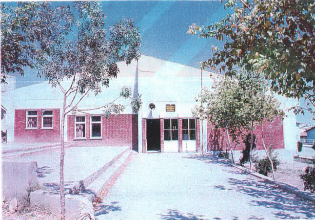
Şekil 6.5: Batıkent İlkokulu'nun yenileme öncesindeki genel görünüşü [58]
