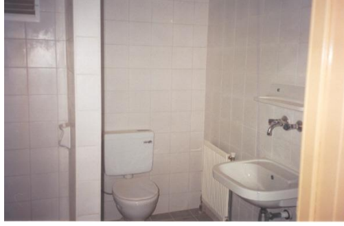
Şekil 5.3. Sosyal Çalışmalar Sonucu Yapımı Talep Edilen Ek Duvar, PUB Hereke Konutları (Haziran 2001)
