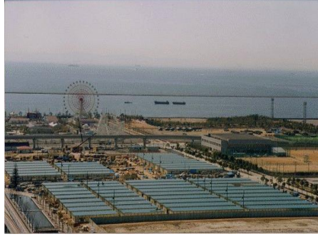
Şekil 3.14. Geçici Konutların Uzaktan Görünümü, Rokko Adası, Seishin Minami (anon, 1996)
