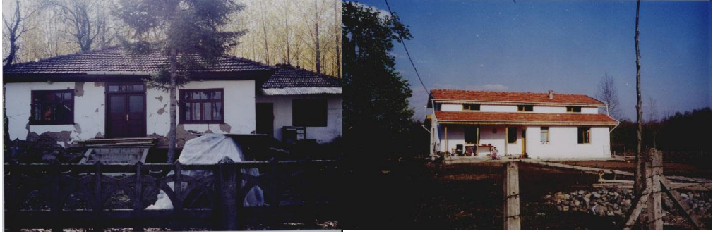
Şekil 5.20. Solda kullanıcının hasarlı konutu, sağda ise yeni yapılan konutu görülmektedir (Nisan 2002).
