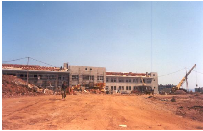
Şekil 5.4. Müteahhit firma tarafından inşa edilen okul binası, PUB Hereke Konutları (Haziran, 2001)
