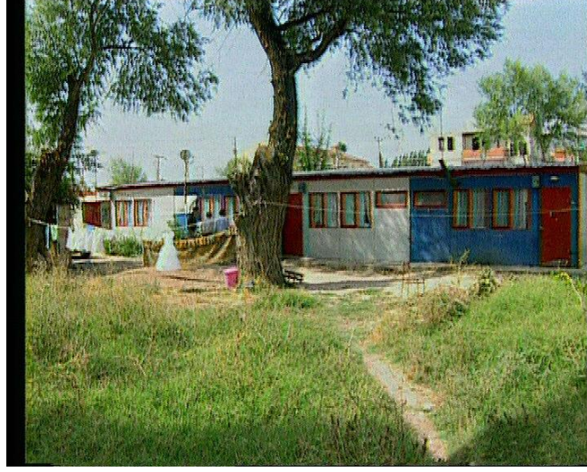
Şekil 4.13 Dinar'da halen kullanılmakta olan prefabrik konutlar (Gönüllü, 2002).
