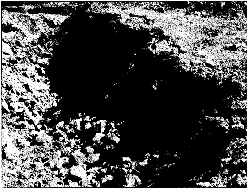
Şekil 6.12 Atım sonrası oluşan yeni ayna
