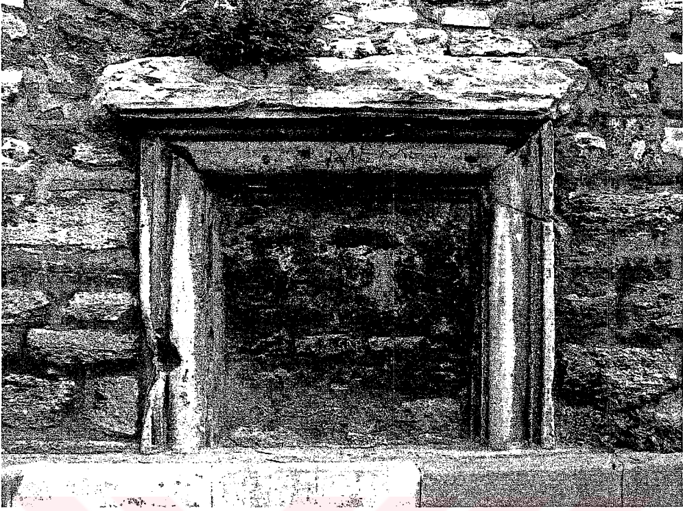
Şekil A.27. Studios Manastırı Kilisesi. Atriumun kuzey portikusunun kuzey duvarındaki batı kapı, kuzeyden görünüş (Kat.no.007)
