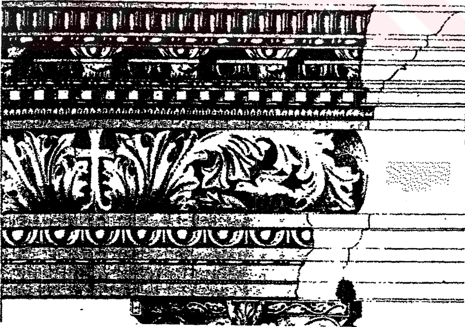
Şekil A.288. Studios Manastırı Kilisesi. Kirişleme.
