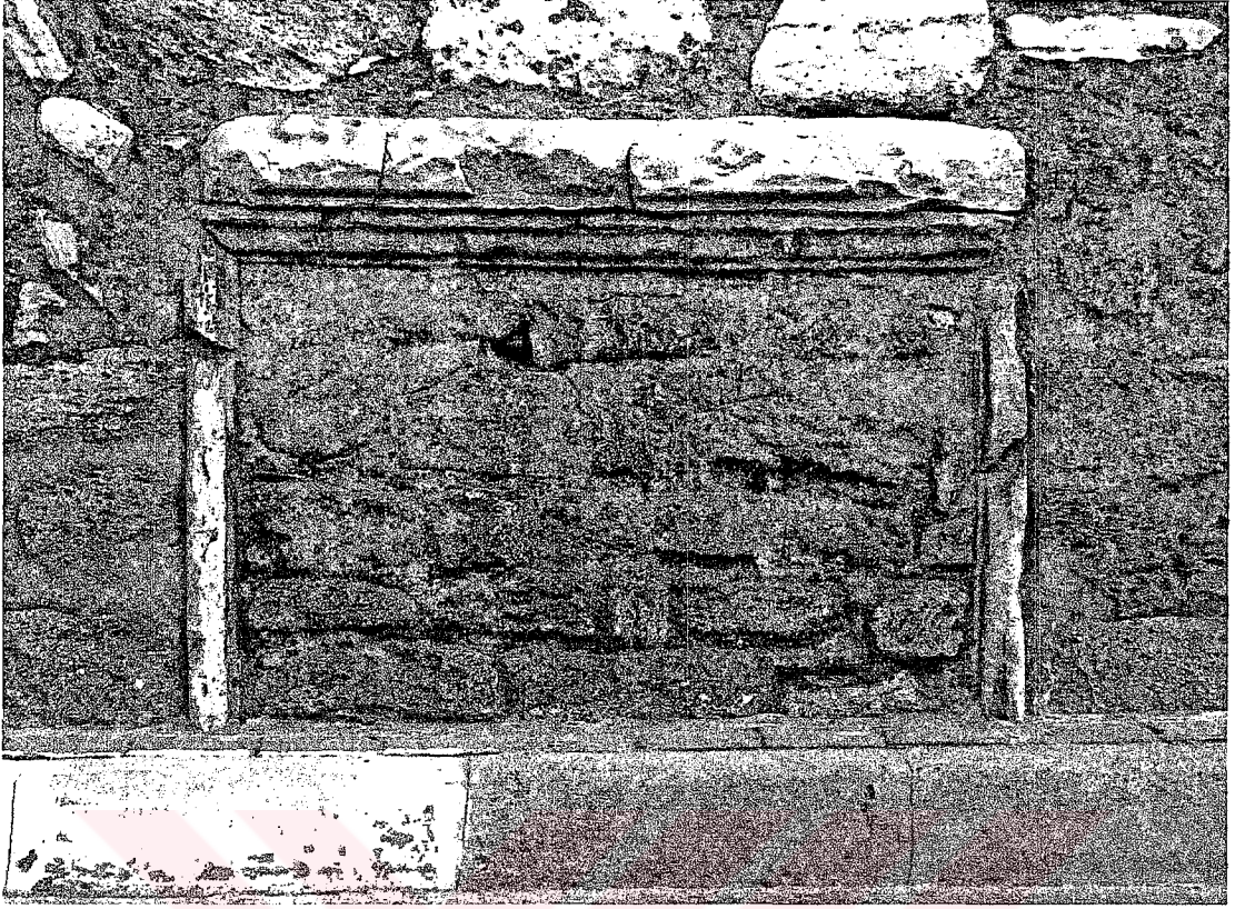
Şekil A.29. Studios Manastırı Kilisesi. Atriumun kuzey portikusunun kuzey duvarındaki doğu kapı, kuzeyden görünüş (Kat.no.008)
