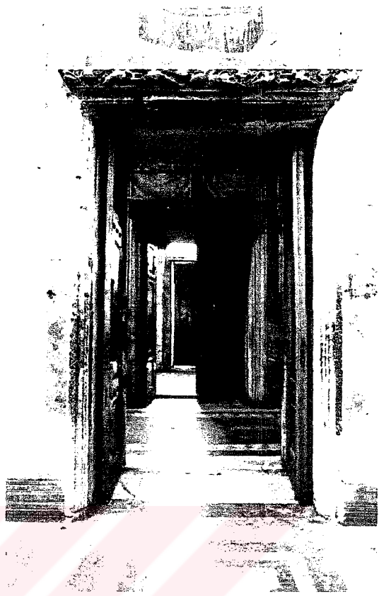
Şekil A.258. Kariye Camisi. İç nartheksden naosa açılan orta kapı, naosdan görünüş (Kat.no.114)
