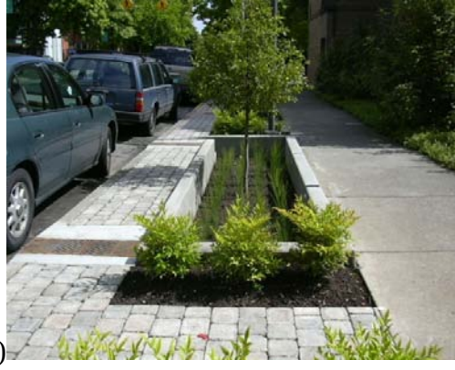
Şekil 3.34 : (a) Yoğun yağmur yağışında bitkiler geçici olarak suyun altında kalır (Url-3) (b) yağmursuz günde bitkilendirilmiş kanal ve tampon bitkilendirmesi (Url-3).
