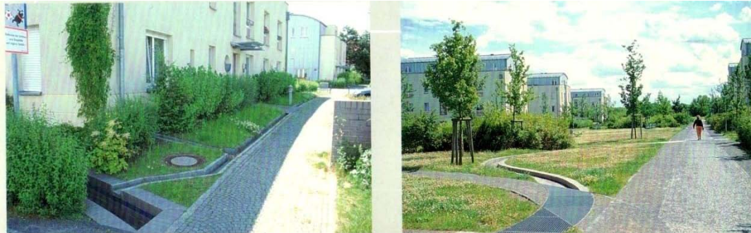
Şekil 3.43 : 1990lar’ın öğrenci konutları berlin, almanya, yerleşmenin planlanmasında sürdürülebilirlik konseptini her yerde devam ettiren yağmur iniş, kanal detay ve su drenaj çözümleri görsel olarak da projeyi destekler niteliktedir, Dunnet, N. ve Clayden A. (2007).
