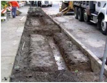
Şekil 3.36 : Sel suyu saksısı yapım aşamasında (a) toprak tesviyesi (Url-17) (b) beton yan yüzeylerin biçimlenmesi (Url-17) (c) beton hendek ve çökelti (sediment) toplama keçesi (Url-17).
