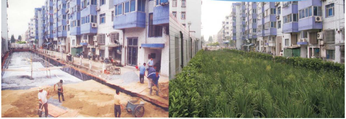
Şekil 3.37 : HuaXin yerleşim bölgesinin yapılandırılmış sulak alan uygulaması sırasında ve sonrasında gösteren fotoğraflar (Stokman, 2008).
