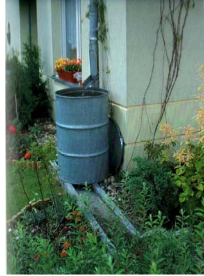
Şekil 3.44 : (a)1990lar'ın öğrenci konutları Berlin, Almanya, kanal detay Dunnet, N. ve Clayden A. (2007) (b) yağmur iniş borusunu takiben yağmur suyu toplama tankı Dunnet, N. ve Clayden A. (2007).
