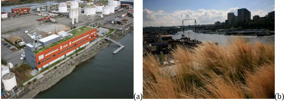
Şekil 3.30 : (a) (b) Washington Tacoma Üniversitesi araştırma tesisinin selsuyu yönetimi (stormwater management) amacıyla bitkilendirilmiş çatısı (Url-5).
