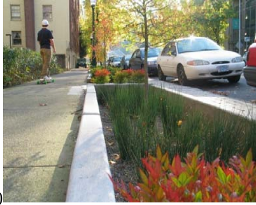
Şekil 3.35 : (a) Toplayıcı sistem ve bitkilendirilmiş kanal bağlantısı (Url-3) (b) yağmursuz günde sel suyu saksısının görünüşü (Url-3).
