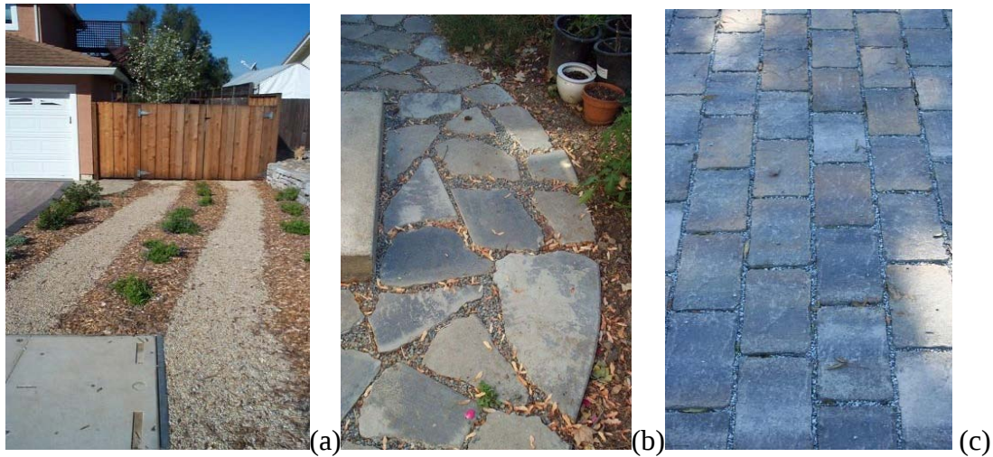
Şekil 4.19 : (a) İnce çakıllı yüzey Dunnet, N. ve Clayden A. (2007) (b) çakıl üzerine geri dönüştürülmüş beton Dunnet, N. ve Clayden A. (2007) (c) ocak taşı Dunnet, N. ve Clayden A. (2007).
