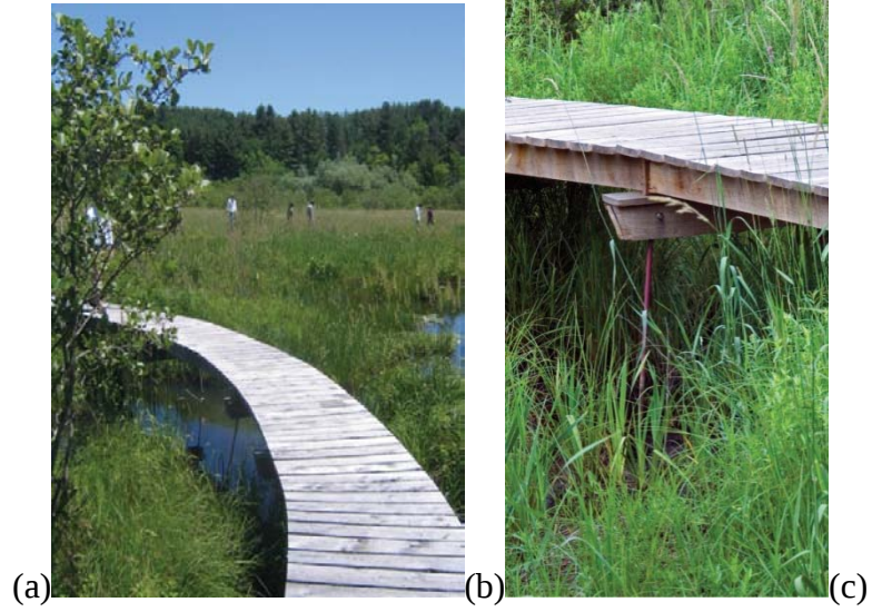
Şekil 4.24 : (a) (b) Sulak alan içerisinde organik formda, kıvrılarak konumlanmış yürüme yolu (Url-23) (c) yürüme yolu hafif strüktürel çözüm detayı (Url-23).
