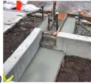
Şekil 3.36 : Sel suyu saksısı yapım aşamasında (a) toprak tesviyesi (Url-17) (b) beton yan yüzeylerin biçimlenmesi (Url-17) (c) beton hendek ve çökelti (sediment) toplama keçesi (Url-17).
