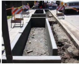
Şekil 3.36 : Sel suyu saksısı yapım aşamasında (a) toprak tesviyesi (Url-17) (b) beton yan yüzeylerin biçimlenmesi (Url-17) (c) beton hendek ve çökelti (sediment) toplama keçesi (Url-17).
