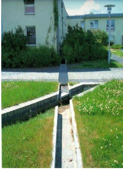
Şekil 3.44 : (a)1990lar'ın öğrenci konutları Berlin, Almanya, kanal detay Dunnet, N. ve Clayden A. (2007) (b) yağmur iniş borusunu takiben yağmur suyu toplama tankı Dunnet, N. ve Clayden A. (2007).
