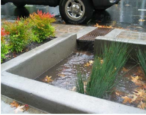
Şekil 3.35 : (a) Toplayıcı sistem ve bitkilendirilmiş kanal bağlantısı (Url-3) (b) yağmursuz günde sel suyu saksısının görünüşü (Url-3).
