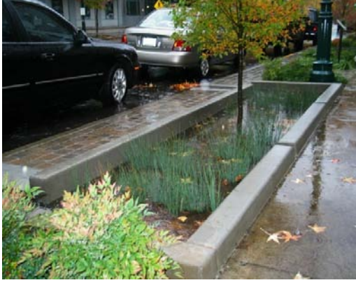
Şekil 3.34 : (a) Yoğun yağmur yağışında bitkiler geçici olarak suyun altında kalır (Url-3) (b) yağmursuz günde bitkilendirilmiş kanal ve tampon bitkilendirmesi (Url-3).
