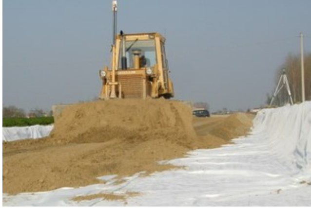
Şekil 4.5: Ayırma amaçlı geotekstil kullanımı.
