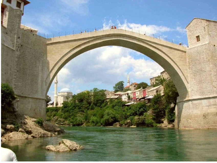
Şekil 2.8: Kemer köprü örneği.
