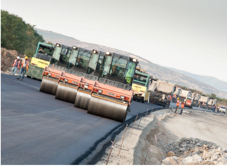
Şekil 2.15: Sıkıştırma işlemi.
