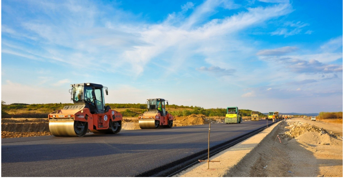
Şekil 2.14: Kaplama tabakası.
